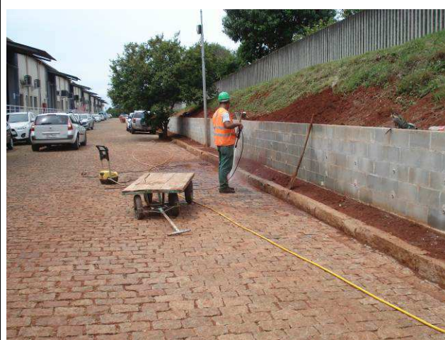
Figura 127C: Finalização da limpeza de área anexa ao muro de arrimo.
