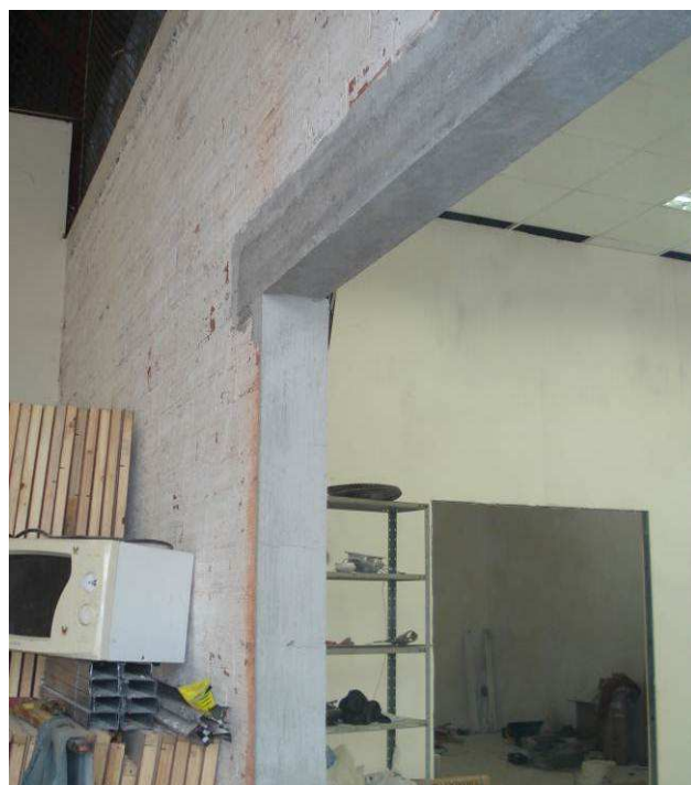
Figura 30C: Emboço paulista executado na adequação do vão da porta do laboratório Service Desk.
