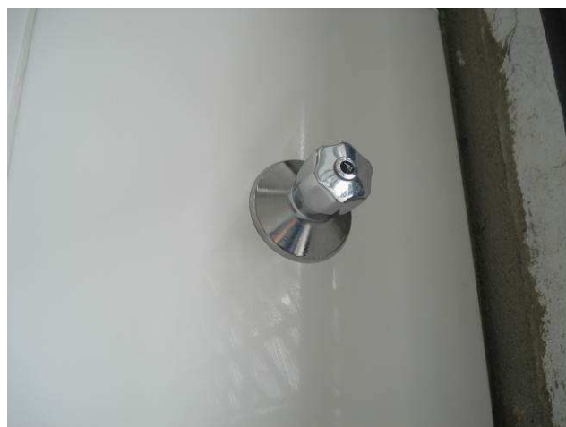
Figura 57C: Registro de gaveta 3/4" instalado na copa da informática.
