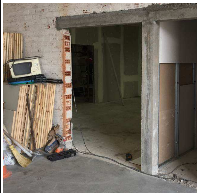
Figura 14C: Porta removida no acesso ao novo laboratório Service Desk.
