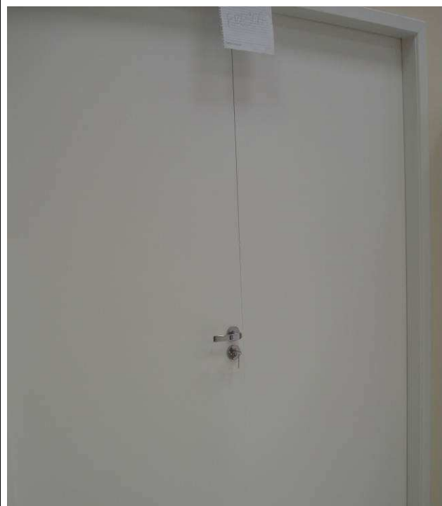
Figura 97C: Porta em madeira PM160x210, em duas folhas de abrir, instalada na passagem do laboratório para o depósito Service Desk.
