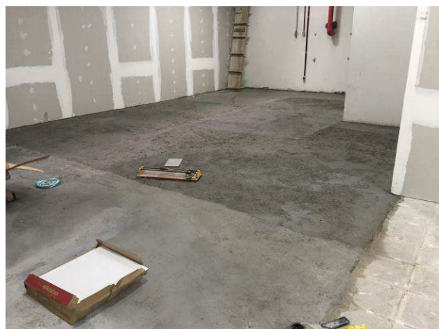
Figura 41C: Regularização de piso executada no laboratório Service Desk.
