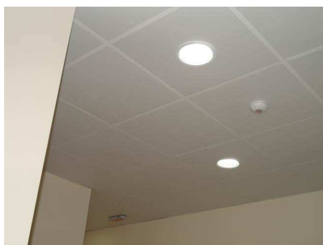
Figura 37C: Forro instalado no corredor de acesso a banheiros e copa da informática.
