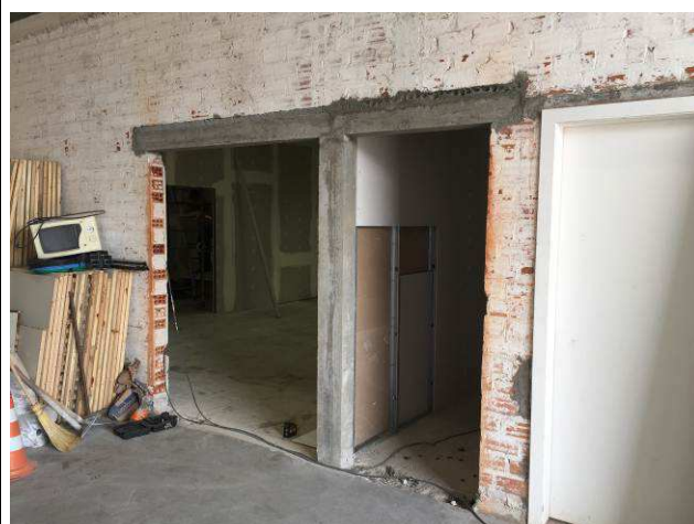
Figura 04C: Aberturas (adequação) de vãos para instalação de portas no corredor e laboratório Service Desk.
