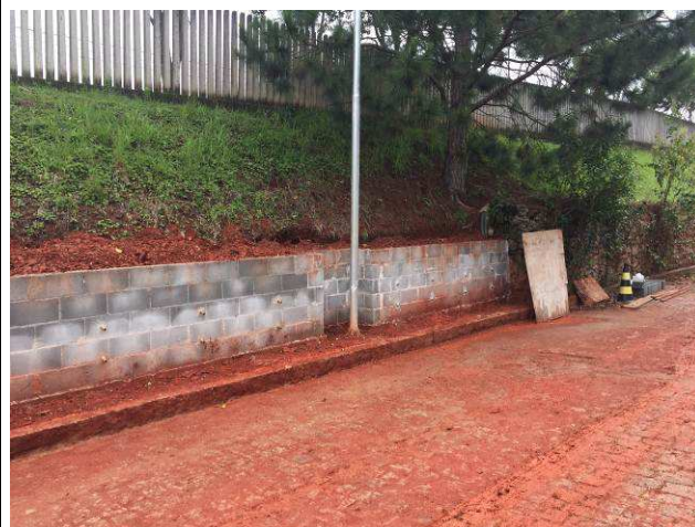
Figura 118C: Executado trecho remanescente da alvenaria em blocos de concreto estrutural.
