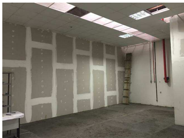
Figura 21C: Parede em gesso acartonado simples executada no laboratório Service Desk.
