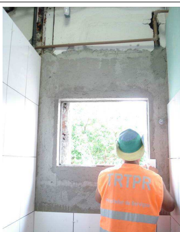
Figura 19C: Alvenaria executada para adequação de vão no banheiro novo da informática.
