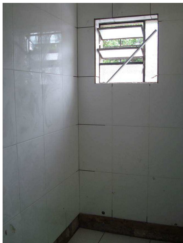
Figura 35C: Azulejos assentados no banheiro reformado da informática (na foto, rejuntamento em andamento).
