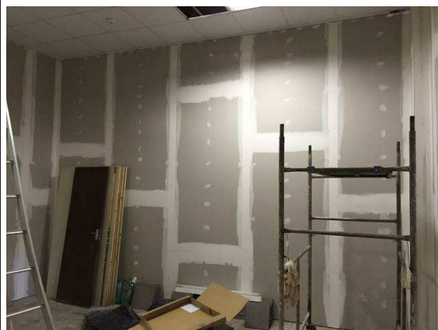
Figura 22C: Parede em gesso acartonado simples executada no depósito Service Desk.
