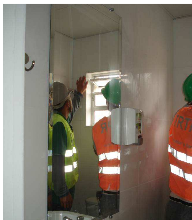
Figura 76C: Espelho cristal com acabamento bisotê instalado no novo banheiro da informática.
