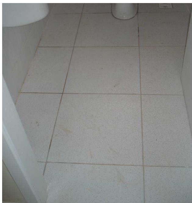
Figura 47C: Após regularização, piso cerâmico Eliane assentado no banheiro novo da informática.
