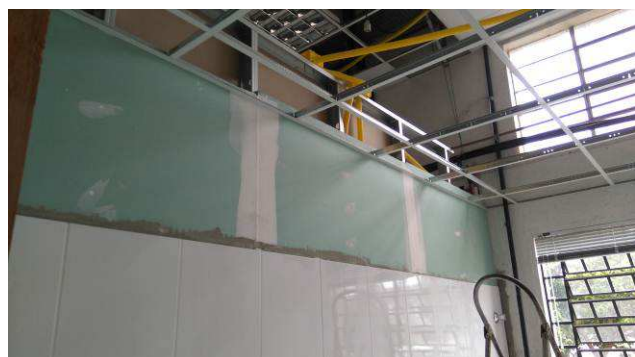
Figura 09E: infraestrutura STI - caixas 2x4", 4x4" e eletrodutos.
