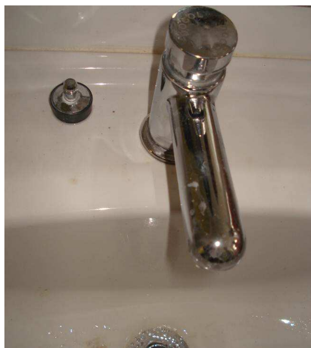
Figura 78C: Torneira de pressão cromada instalada junto ao lavatório do novo banheiro da informática. Utilizado item da marca Docol.
