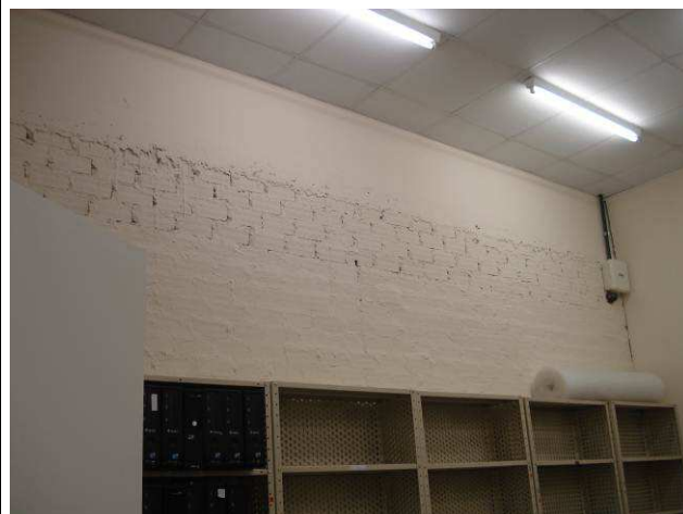
Figura 109C: Parede em alvenaria do depósito Service Desk pintada com tinta látex acrílica Suvinil na cor palha.
