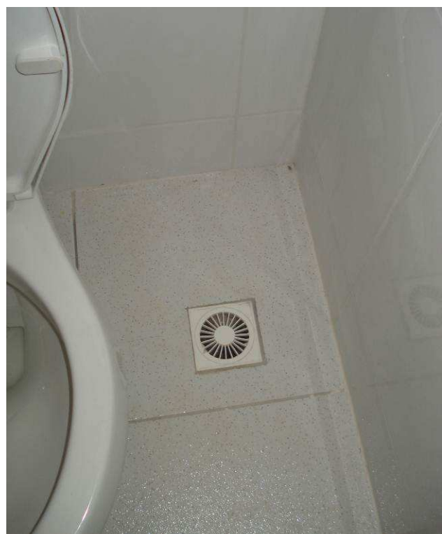
Figura 82C: Caixa sifonada instalada no banheiro construído da informática.
