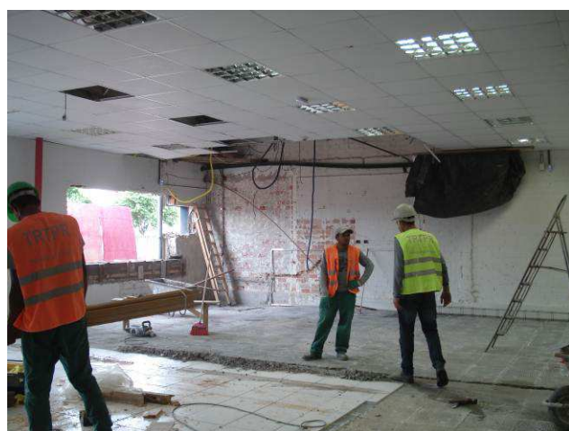
Figura 17C: louças de banheiro e tanque removidos da área a ser incorporada ao Projeto Horizontes.
