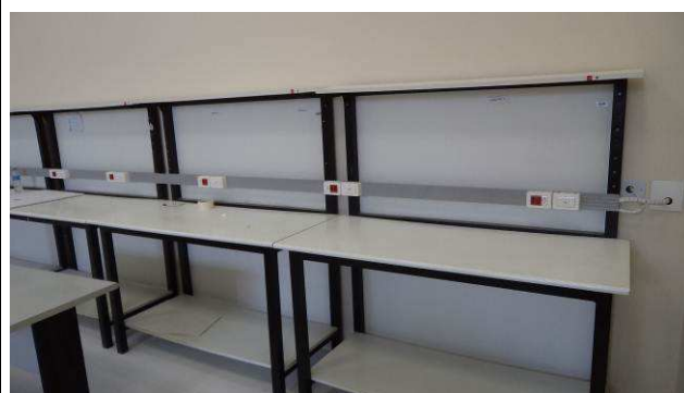
Figura 06E: remanejamento bancadas, régua Dutotec com tomadas e pontos lógicos.
