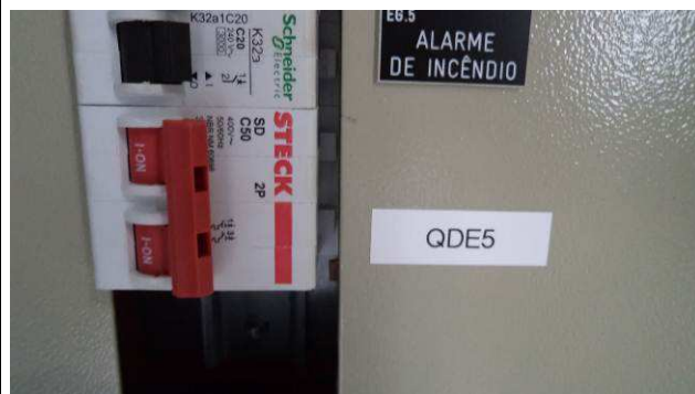
Figura 22E: ramal alimentador QDEG ao QDE-5.
