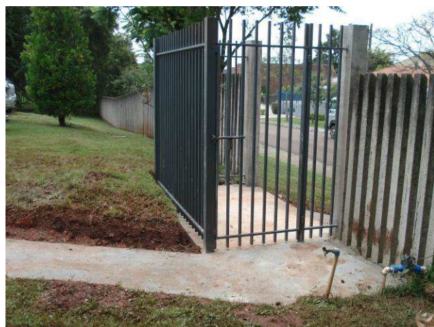
Figura 116C: Gradil com portão de abrir executado na área da lixeira.
