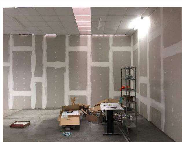
Figura 20C: Parede em gesso acartonado simples executada no laboratório Service Desk.
