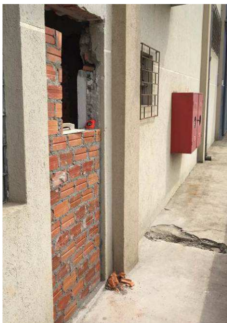
Figura 15C: Porta removida em parede frontal do novo laboratório Service Desk.
