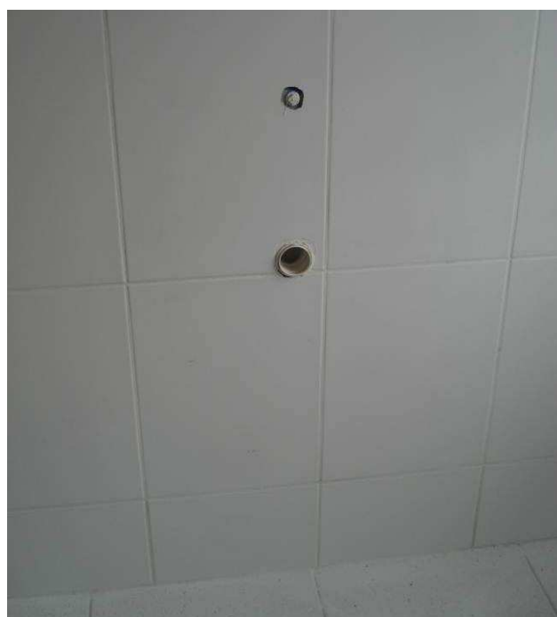
Figura 60C: Ponto de água fria Ø 25 mm e esgoto secundário referente ao lavatório do novo banheiro da informática.
