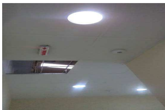
Figura 04E: remanejamento sensores presença e luminárias 23W - banheiros e corredor STI.
