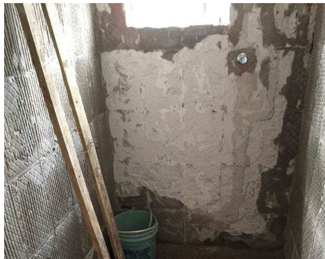
Figura 11C: Azulejos removidos no banheiro da informática.
