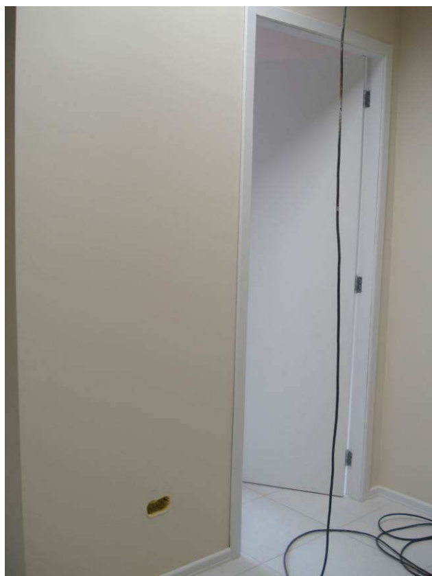
Figura 104C: Paredes do corredor da informática pintadas com tinta látex acrílica Suvinil na cor palha.
