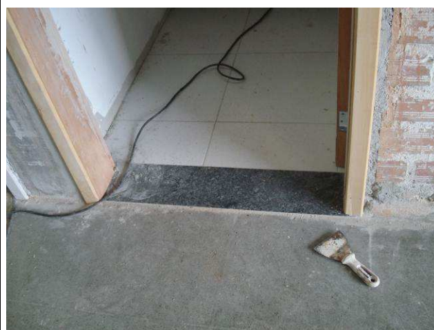
Figura 54C: Soleira em granito polido cinza andorinha, instalada no corredor de acesso à copa da informática.
