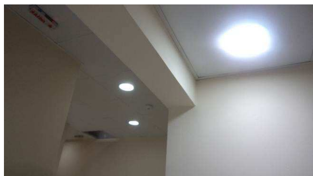
Figura 03E: remanejamento sensores presença e luminárias 23W - banheiros e corredor STI.
