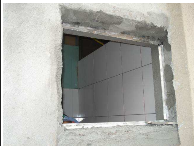
Figura 28C: Emboço paulista executado na adequação do vão de janela, no banheiro novo da informática.
