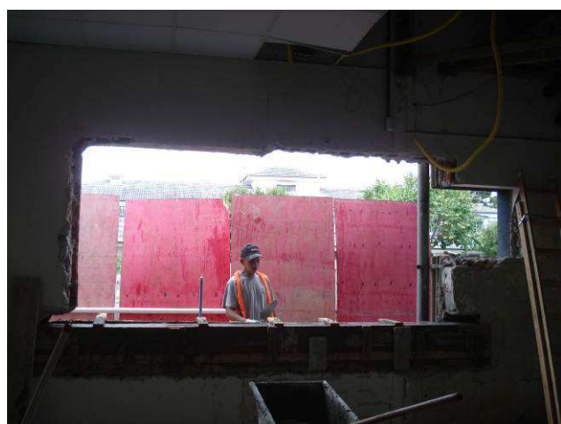
Figura 13C: Janela removida na área a ser incorporada ao projeto horizontes.
