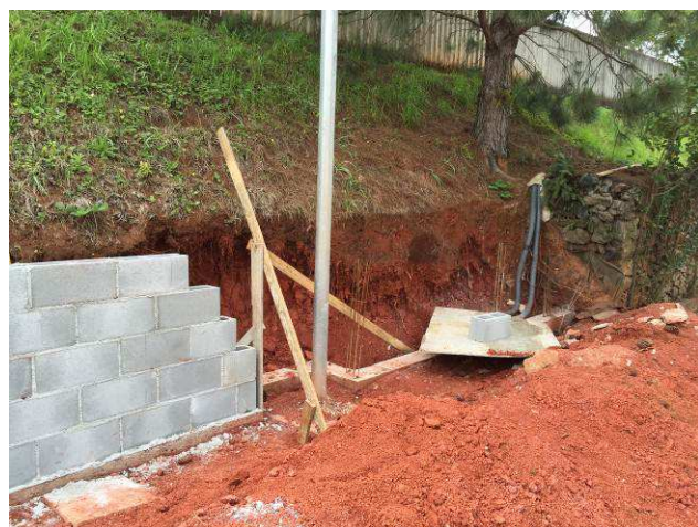
Figura 117C: Executada viga baldrame remanescente do trecho A.
