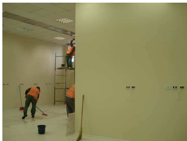
Figura 106C: Paredes em gesso acartonado do laboratório Service Desk pintadas com tinta látex acrílica Suvinil na cor palha.
