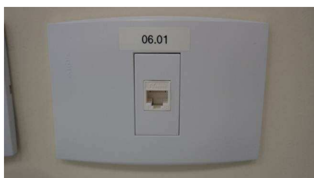
Figura 41E: tomadas lógicas cat-6 Rj45.
