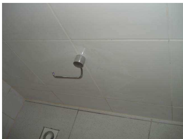
Figura 68C: Papeleira instalada junto à bacia sanitária do banheiro reformado da informática.
