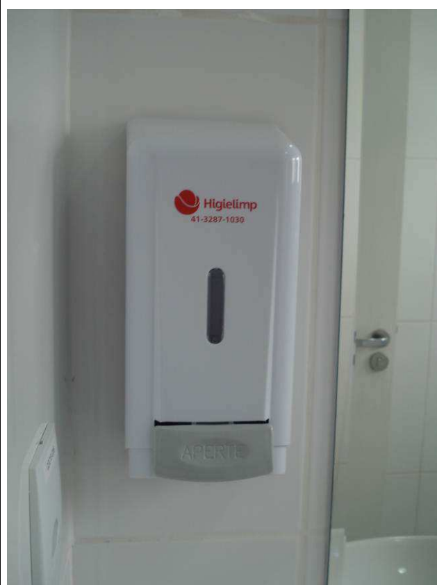
Figura 70C: Saboneteira de plástico instalada junto ao lavatório do banheiro reformado da informática.
