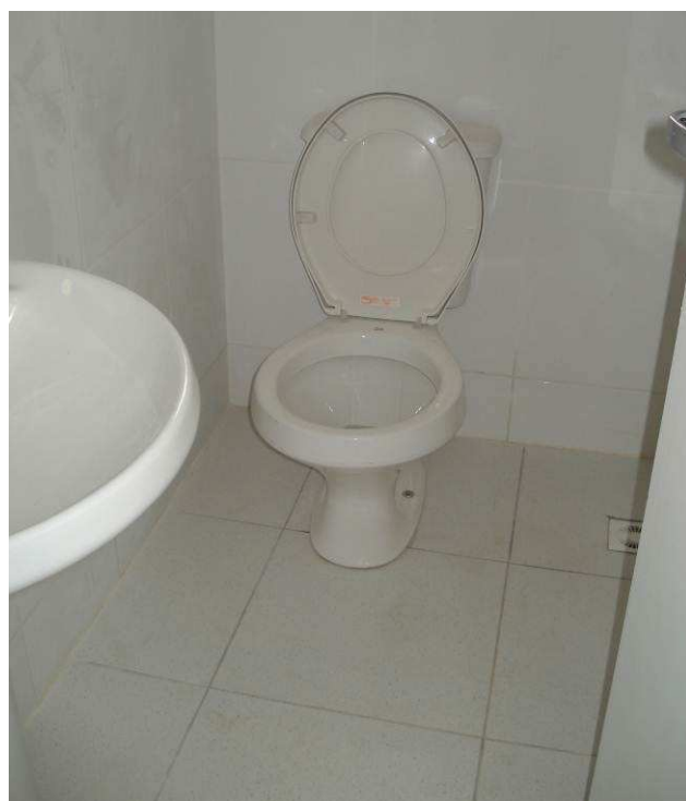
Figura 46C: Após regularização, piso cerâmico Eliane assentado no banheiro reformado da informática.
