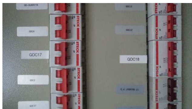
Figura 19E: ramais alimentadores QDG ao QDC-17 e QDC-18.
