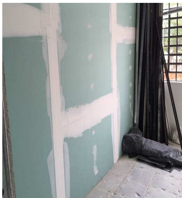
Figura 25C: Parede em gesso acartonado verde executada na copa da informática.
