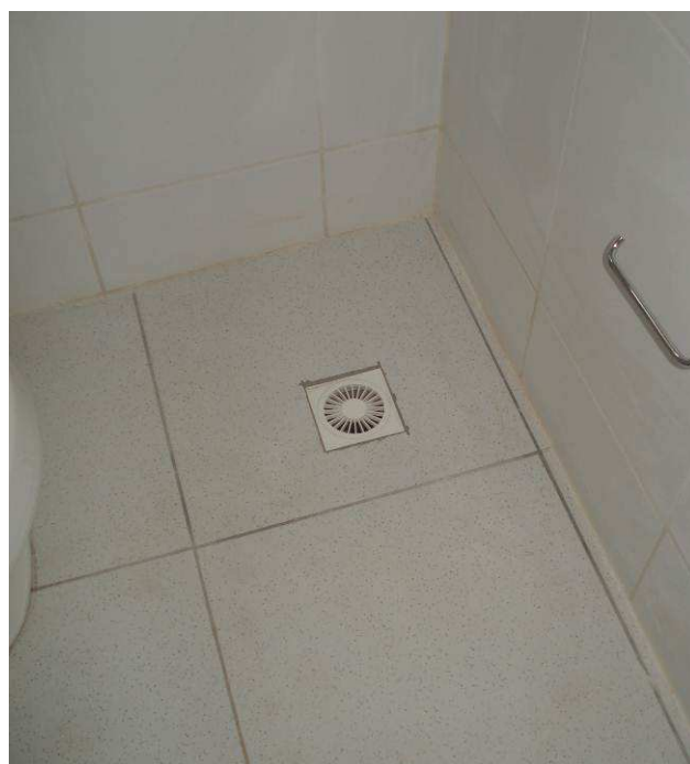
Figura 81C: Caixa sifonada instalada no banheiro reformado da informática.
