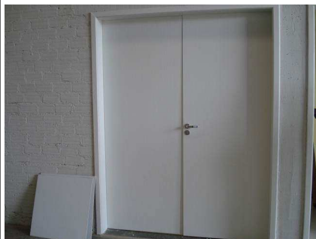
Figura 111C: Porta em madeira, no acesso ao laboratório Service Desk, pintada com esmalte acetinado Suvinil, na cor branca.
