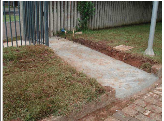
Figura 115C: Trecho interno da calçada.
