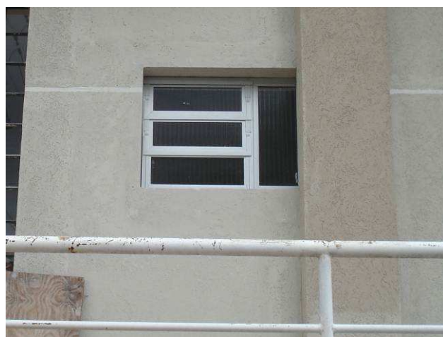
Figura 101C: Janela basculante em alumínio, instalada no banheiro reformado da informática.
