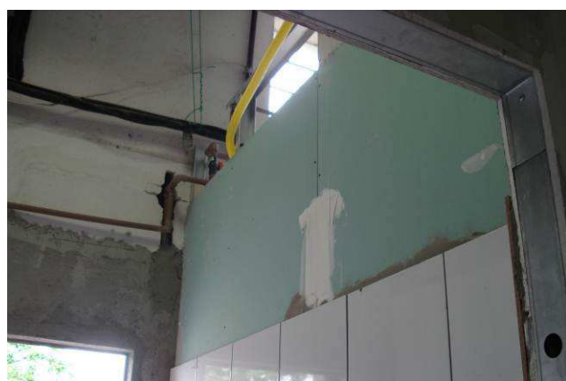
Figura 03C: Forro em PVC removido do banheiro a reformar da informática.
