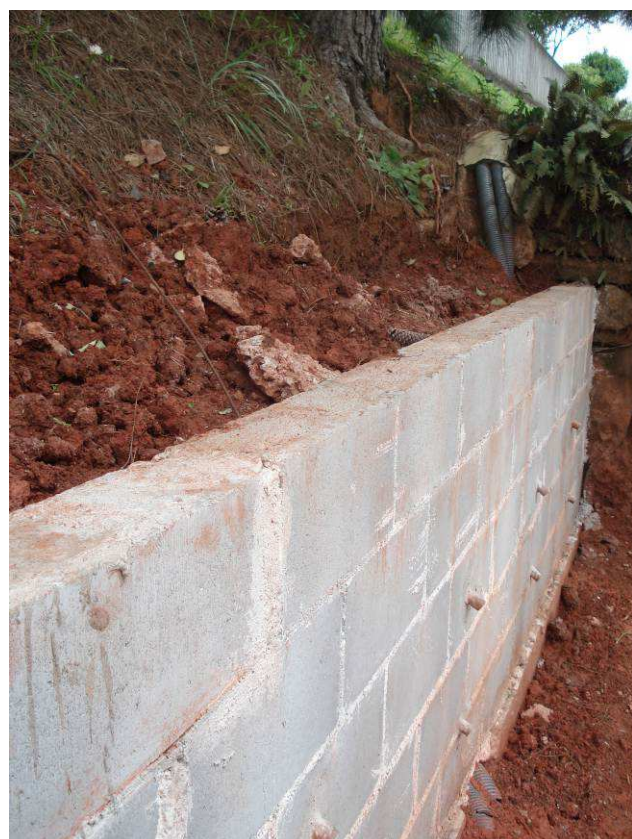
Figura 119C: Executado trecho remanescente de cinta superior do trecho A.
