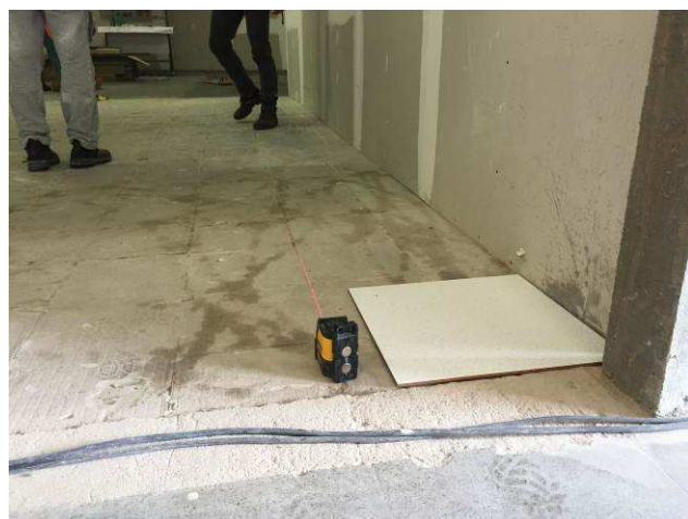
Figura 05C: Piso removido no laboratório Service Desk.
