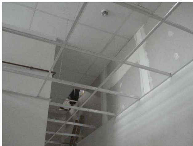
Figura 103C: Parede (abaixo da estrutura do forro) do corredor da informática emassada e lixada.
