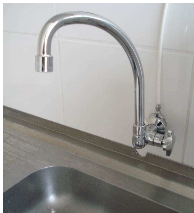
Figura 80C: Torneira para pia, de parede, marca Deca, instalada na copa da informática.
