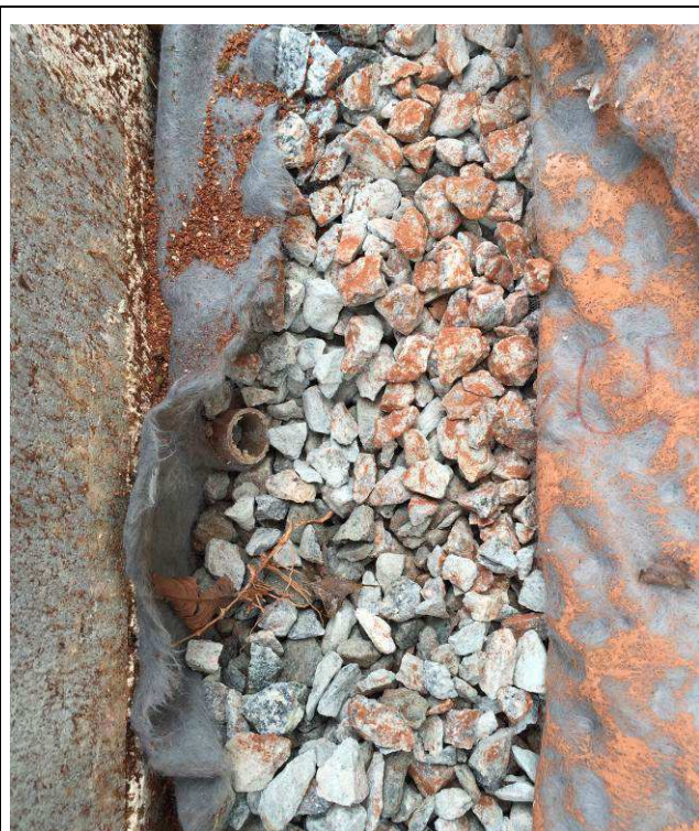
Figura 121C: Executada camada drenante em pedra britada 1 e 2 envolta em manta bidim.
