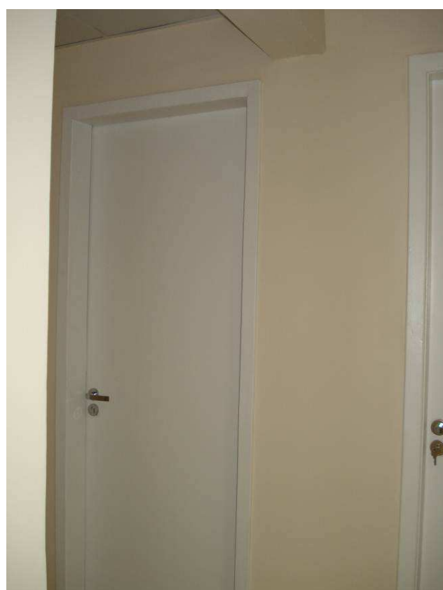
Figura 92C: Porta PM 70x210 reinstalada no banheiro reformado da informática.
