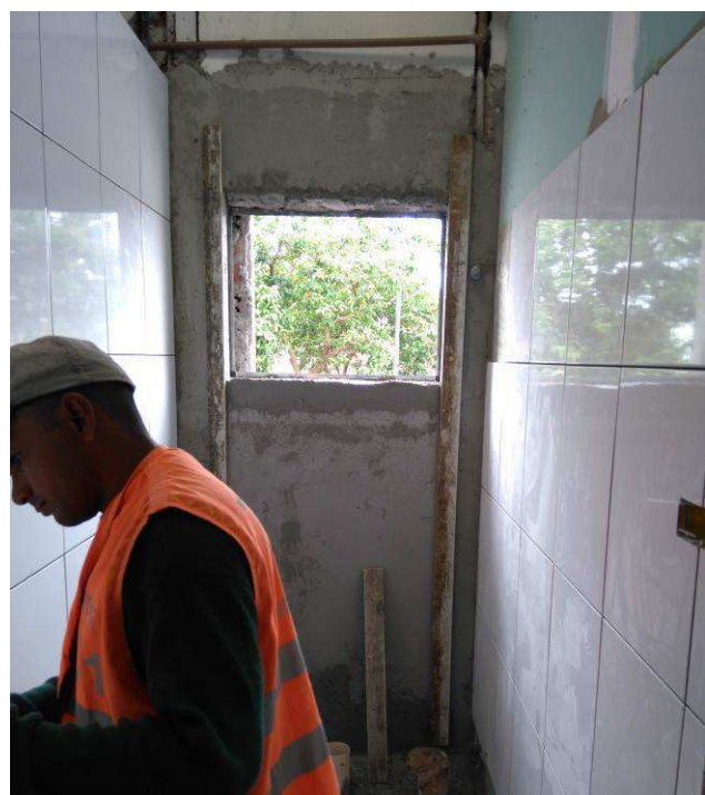
Figura 27C: Chapisco e emboço paulista executados na parede em alvenaria do novo banheiro da informática.
