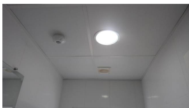
Figura 01E: remanejamento sensores presença e luminárias 23W - banheiros e corredor STI.
