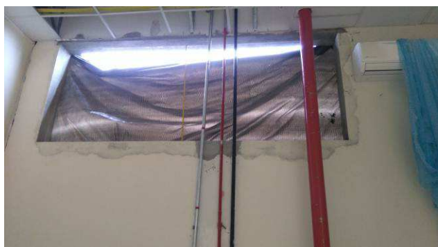
Figura 29C: Emboço paulista executado na adequação do vão da janela do laboratório Service Desk.
