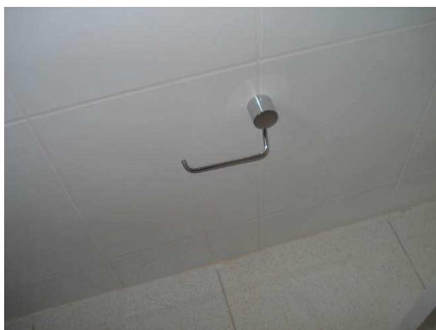
Figura 67C: Papeleira instalada junto à bacia sanitária do novo banheiro da informática. Utilizado item da marca Deca.
