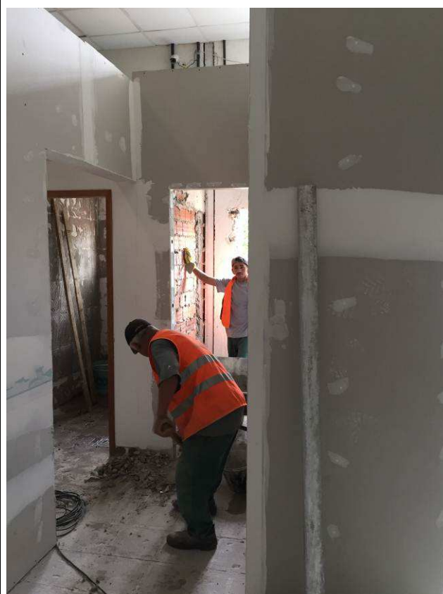
Figura 08C: Piso removido no corredor de acesso à copa e banheiros.
