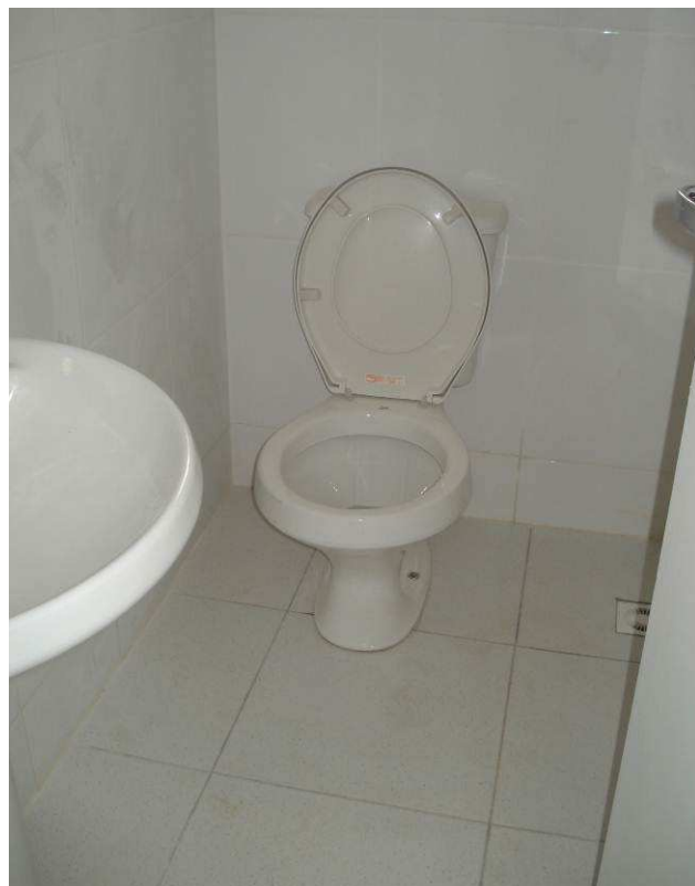
Figura 64C: Bacia sanitária com caixa acoplada reinstalada no banheiro reformado da informática. Assento e acessórios de fixação novos.
