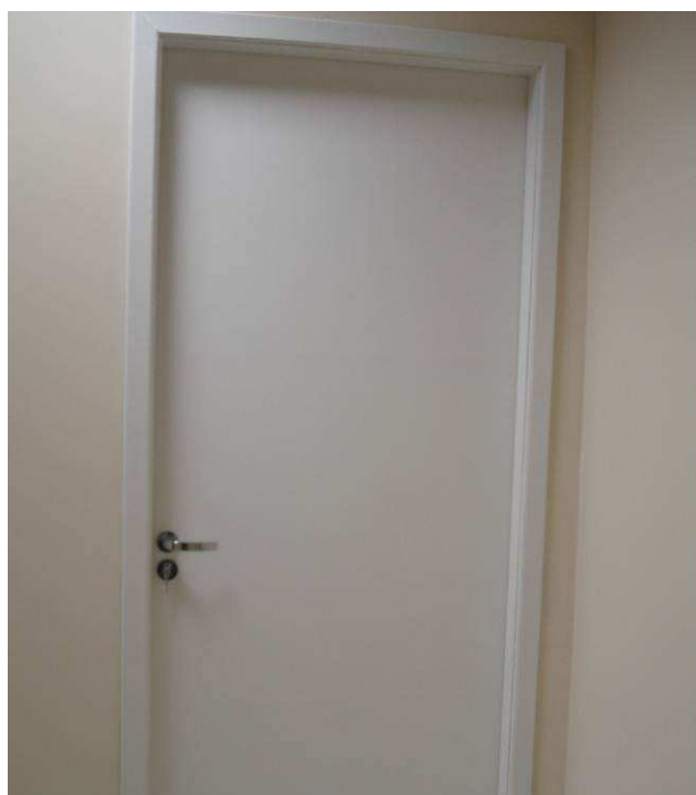
Figura 94C: Porta PM 80x210 instalada na copa da informática.
