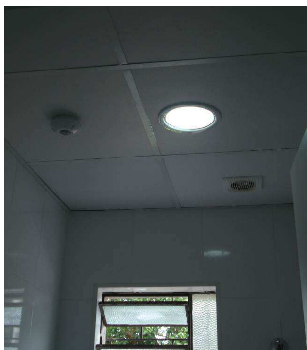
Figura 39C: Forro instalado no banheiro reformado da informática.
