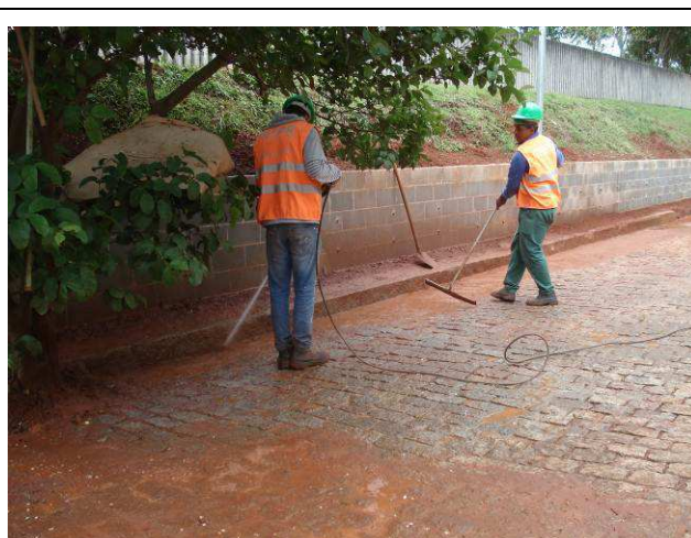
Figura 125C: Lavagem da área anexa ao muro de arrimo executado.
