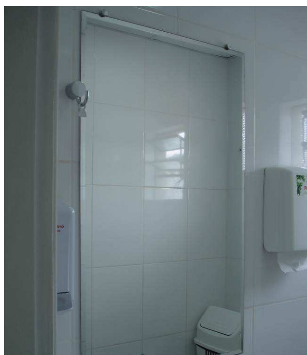
Figura 77C: Espelho cristal com acabamento bisotê reinstalado no banheiro reformado da informática.
