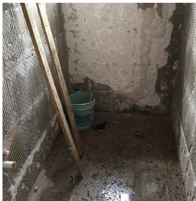
Figura 09C: Piso removido no banheiro da informática.
