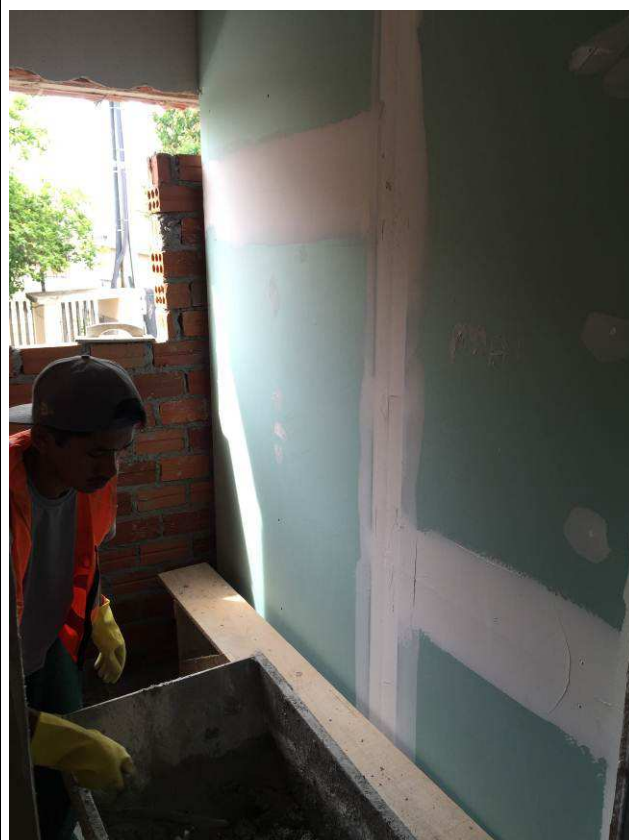
Figura 24C: Parede em gesso acartonado verde executada no banheiro novo da informática.
