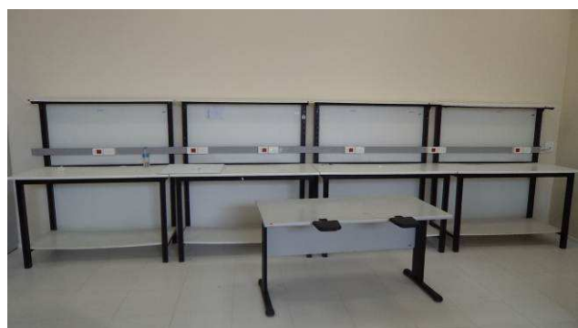
Figura 07E: remanejamento bancadas, régua Dutotec com tomadas e pontos lógicos..
