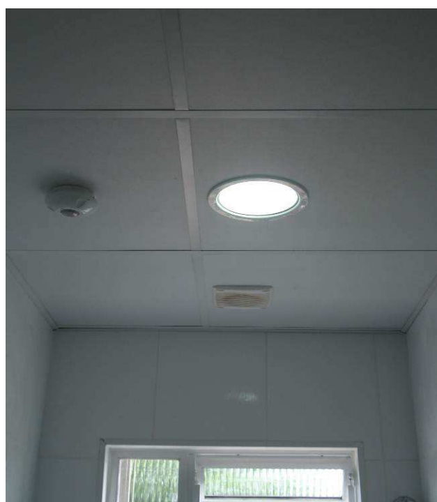
Figura 40C: Forro instalado no banheiro novo da informática.
