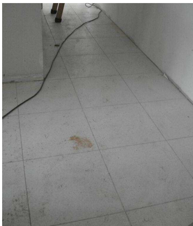
Figura 45C: Após regularização, piso cerâmico Eliane assentado no corredor de acesso à copa e banheiros da informática.
