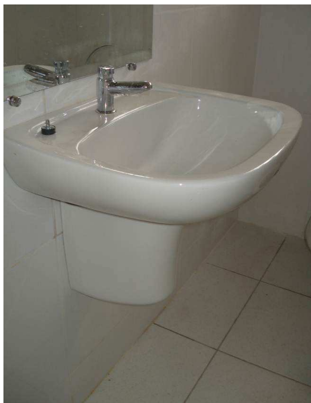
Figura 65C: Lavatório Deca, com válvula de escoamento cromada, instalado no novo banheiro da informática.
