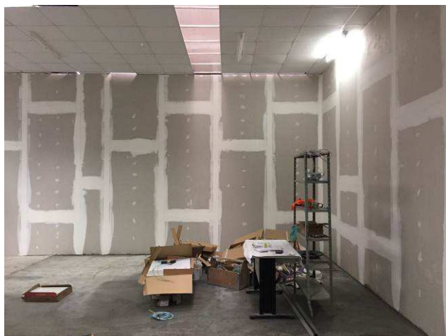
Figura 102C: Juntas das placas de gesso acartonado do laboratório Service Desk emassadas.
