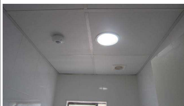
Figura 02E: remanejamento sensores presença e luminárias 23W - banheiros e corredor STI.
