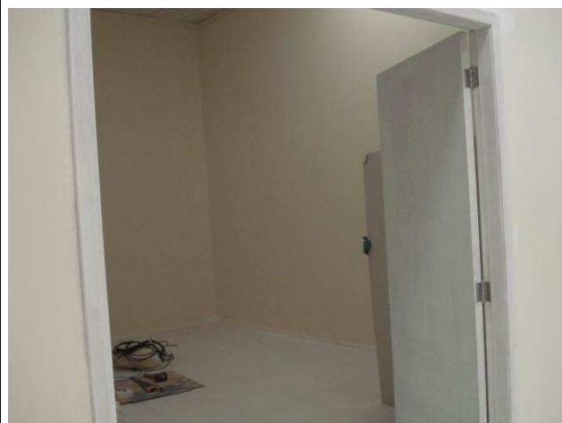
Figura 44C: Após regularização, piso cerâmico assentado no depósito Service Desk.
