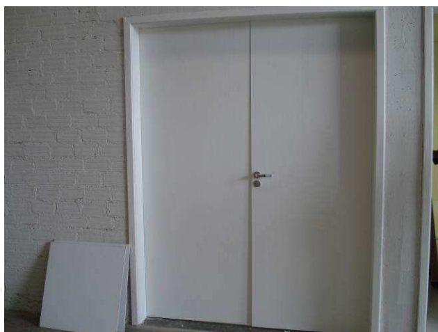
Figura 96C: Porta em madeira PM160x210, em duas folhas de abrir, instalada no acesso ao laboratório Service Desk.
