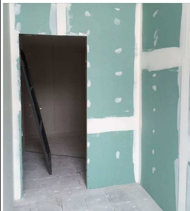
Figura 26C: Parede em gesso acartonado verde executada na copa da informática.
