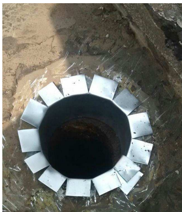
Figura 123C: Adaptação de tubulação de descida com aumento de diâmetro passando de 50mm para 100mm.
