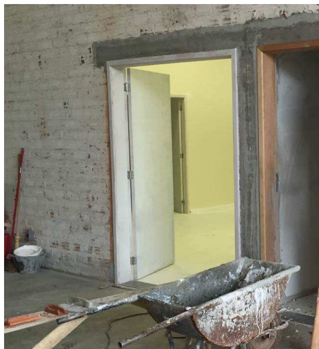
Figura 32C: Verga executada acima do vão da porta de acesso ao laboratório Service Desk.
