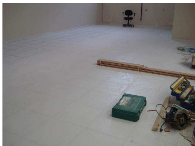
Figura 43C: Piso cerâmico assentado no laboratório Service Desk.
