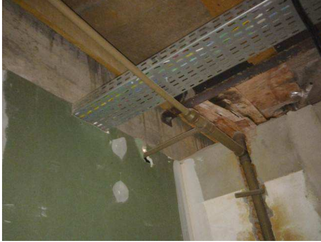
Figura 41C: Prumadas de alimentação (32 mm)
