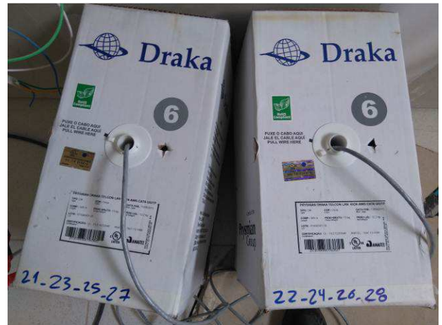
Figura 06E: cabeamento lógico UTP cat 6 - 2º pavimento
