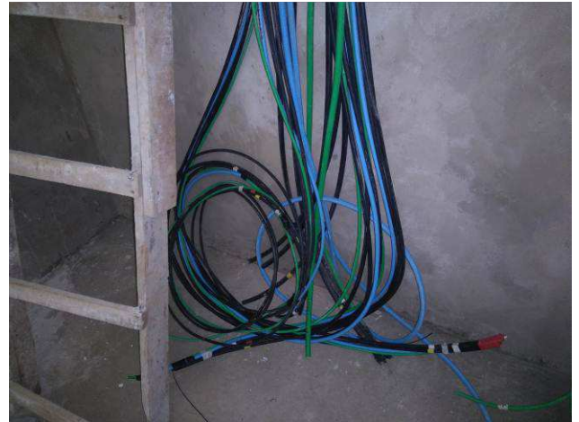
Figura 34E: Ramais alimentadores sala técnica subsolo
