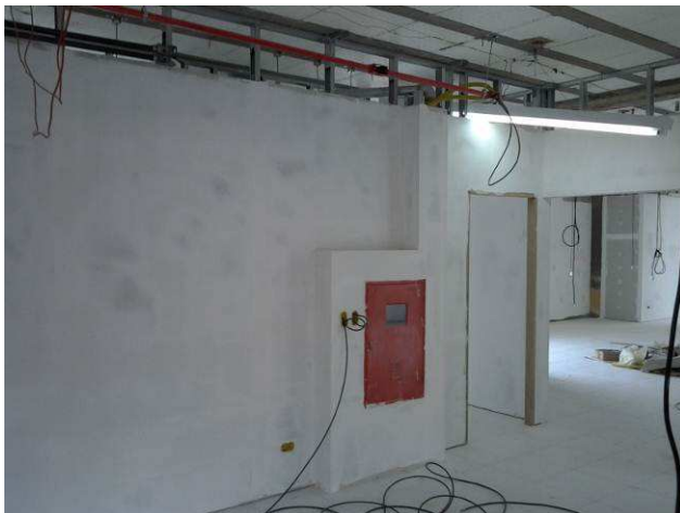
Figura 09C: Paredes de gesso acartonado simples, instaladas no primeiro pavimento
