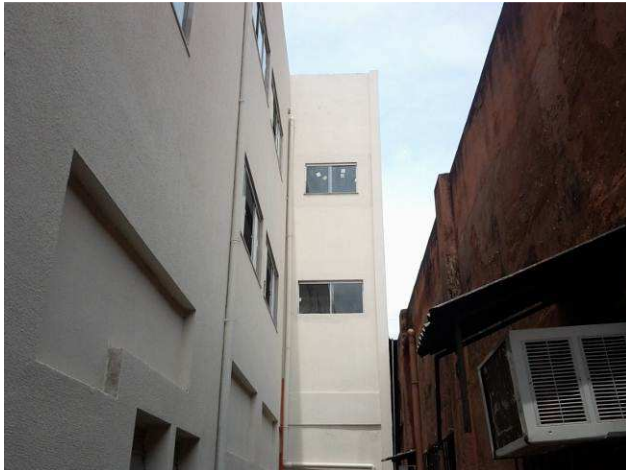
Figura 65C: Segunda demão de textura na lateral esquerda do imóvel
