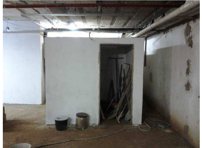
Figura 54C: Emassamento das paredes da cisterna
