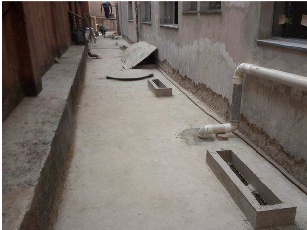
Figura 73C: Furos executados na laje do subsolo, para permitir a exaustão do ambiente
