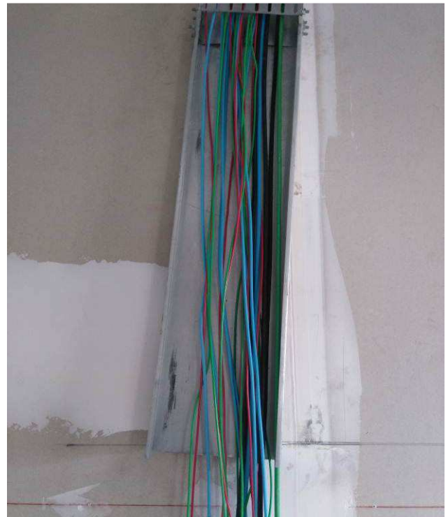
Figura 28E: ramal alimentador e cabeamento elétrica estabilizada 1º pavimento
