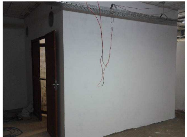
Figura 56C: Emassamento das paredes externas da cabine de transformação
