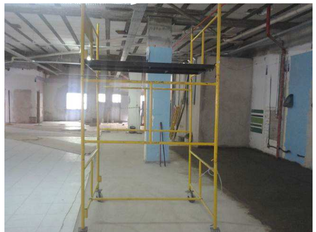
Figura 02C: Uso de andaimes
