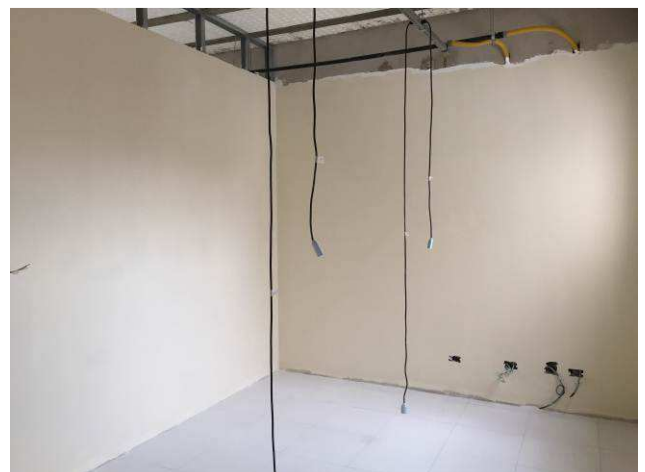
Figura 64C: Pintura de paredes no segundo pavimento - primeira demão
