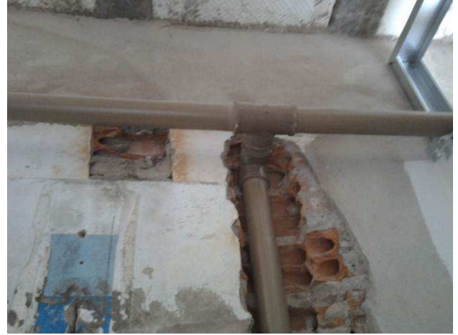
Figura 42C: Prumadas de alimentação (32 mm)
