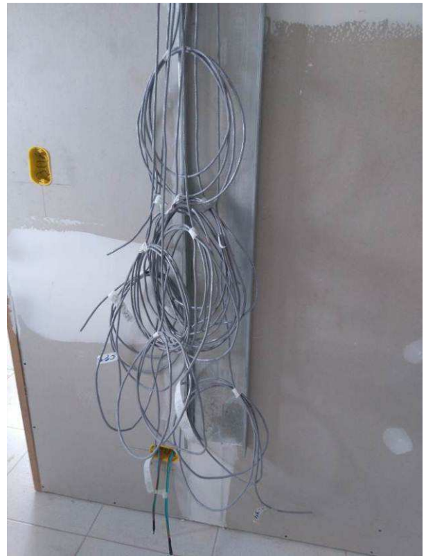
Figura 52E: cabeamento lógico UTP cat 6 - 1º pavimento
