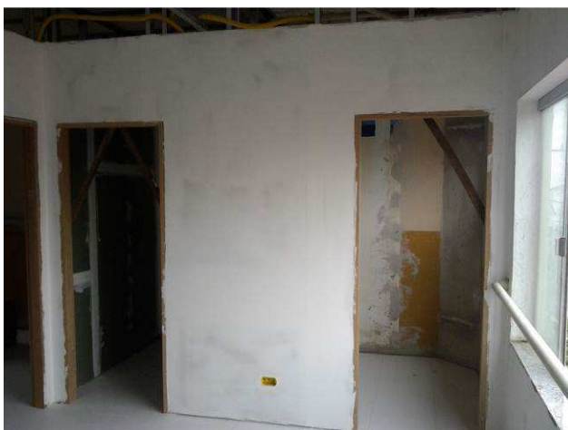
Figura 57C: Emassamento das paredes no primeiro pavimento
