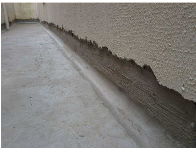
Figura 23C: Detalhe da camada de regularização da base para aplicação de manta - corredor lateral esquerdo do pavimento térreo
