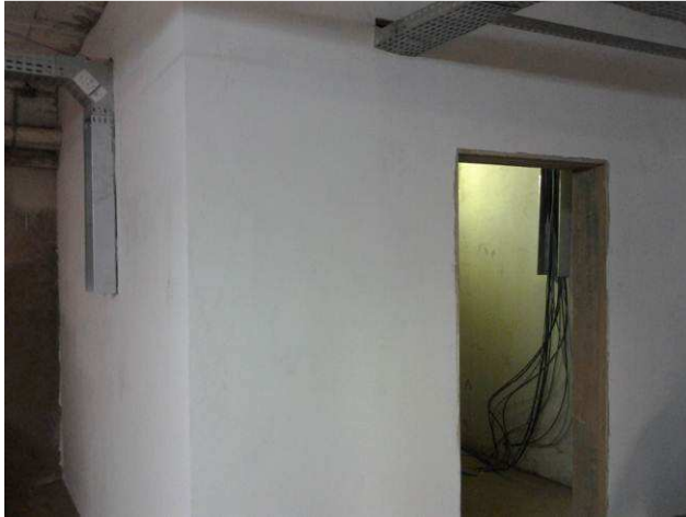
Figura 53C: Emassamento das paredes da sala de nobreak e de transformação, no subsolo
