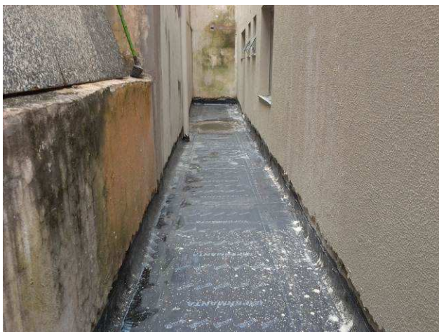
Figuras 29C: Detalhe da aplicação da manta asfáltica - corredor lateral à esquerda, pavimento térreo
