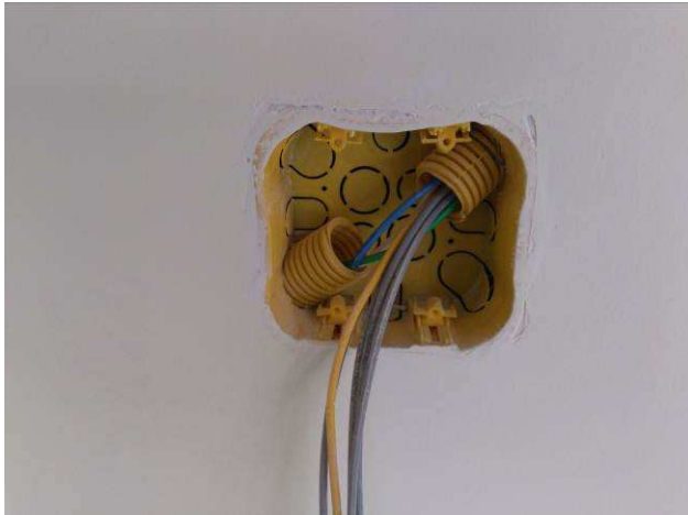
Figura 15E: infraestrutura - eletrodutos e caixas 2x4" e 4x4"
