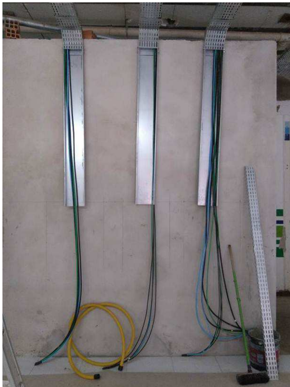
Figura 31E: Ramais alimentadores quadros elétricos Térreo
