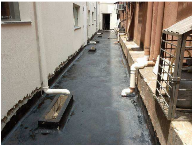
Figuras 27C: Detalhe da aplicação de emulsão asfáltica como substrato para assentamento da manta - corredor lateral à esquerda, pavimento térreo
