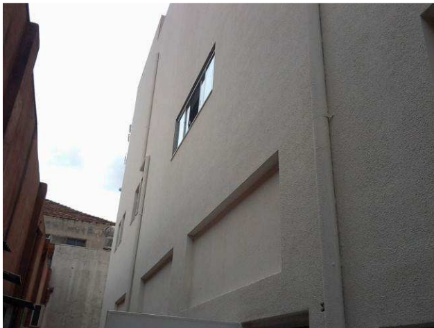
Figura 67C: Segunda demão de textura na lateral esquerda do imóvel
