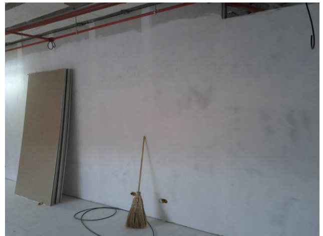
Figura 10C: Paredes de gesso acartonado duplo, instaladas no primeiro pavimento
