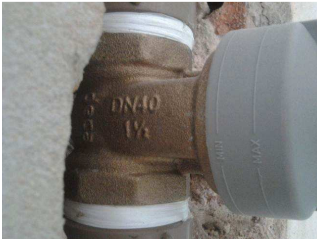
Figura 49C: Registro de gaveta 1 1/2", instalado no primeiro pavimento
