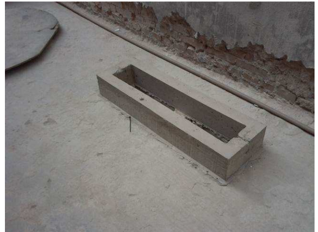
Figura 74C: Furos executados na laje do subsolo, para permitir a exaustão do ambiente
