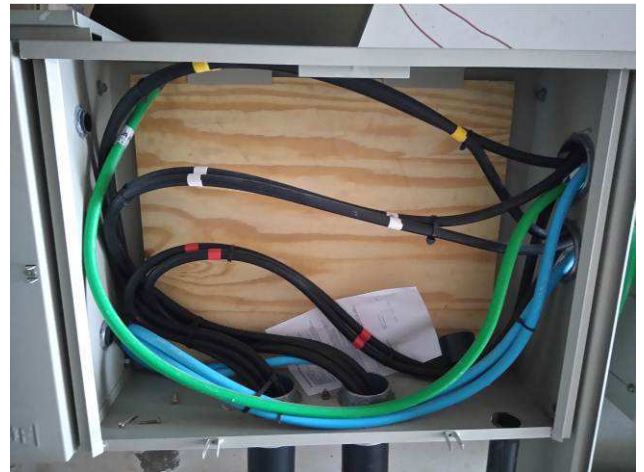
Figura 06E: Caixa FN padrão Copel
