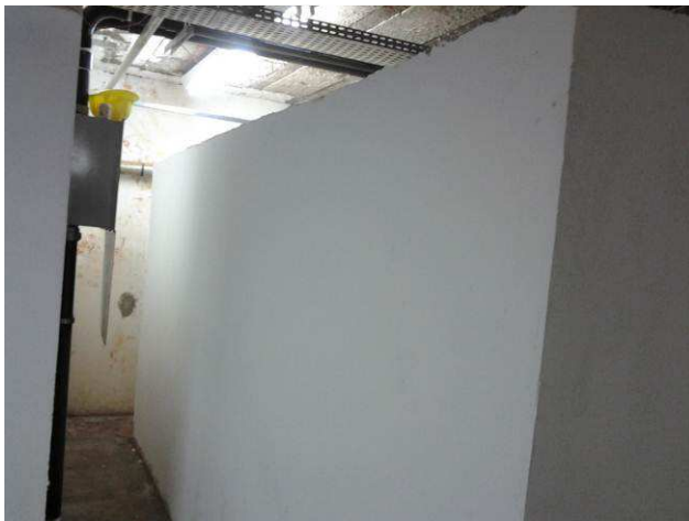
Figura 55C: Emassamento das paredes da cisterna
