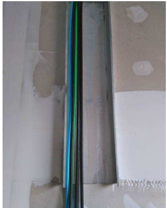
Figura 30E: ramal alimentador QDAC 1º pavimento
