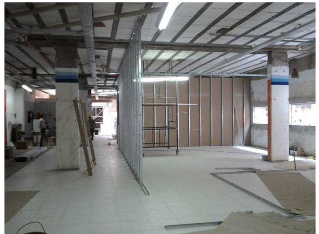
Figura 34C: Execução de piso no pavimento térreo
