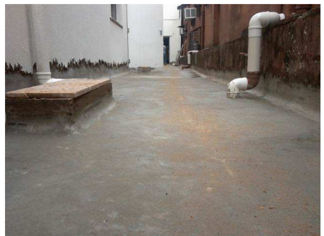
Figura 24C: Detalhe da camada de regularização da base para aplicação de manta - corredor lateral esquerdo do pavimento térreo
