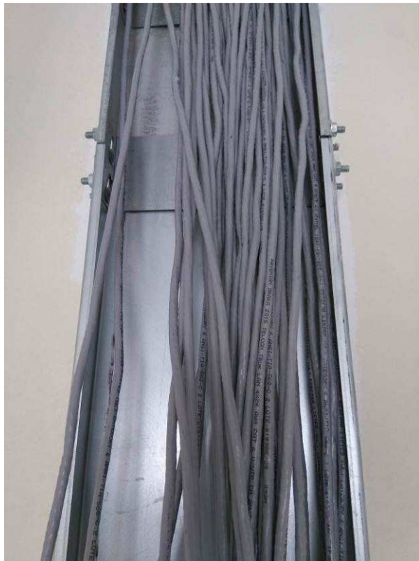
Figura 51E: cabeamento lógico UTP cat 6 - 2º pavimento
