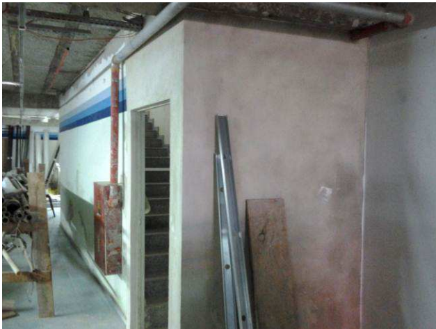
Figura 31C: Revestimento das paredes de adequação da porta corta-fogo no subsolo
