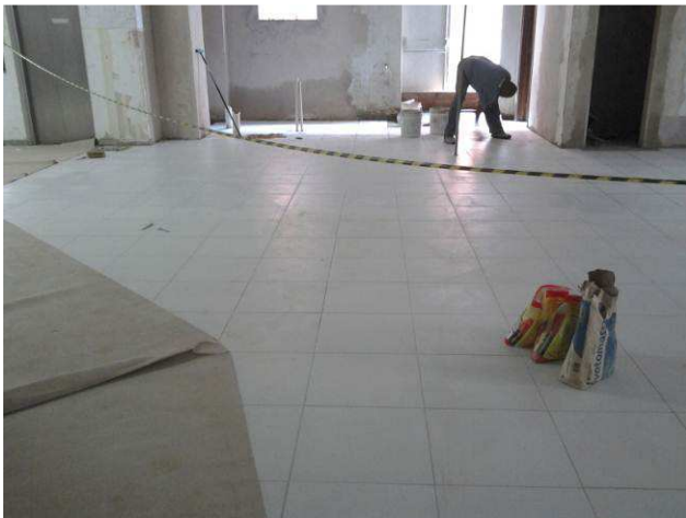
Figura 33C: Execução de piso no pavimento térreo
