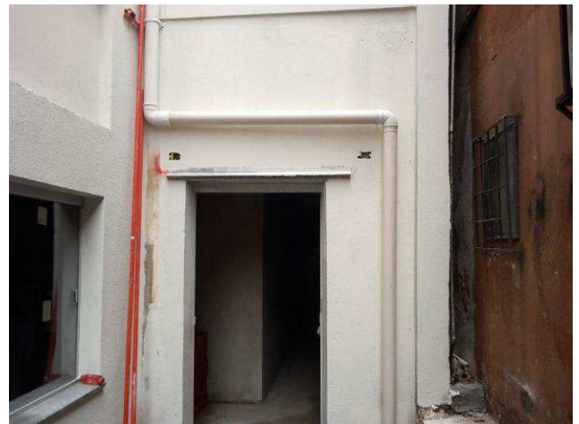
Figura 44C: Readequação de prumadas de água pluvial, na lateral esquerda do imóvel
