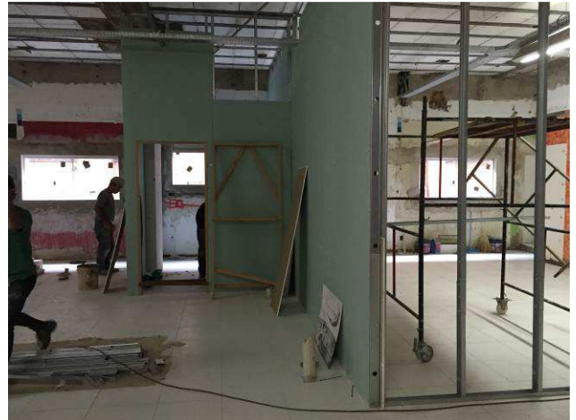
Figura 14C: Paredes de gesso acartonado verde, instaladas no pavimento térreo
