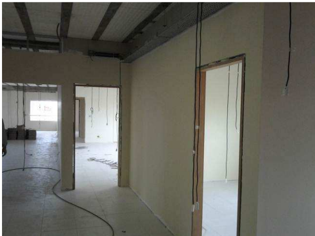
Figura 61C: Pintura de paredes de gesso acartonado, no segundo pavimento - primeira demão
