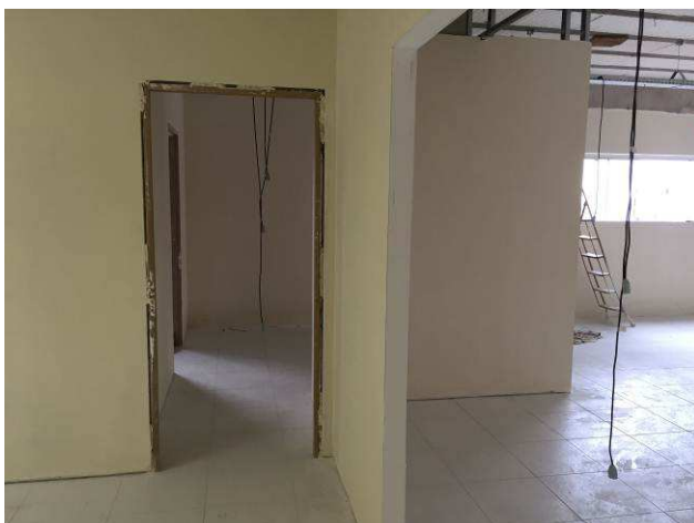
Figura 63C: Pintura de paredes de gesso acartonado, no segundo pavimento - primeira demão
