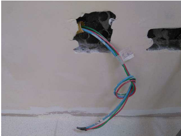
Figura 21E: cabearmento elétrico 2,5mm 2
