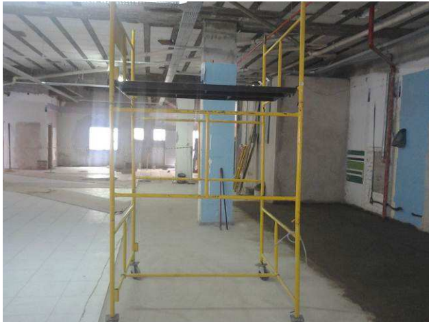
Figura 71C: Camada de contrapiso executada no pavimento térreo - PAB
