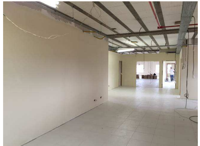
Figura 62C: Pintura de paredes de gesso acartonado, no segundo pavimento - primeira demão
