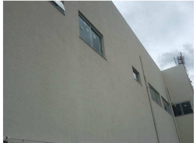
Figura 66C: Segunda demão de textura na lateral direita do imóvel
