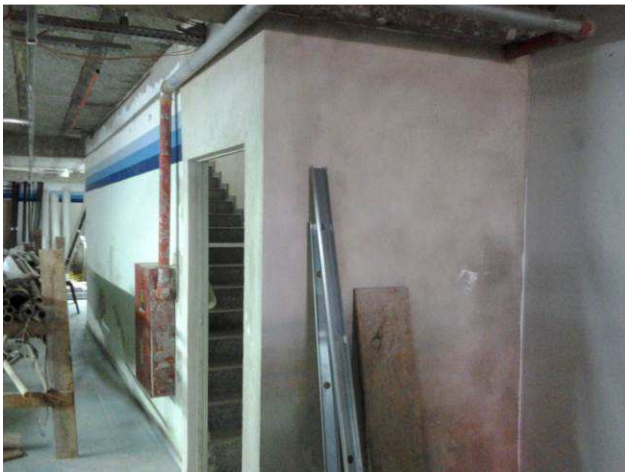
Figura 05C: Detalhes da adequação do vão para instalação de porta corta-fogo junto à escada do subsolo
