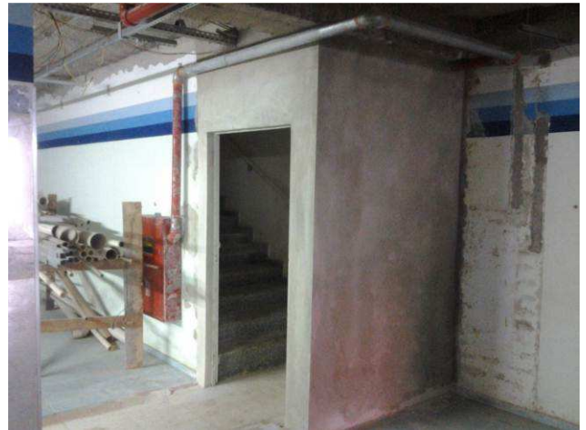
Figura 32C: Revestimento das paredes de adequação da porta corta-fogo no subsolo
