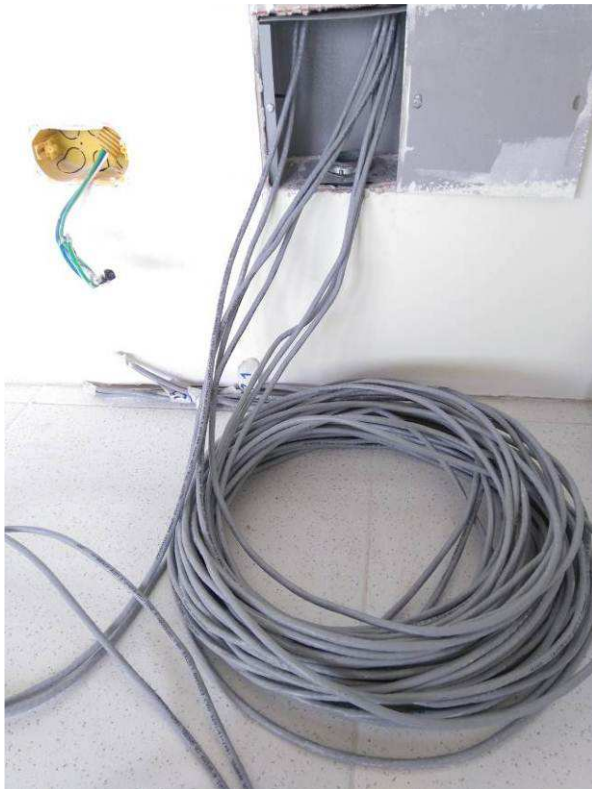
Figura 49E: cabeamento lógico UTP cat 6 - 2º pavimento
