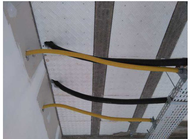
Figura 12E: infraestrutura - eletrodutos
