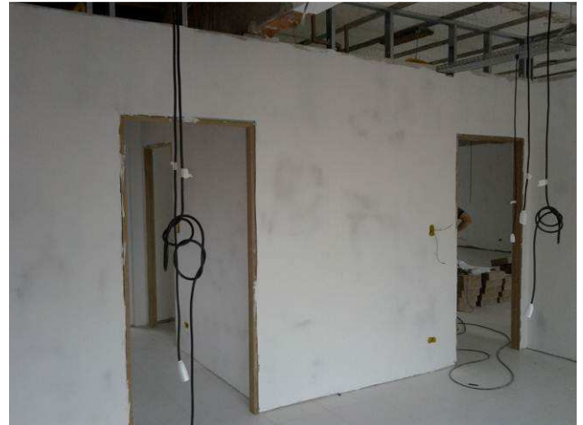
Figura 60C: Emassamento das paredes no primeiro pavimento
