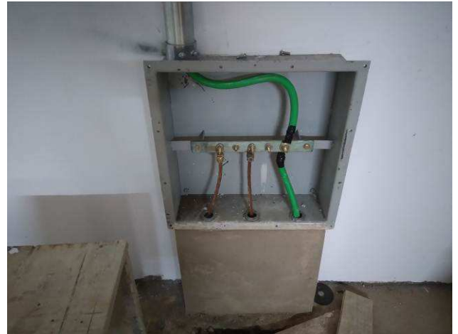
Figura 10E: BEP aterramento geral
