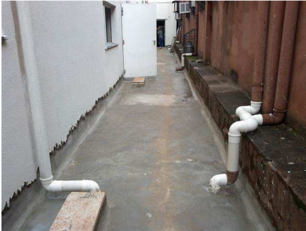
Figura 03C: Demolição das irregularidades e limpeza do piso - corredor lateral esquerdo do pavimento térreo
