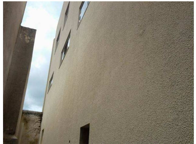
Figura 68C: Segunda demão de textura na parede posterior do imóvel
