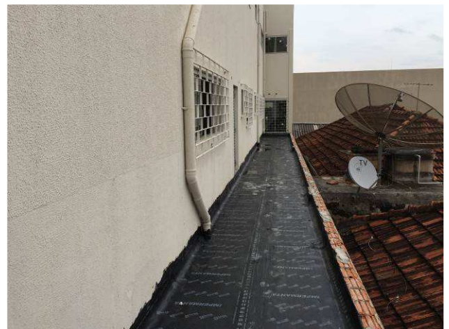
Figuras 30C: Detalhe da aplicação da manta asfáltica - terraço do primeiro pavimento
