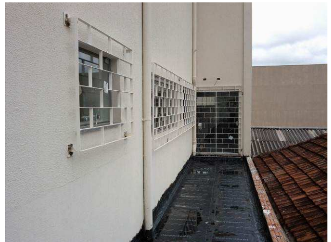
Figura 70C: Grades instaladas na lateral direita (terraço do primeiro pavimento)
