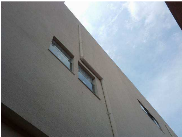
Figura 43C: Readequação de prumadas de água pluvial, na lateral esquerda do imóvel
