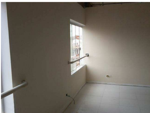
Figura 39C: barras de proteção (corrimão) das janelas, instaladas em janelas do segundo pavimento
