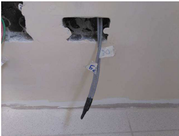
Figura 05E: cabeamento lógico UTP cat 6 - 2º pavimento
