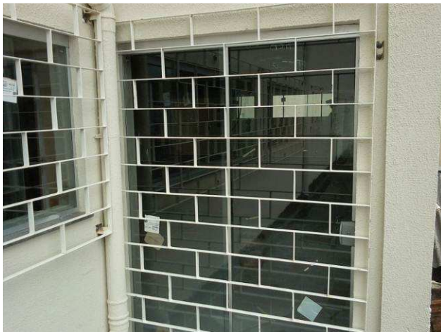
Figura 69C: Grades instaladas na lateral direita (terraço do primeiro pavimento)
