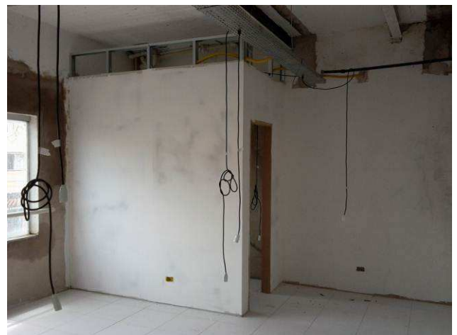
Figura 12C: Paredes de gesso acartonado verde, instaladas no primeiro pavimento
