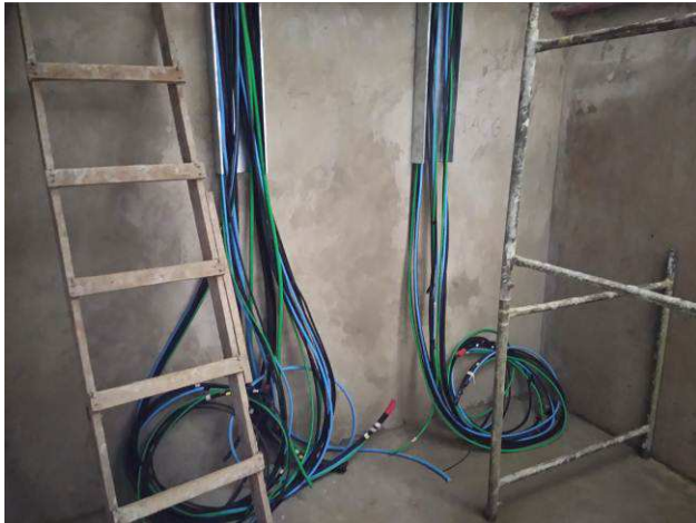
Figura 33E: Ramais alimentadores sala técnica subsolo
