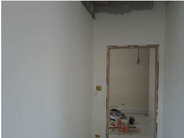
Figura 59C: Emassamento das paredes no primeiro pavimento
