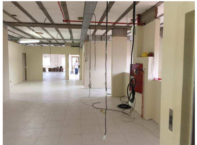
Figura 16C: Paredes de gesso acartonado simples, instaladas no segundo pavimento
