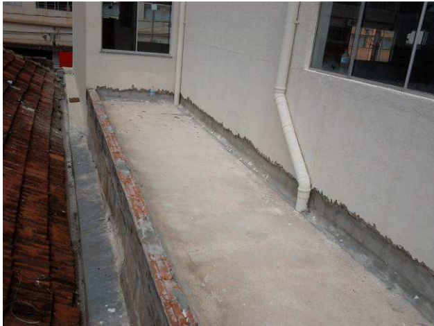
Figuras 25C: Detalhe da camada de regularização da base para aplicação de manta - terraço do primeiro pavimento
