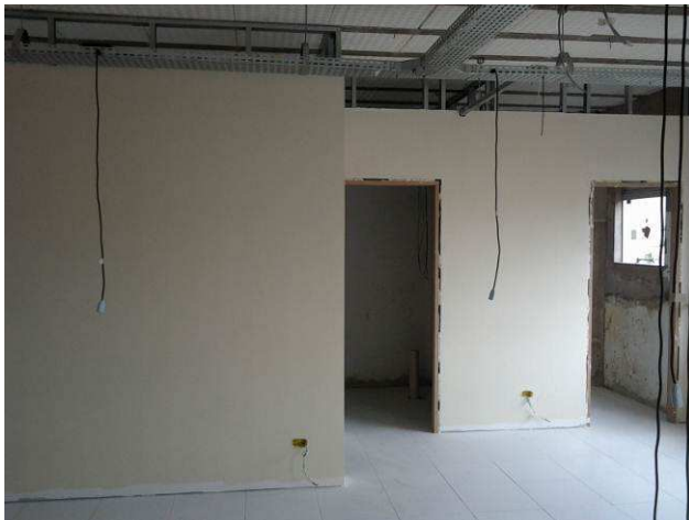
Figura 15C: Paredes de gesso acartonado verde, instaladas no segundo pavimento
