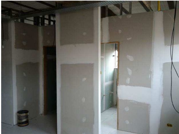
Figura 13C: Paredes de gesso acartonado verde, instaladas no primeiro pavimento
