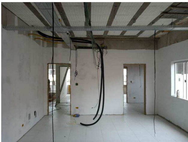
Figura 11C: Paredes de gesso acartonado duplo, instaladas no primeiro pavimento
