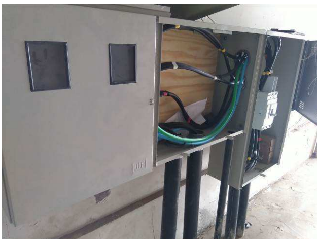
Figura 07E: Caixa EN padrão Copel
