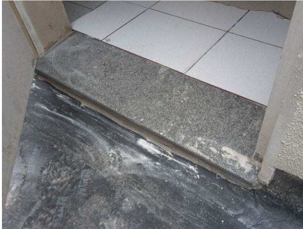
Figura 35C: Soleira instalada na porta de saída da sala múltiplo-uso, no térreo
