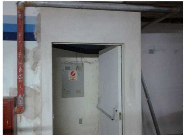
Figura 06C: Detalhes da adequação do vão para instalação de porta corta-fogo junto à escada do subsolo
