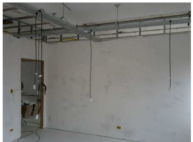
Figura 58C: Emassamento das paredes no primeiro pavimento
