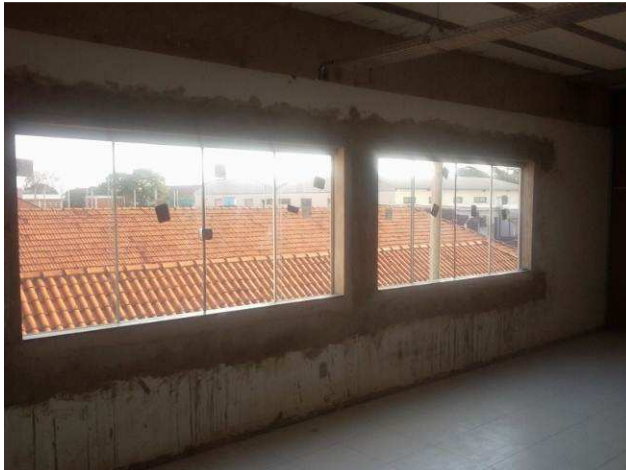
Figura 39C: Esquadrias de vidro instaladas no primeiro pavimento
