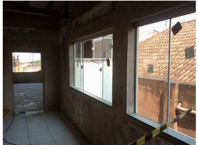
Figura 34C: Esquadrias de vidro instaladas no primeiro pavimento
