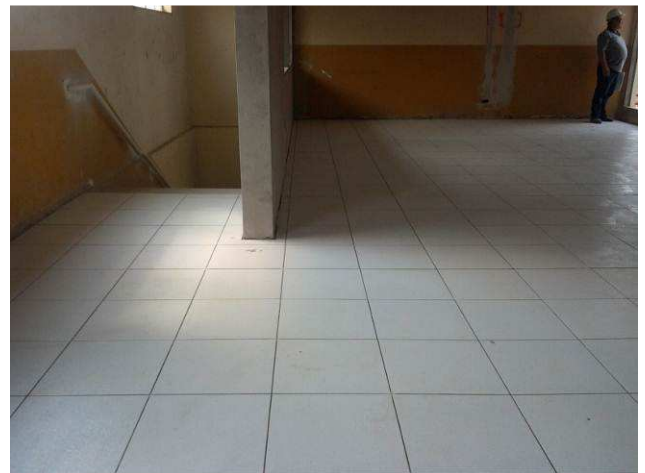
Figura 60C: Detalhe do piso acabado no primeiro pavimento
