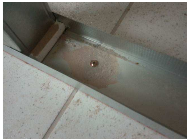
Figura 26C: Detalhe da fixação dos perfis metálicos no piso
