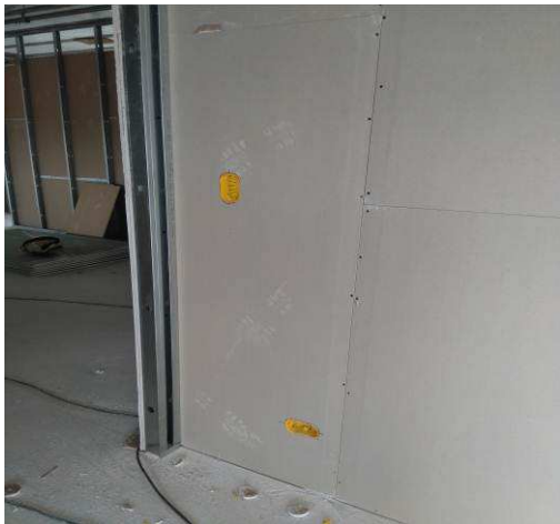
Figura 31E: eletrodutos e caixas 2x4" drywall - 2º pavimento
