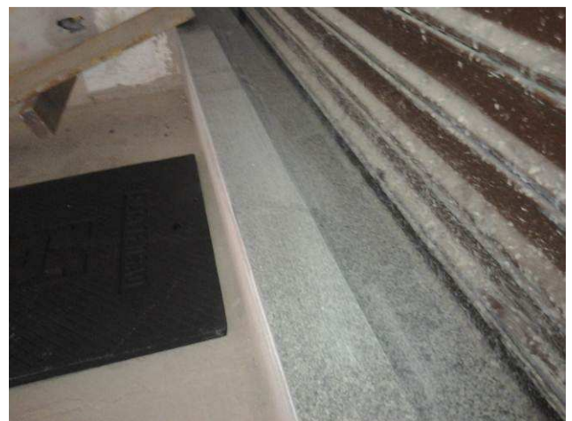
Figura 68C: Peitoril de granito, instalado na janela da fachada frontal, no pavimento térreo
