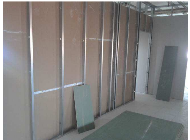
Figura 18C: Paredes de gesso acartonado verde no segundo pavimento
