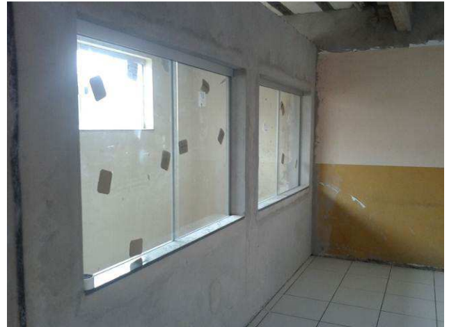
Figura 40C: Esquadrias de vidro instaladas no primeiro pavimento
