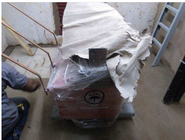
Figura 11E: transformador 150kVA
