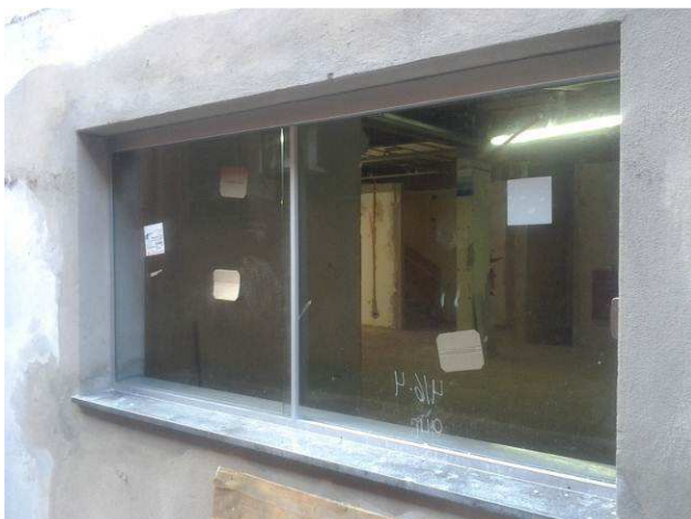
Figura 31C: Esquadrias de vidro instaladas no pavimento térreo
