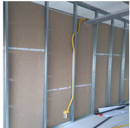
Figura 28E: eletrodutos e caixas 2x4" drywall - 2º pavimento
