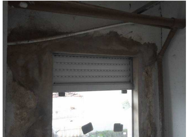
Figura 46C: Esquadrias de vidro instaladas no segundo pavimento
