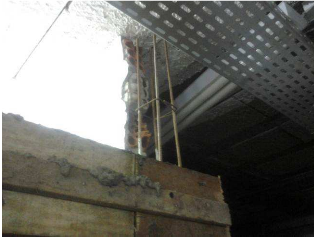
Figura 09C: Pilares e vigas de amarração da alvenaria no subsolo
