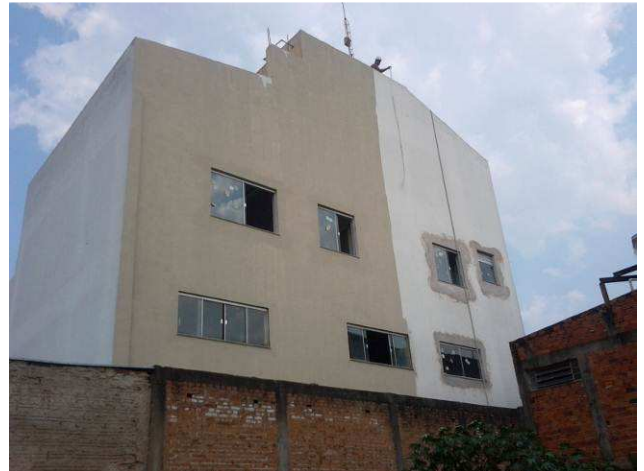
Figura 76C: Fachada dos fundos, durante aplicação de uma demão de textura
