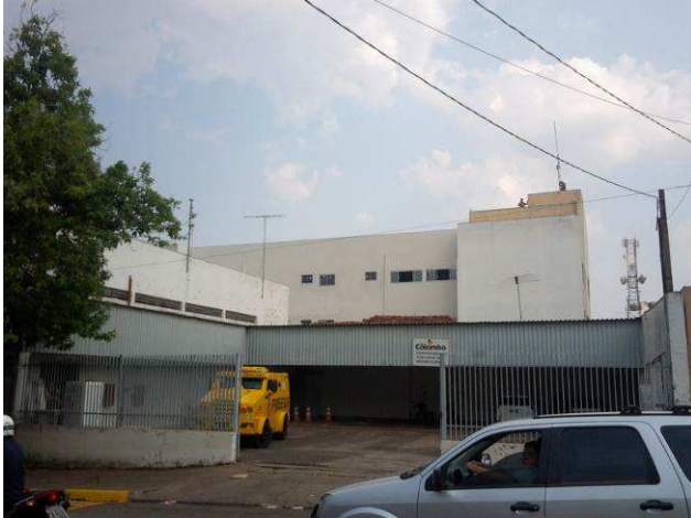
Figura 73C: Fachada lateral direita, após aplicação de uma demão de textura
