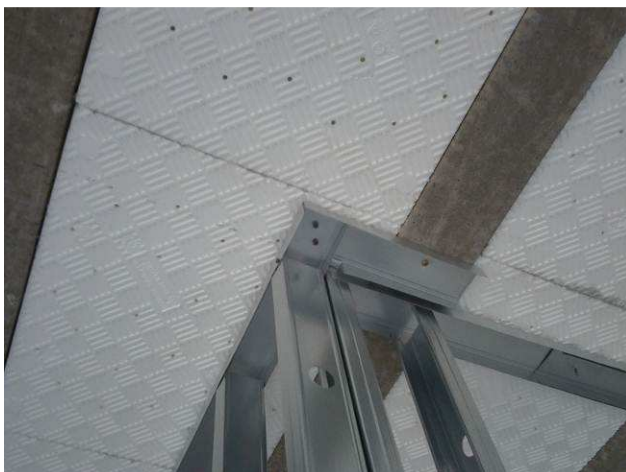
Figura 25C: Detalhe da fixação dos perfis metálicos na laje
