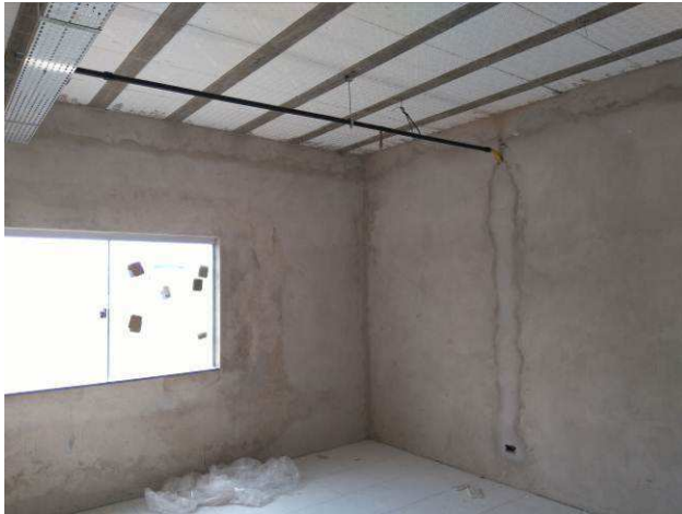
Figura 25E: eletrodutos e caixas 2x4" - 2º pavimento
