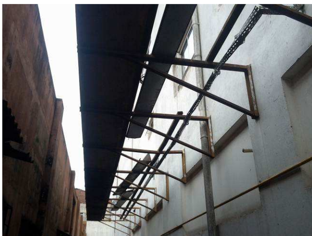
Figura 07C: Fachada lateral esquerda, antes da remoção da estrutura metálica
