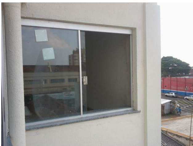
Figura 43C: Esquadrias de vidro instaladas no segundo pavimento
