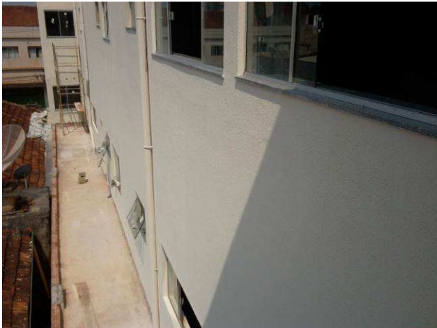
Figura 75C: Fachada lateral direita, após aplicação de uma demão de textura
