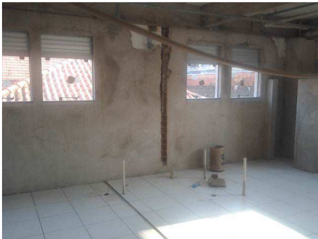
Figura 41C: Esquadrias de vidro instaladas no primeiro pavimento
