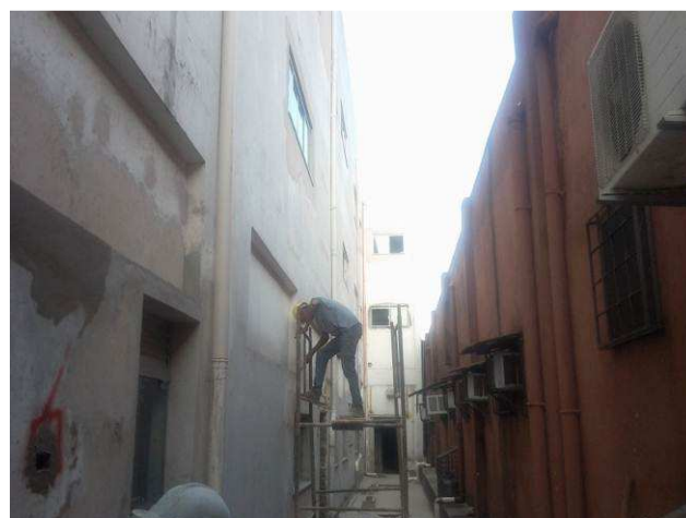
Figura 02C: Uso de andaimes
