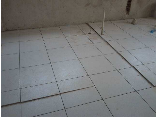
Figura 57C: Piso cerâmico instalado no BWC público do primeiro pavimento
