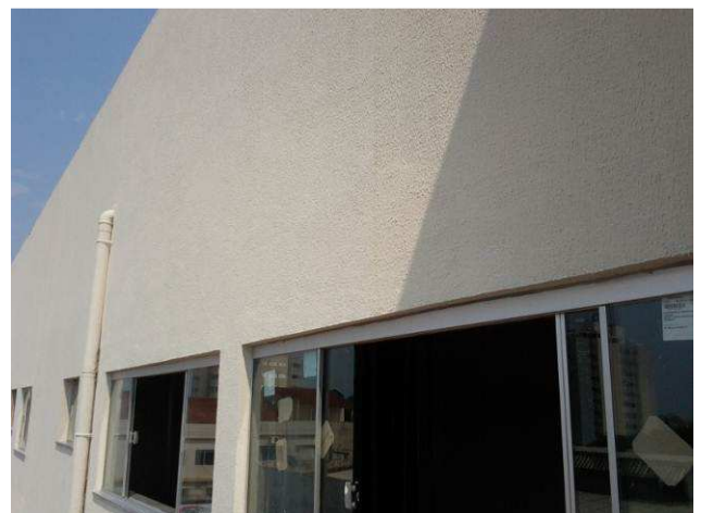
Figura 44C: Esquadrias de vidro instaladas no segundo pavimento
