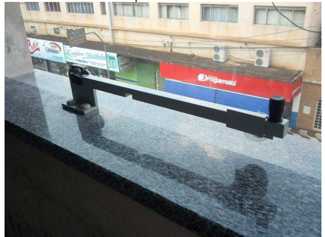
Figura 48C: Esquadrias de vidro instaladas no segundo pavimento
