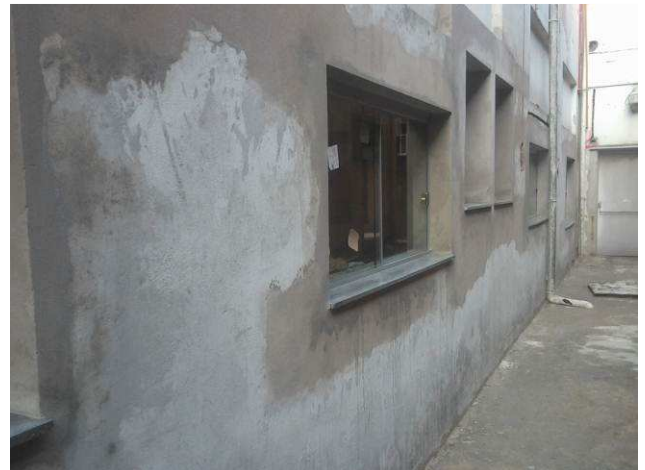
Figura 30C: Esquadrias metálicas instaladas no pavimento térreo
