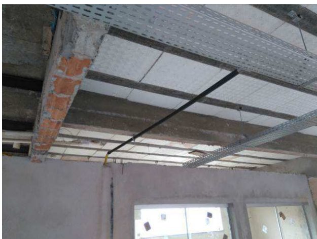
Figura 23E: eletrodutos e caixas 2x4" - 1º pavimento
