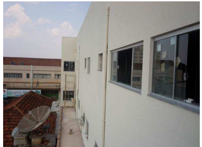
Figura 42C: Esquadrias de vidro instaladas no segundo pavimento
