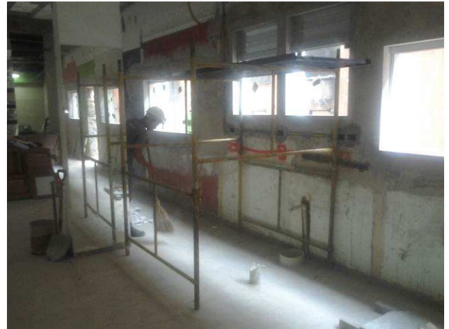
Figura 04C: Uso de andaimes
