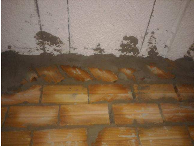
Figura 15C: Parede da sala técnica - detalhe do encunhamento
