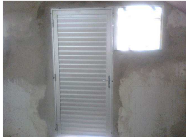
Figura 52C: Porta de alumínio veneziana instalada no pavimento térreo
