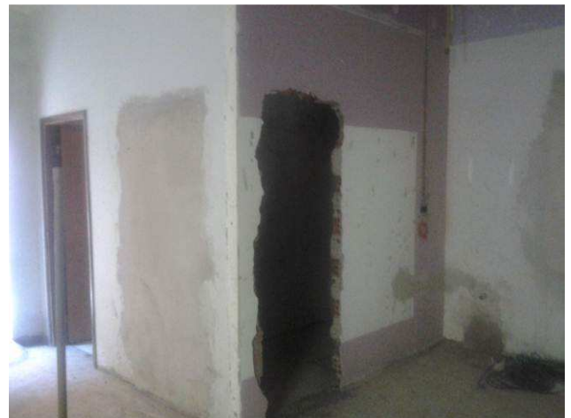
Figura 06C: Sanitário após remoção da porta
