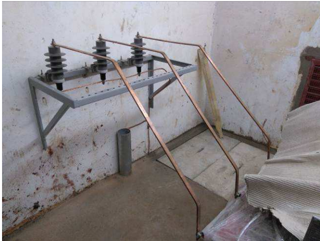
Figura 13E: transformador 150kVA e barramentos
