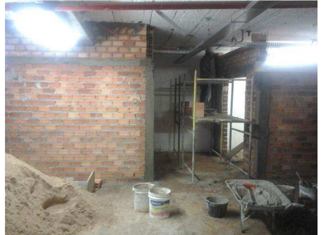
Figura 10C: Pilares e vigas de amarração da alvenaria no subsolo
