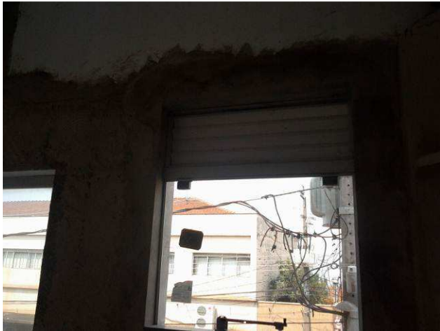
Figura 33C: Esquadrias de vidro instaladas no primeiro pavimento
