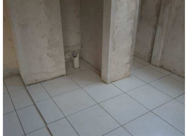
Figura 58C: Piso cerâmico instalado no BWC público do primeiro pavimento
