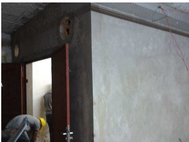
Figura 55C: Parede da cabine de transformação com aplicação de revestimento (chapisco + emboço paulista)
