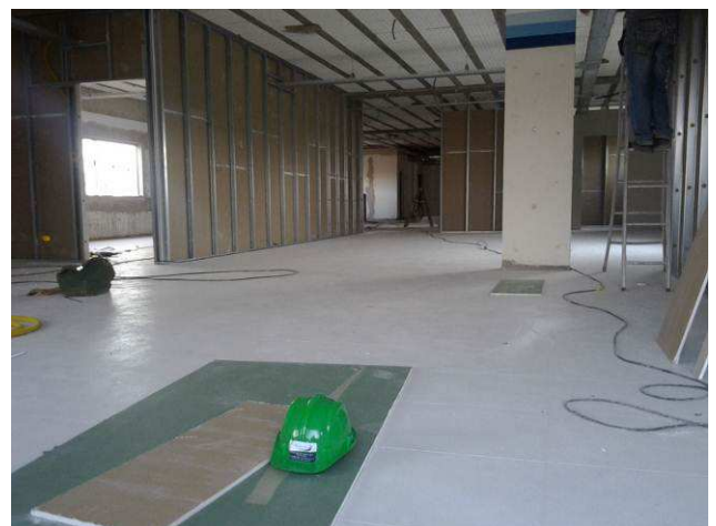
Figura 62C: Piso executado no segundo pavimento
