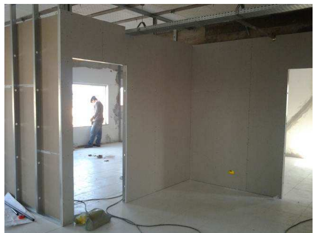
Figura 20C: Paredes de gesso acartonado simples no segundo pavimento
