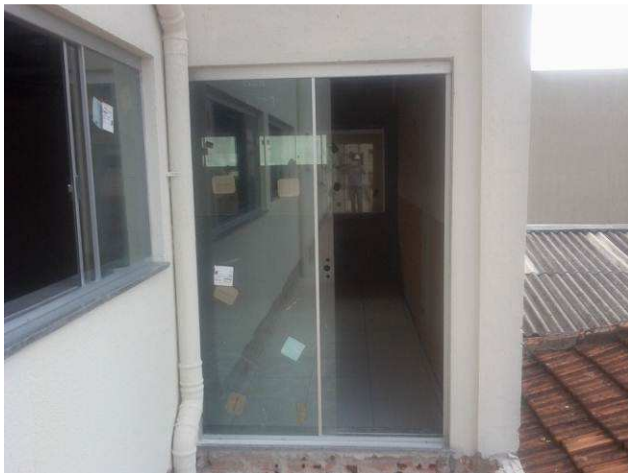
Figura 35C: Esquadrias de vidro instaladas no primeiro pavimento
