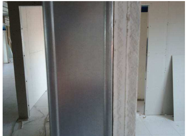
Figura 24C: Detalhe da aplicação das placas de gesso acartonado duplas (acústicas)
