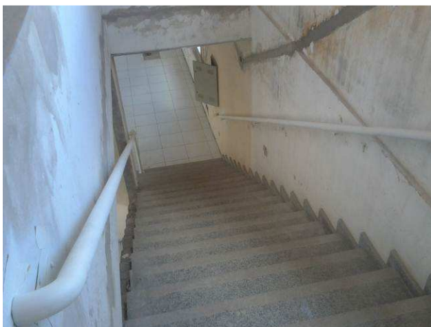
Figura 67C: Corrimão instalado na escada de acesso ao segundo pavimento
