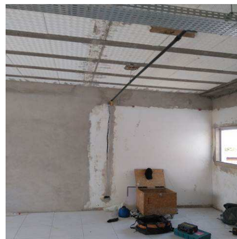
Figura 24E: eletrodutos e caixas 2x4" - 2º pavimento
