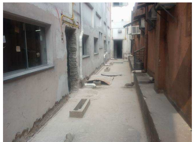
Figura 08C: Fachada lateral esquerda após demolição da estrutura metálica
