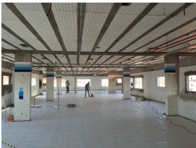
Figura 61C: Detalhe do piso acabado no segundo pavimento
