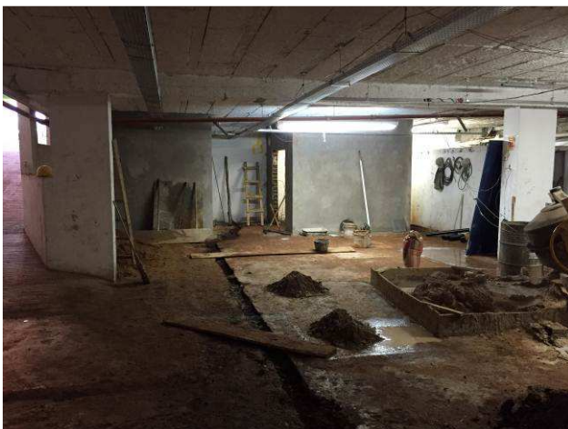
Figura 17E: malha de aterramento
