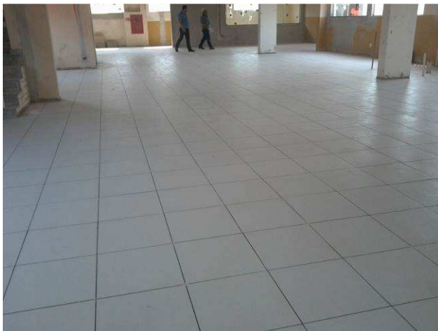
Figura 59C: Detalhe do piso acabado no primeiro pavimento
