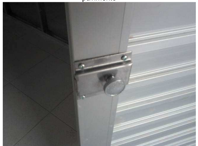
Figura 50C: Detalhe da fechadura das portas dos boxes dos banheiro públicos do segundo pavimento
