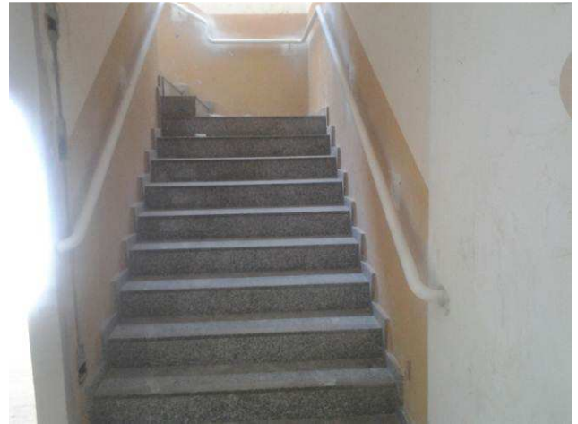
Figura 64C: Corrimão instalado na escada de acesso ao primeiro pavimento
