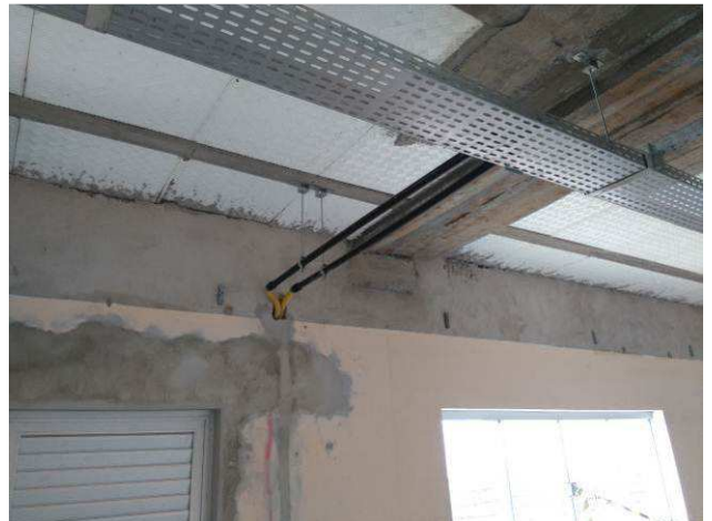
Figura 22E: eletrodutos e caixas 2x4" - 1º pavimento
