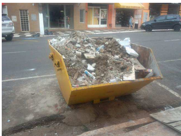
Figura 01C: caçambas para remoção de entulho
