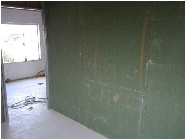
Figura 23C: Detalhe da aplicação das placas de gesso acartonado verde (resistente à água)
