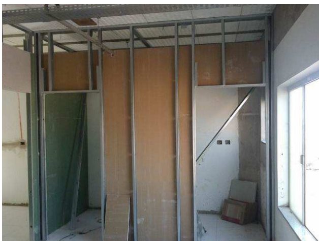
Figura 19C: Paredes de gesso acartonado verde no segundo pavimento
