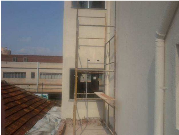
Figura 03C: Uso de andaimes
