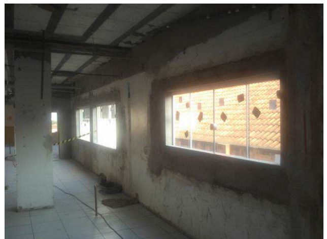
Figura 38C: Esquadrias de vidro instaladas no primeiro pavimento
