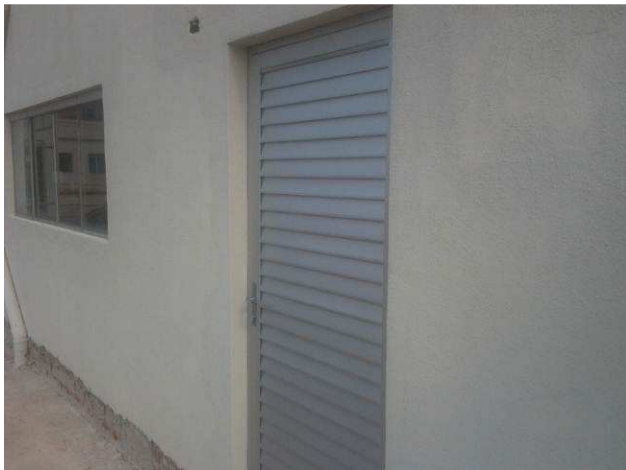
Figura 53C: Porta de alumínio veneziana instalada no primeiro pavimento
