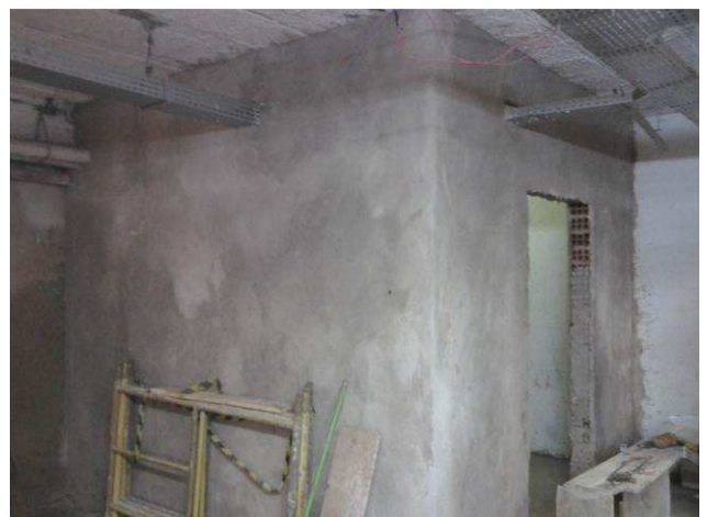
Figura 56C: Parede da sala técnica com aplicação de revestimento (chapisco + emboço paulista)
