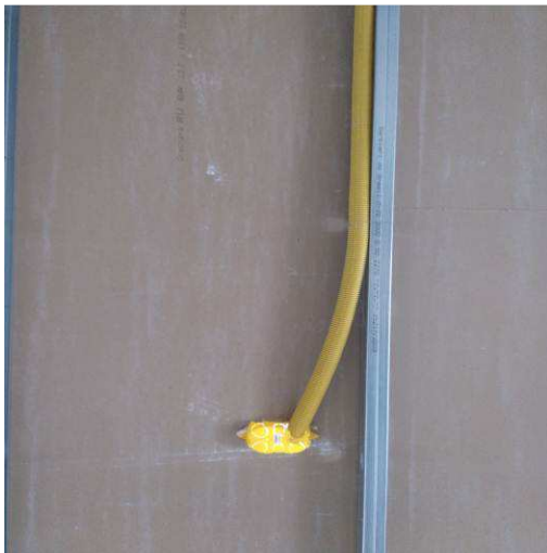
Figura 27E: eletrodutos e caixas 2x4" drywall - 2º pavimento
