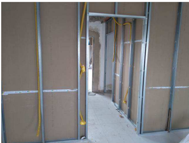
Figura 29E: eletrodutos e caixas 2x4" drywall - 2º pavimento
