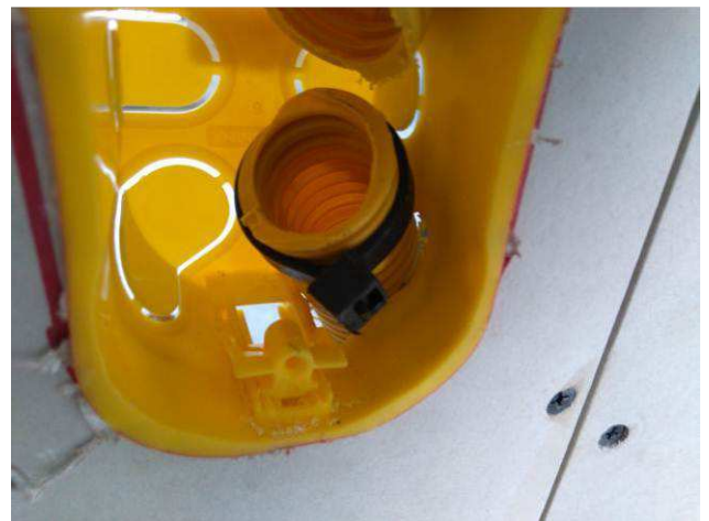
Figura 30E: eletrodutos e caixas 2x4" drywall - 2º pavimento
