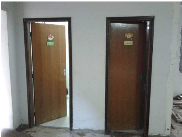
Figura 05C: Porta de sanitário, antes de sua remoção
