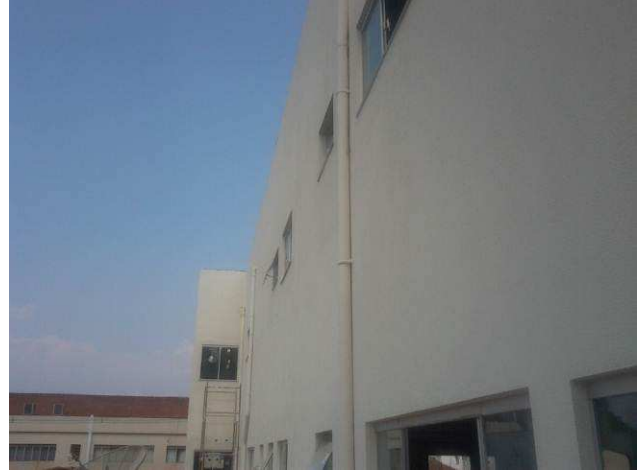
Figura 74C: Fachada lateral direita, após aplicação de uma demão de textura
