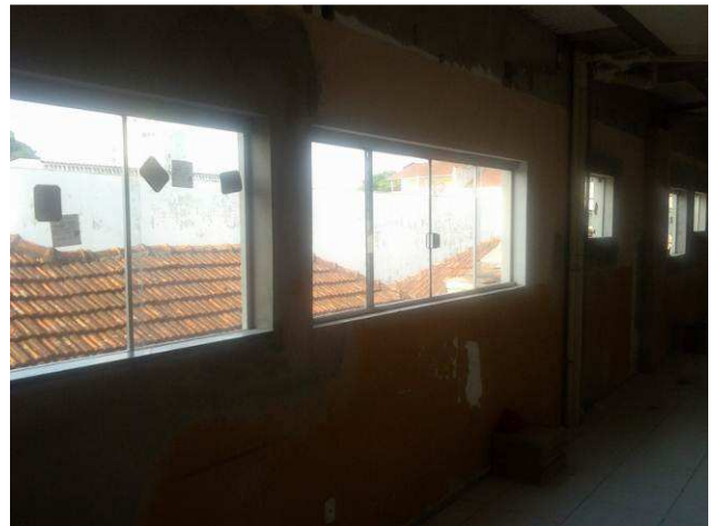
Figura 36C: Esquadrias de vidro instaladas no primeiro pavimento
