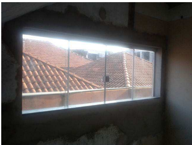
Figura 37C: Esquadrias de vidro instaladas no primeiro pavimento
