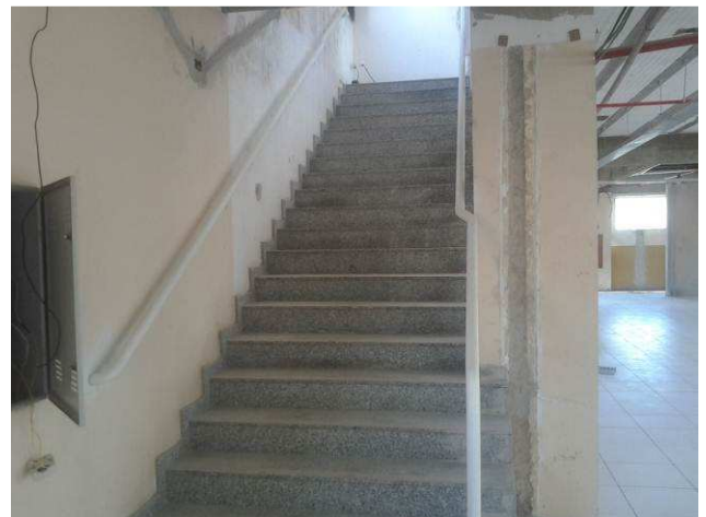
Figura 66C: Corrimão instalado na escada de acesso ao segundo pavimento
