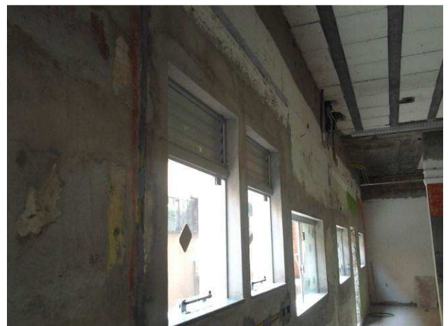
Figura 32C: Esquadrias de vidro instaladas no pavimento térreo
