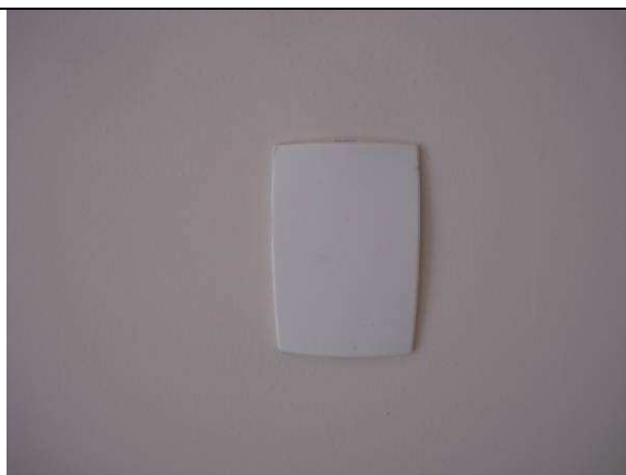
Figura 06E: Interruptores, tomadas, espelhos 1ª VT, hall e Distribuição.
