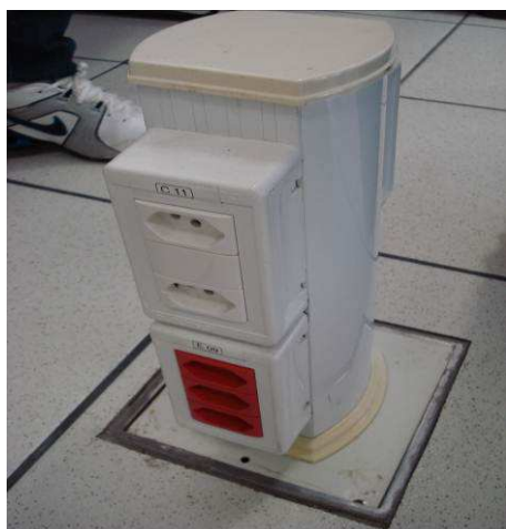
Figura 03E: Tomadas elétricas, espelhos cegos, porta equipamentos Dutotec.
