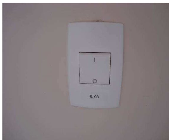
Figura 04E: Interruptores, tomadas, espelhos 1ª VT, hall e Distribuição.
