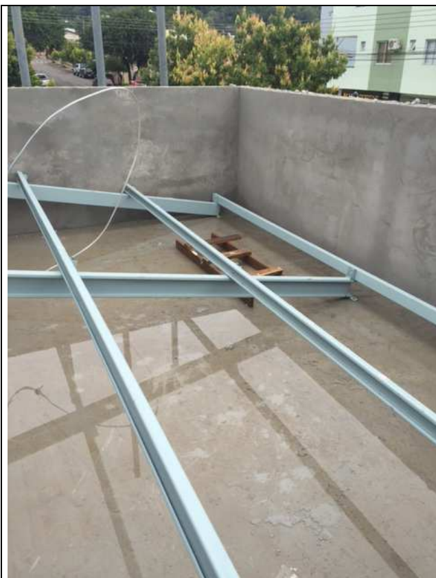
Figura 91C: Estrutura metálica de cobertura.
