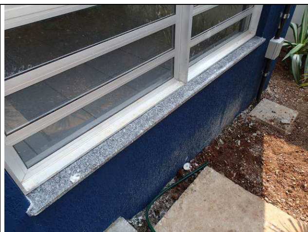
Figura 99C: Peitoril em granito - JA2E.
