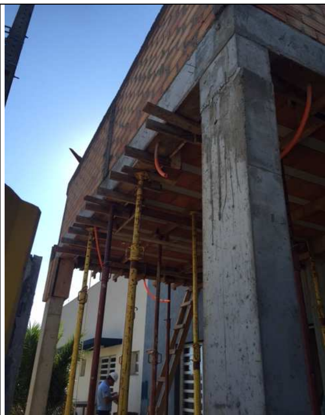
Figura 84C: Pilares, vigas e laje pré-moldada.
