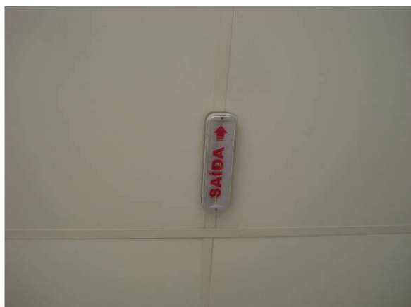
Figura 15E: Luminárias revisadas e novos blocos emergência.
