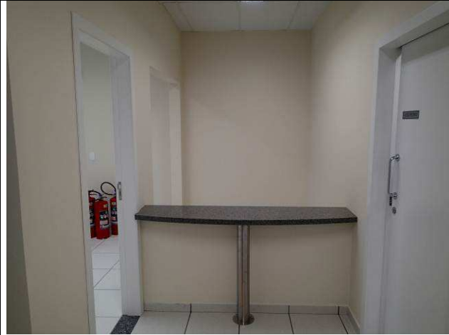
Figura 31C: Pintura interna - distribuição.
