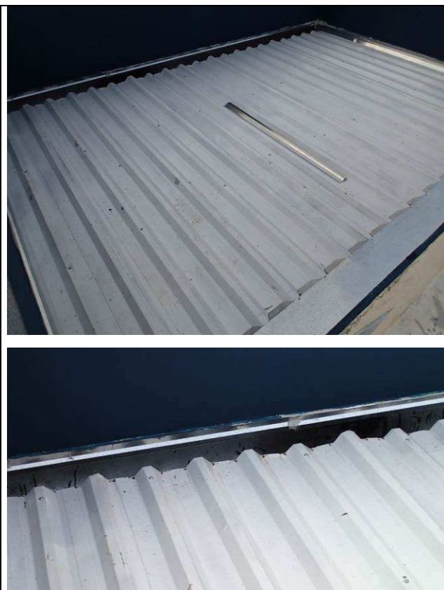
Figura 92C: Cobertura com telha metálica tipo "sanduíche" e calha.
