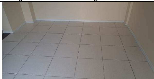
Figura 101C: Rodapé em poliestireno.
