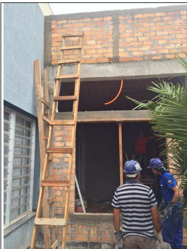
Figura 87C: Paredes de alvenaria.
