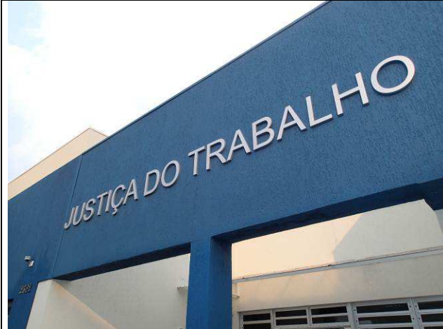
Figura 11C: Comunicação visual - letreiro da fachada.
