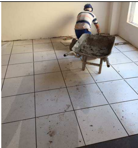
Figura 97C: Assentamento do piso cerâmico.
