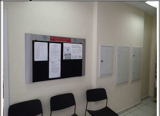
Figura 34C: Pintura interna - hall.
