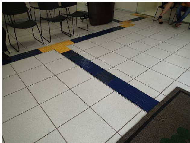
Figura 09C: Piso podotáteis de borracha - caminho para o balcão 2ª Vara.
