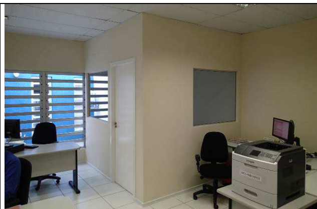
Figura 59C: Paredes de gesso acartonado - sala do assistente do juiz da 2ª Vara.
