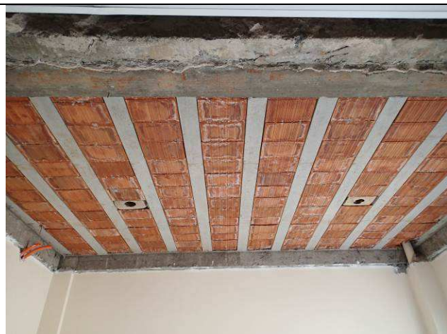
Figura 85C: Laje pré-moldada e vigas de cobertura.
