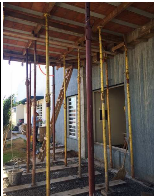
Figura 83C: Vigas baldrame e escoramento da laje pré-moldada.
