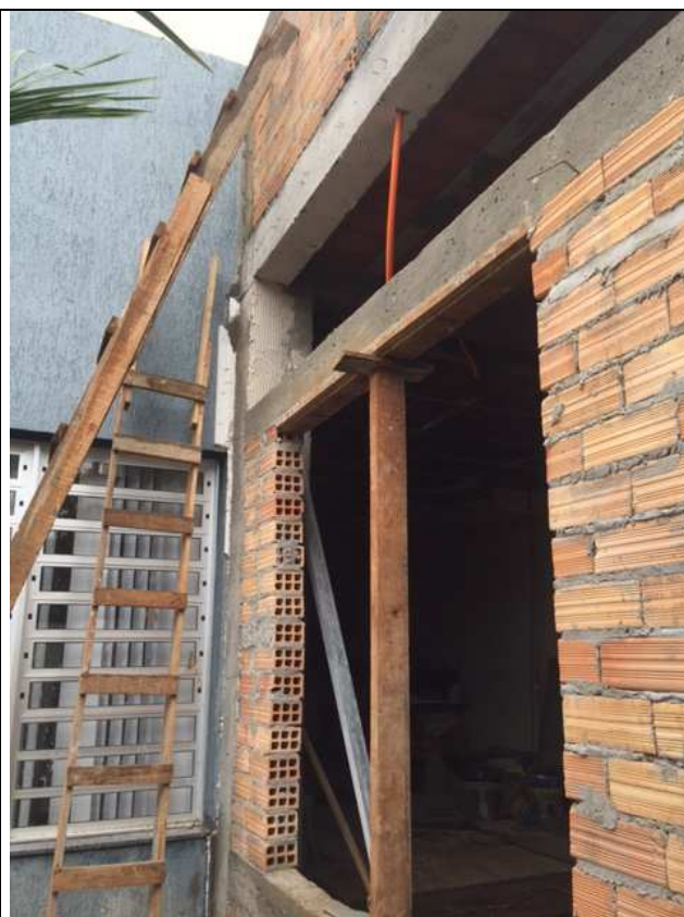
Figura 88C: Verga para janela JA2E.
