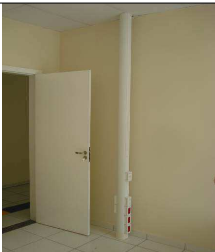
Figura 01E: Coluna técnica Dutotec remanejada da 1ª VT para Distribuição.
