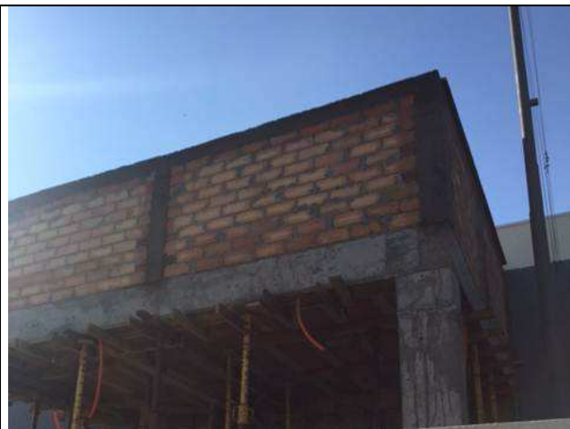
Figura 86C: Pilaretes e viga cinta da platibanda.
