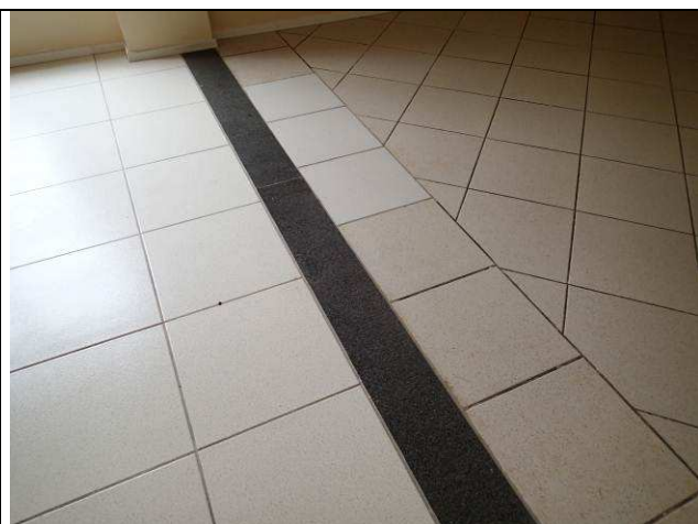
Figura 100C: Soleira em granito.
