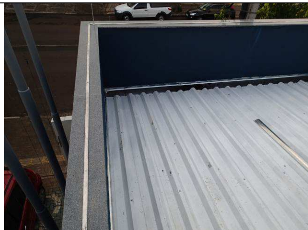
Figura 93C: Copeamento no topo da platibanda.
