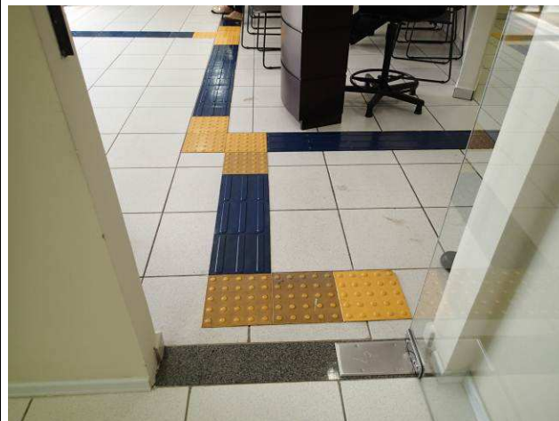
Figura 10C: Piso podotáteis de borracha - caminho para o balcão 2ª Vara.
