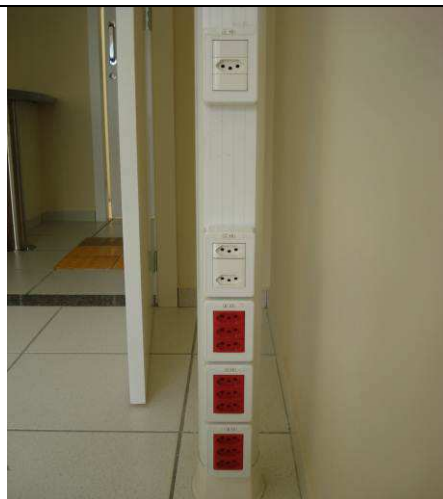
Figura 02E: Tomadas elétricas, espelhos cegos, porta equipamentos Dutotec.
