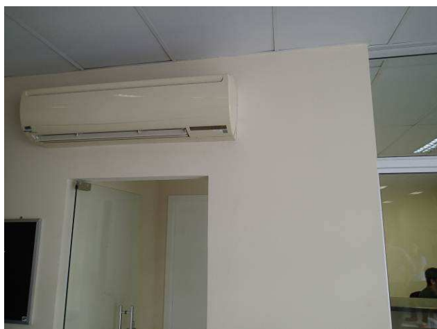
Figura 71C: Evaporadora de ar condicionado Split relocada no hall público.
