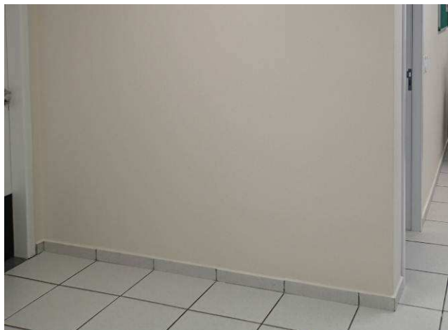
Figura 27C: Rodapé cerâmico.
