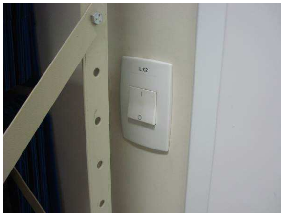
Figura 08E: Interruptores, tomadas, espelhos 1ª VT, hall e Distribuição.
