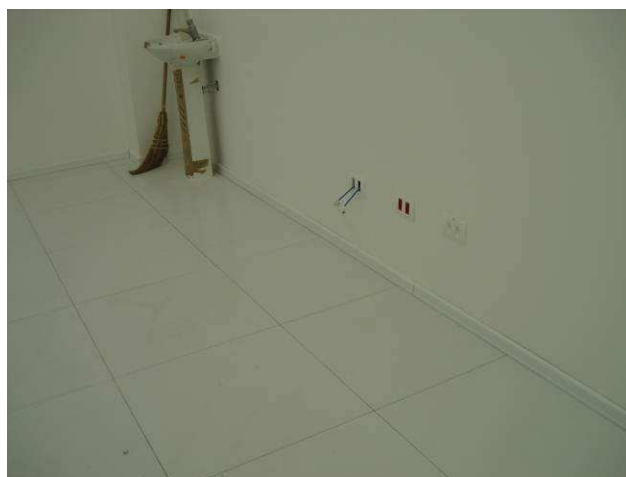
Figura 32C: Rodapé em poliestireno reciclado instalado no consultório.
