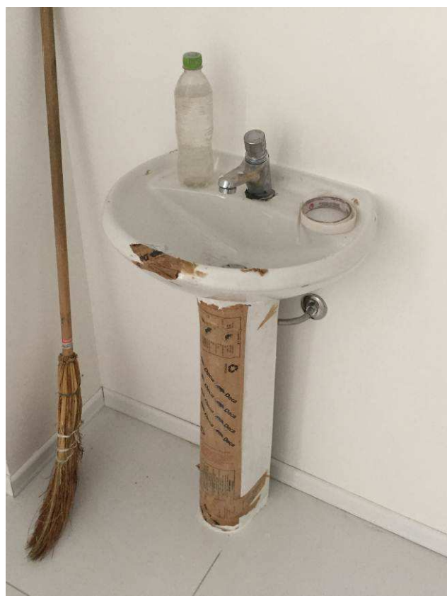
Figura 75C: Lavatório instalado no consultório.
