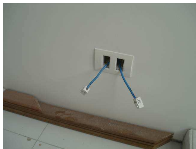
Figura 42E: pontos de rede - consultório e ambulatório.
