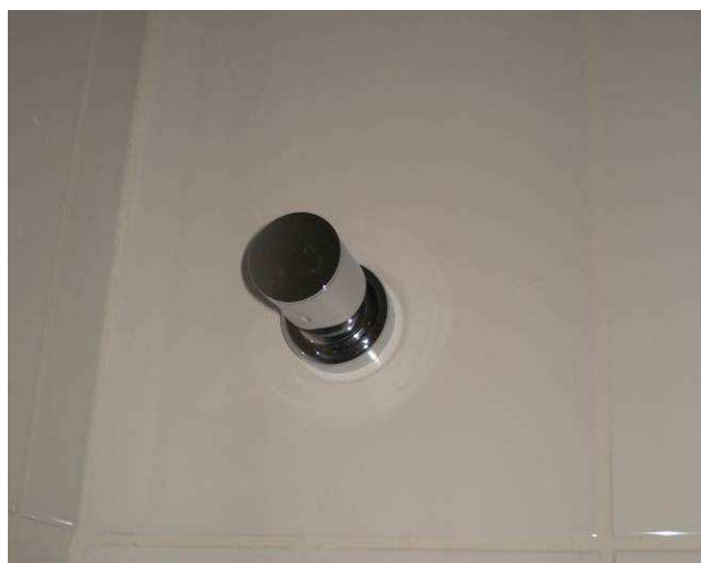
Figura 119C: Instalados canopla e acabamentos cromados para os registros de gaveta 3/4" do banheiro/vestiário masculino.
