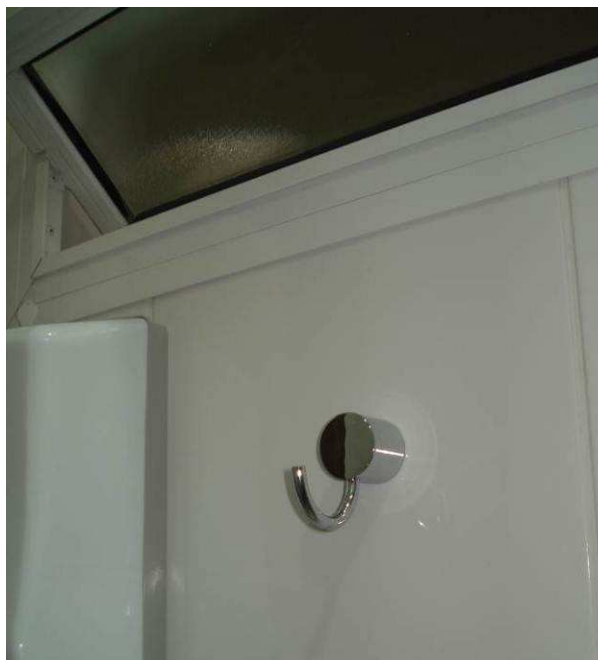
Figura 135C: Instalado toalheiro tipo gancho em metal cromado, junto ao lavatório do banheiro feminino.
