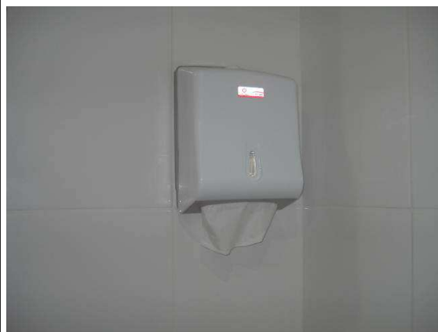
Figura 130C: Instalado 1 dispenser para papel toalha junto aos lavatórios do banheiro/vestiário masculino.
