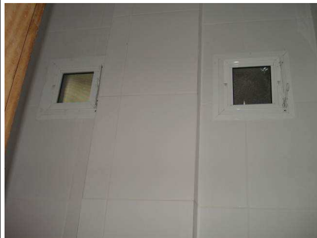
Figura 106C: Instalada a janela remanescente (esquerda) JA 0,30X0,30m, no banheiro feminino, conforme alterações relatadas na 3ª medição.
