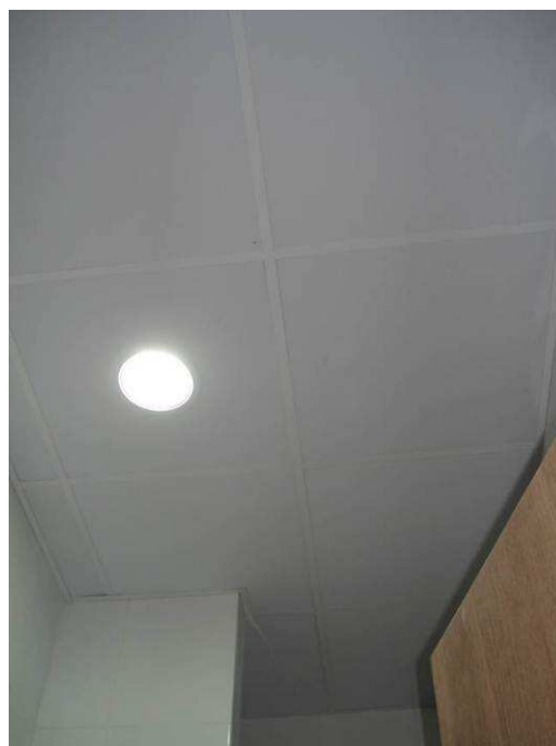
Figura 111C: Instalado forro em gesso acartonado removível (0,65x0,65m) no banheiro/vestiário feminino.
