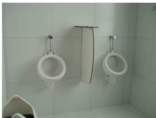
Figura 53C: Reinstalados 2 mictórios no banheiro masculino.
