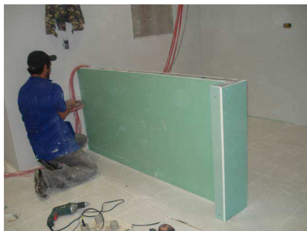
Figura 101C: Executada base do balcão da copa da sala dos motoristas, em gesso acartonado simples.
