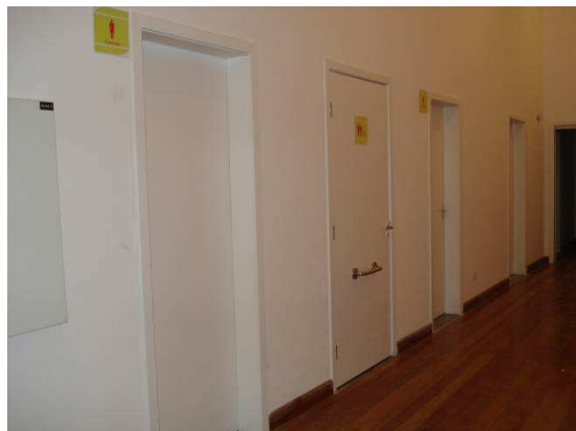
Figura 90C: Executada pintura em esmalte sintético acetinado (marca Glasurit), na cor branca, nas portas de acesso aos banheiros e ambulatório.
