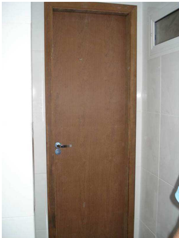
Figura 103C: Instalada 1 porta PM 70 no cubículo do vaso sanitário do banheiro feminino.
