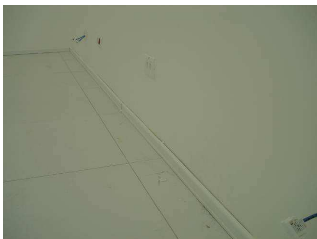
Figura 33C: Rodapé em poliuretano reciclado instalado no ambulatório.
