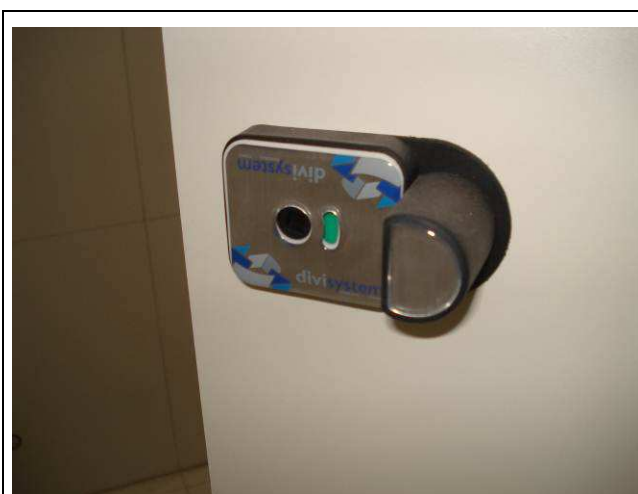
Figura 12C: Detalhe das portas com tarjeta livre/ocupado, instaladas no banheiro feminino.
