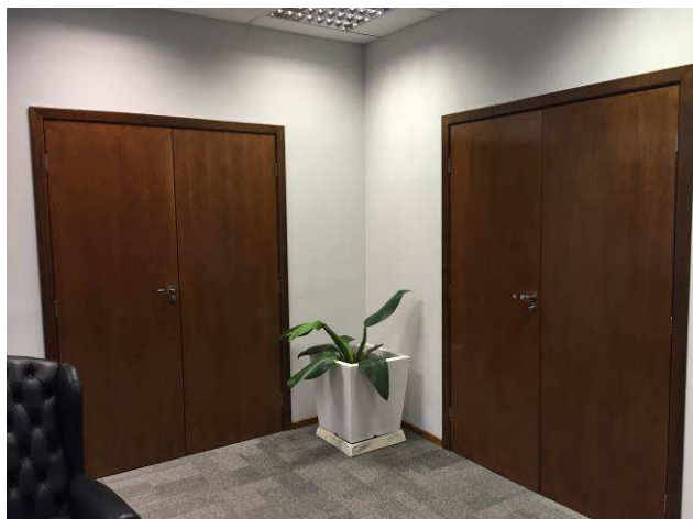
Figura 165C: Paredes adjacentes às portas instaladas no gabinete da vice-presidência foram emassadas, lixadas e pintadas, e as portas foram envernizadas.
