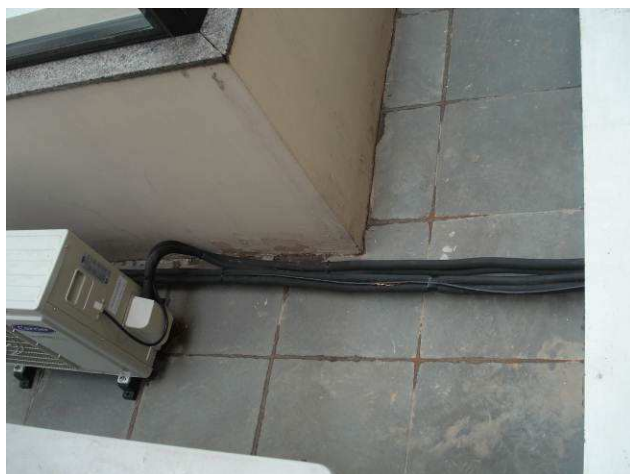
Figura 82C: Detalhe da rede executada junto às unidades condensadoras.
