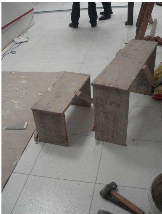
Figura 112C: Executado assentamento e rejuntamento do piso cerâmico 45x45 cm, linha Cargo Plus, cor White, nas salas dos motoristas I e II.
