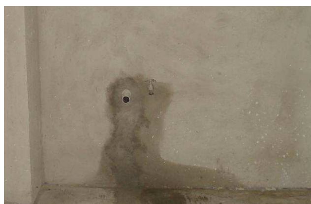
Figura 40C: Executado 1 ponto de água fria (Ø 25 mm) e esgoto secundário (Ø 50 mm) para lavatório do consultório.
