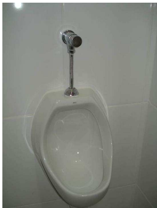
Figura 125C: Instalado 1 mictório de louça branca no banheiro/vestiário masculino.
