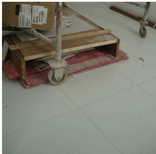
Figura 30C: Executados regularização e assentamento de porcelanato retificado Nórdico Snow, 60x60 cm, marca Incepa, na área do ambulatório.
