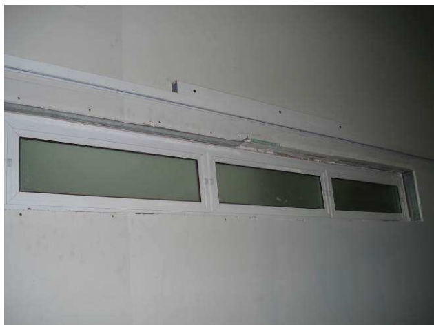
Figura 107C: Janela JA 2,40 X 0,30m, tipo máximo ar, instalada no banheiro/vestiário feminino.
