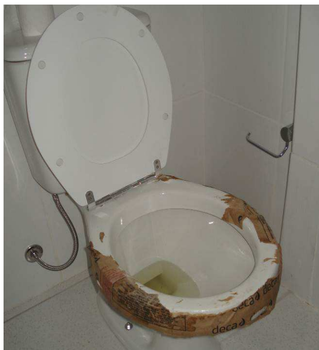
Figura 121C: Bacia sanitária com caixa acoplada, marca Deca, instalada no banheiro/sanitário feminino. Utilizados engates cromados.
