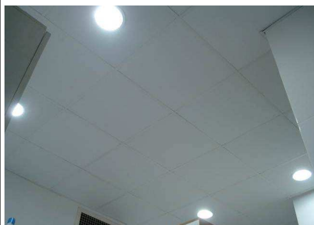
Figura 14E: luminárias 2x23W embutir - vestiários.
