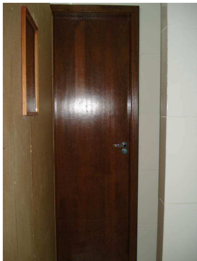
Figura 146C: Porta do cubículo do vaso sanitário masculino pintada com verniz marítimo Suvinil.
