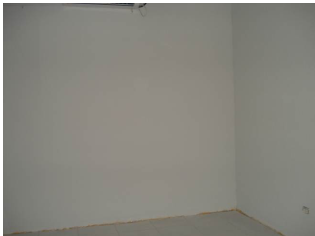
Figura 140C: Executada pintura da sala dos motoristas I com tinta látex acrílica, cor branco gelo, marca Luz & Cor.
