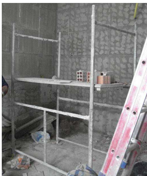
Figura 01C: Utilização de andaime metálico.
