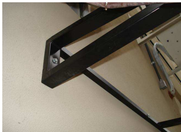
Figura 161C: Detalhe da estrutura em perfis de aço galvanizado 30x50mm, pintados com esmalte sintético na cor preta.
