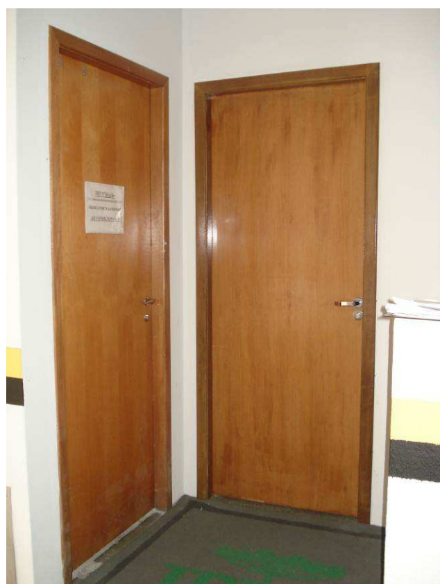
Figura 144C: Executada pintura da porta de acesso às sala dos motoristas II (à direita), com verniz marítimo Suvinil.
