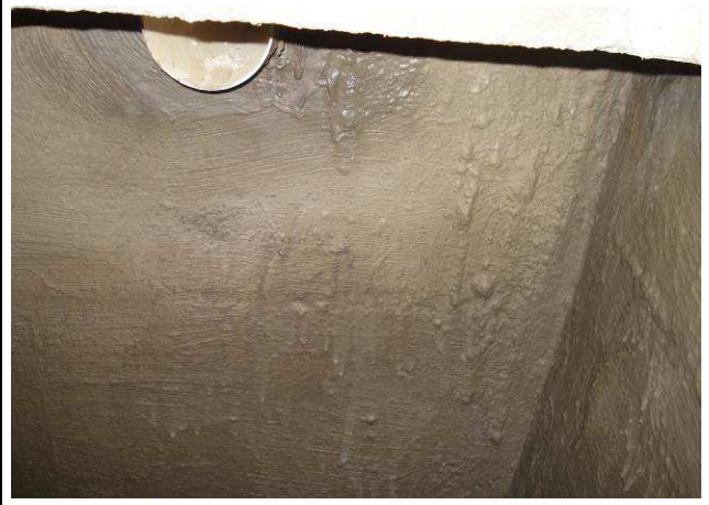
Figura 176C: Detalhe da impermeabilização.
