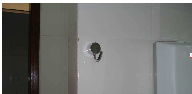
Figura 134C: Instalados 2 toalheiros tipo gancho em metal cromado, junto aos lavatórios do banheiro masculino.
