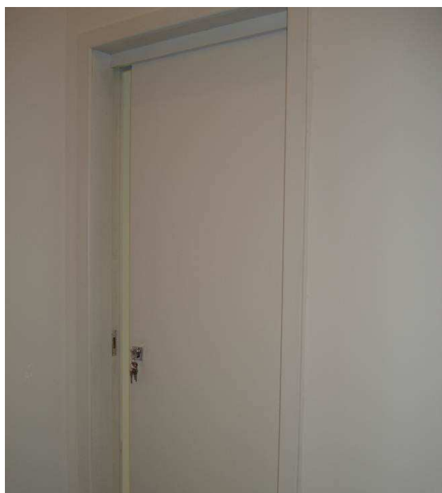
Figura 17C: Porta PM 90, de correr, instalada no acesso à sala de espera.
