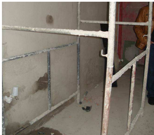
Figura 05C: Revestimento de piso removido do banheiro masculino existente.
