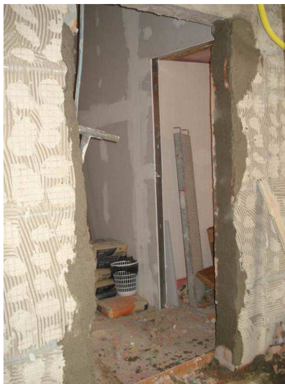
Figura 06C: Demolição em parede de alvenaria para instalação de porta de acesso ao consultório.
