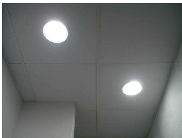
Figura 15E: luminárias 2x23W embutir - vestiários.
