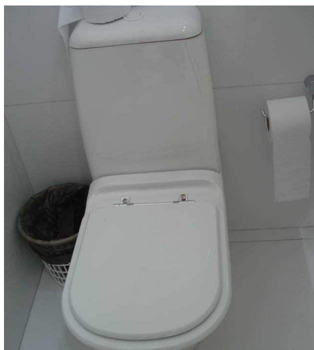
Figura 48C: Bacias sanitária (total de 5) com novo assento, instalada no banheiro feminino.
