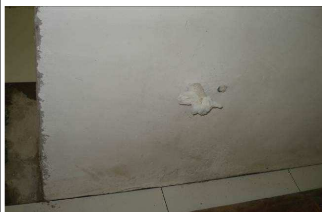
Figura 41C: Executado 1 ponto de água fria (Ø 25 mm) e esgoto secundário (Ø 50 mm) para lavatório do ambulatório.
