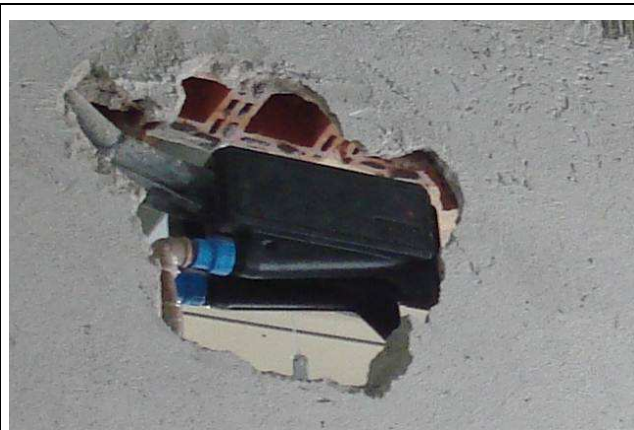
Figura 39C: Executado drenos para aparelhos de ar condicionado do consultório e ambulatório (1º e 2º plano, respectivamente).
