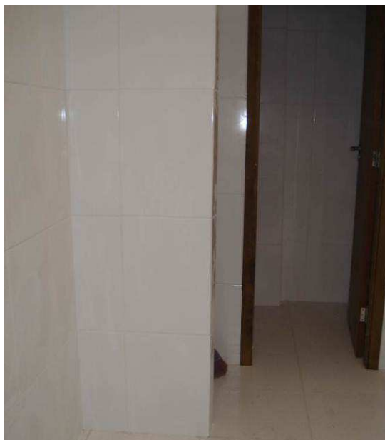
Figura 109C: Concluído assentamento e rejuntamento de azulejos Eliane, 33x45 cm, da linha Forma, na cor branca, no banheiro/vestiário feminino.
