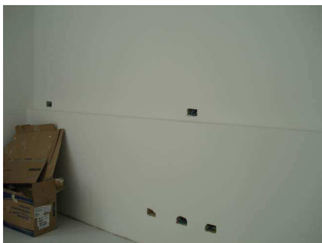
Figura 88C: Executados emassamento, lixamento e pintura em tinta látex acrílica (marca Luz & Cor), na cor branco gelo, nas paredes do consultório.
