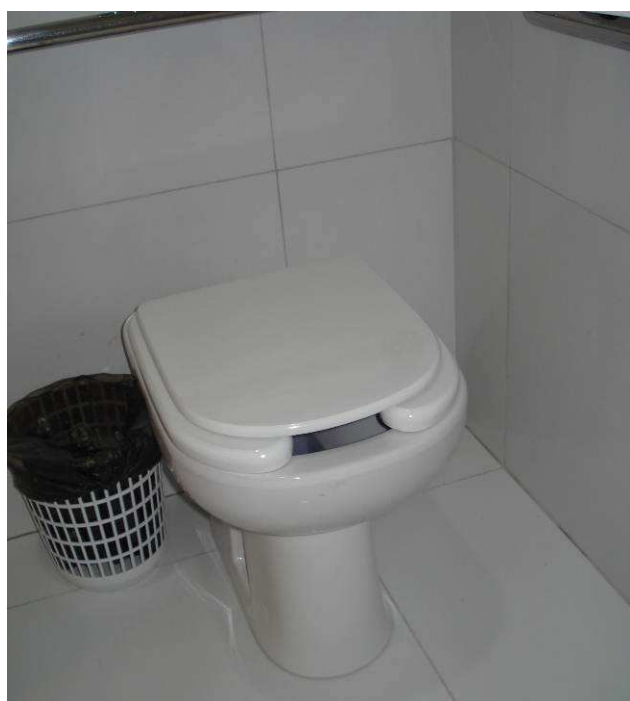
Figura 47C: Instalada 1 bacia sanitária no banheiro PNE (marca Deca) com respectivo assento especial para PNE.
