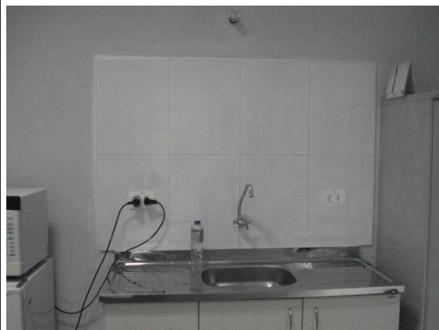
Figura 110C: Executado assentamento e rejuntamento de azulejos Eliane, 33x45 cm, da linha Forma, na cor branca, na parede da pia da copa da sala dos motoristas.
