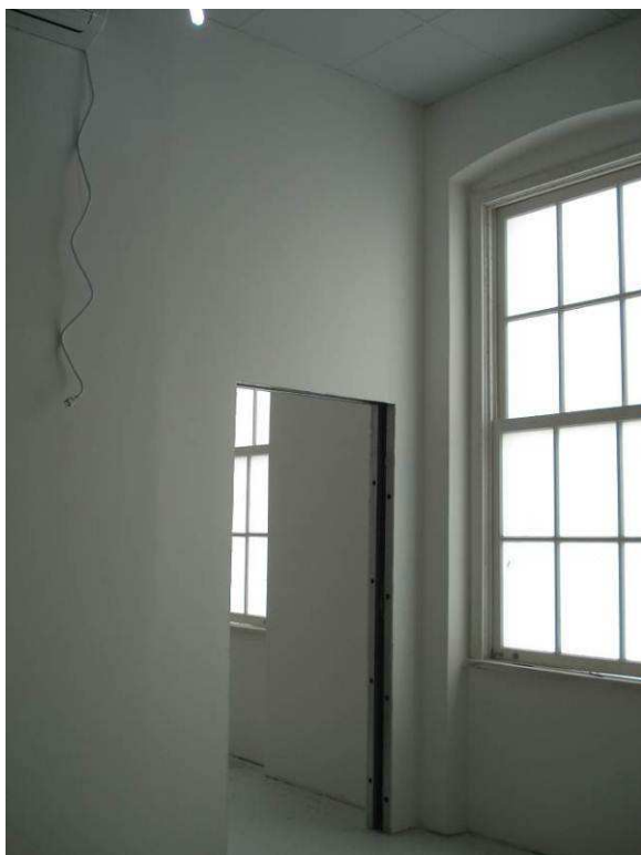
Figura 08C: Parede em gesso acartonado simples instalada na divisa do consultório para o ambulatório.
