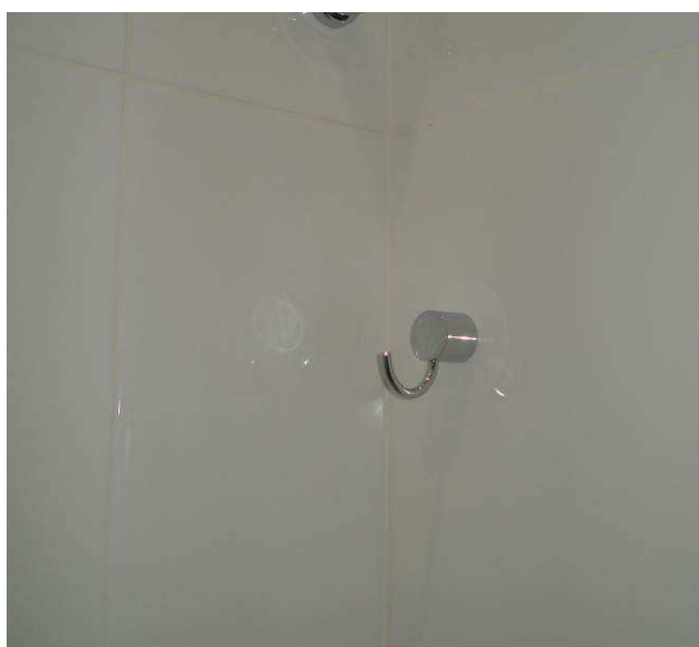
Figura 133C: Instalado 1 toalheiro tipo gancho em metal cromado, junto à bacia sanitária do banheiro feminino.
