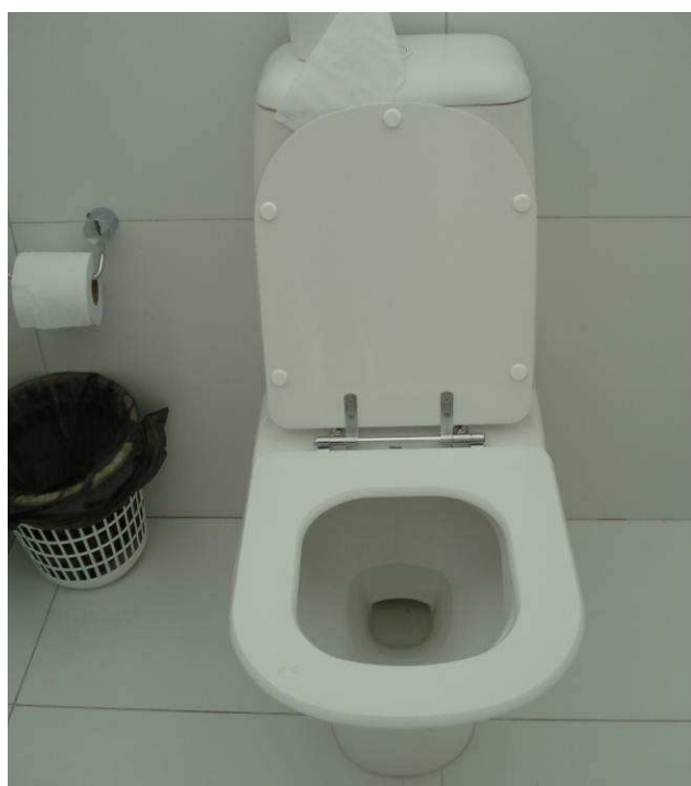
Figura 49C: Reinstalada 1 bacia sanitária com novo assento no banheiro masculino.
