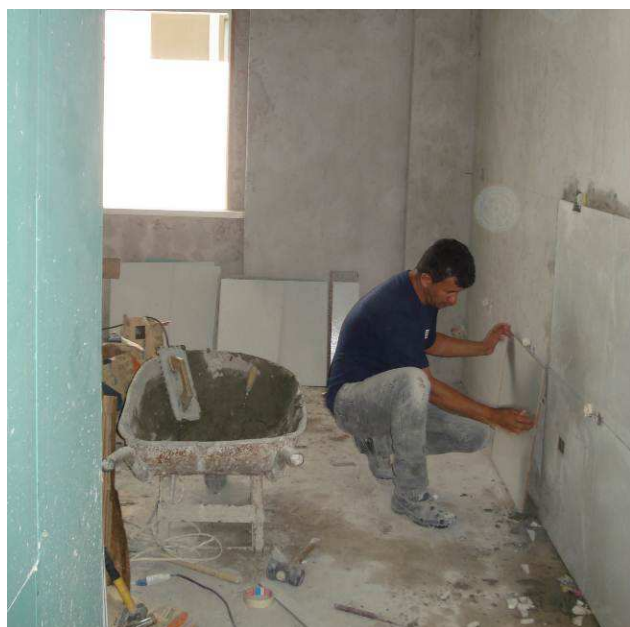
Figura 21C: Regularização de paredes para assentamento de porcelanato no banheiro masculino.
