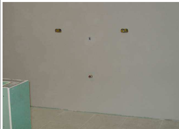
Figura 118C: Executados ponto de água fria Ø 25 mm e esgoto secundário Ø 50 mm para pia da copa da sala dos motoristas.
