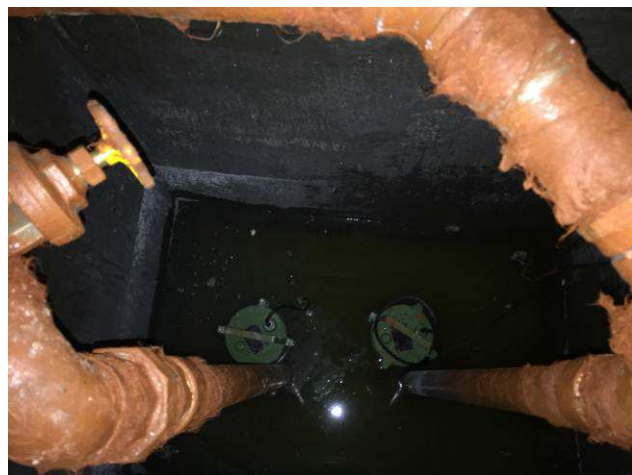
Figura 173C: Executada tubulação em aço gavanizado, registros de gaveta e válvulas de retenção verticais.
