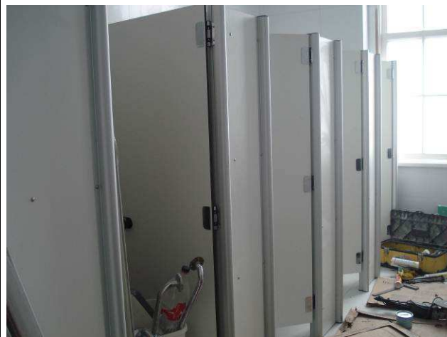
Figura 09C: Divisórias sanitárias Sanisystem Master (e=10mm), instaladas no banheiro feminino.
