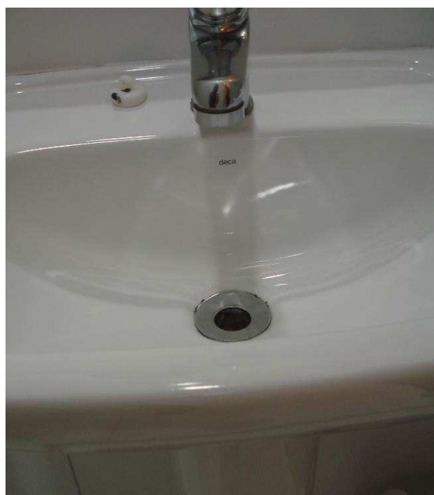
Figura 50C: Instalado 1 lavatório (marca Deca) com coluna suspensa no banheiro PNE.
