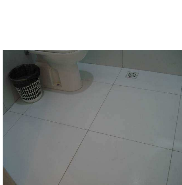
Figura 28C: Executados regularização e assentamento de porcelanato retificado Nórdico Snow, 60x60 cm, marca Incepa, no banheiro PNE.
