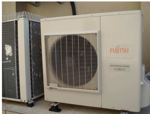
Figura 151C: Foi finalizada a rede frigorígena externa (conexão à unidade condensadora) para instalação de condicionador de ar das salas dos motoristas II.
