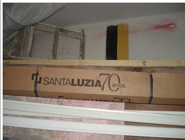
Figura 34C: Utilizado rodapé com altura de 5cm, marca Santa Luzia, na cor branca.
