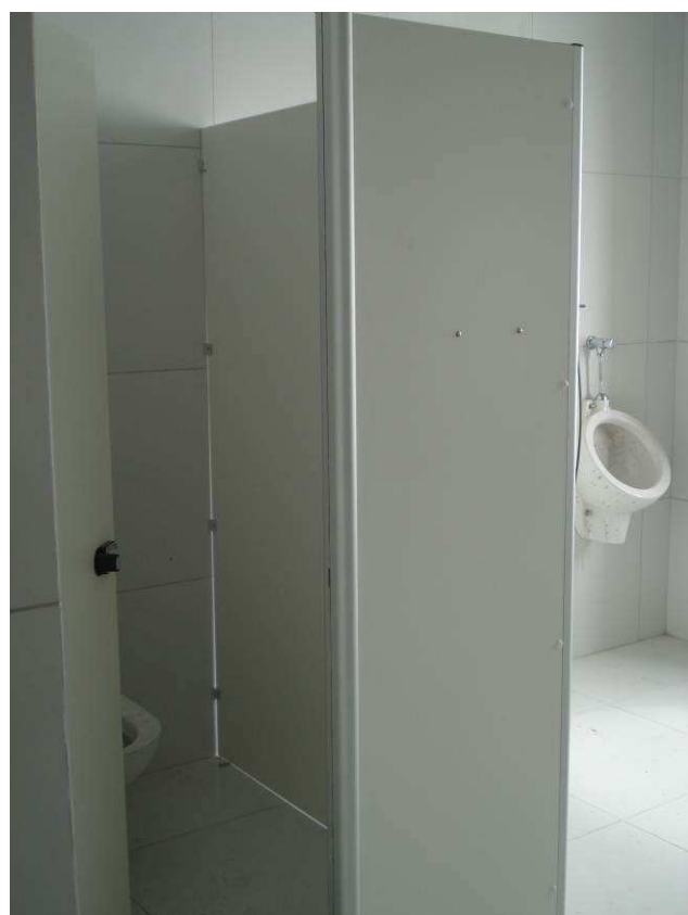
Figura 10C: Divisórias sanitárias Sanisystem Master (e=10mm), instaladas no banheiro masculino.
