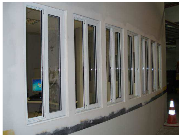
Figura 139C: Parede externa da área de banheiros/vestiários emassada e lixada.
