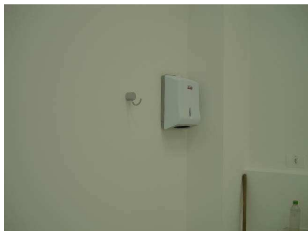
Figura 65C: Instalado 1 dispenser para papel toalha junto ao lavatório do consultório.
