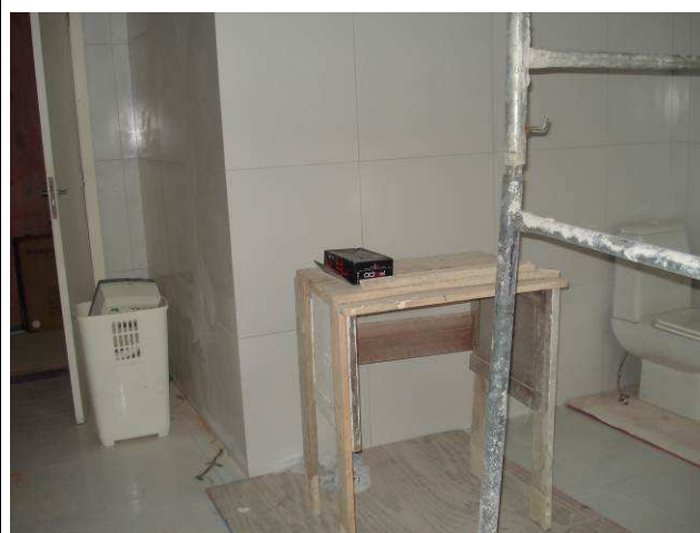
Figura 26C: Assentamento e rejuntamento das paredes concluídos no banheiro masculino.
