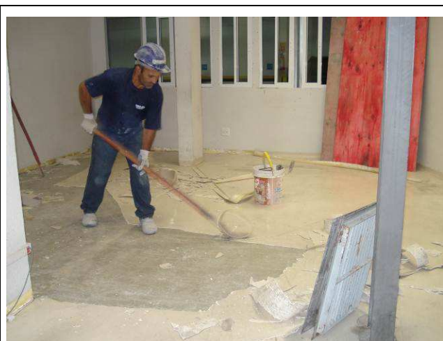
Figura 98C: Foi removido o piso vinílico da sala dos motoristas, a ser substituído por piso cerâmico.
