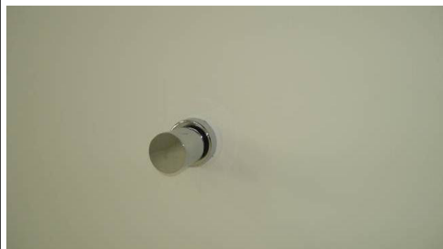
Figura 43C: Instalados registros de gaveta 3/4" com respectivos acabamentos e canoplas cromadas, no consultório.
