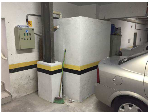
Figura 179C: Executado chapisco, emboço e pintura do reservatório de esgoto.
