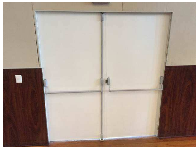
Figura 164C: Executada pintura em esmalte sintético, cor branco acetinado, marca Suvinil, na porta corta-fogo instalada no Plenário.
