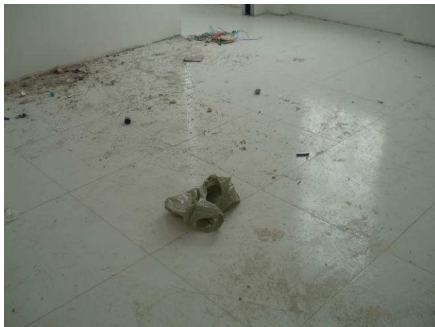
Figura 29C: Executados regularização e assentamento de porcelanato retificado Nórdico Snow, 60x60 cm, marca Incepa, na área do consultório.
