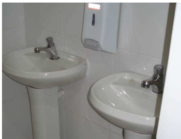
Figura 136C: Foram reinstaladas 2 torneiras para os lavatórios do banheiro/vestiário masculino.
