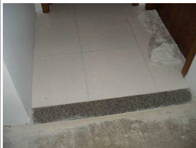
Figura 115C: Soleira em granito polido cinza andorinha instaladas no acesso à área de banheiros/vestiários.
