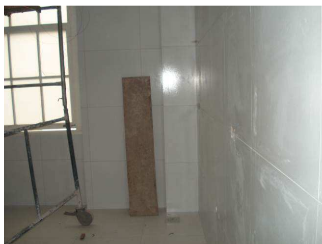
Figura 25C: Executado assentamento e rejuntamento de porcelanato retificado Nórdico Snow, 60x60 cm, marca Incepa, nas paredes do banheiro masculino.
