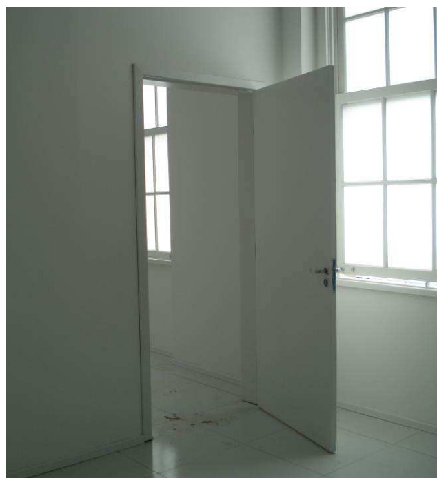
Figura 92C: Executada pintura em esmalte sintético acetinado (marca Glasurit), na cor branca neve, na porta de passagem do consultório para ambulatório.
