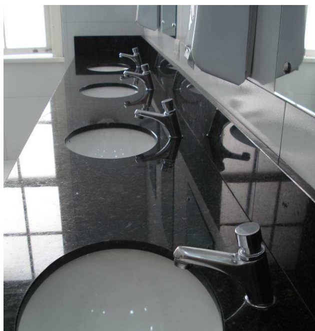
Figura 73C: Torneiras reinstaladas na bancada do banheiro feminino.
