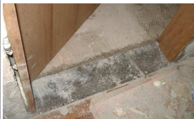
Figura 38C: Soleira em granito polido cinza andorinha, instalado na passagem da sala de espera para o consultório.
