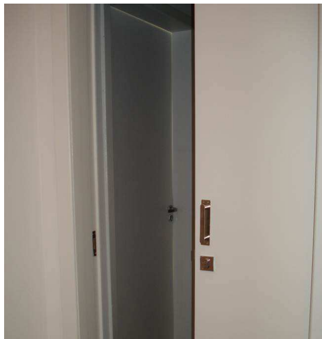
Figura 91C: Executada pintura em esmalte sintético acetinado (marca Glasurit), na cor branca, nas portas da sala de espera.
