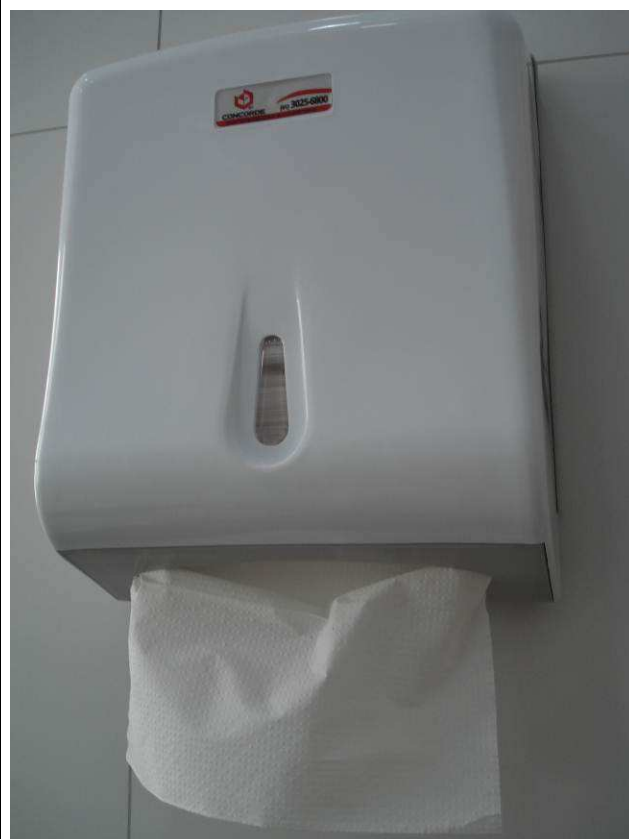
Figura 62C: Instalados 2 dispensers para papel toalha junto à bancada do banheiro feminino.
