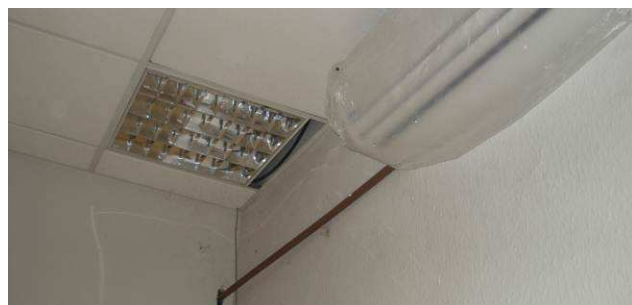
Figura 117C: Executados pontos de dreno de ar condicionado das salas dos motoristas I e II.
