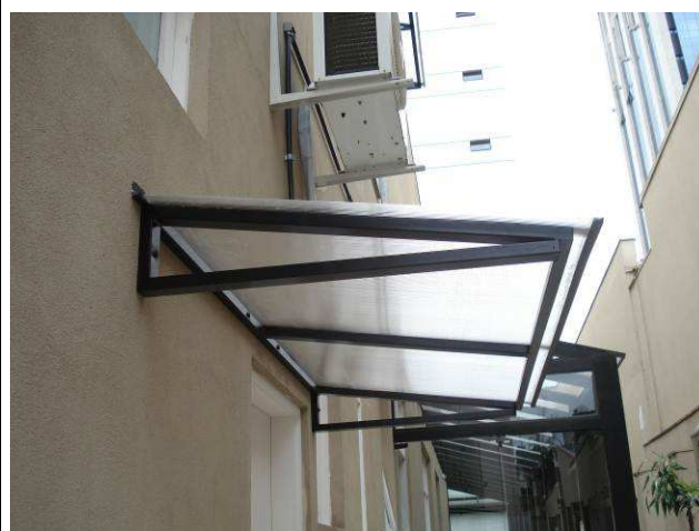
Figura 160C: Instalada cobertura em policarbonato alveolar (e=6mm), junto à porta da enfermagem.
