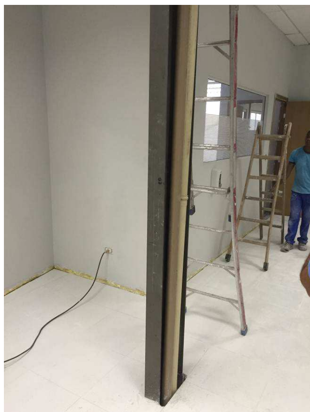
Figura 167C: Tubulação de condução dos dejetos (Ø 60 mm), e tubulação de ventilação (Ø 75 mm) da estação elevatória de esgoto.
