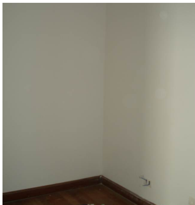
Figura 87C: Executados emassamento, lixamento e pintura em tinta látex acrílica (marca Luz & Cor), na cor branco gelo, nas paredes da sala de espera.
