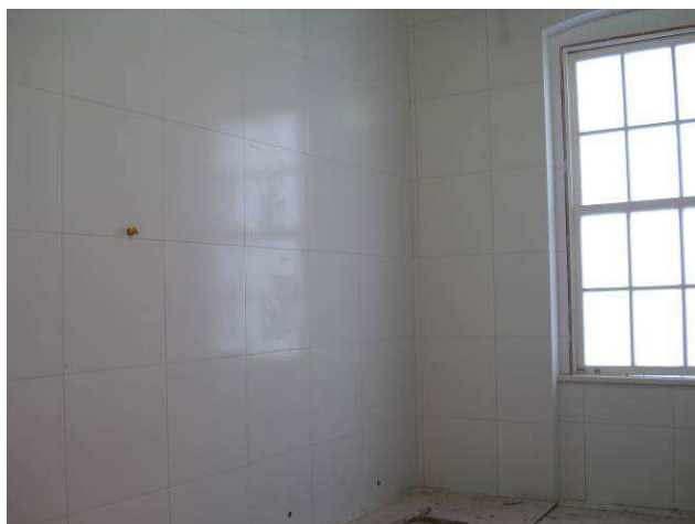
Figura 23C: Concluído assentamento e rejuntamento de porcelanato retificado Nórdico Snow, 60x60 cm, marca Incepa, nas paredes do banheiro feminino.
