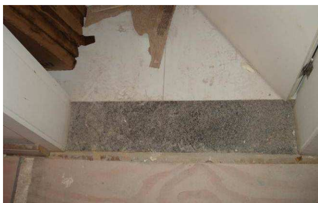
Figura 35C: Soleira em granito polido cinza andorinha, instalado junto à porta de acesso ao banheiro feminino.
