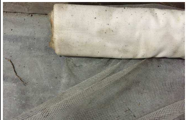
Figura 178C: Tela de poliéster aplicada entre as camadas de argamassa polimérica.
