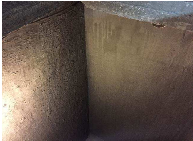
Figura 175C: Impermeabilização do reservatório de esgoto com argamassa polimérica.
