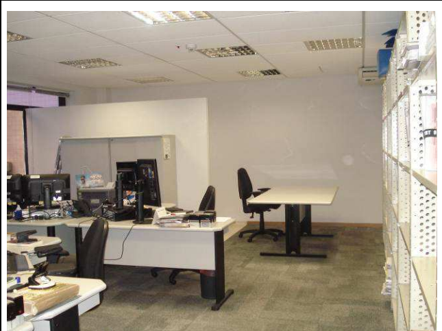
Figura 97C: Pintura executada na Secretaria do Pleno.
