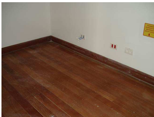
Figura 31C: Rodapé reinstalado na sala de espera.
