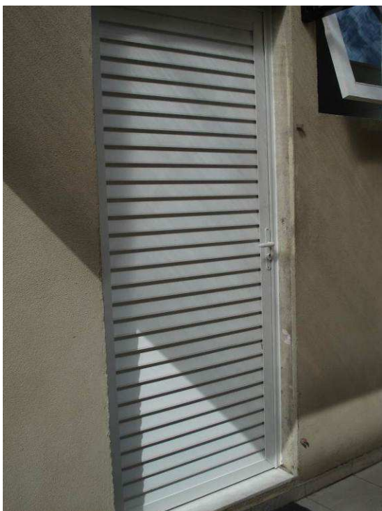
Figura 159C: Instalada porta de abrir, com acabamento tipo veneziana, no acesso à sala de enfermagem.
