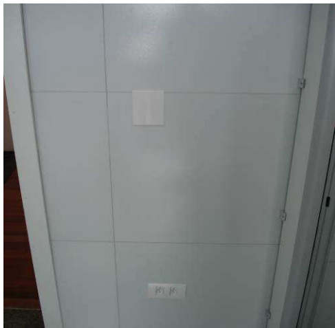
Figura 31E: tomadas elétricas e interruptores.
