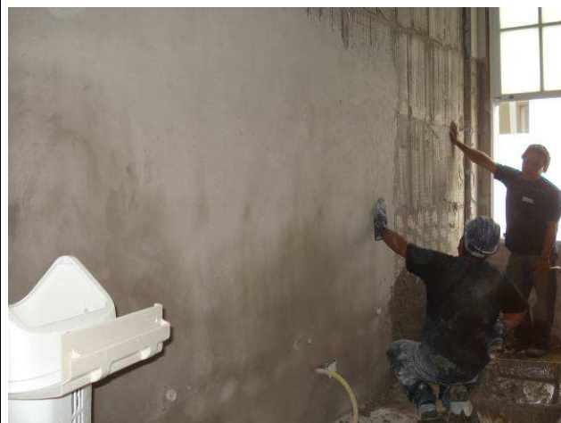
Figura 22C: Regularização de paredes para posterior execução de pintura, em área do ambulatório.
