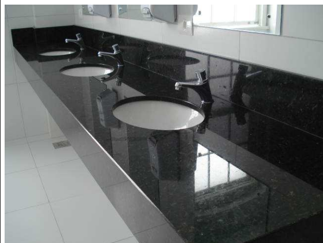
Figura 52C: Tampo em granito adaptado e reinstalado com respectivas cubas no banheiro masculino.
