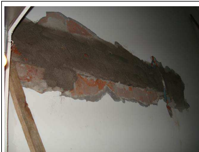
Figura 07C: Verga executada sobre o vão da porta de acesso ao consultório (na foto, abertura de vão ainda não executada).
