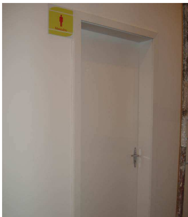
Figura 19C: Porta reinstalada no banheiro masculino.
