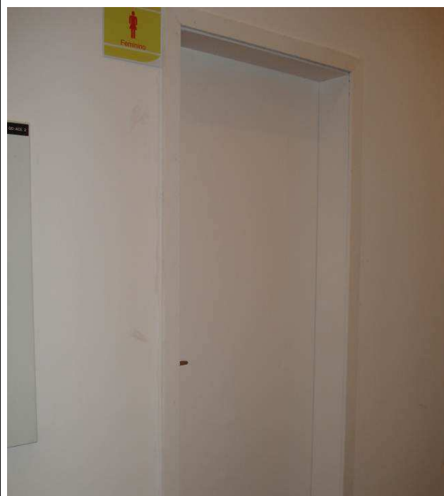
Figura 18C: Porta reinstalada no banheiro feminino.
