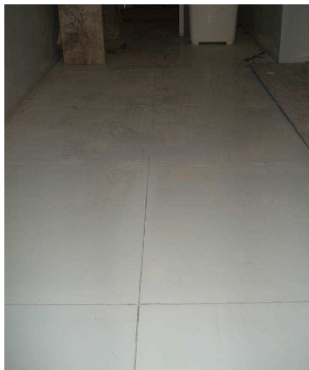
Figura 27C: Executados regularização e assentamento de porcelanato retificado Nórdico Snow, 60x60 cm, marca Incepa, no banheiro masculino.
