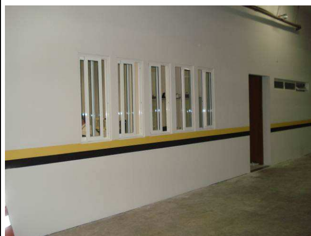
Figura 143C: Executada pintura externa de parede da área de banheiros/vestiários com tinta látex acrílica, cor branco gelo, marca Luz & Cor, com faixa zebraada.
