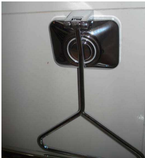
Figura 79C: Instalado acabamento cromado (tipo barra) para válvula de descarga do vaso sanitário do banheiro PNE.
