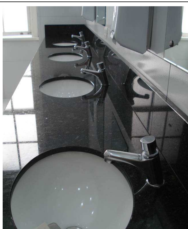
Figura 51C: Tampo em granito adaptado e reinstalado com respectivas cubas no banheiro feminino.
