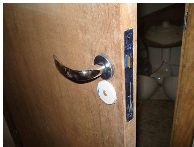
Figura 104C: Foi utilizada fechadura 40mm da linha ZM COPA, marca Pado, além de maçaneta tipo alavanca com roseta em acabamento cromado.
