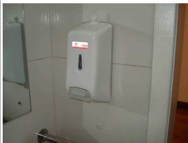
Figura 60C: Instalada 1 saboneteira de plástico junto ao lavatório do banheiro PNE.
