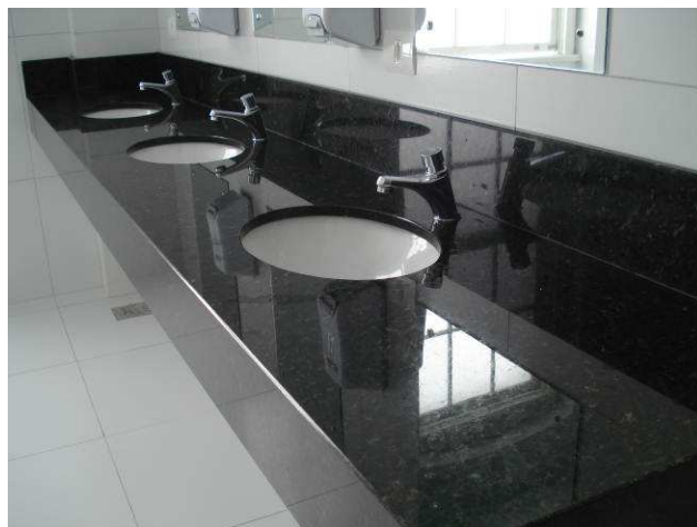
Figura 74C: Torneiras reinstaladas na bancada do banheiro masculino.
