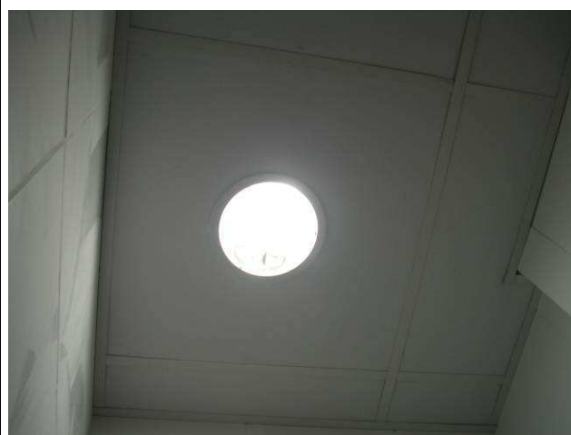
Figura 16E: luminárias 2x23W embutir - vestiários.
