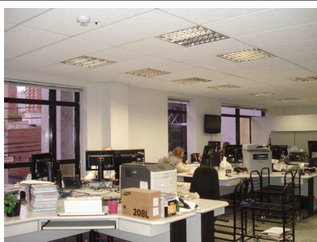
Figura 96C: Executada pintura em tinta látex acrílica (marca Luz & Cor), cor branco gelo, nas paredes da Secretaria do Pleno.
