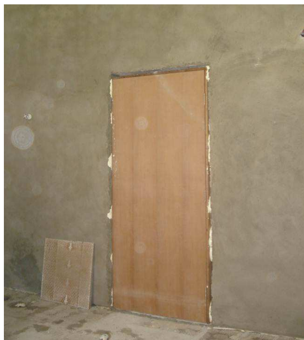
Figura 14C: Porta PM 090 instalada na passagem do consultório para o ambulatório.
