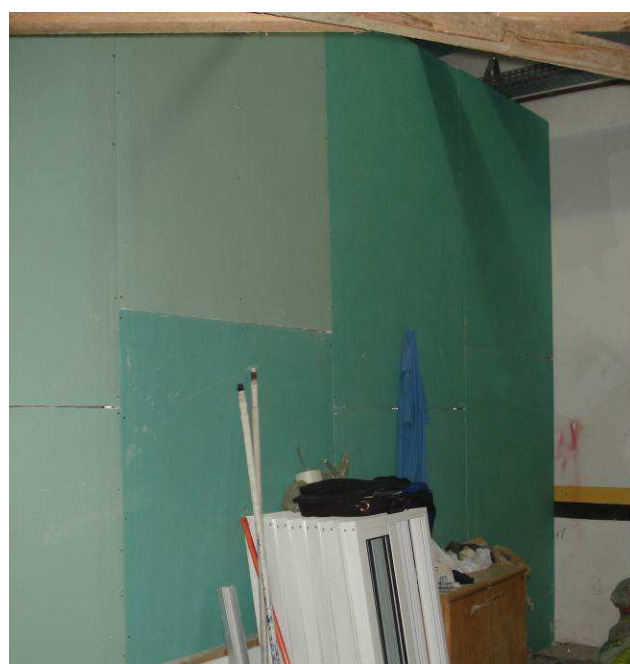
Figura 99C: Houve conclusão da execução da parede em gesso acartonado verde (opção da contratada) do depósito de lixo.
