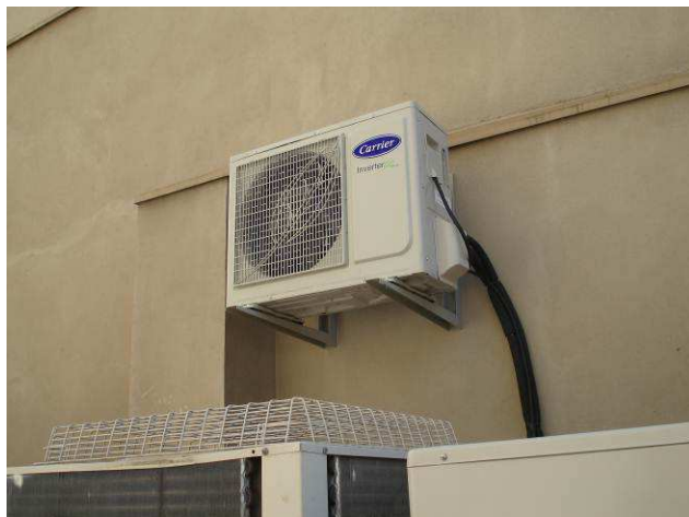
Figura 150C: Foi finalizada a rede frigorígena externa (conexão à unidade condensadora) para instalação de condicionador de ar das salas dos motoristas I.
