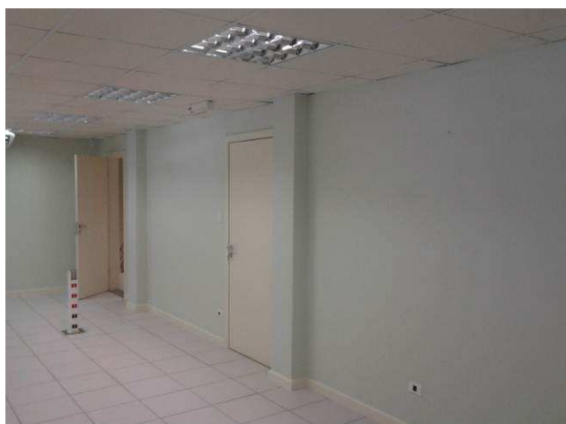
Figura 21C: Pintura de paredes da sala de audiência
