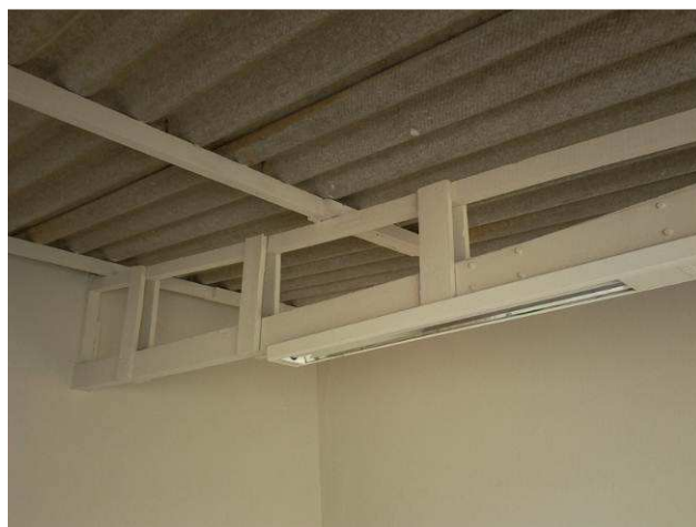
Figura 16C: Pintura da estrutura de cobertura da garagem
