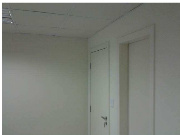
Figura 23C: Pintura de paredes do pavimento superior
