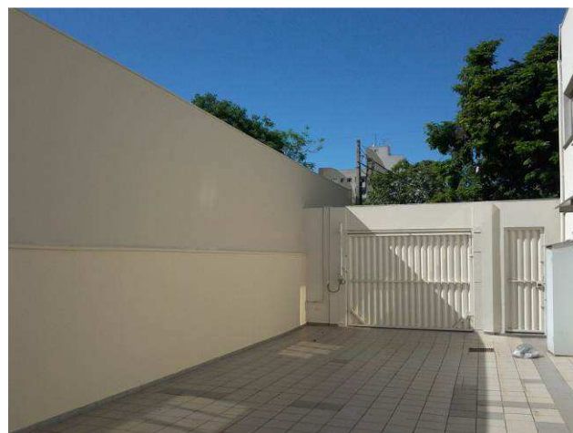
Figura 10C: Pintura do muro da garagem
