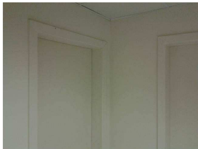
Figura 20C: Pintura das paredes do pavimento superior
