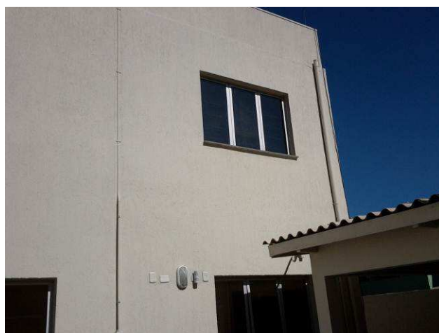
Figura 06C: Pintura da parede lateral direita do imóvel principal
