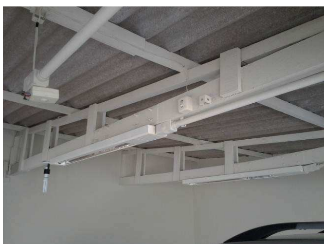
Figura 17C: Pintura da estrutura de cobertura da garagem
