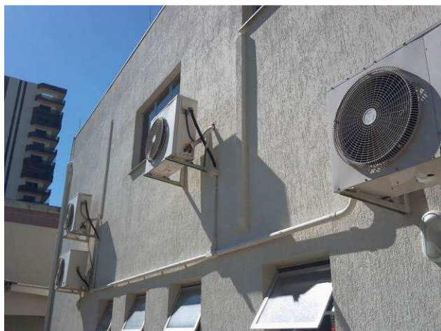
Figura 07C: Detalhe da pintura da parede dos fundos do imóvel principal
