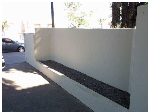
Figura 14C: Detalhe da pintura do muro frontal
