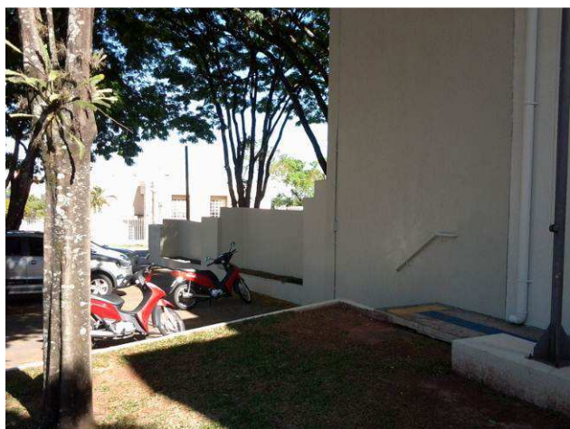
Figura 09C: Pintura dos muros frontais
