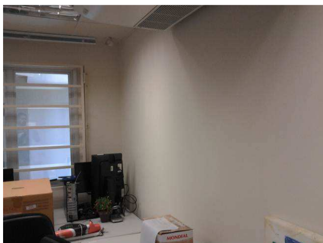
Figura 27C: Pintura das paredes do pavimento térreo - secretaria
