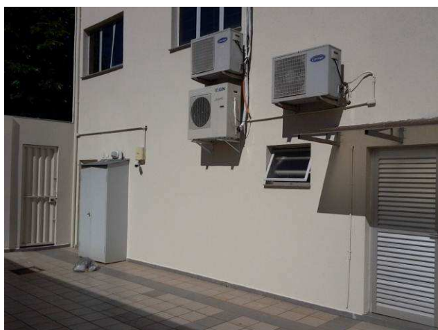
Figura 05C: Pintura da parede lateral direita do imóvel principal
