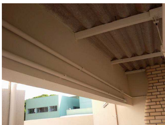
Figura 18C: Pintura da estrutura de cobertura da garagem
