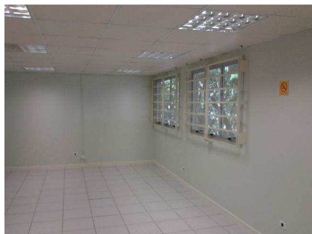
Figura 22C: Pintura de paredes da sala de audiência
