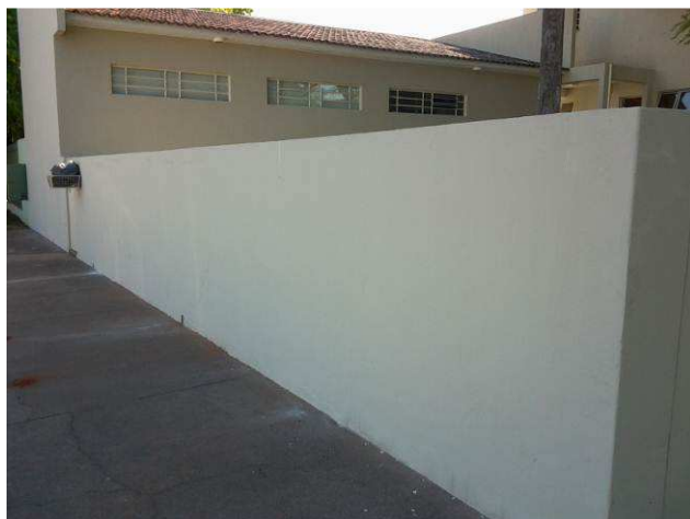
Figura 13C: Pintura do muro dos fundos do arquivo
