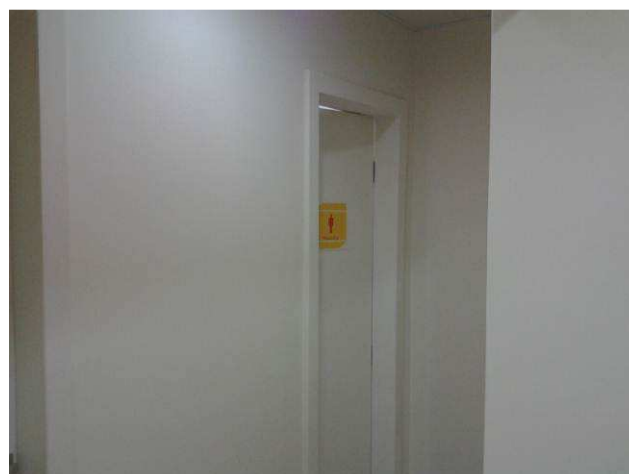
Figura 28C: Pintura das paredes do pavimento térreo - corredor de acesso aos sanitários
