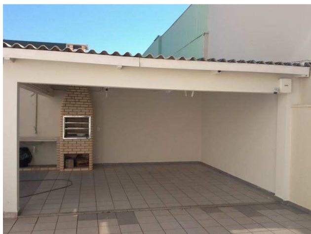
Figura 15C: Pintura da cobertura da garagem
