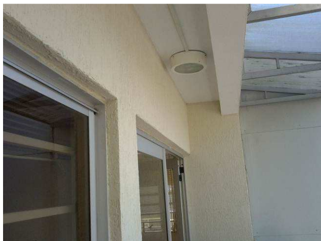
Figura 19C: Pintura da pequena laje da sacada no pavimento superior
