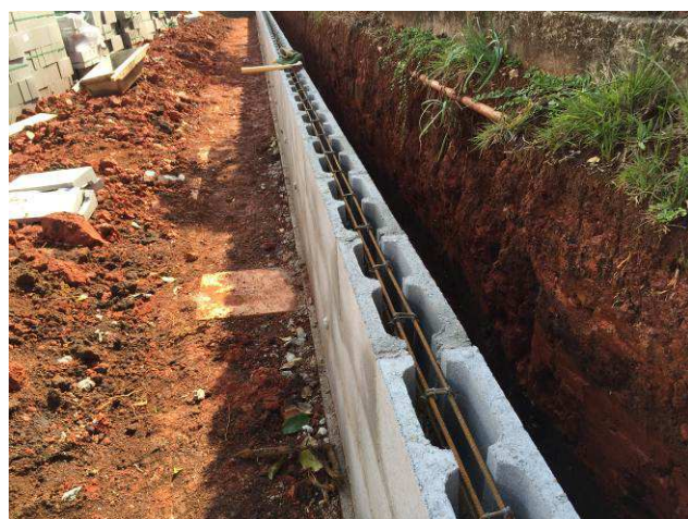
Figura 75C: Assentamento dos blocos de concreto.
