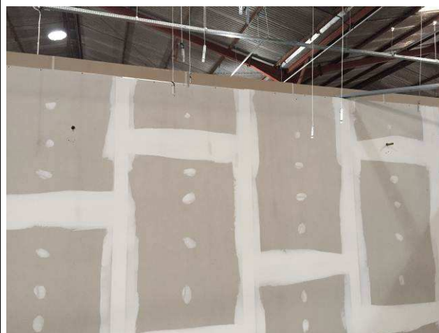
Figura 22C: Montagem das paredes de gesso acartonado - aplicação de fita e massa nas juntas.
