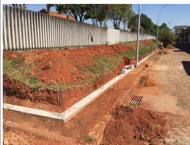
Figura 68C: Viga baldrame concretada.
