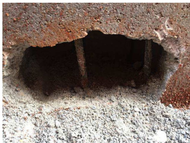
Figura 77C: Limpeza do "pé" dos pilaretes antes da concretagem.
