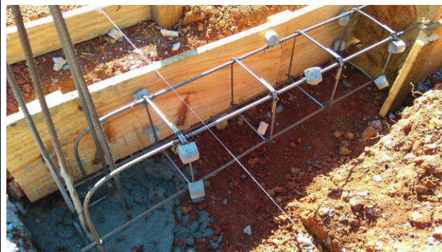
Figura 60C: Brocas concretadas, forma e armação da viga baldrame.
