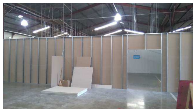
Figura 16C: Montagem das paredes de gesso acartonado.
