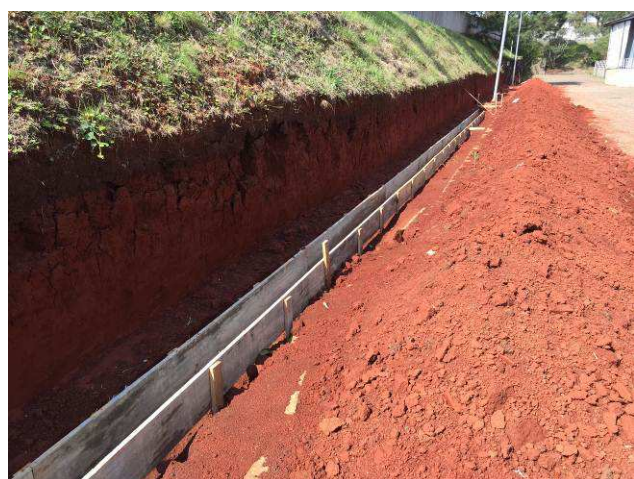
Figura 61C: Montagem das formas da viga baldrame.
