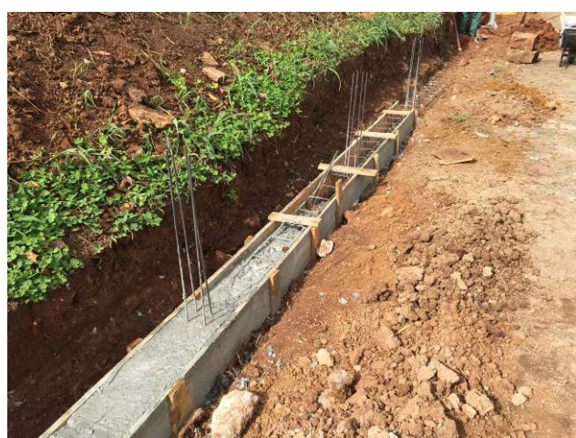
Figura 67C: Concretagem da viga baldrame.
