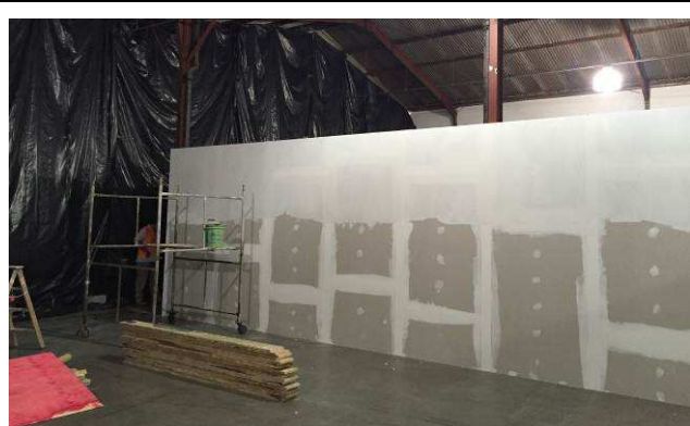
Figura 39C: Emassamento das paredes.
