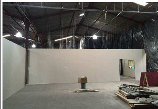
Figura 52C: Paredes pintadas - vista externa da ampliação do arquivo, salas refrigerada e reserva.
