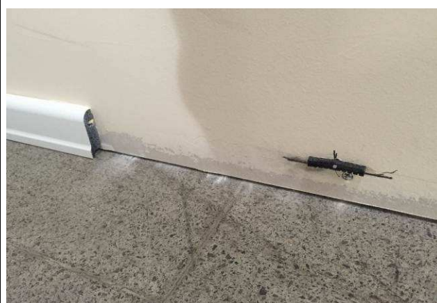
Figura 32C: Sistema de fixação dos rodapés.
