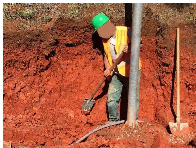
Figura 56C: Raspagem e escavação do terreno.
