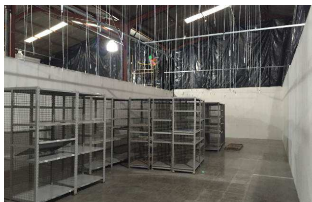
Figura 41C: Emassamento das paredes.
