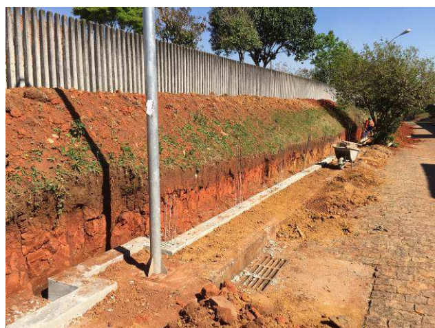
Figura 69C: Viga baldrame concretada.
