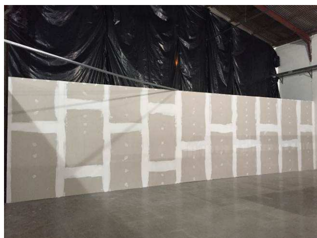
Figura 23C: Montagem das paredes de gesso acartonado - aplicação de fita e massa nas juntas.
