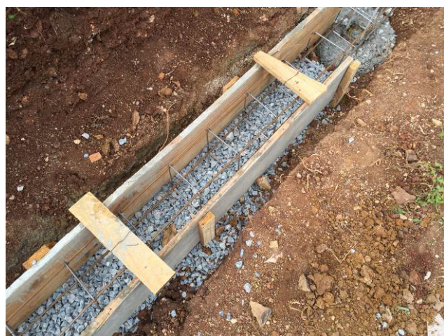
Figura 63C: Montagem das armaduras da viga baldrame.
