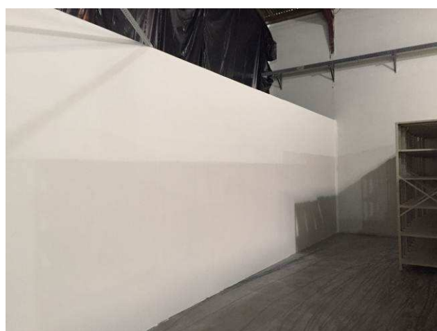
Figura 47C: Paredes pintadas - ampliação arquivo.
