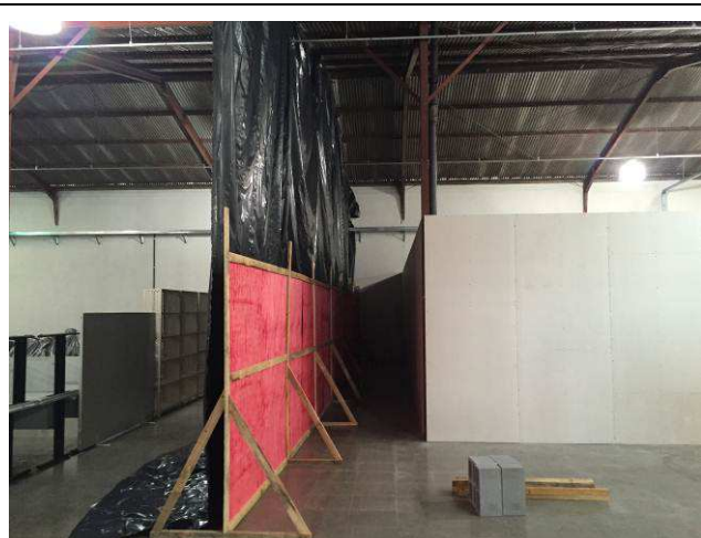
Figura 03C: Montagem do tapume e lonas.
