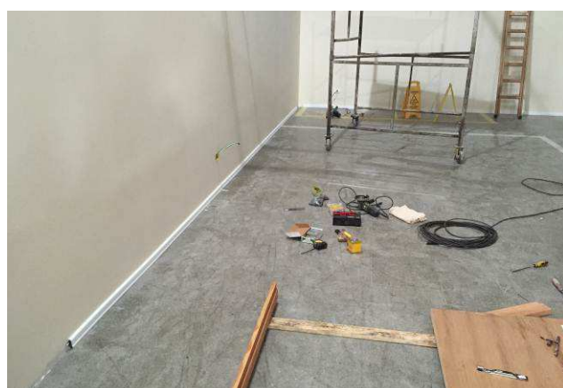
Figura 31C: Rodapés instalados - Sala Reserva.
