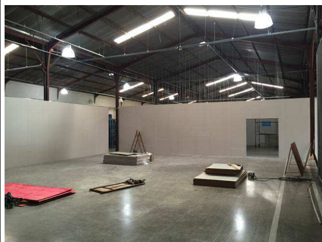
Figura 18C: Montagem das paredes de gesso acartonado.
