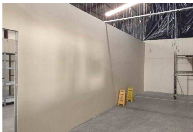
Figura 51C: Paredes pintadas - sala reserva.
