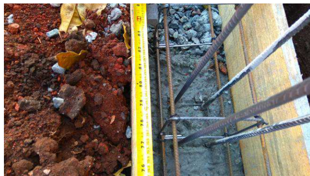
Figura 59C: Brocas concretadas.
