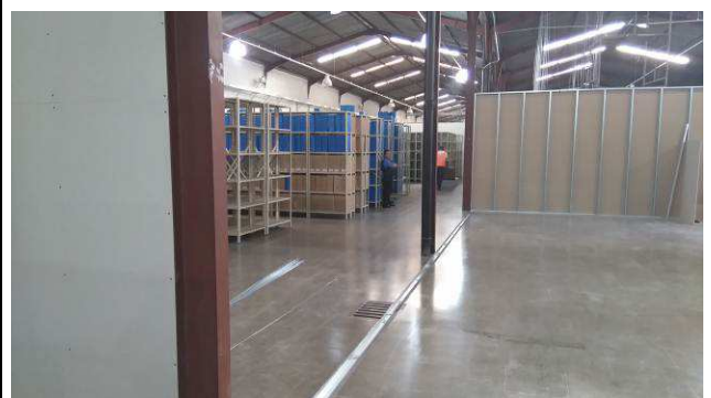
Figura 14C: Início da montagem das paredes.
