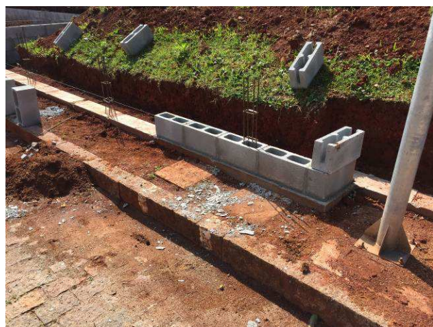
Figura 71C: Assentamento dos blocos de concreto.
