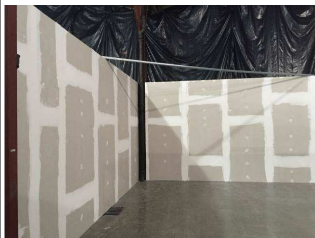
Figura 24C: Montagem das paredes de gesso acartonado - aplicação de fita e massa nas juntas.
