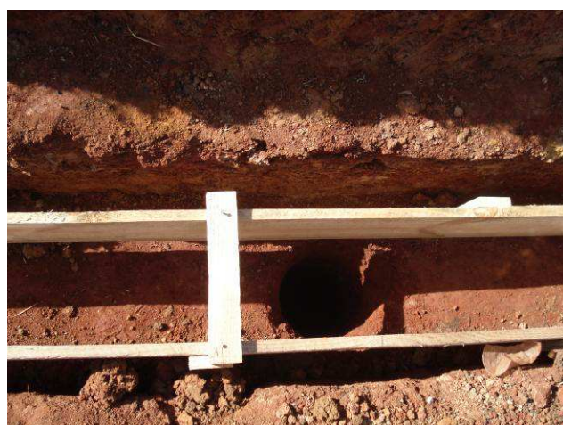
Figura 57C: Escavação de brocas.
