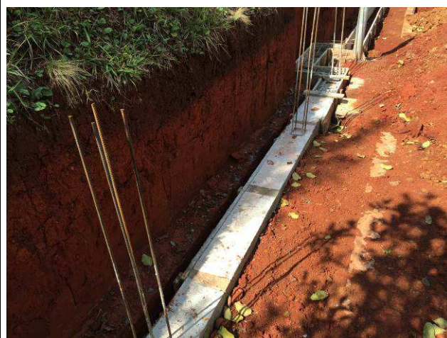
Figura 70C: Viga baldrame concretada.
