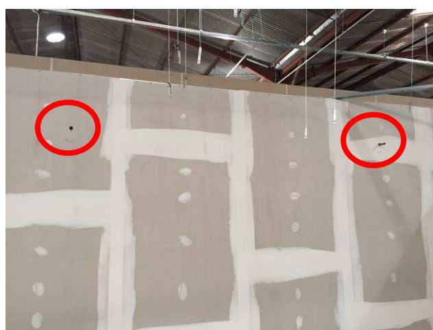
Figura 33C: Drenos em tubos de PVC - sala refrigerada do almoxarifado.
