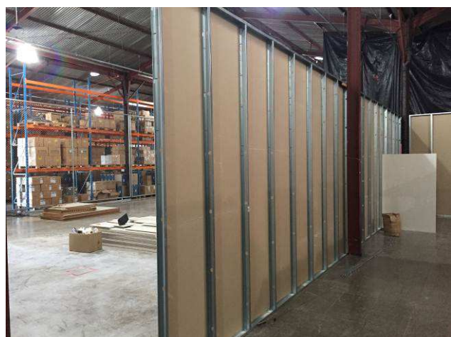
Figura 17C: Montagem das paredes de gesso acartonado.
