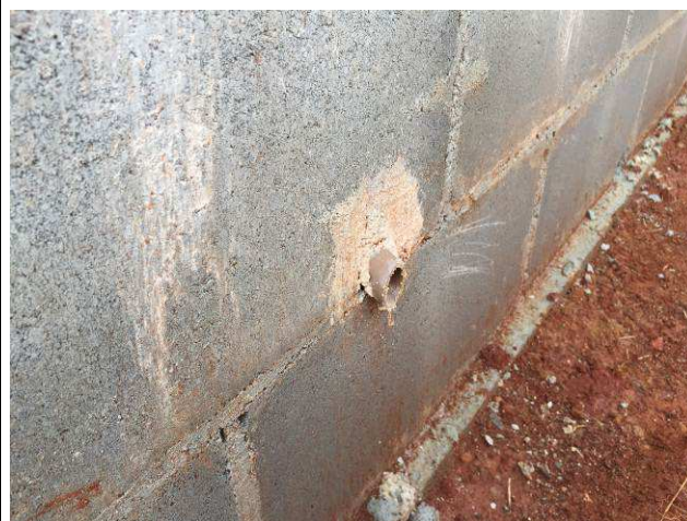
Figura 78C: Tubos de drenagem instalados durante o assentamento dos blocos de concreto.
