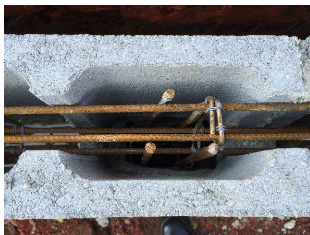
Figura 76C: Bloco canaleta superior com armação.
