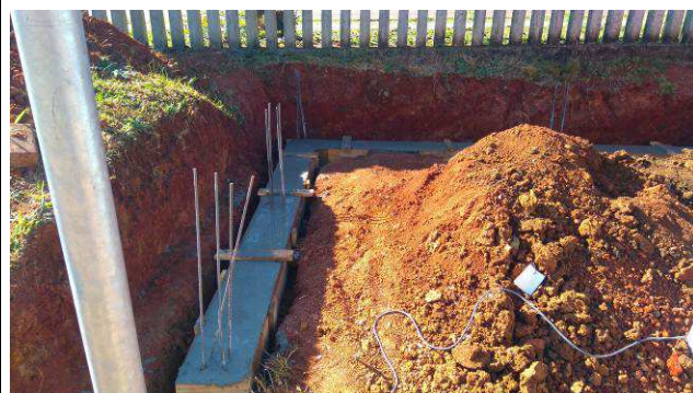
Figura 66C: Concretagem da viga baldrame.
