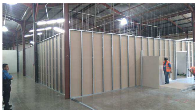
Figura 15C: Montagem das paredes de gesso acartonado.
