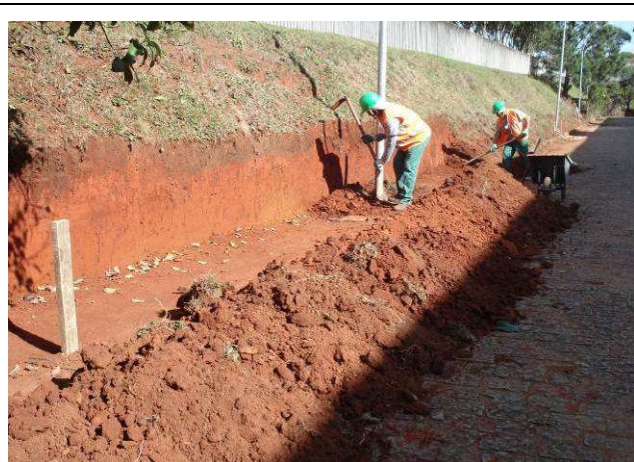
Figura 53C: Raspagem e escavação do terreno.
