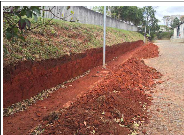
Figura 54C: Raspagem e escavação do terreno.
