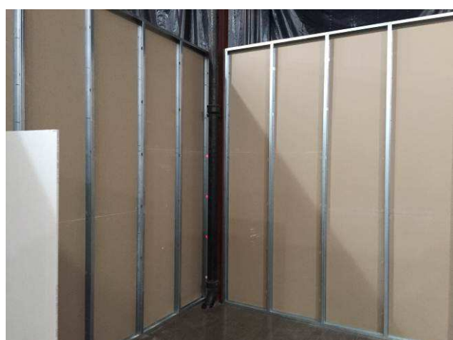
Figura 19C: Montagem das paredes de gesso acartonado.
