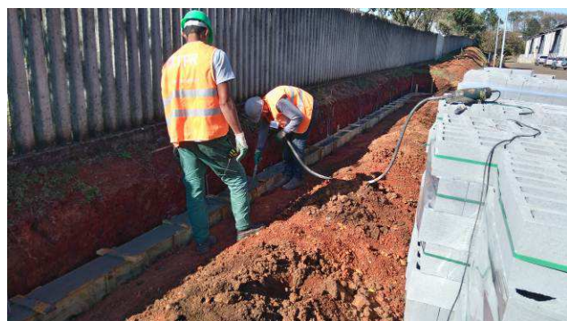
Figura 65C: Concretagem da viga baldrame.
