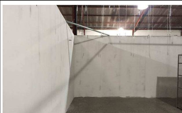
Figura 40C: Emassamento das paredes.
