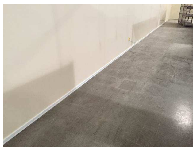
Figura 28C: Rodapés instalados - Sala Refrigerada.
