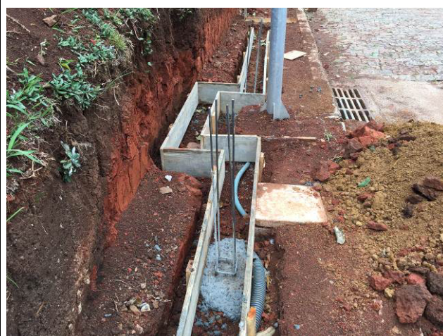
Figura 58C: Brocas concretadas.
