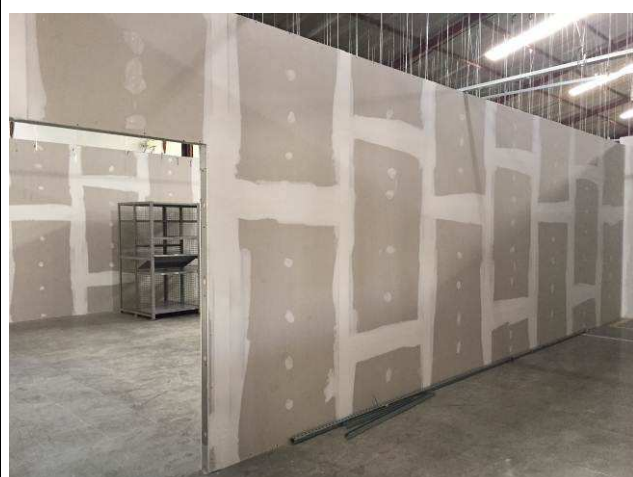
Figura 20C: Montagem das paredes de gesso acartonado - aplicação de fita e massa nas juntas.
