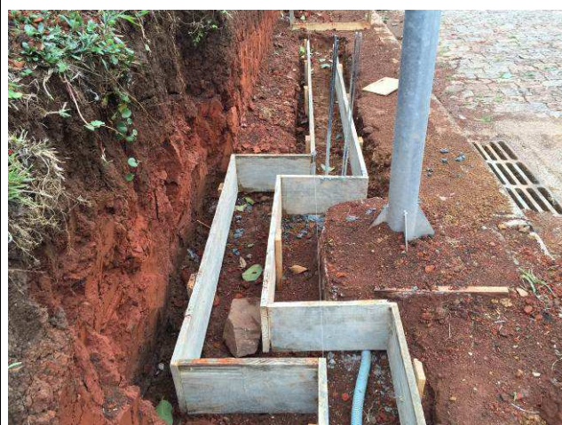
Figura 62C: Montagem das formas da viga baldrame.
