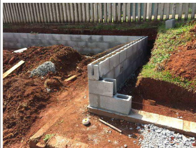
Figura 72C: Assentamento dos blocos de concreto.
