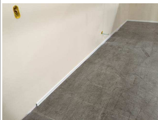
Figura 30C: Rodapés instalados - Sala Refrigerada.
