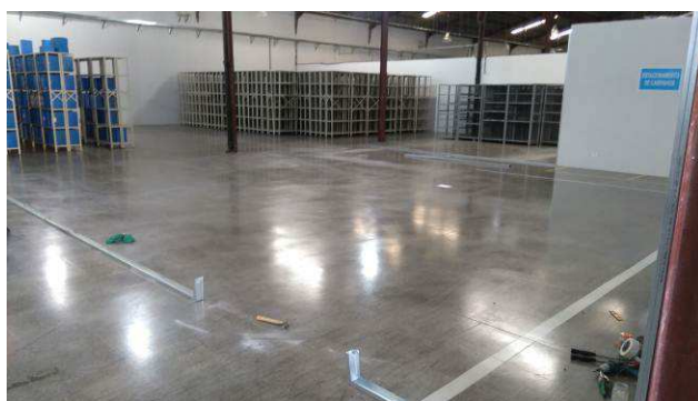
Figura 13C: Marcação das paredes.
