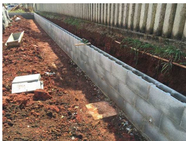
Figura 73C: Assentamento dos blocos de concreto.
