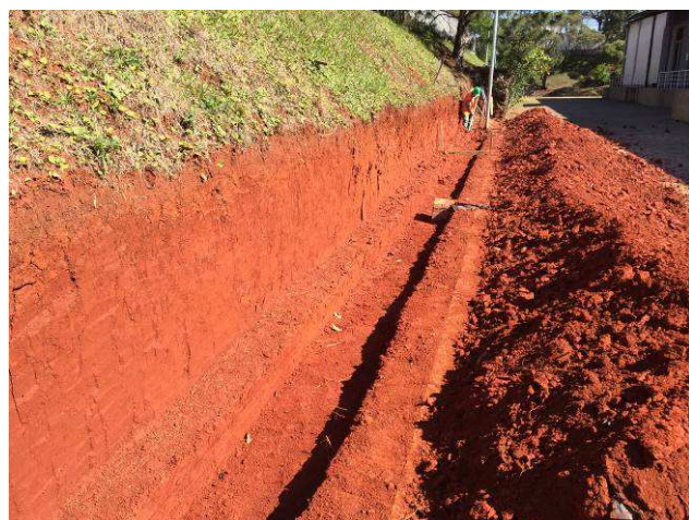
Figura 55C: Raspagem e escavação do terreno.
