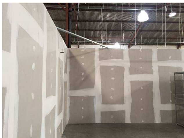
Figura 21C: Montagem das paredes de gesso acartonado - aplicação de fita e massa nas juntas.
