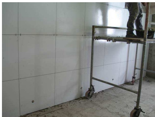
Figura 37C: Assentamento de porcelanato retificado Nórdico Snow, 60x60 cm, marca Incepa, em parede do banheiro feminino.(assentamento em andamento).
