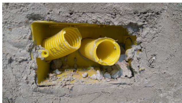
Figura 05E: caixas 2x4" e eletrodutos corrugados - banheiro feminino público 2º piso casarão.
