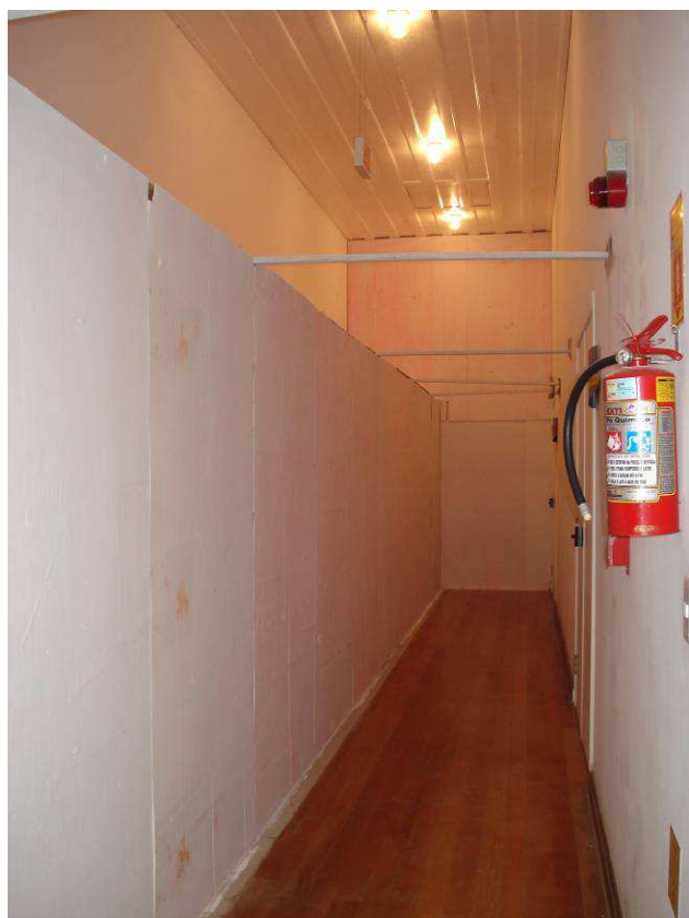
Figura 05C: Tapume de chapa de madeira compensada, para delimitação da área de trabalho, na sobreloja do Casarão.
