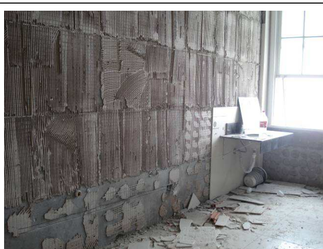
Figura 22C: Bancada em granito (com respectivas cubas) removida no banheiro masculino existente. Item armazenado para posterior adaptação e reinstalação.
