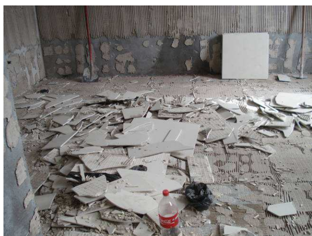
Figura 14C: Revestimento de piso removido no banheiro feminino existente.
