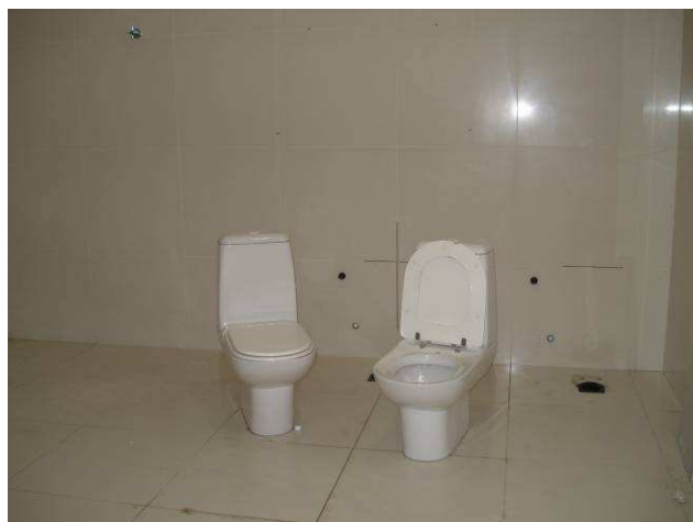
Figura 20C: Vasos sanitários removidos do banheiro feminino. Itens armazenados para posterior reinstalação.
