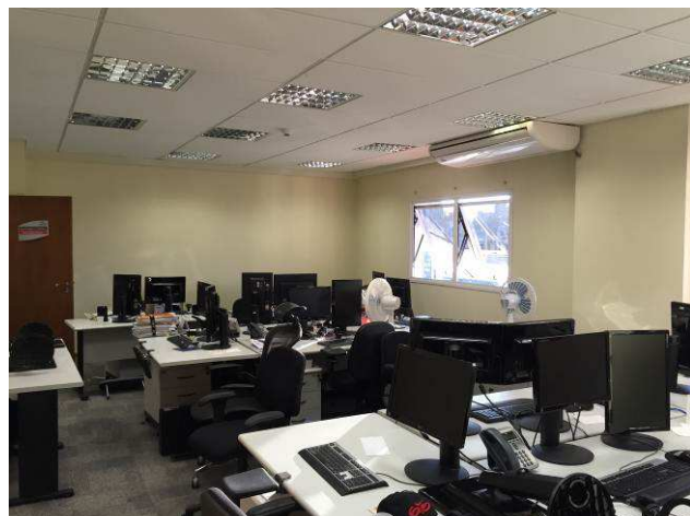
Figura 86C: Pintura executada com tinta látex acrílica, na cor palha, marca Luz & Cor, no gabinete do Dr. Paulo Pozzolo (11º andar).
