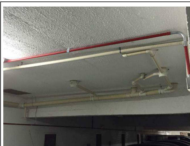
Figura 73C: Caixas sifonadas instaladas no banheiro feminino e masculino.
