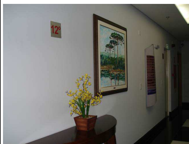
Figura 79C: Pintura executada com tinta látex acrílica, na cor branco gelo, marca Luz & Cor, em paredes do corredor do 12º andar.
