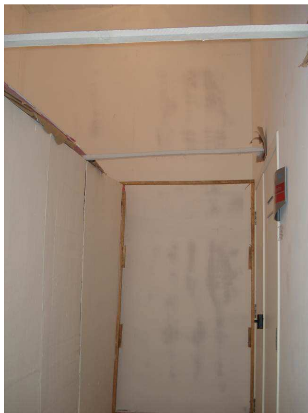
Figura 30C: Detalhe da montagem da parede identificada ao lado (vista corredor externo).
