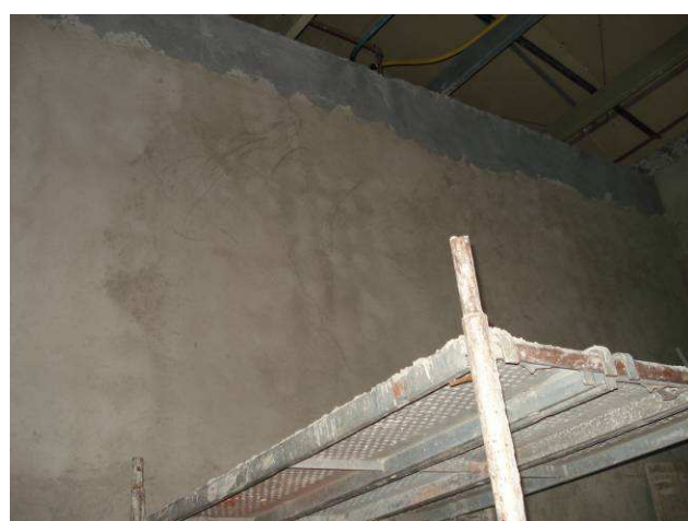
Figura 35C: Regularização de paredes para assentamento de porcelanato no banheiro feminino.
