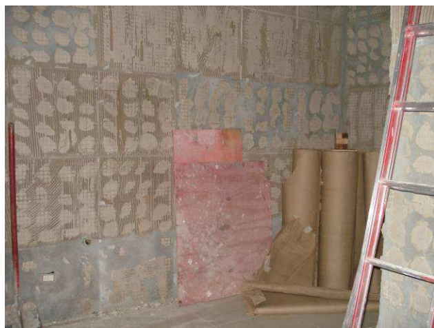
Figura 16C: Azulejo removido no banheiro feminino existente.
