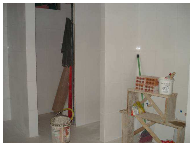
Figura 67C: Concluído assentamento e rejuntamento de azulejos Eliane, 33x45 cm, da linha Forma, na cor branca, no banheiro/vestiário masculino.
