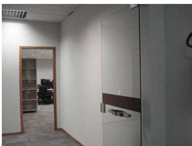
Figura 78C: Pintura executada com tinta látex acrílica, na cor branco gelo, marca Luz & Cor, em paredes do corredor do 3º andar.
