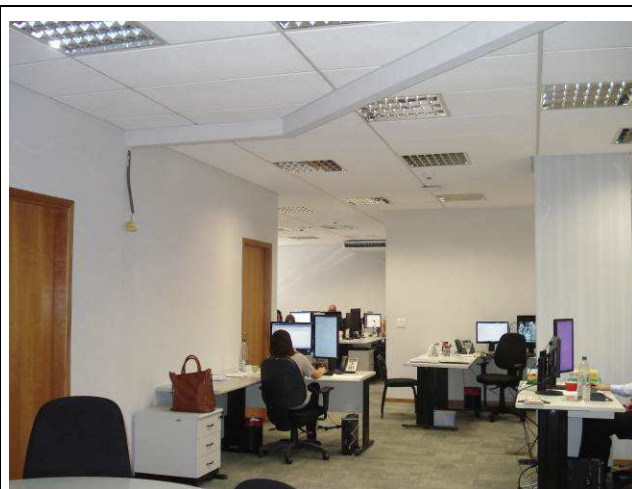
Figura 88C: Pintura executada com tinta látex acrílica, na cor branco gelo, marca Luz & Cor, no gabinete do Dr. Adilson Luiz Funez (5º andar).
