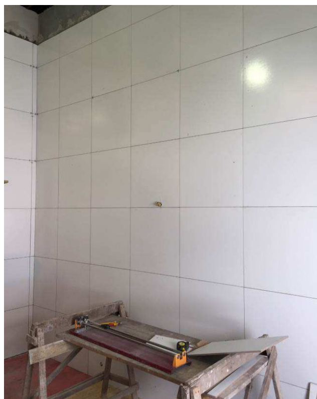
Figura 39C: Detalhe do equipamento manual utilizado no corte das peças.
