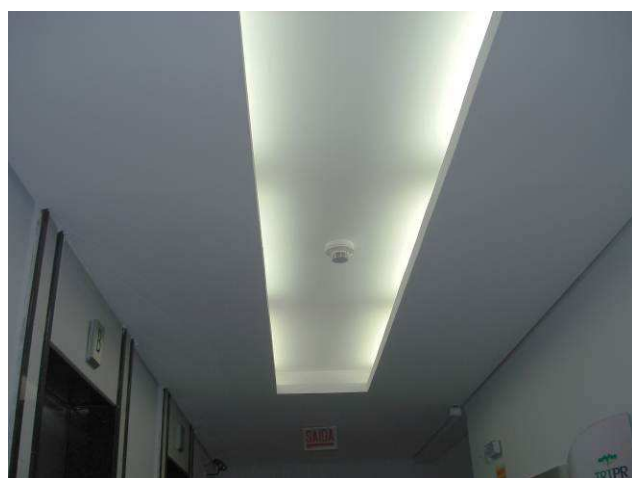
Figura 82C: Pintura executada com tinta látex acrílica, na cor branco neve, marca Luz & Cor, no teto.
