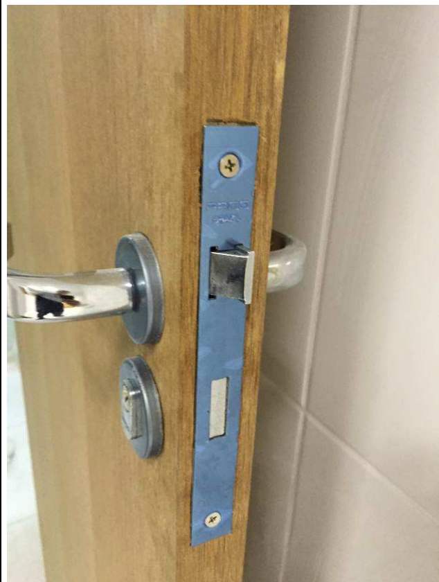
Figura 63C: Foram utilizadas fechadura 40mm, da linha ZM COPA, marca Pado e maçaneta tipo alavanca com roseta em acabamento cromado.
