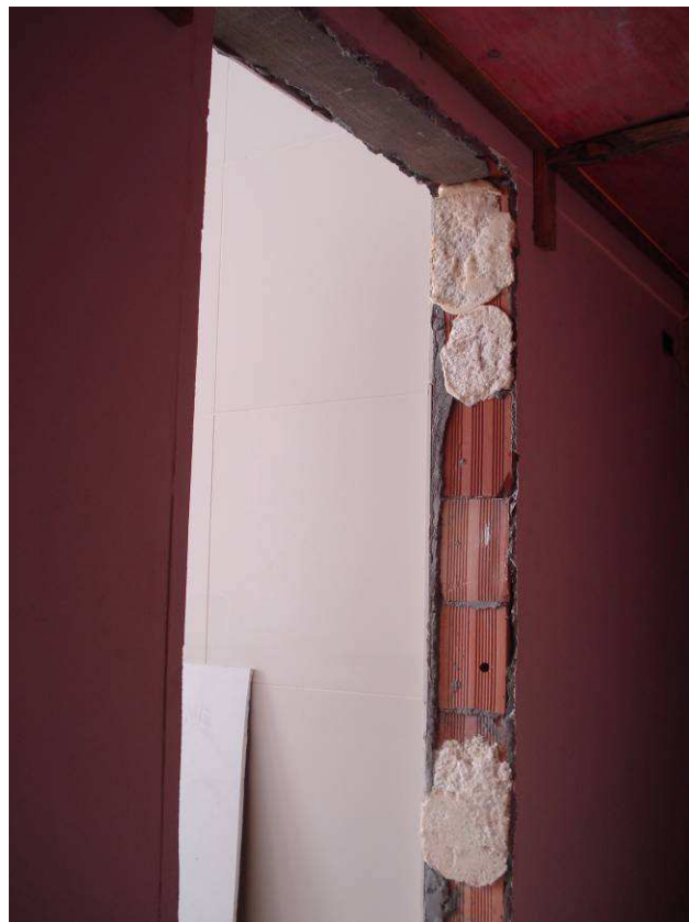
Figura 19C: Porta removida do banheiro masculino existente. Item armazenado para posterior reinstalação.
