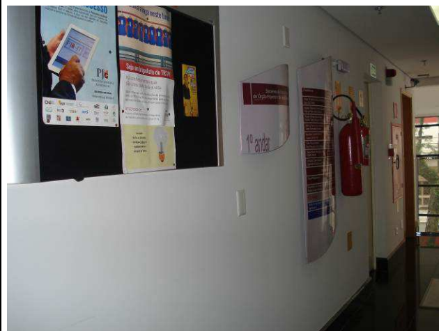
Figura 81C: Pintura executada com tinta látex acrílica, na cor branco gelo, marca Luz & Cor, em paredes da sobreloja (1º andar).
