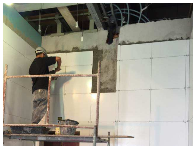
Figura 38C: Detalhe do assentamento no banheiro feminino. Pendente execução de rejuntamento.
