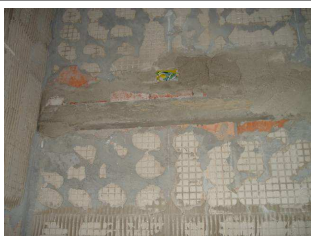
Figura 28C: Verga executada sobre o vão da porta do banheiro masculino (na foto, demolição não iniciada).
