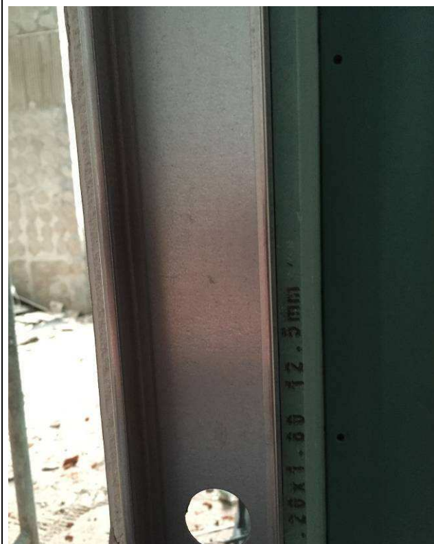
Figura 34C: Detalhe de perfil metálico e chapa de gesso acartonado verde (125mm) utilizados na montagem das paredes.
