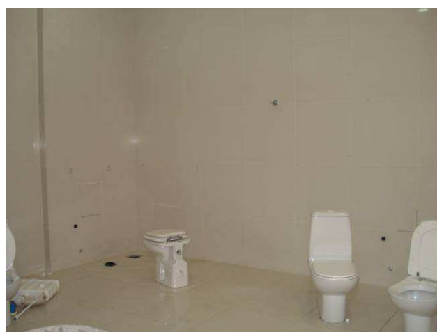
Figura 15C: Divisórias sanitárias removidas no banheiro feminino existente.
