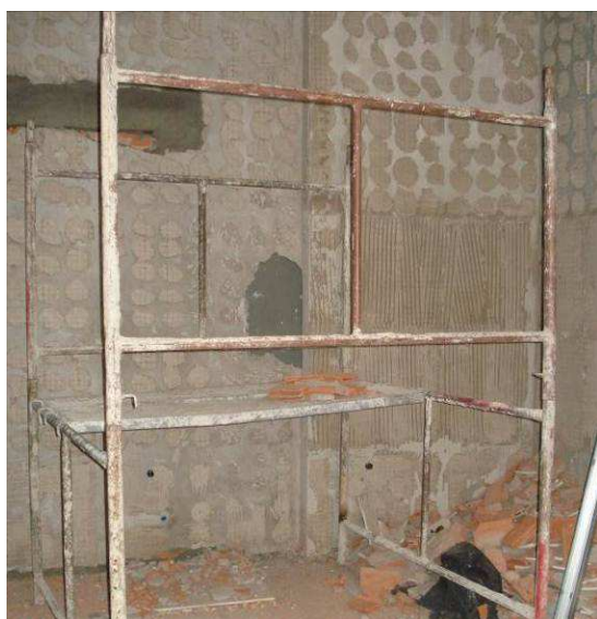
Figura 01C: Utilização de andaime metálico tipo fachadeiro.
