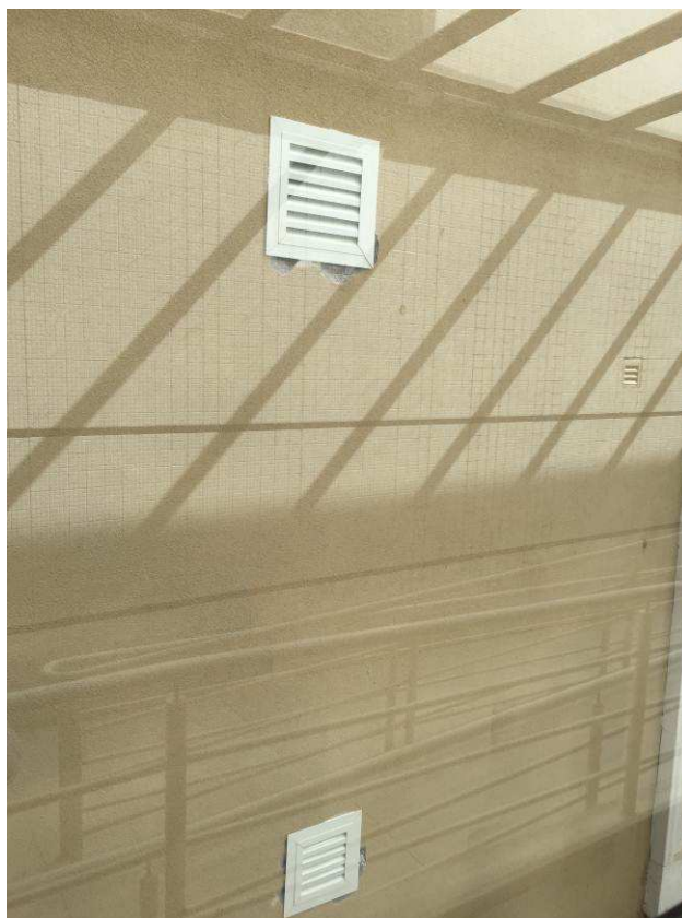
Figura 07C: Executada demolição de alvenaria e instalação de esquadrias fixas (inferior e superior) para ventilação da área anexa ao ponto de gás instalado (fogão).
