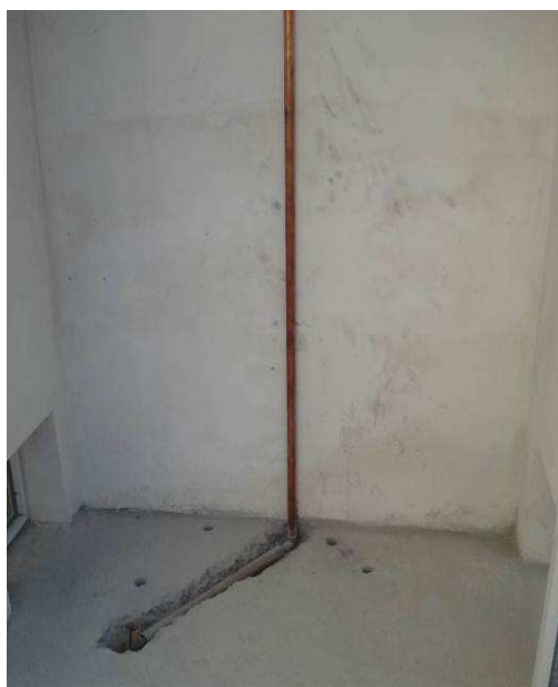
Figura 74C: Executada tubulação de gás em cobre 22mm, em trecho correspondente à ligação da central GLP ao ponto da cozinha.
