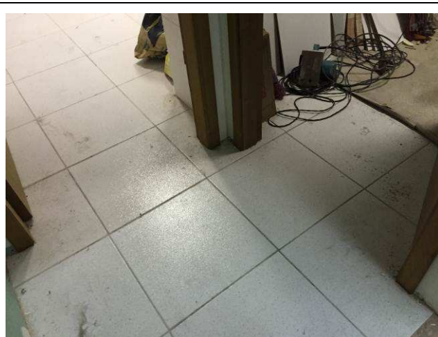
Figura 71C: Executado assentamento e rejuntamento do piso da linha Cargo Plus (Eliane), 45x45 cm, cor White, nos banheiros/vestiários feminino e masculino.
