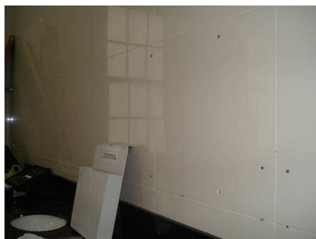
Figura 23C: Espelho removido no banheiro feminino existente. Item armazenado para posterior adaptação e reinstalação.
