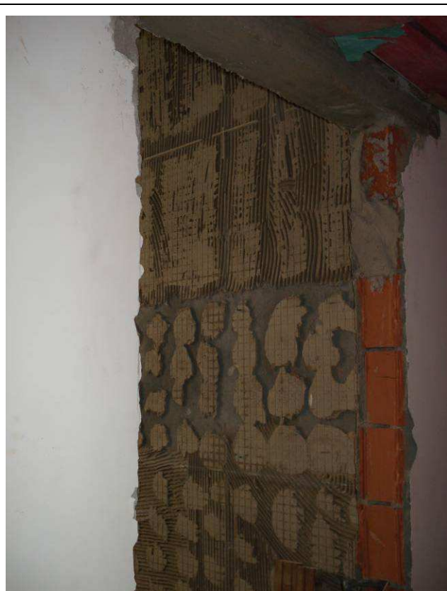
Figura 26C: Demolição em parede de alvenaria (em primeiro plano), para instalação de porta de acesso ao banheiro masculino.
