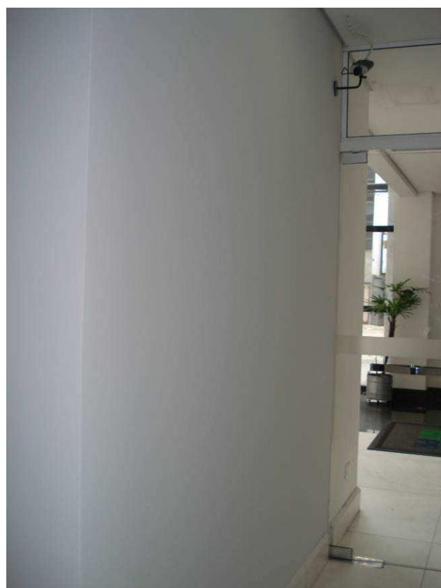
Figura 80C: Pintura executada com tinta látex acrílica, na cor branco gelo, marca Luz & Cor, em paredes do corredor do térreo.
