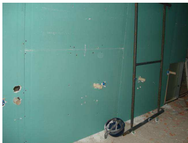
Figura 46C: Executados 4 pontos de água fria (Ø 25 mm) e esgoto secundário (Ø 50 mm) para lavatórios do banheiro feminino.
