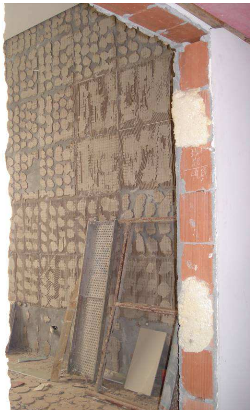
Figura 18C: Porta removida do banheiro feminino existente. Item armazenado para posterior reinstalação.
