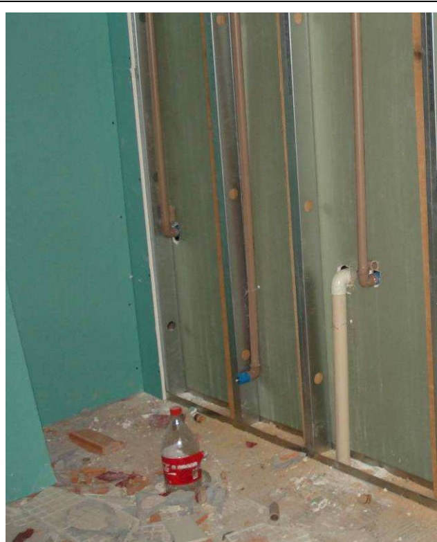
Figura 47C: Executado 1 ponto de água fria (Ø 25 mm) e esgoto primário (Ø 100 mm) para vaso sanitário do banheiro masculino
