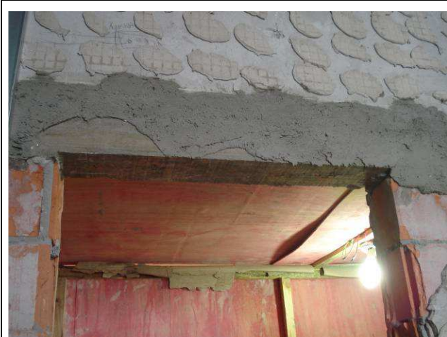
Figura 27C: Verga executada sobre o vão da porta do banheiro feminino.
