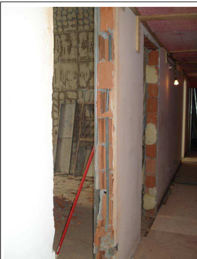
Figura 25C: Demolição em parede de alvenaria (em primeiro plano), para instalação de porta de acesso ao banheiro feminino.
