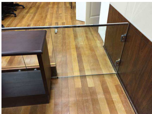
Figura 89C: Após remoção e adaptação da estrutura preexistente, foi instalada porta de vidro laminado incolor e vidro fixo (ambos e=8mm), no Plenário II.
