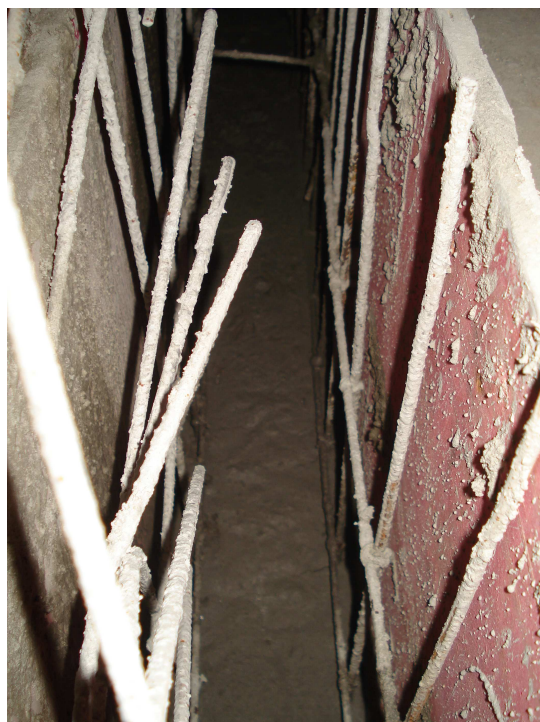
Figura 92C: Detalhe da concretagem.
