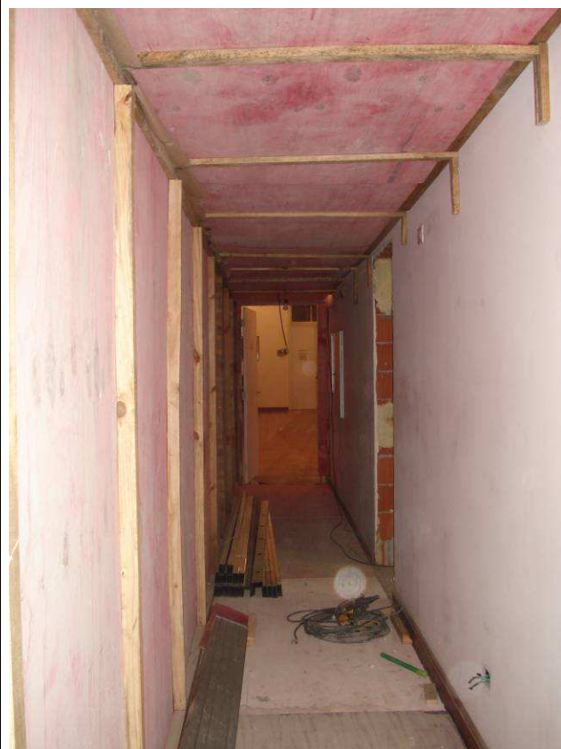
Figura 06C: Vista interna da área delimitada, mostrada na figura ao lado.
