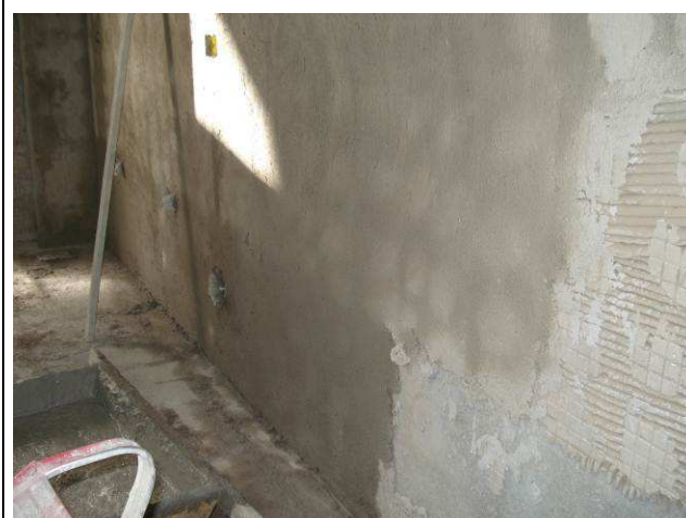
Figura 36C: Regularização de paredes para assentamento de porcelanato no banheiro masculino.
