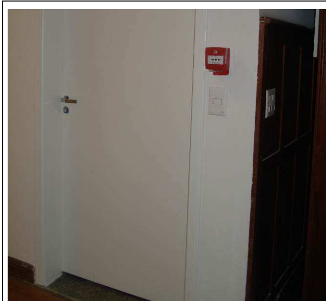
Figura 08C: Soleira em granito polido cinza andorinha, instalado junto à porta de acesso à copinha.
