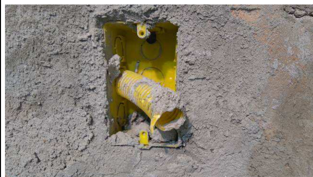
Figura 06E: caixas 2x4" e eletrodutos corrugados - banheiro feminino público 2º piso casarão.
