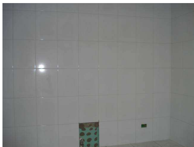
Figura 68C: Detalhe de parede executada no banheiro/vestiário masculino.
