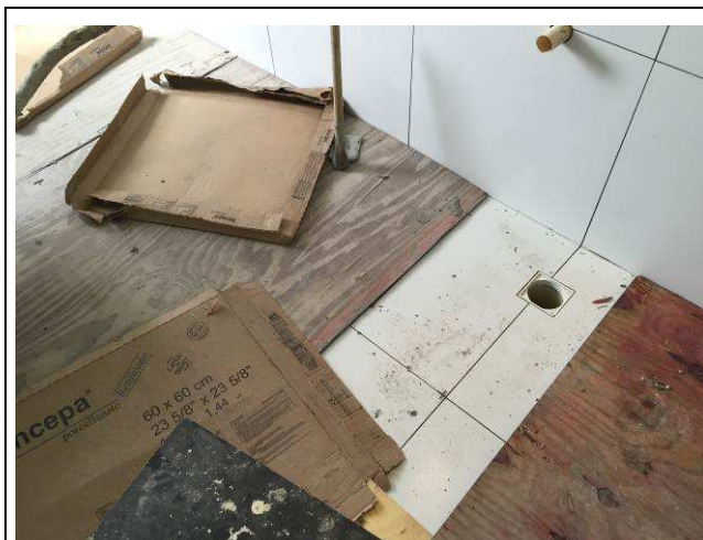
Figura 43C: Executados regularização e assentamento de porcelanato retificado Nórdico Snow, 60x60 cm, marca Incepa, no banheiro feminino.
