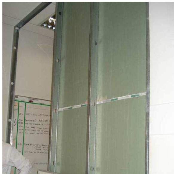
Figura 57C: Detalhe da parede parcialmente executada.
