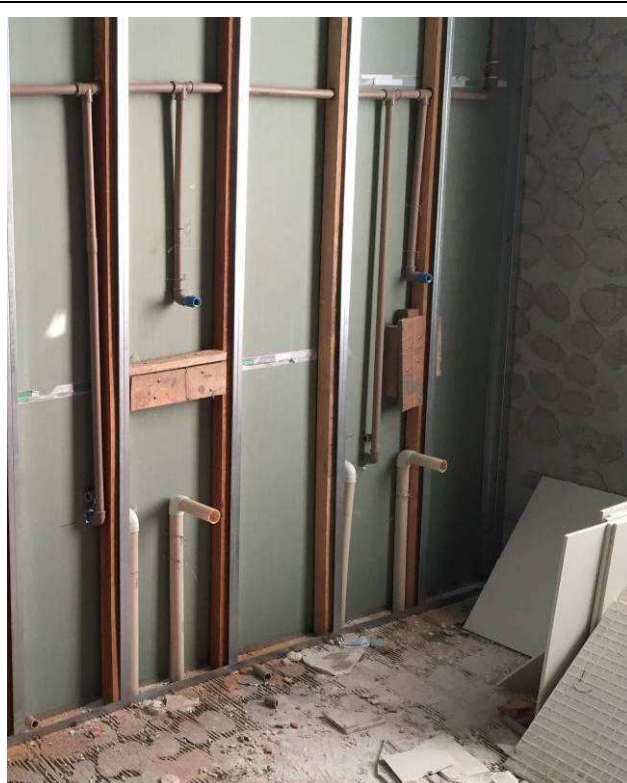
Figura 48C: Executados 2 pontos de água fria (Ø 25 mm) e esgoto secundário (Ø 50 mm) para mictórios do banheiro masculino.
