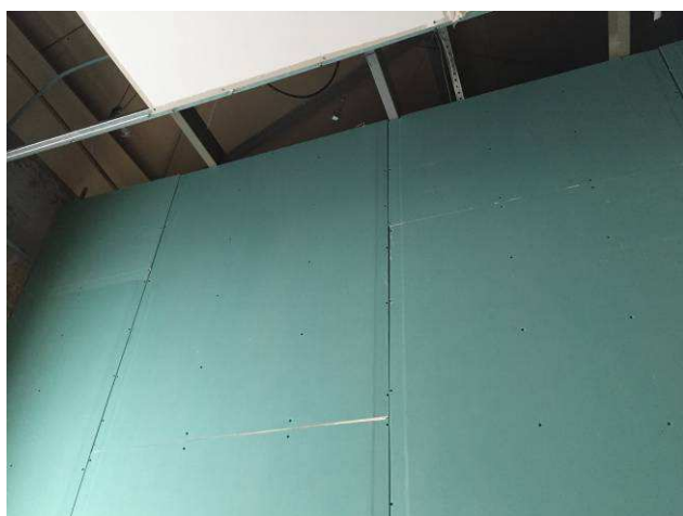
Figura 31C: Placas de gesso acartonado verde (e=125mm) utilizadas na montagem de parede de divisa entre os banheiros feminino e masculino.
