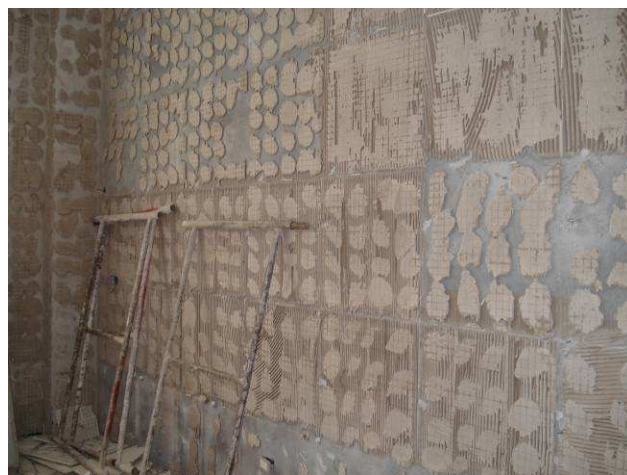
Figura 21C: Bancada em granito (com respectivas cubas) removida no banheiro feminino existente. Item armazenado para posterior adaptação e reinstalação.
