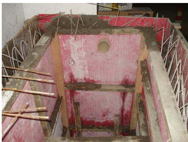
Figura 93C: Detalhe da forma e armação.
