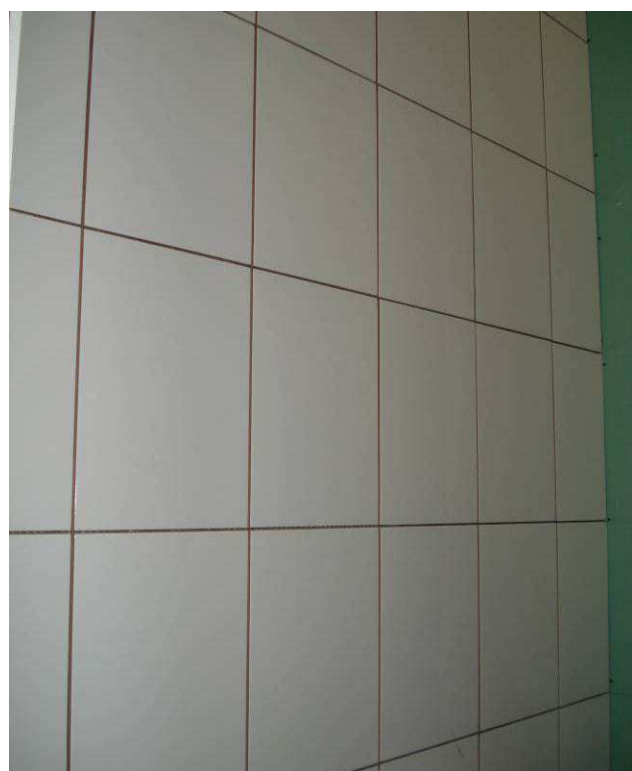
Figura 69C: Área do banheiro/vestiário feminino com assentamento parcial de azulejos Eliane, 33x45 cm, da linha Forma, na cor branca. Pendente execução de rejuntamento.
