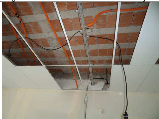
Figura 09E: Infraestrutura elétrica, remanejamento iluminação.
