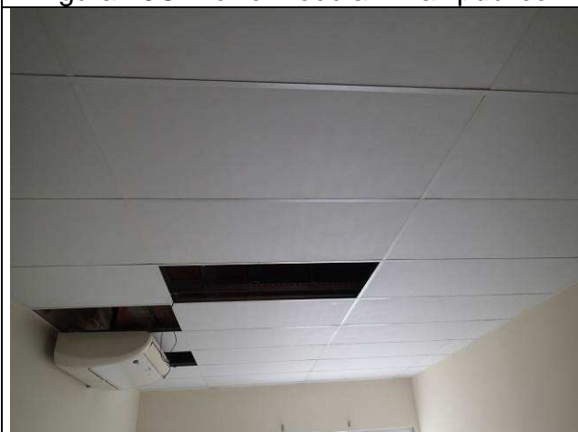
Figura 21C: Forro modular - PAB.
