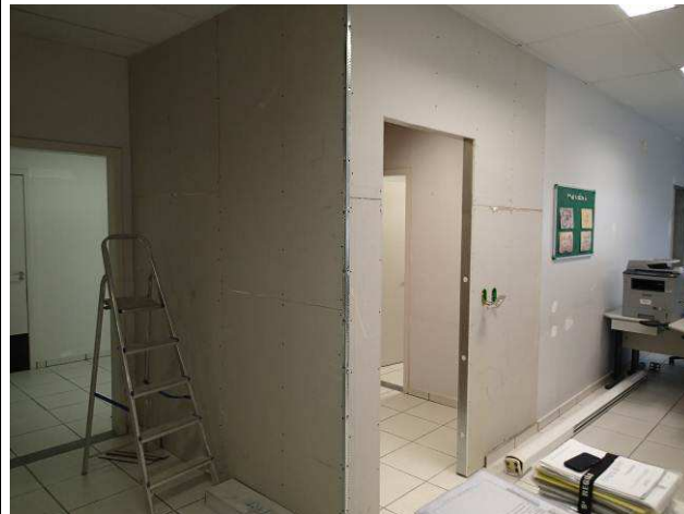
Figura 14C: Parede de gesso acartonado - depósito 1ª Vara.
