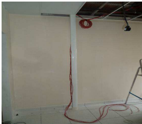
Figura 01E: Remanejamento de colunas técnicas.
