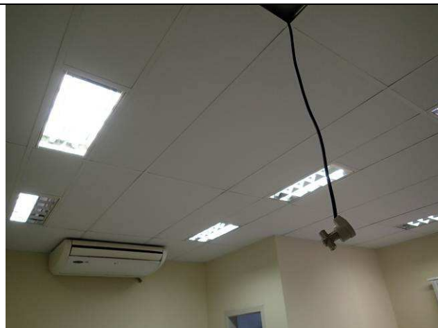
Figura 27C: Forro modular - gabinete juiz auxiliar 1ª Vara.
