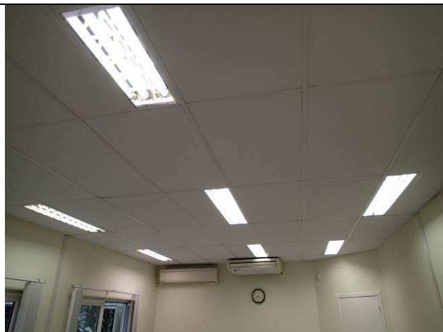
Figura 28C: Forro modular - sala de audiências da 1ª Vara.
