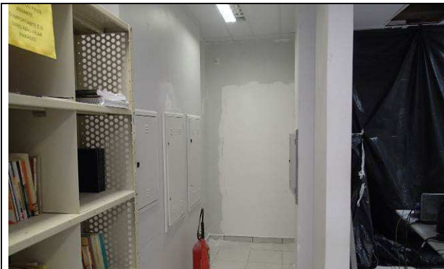
Figura 07C: Alvenaria de vedação - fechamento dos vãos.
