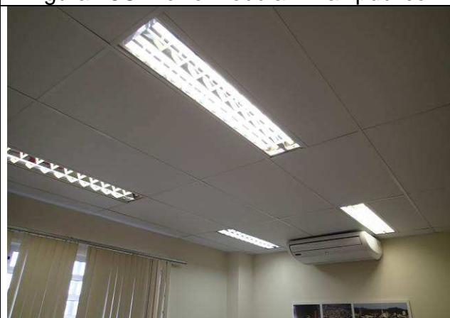
Figura 20C: Forro modular - OAB.
