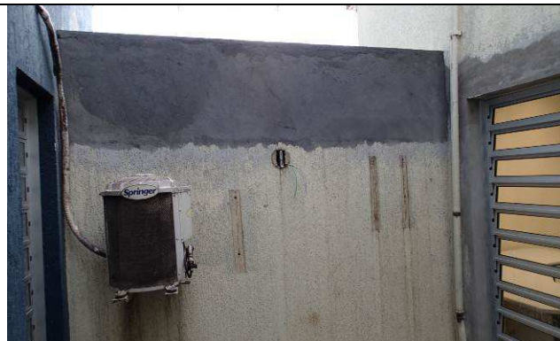
Figura 08C: Alvenaria de vedação - aumento da altura do muro.
