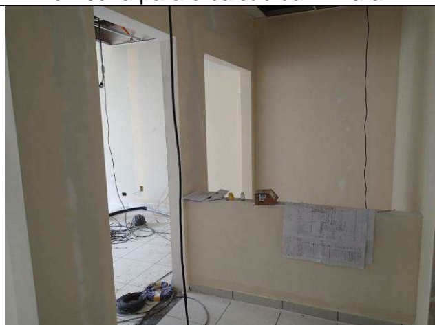
Figura 12C: Parede de gesso acartonado - balcão da Distribuição.
