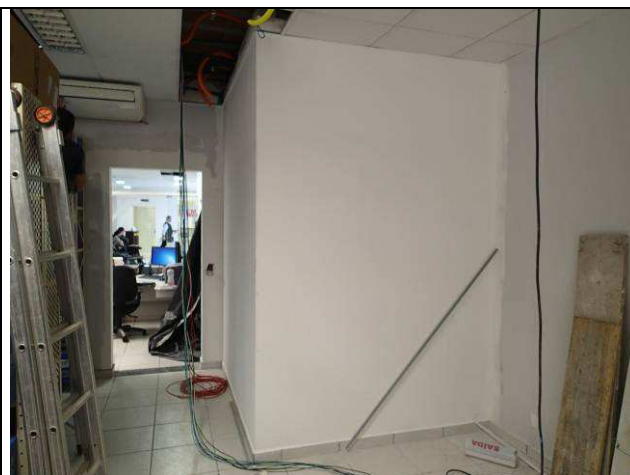
Figura 42C: Aplicação de massa PVA.
