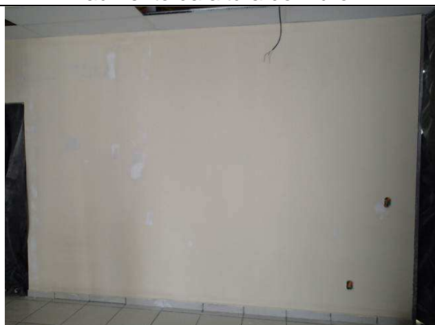
Figura 10C: Parede de gesso acartonado - divisória para o balcão da 1ª Vara.
