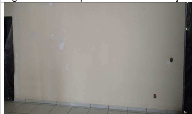
Figura 33C: Rodapé cerâmico - Balcão.
