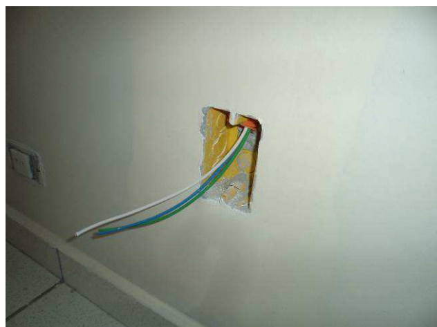
Figura 03E: Remanejamento de circuitos, infraestrutura elétrica.
