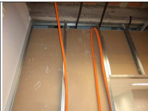
Figura 06E: Remanejamento de circuitos, infraestrutura elétrica.
