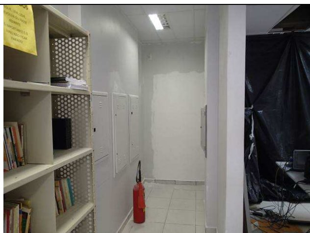
Figura 40C: Aplicação de massa PVA.
