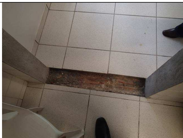
Figura 36C: Recorte para instalação de soleira - cozinha.
