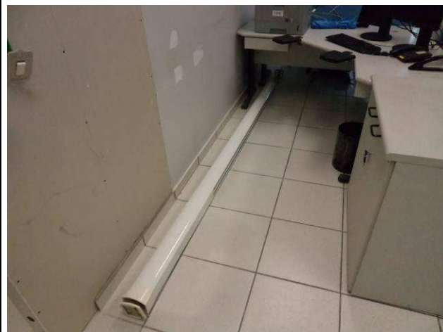
Figura 02E: Remanejamento de colunas técnicas.
