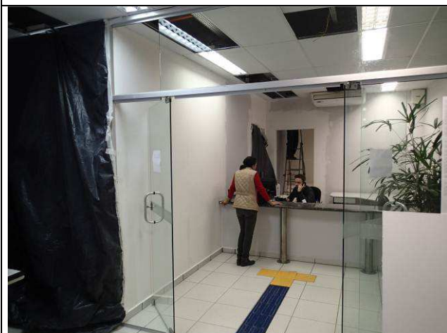
Figura 09C: Parede de gesso acartonado - divisória para o balcão da 1ª Vara.
