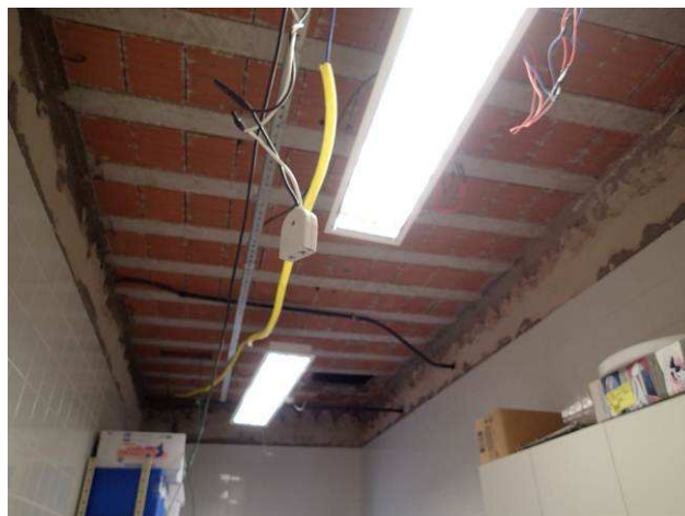
Figura 04C: Remoção de forro - cozinha.
