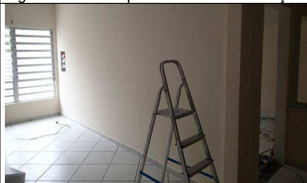
Figura 34C: Rodapé cerâmico - OAB.
