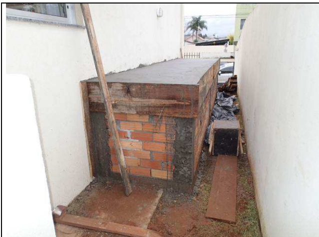
Figura 51C: Estrutura de concreto armado, e alvenaria de vedação, da base dos reservatórios de aproveitamento de águas pluviais.
