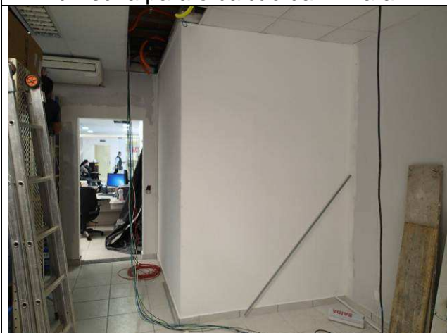
Figura 11C: Parede de gesso acartonado - balcão da Distribuição.
