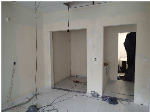
Figura 05C: Demolição de paredes de alvenaria - abertura de vãos da Distribuição.
