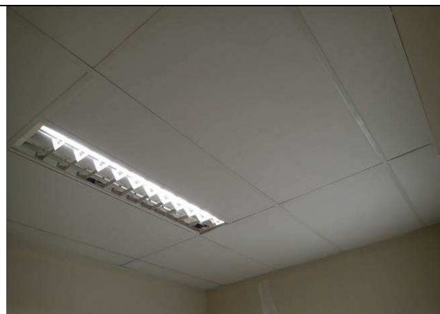
Figura 23C: Forro modular - acesso banheiros da 1ª Vara.
