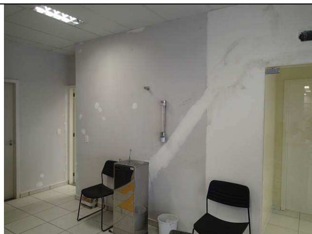
Figura 41C: Aplicação de massa PVA.
