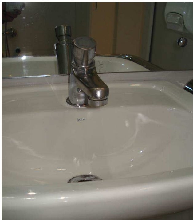
Figura 66C: Torneiras reinstaladas no lavatório do banheiro PNE.
