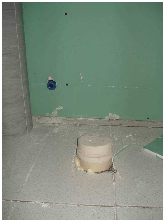
Figura 103C: Executado 1 ponto de água fria (Ø 25 mm) e 1 ponto de esgoto primário (Ø 100 mm) para instalação de bacia sanitária do banheiro feminino.
