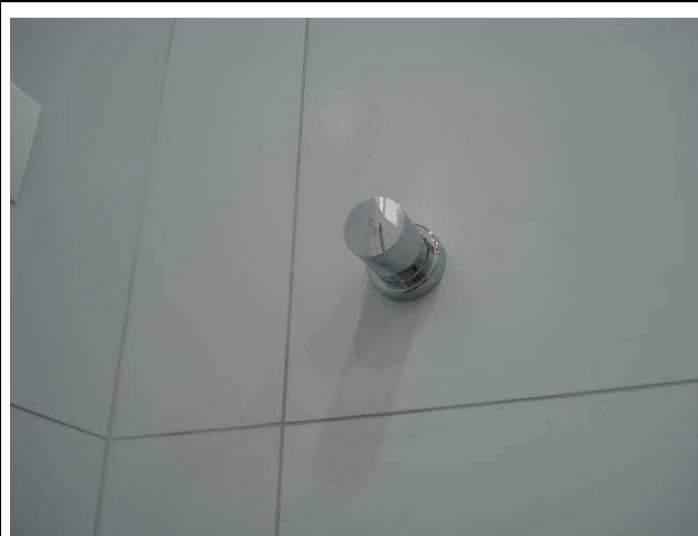
Figura 31C: Executados acabamentos e instalada canopla cromada dos registros de gaveta 3/4" (banheiro feminino).
