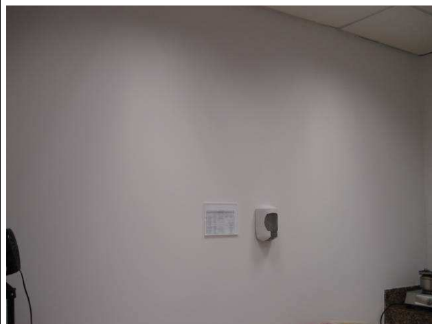
Figura 120C: Pintura executada com tinta látex acrílica, na cor branco gelo, marca Luz & Cor, em paredes da copa do 9º andar. (Padrão se repetiu do 5º ao 10º andar).
