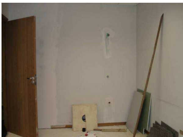
Figura 88C: Executado emassamento das paredes da Secretaria do Pleno.
