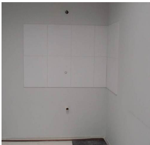
Figura 83C: Executados ponto de água fria Ø 25 mm, esgoto secundário Ø 50 mm e registro de gaveta, junto ao balcão da pia.
