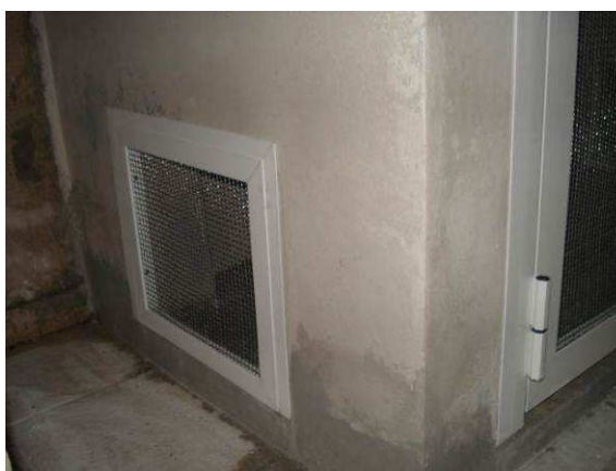
Figura 113C: Venezianas em alumínio anodizado natural fixas (4 unidades), instaladas no abrigo da central GLP.
