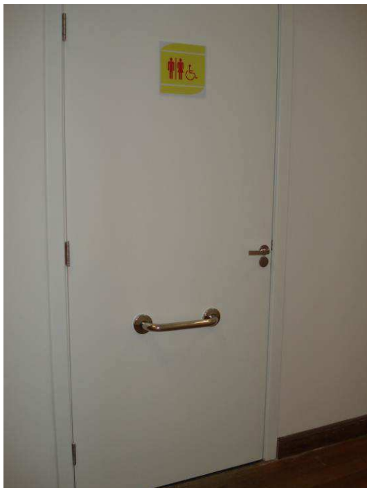
Figura 09C: Porta PM90 instalada no banheiro PNE.
