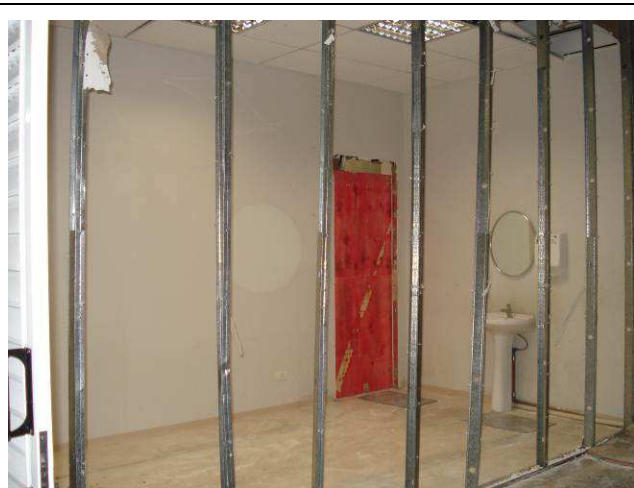
Figura 91C: Foi realizada desmontagem e remoção de divisória em gesso acartonado existente no antigo depósito de lixo.
