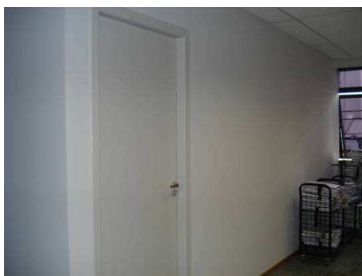
Figura 90C: Pintura da porta da copa da Secretaria do Pleno executada com tinta esmalte sintético, cor branco neve, marca Glasurit.
