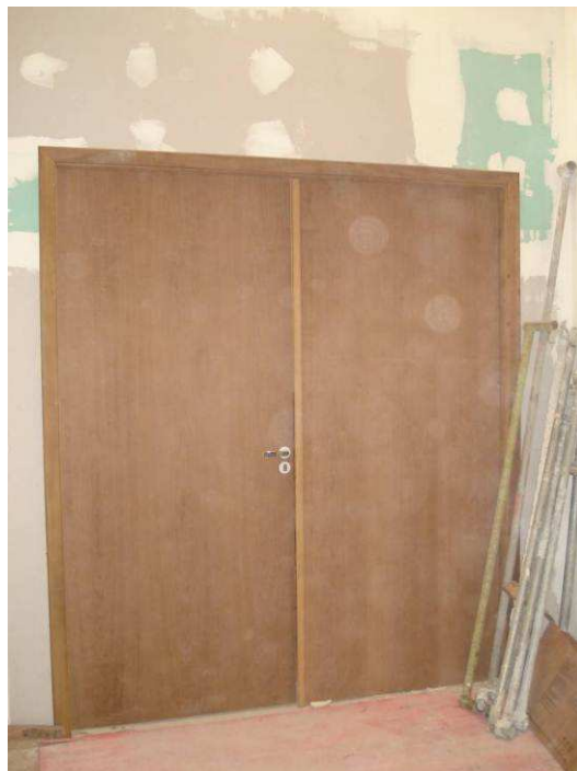
Figura 10C: Porta PM180 instalada no corredor de acesso aos banheiros e cozinha.
