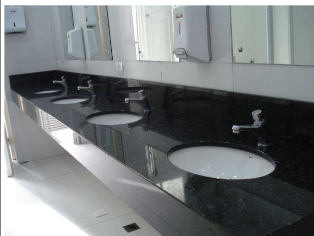
Figura 43C: Bancada em granito, adaptada e reinstalada, com as devidas cubas, no banheiro feminino.
