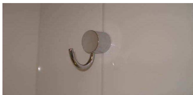
Figura 87C: Toalheiro tipo gancho, com acabamento cromado, marca Deca, instalado junto ao balcão da pia.
