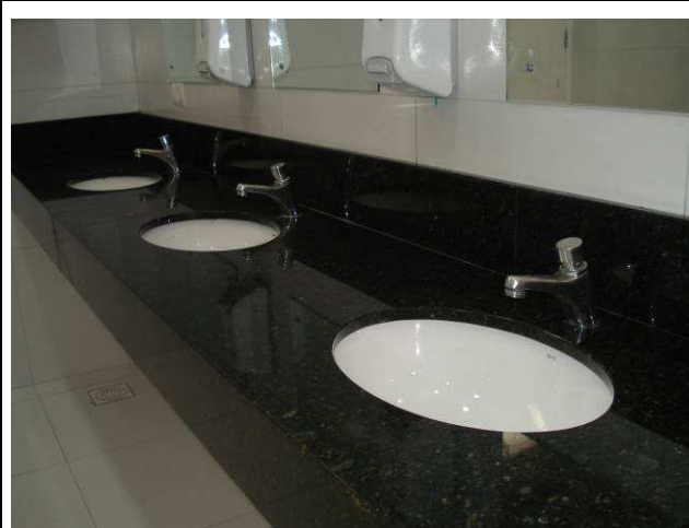
Figura 65C: Torneiras reinstaladas na bancada em granito do banheiro masculino.
