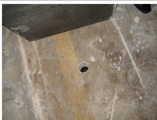
Figura 93C: Executada furação na laje do 1º subsolo para execução de pontos de esgoto primário e secundário dos banheiros feminino e masculino.
