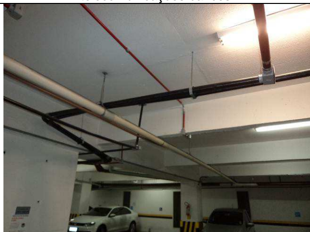
Figura 10E: infraestrutura - entrada de telecomunicações bancos.
