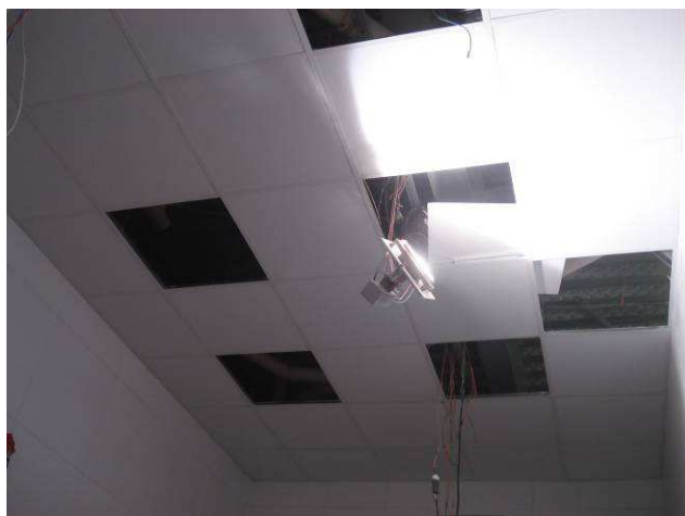
Figura 15C: Forro de gesso acartonado removível instalado no banheiro feminino.
