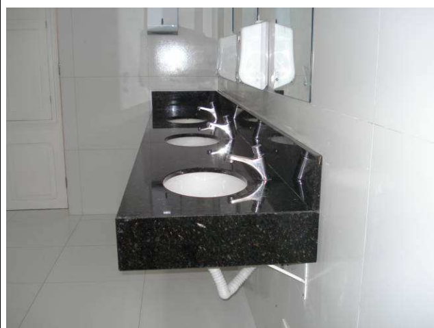
Figura 44C: Bancada em granito, adaptada e reinstalada, com as devidas cubas, no banheiro masculino.
