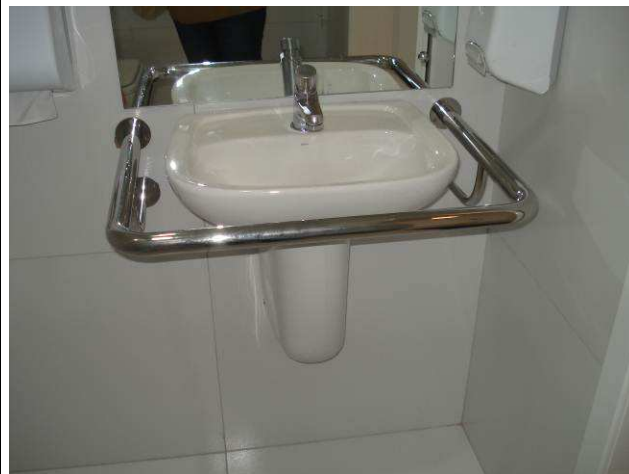
Figura 67C: Barra de apoio, em aço inox escovado, instalada no lavatório do banheiro PNE.
