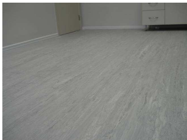
Figura 80C: Instalado piso vinílico em manta (Beaulieu), cor fóssil, na copa da Secretaria do Pleno. Piso instalado sobre chapas de compensado naval 20 mm.
