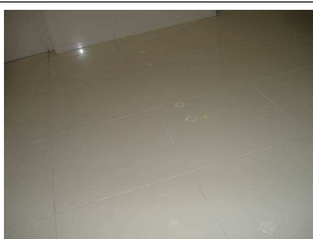
Figura 73C: Finalizada furação de pontos de esgoto primário/secundário na laje da sobreloja.
