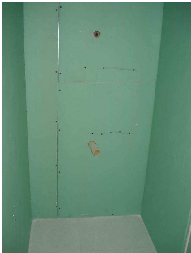
Figura 96C: Parede em gesso acartonado RU, cor verde, instalada no banheiro/vestiário feminino.
