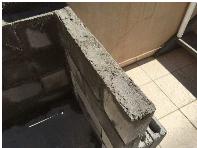
Figura 109C: Utilizados blocos de concreto preenchidos com concreto, no levantamento do abrigo da central GLP.
