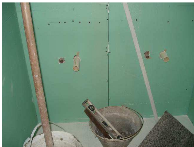
Figura 104C: Executados 2 pontos de água fria (Ø 25 mm) e 2 de esgoto secundário (Ø 50 mm) para instalação de lavatórios do banheiro masculino.
