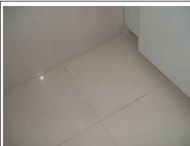
Figura 74C: Finalizada furação de pontos de esgoto primário/secundário na laje da sobreloja.
