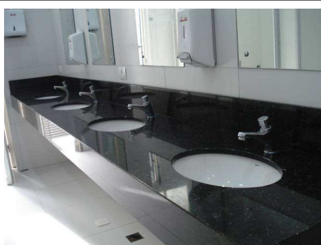
Figura 64C: Torneiras reinstaladas na bancada em granito do banheiro feminino.
