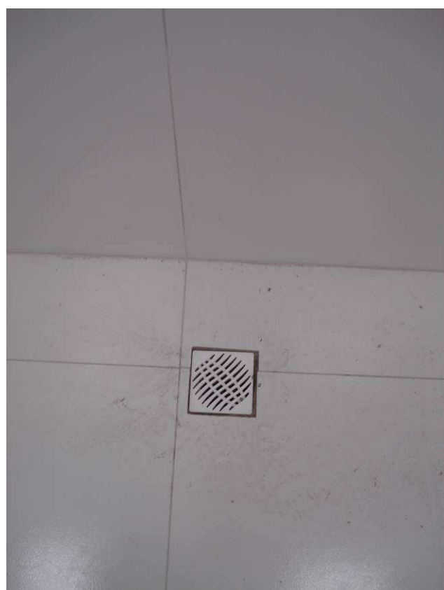
Figura 34C: Executados acabamentos e instalada grelha das caixas sifonadas (cozinha).
