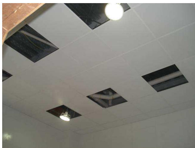
Figura 18C: Forro de gesso acartonado removível instalado na cozinha.
