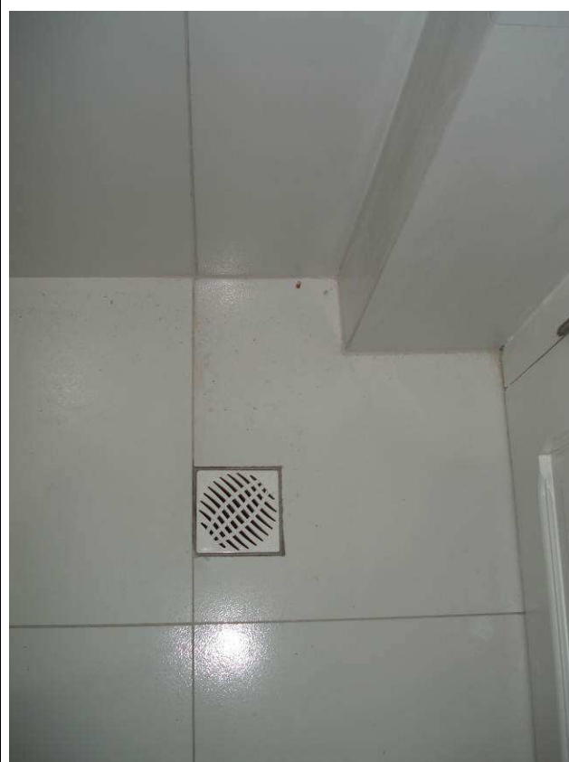
Figura 35C: Executados acabamentos e instalada grelha das caixas sifonadas (apoio).
