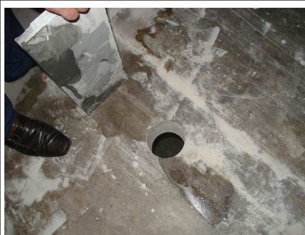
Figura 94C: Executada furação na laje do 1º subsolo para execução de pontos de esgoto primário e secundário dos banheiros feminino e masculino.
