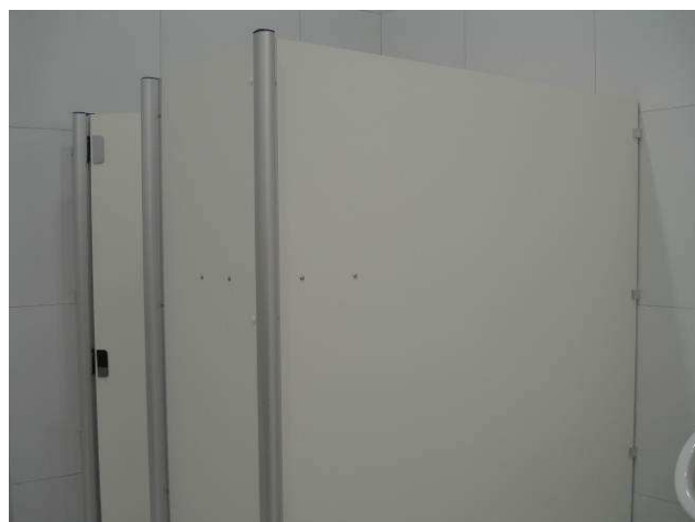
Figura 05C: Divisórias sanitárias SANISYSTEM MASTER (e=10mm), instaladas no banheiro masculino.
