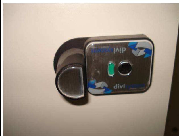
Figura 04C: Detalhe das portas com tarjeta livre/ocupado, instaladas no banheiro feminino.
