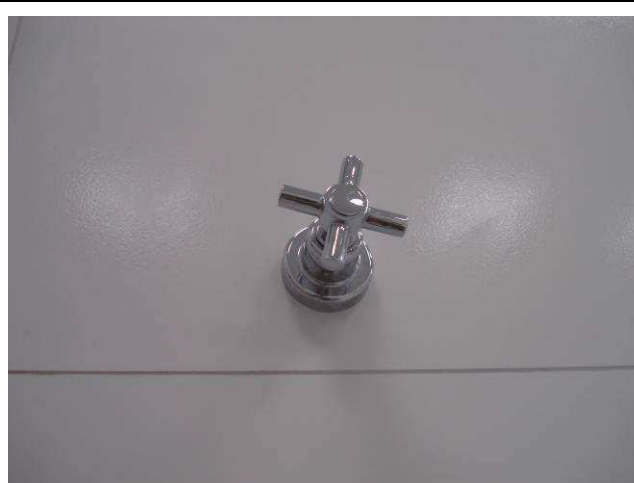
Figura 30C: Executados acabamentos e instalada canopla cromada dos registros de gaveta 3/4" (cozinha).
