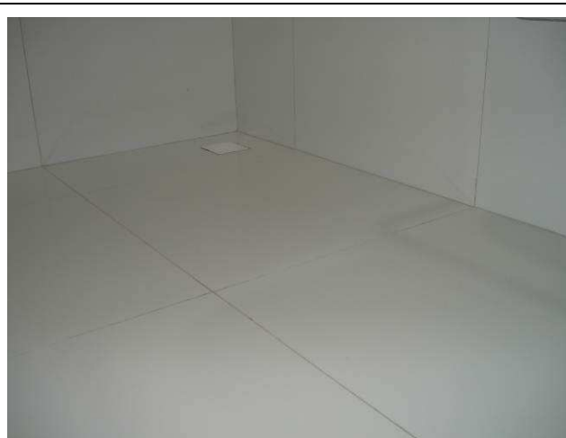
Figura 25C: Piso em porcelanato Incepa assentado e rejuntado, no banheiro PNE.
