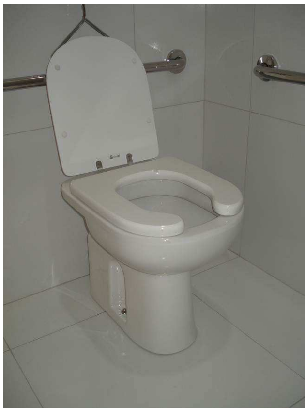
Figura 39C: Instalada bacia sanitária, marca Deca, no banheiro PNE. Assento especial, marca Sicmol.
