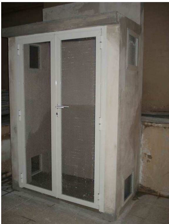
Figura 112C: Instalada porta em alumínio anodizado natural tipo veneziana, PAV 60x180, em duas folhas, no abrigo da central GLP.
