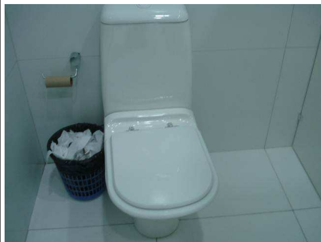
Figura 40C: Bacia sanitária reinstalada no banheiro masculino. Assento novo, marca Produza.
