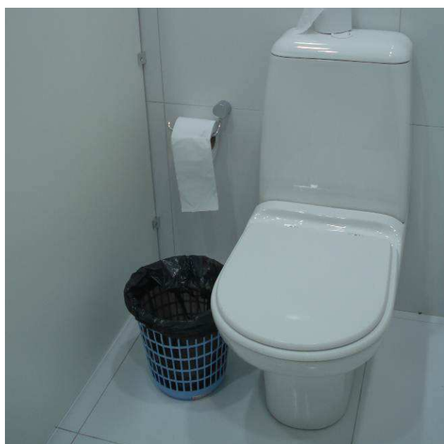
Figura 41C: Bacia sanitária reinstalada no banheiro feminino. Assento novo, marca Produza.
