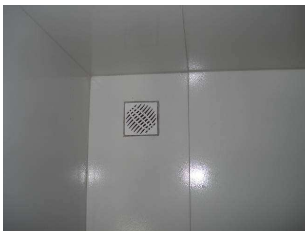
Figura 38C: Executados acabamentos e instalada grelha das caixas sifonadas (banheiro PNE).
