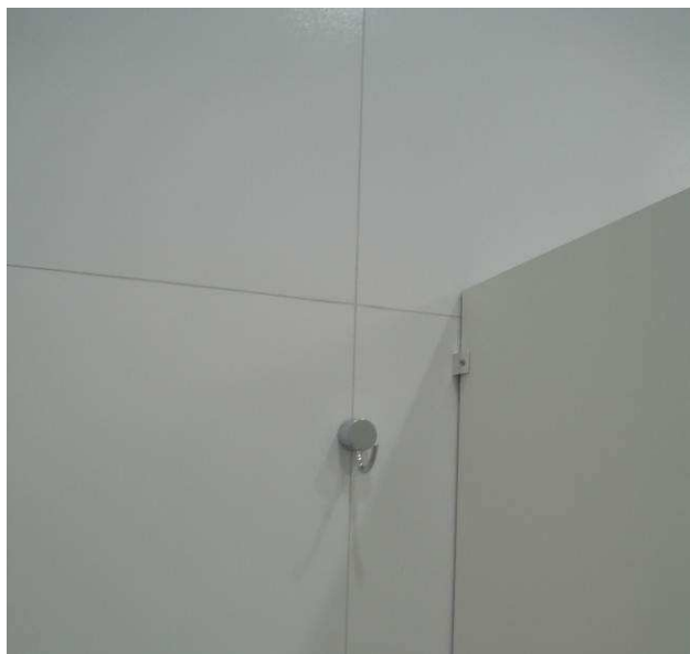
Figura 59C: Toalheiro tipo gancho, marca Deca, instalado no banheiro masculino.
