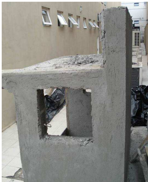
Figura 110C: Laje maciça executada no abrigo da central GLP.
