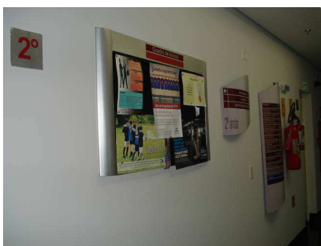
Figura 115C: Pintura executada com tinta látex acrílica, na cor branco gelo, marca Luz & Cor, em paredes do corredor do 2º andar.
