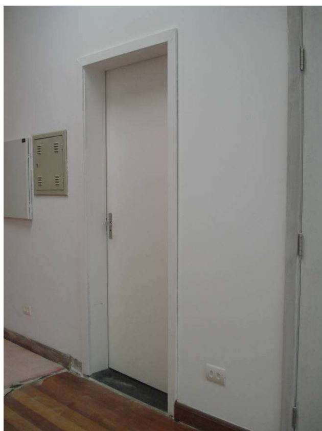
Figura 11C: Porta reinstalada no banheiro feminino.
