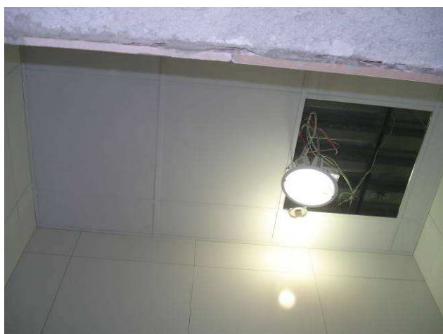
Figura 17C: Forro de gesso acartonado removível instalado no banheiro PNE.
