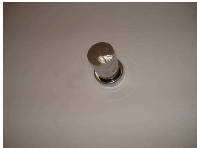
Figura 84C: Detalhe do acabamento cromado do registro de gaveta identificado ao lado.
