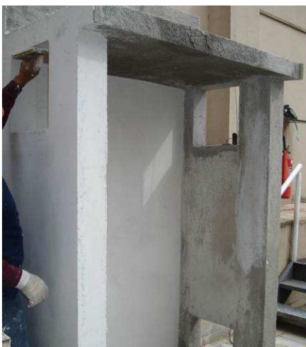
Figura 114C: Executado chapisco e emboço na alvenaria do abrigo da central GLP.
