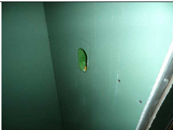
Figura 01E: infraestrutura de caixas 2X4" e eletrodutos corrugados - vestiários.
