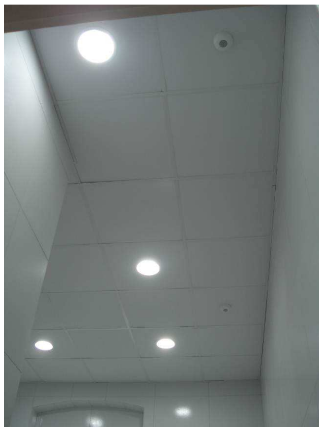
Figura 16C: Forro de gesso acartonado removível instalado no banheiro masculino.
