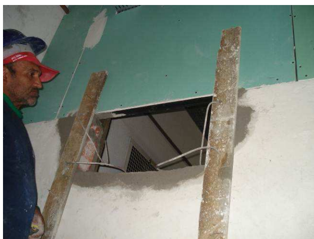
Figura 101C: Executado requadro de vão de janelas no banheiro/vestiário masculino.
