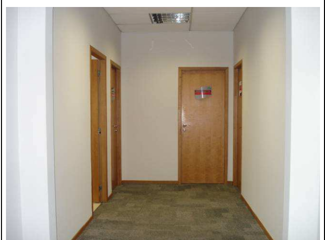
Figura 116C: Pintura executada com tinta látex acrílica, na cor branco gelo, marca Luz & Cor, em paredes do corredor do 4º andar. (Padrão se repetiu do 4º ao 11º andar, esse último, mostrado na próxima foto)
