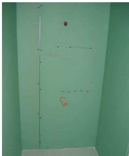
Figura 105C: Executado 1 ponto de água fria (Ø 25 mm) e 1 de esgoto secundário (Ø 50 mm) para instalação de mictório do banheiro masculino.
