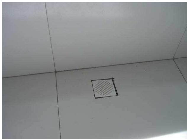
Figura 36C: Executados acabamentos e instalada grelha das caixas sifonadas (banheiro feminino).
