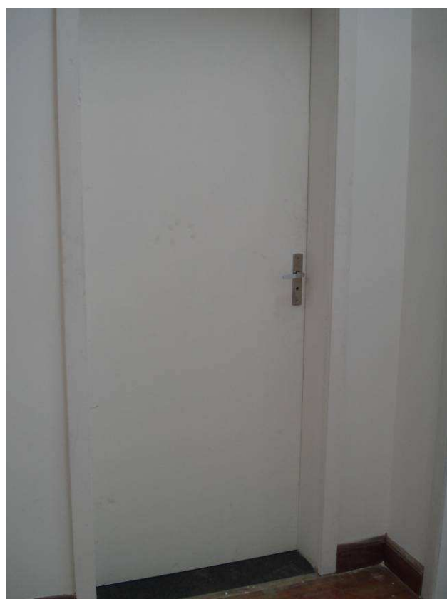
Figura 12C: Porta reinstalada no banheiro masculino.
