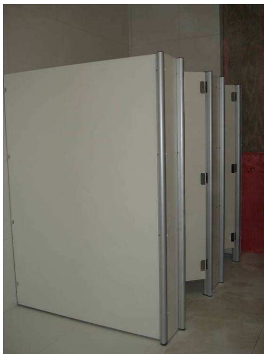
Figura 03C: Divisórias sanitárias Sanisystem Master (e=10mm), instaladas no banheiro feminino.
