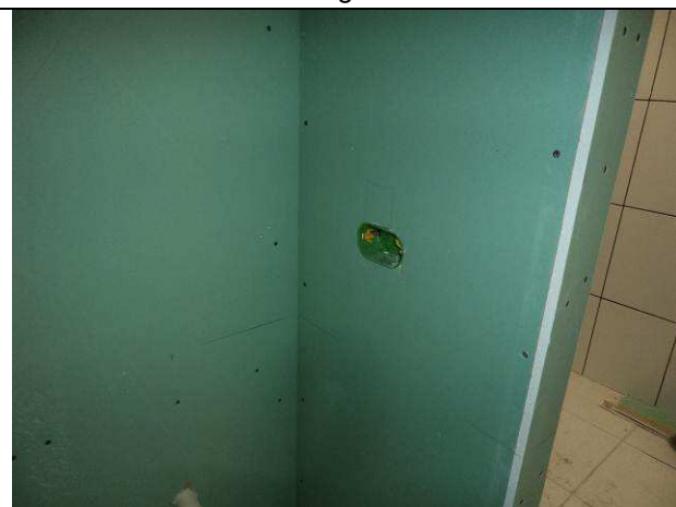
Figura 06E: infraestrutura de caixas 2X4" e eletrodutos corrugados - vestiários.
