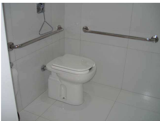
Figura 68C: Barras de apoio, em aço inox escovado, instaladas junto ao vaso sanitário do banheiro PNE.
