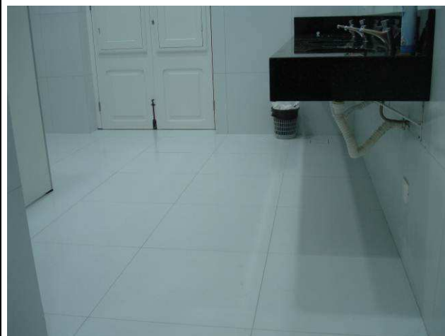
Figura 24C: Piso em porcelanato Incepa assentado no banheiro masculino.
