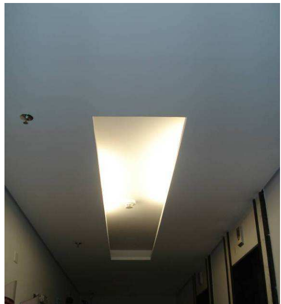
Figura 118C: Pintura executada com tinta látex acrílica, na cor branco neve, marca Luz & Cor, no teto do corredor do 8º andar. (Padrão se repetiu no 2º e do 4º ao 11º andares.
