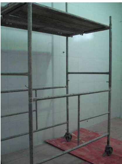
Figura 01C: Utilização de andaime metálico tipo fachadeiro.
