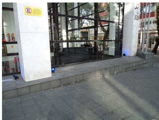
Figura 33E: luminárias externas torre - LED RGB.
