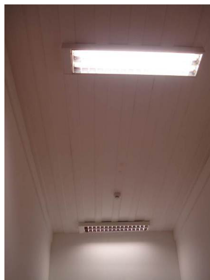
Figura 72C: Executada 1ª demão de pintura com tinta esmalte sintético acetinado, cor branco neve, marca Glasurit, no teto do corredor de acesso aos banheiros e cozinha.
