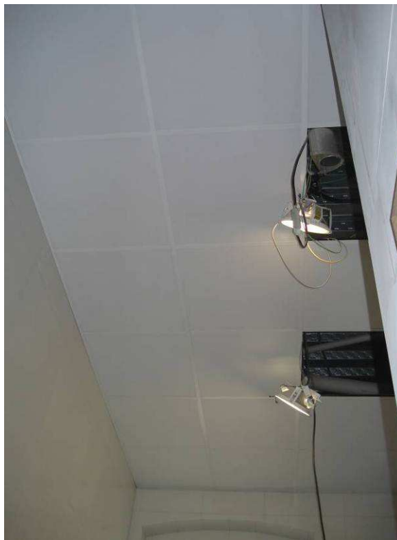
Figura 19C: Forro de gesso acartonado removível instalado na sala de apoio.
