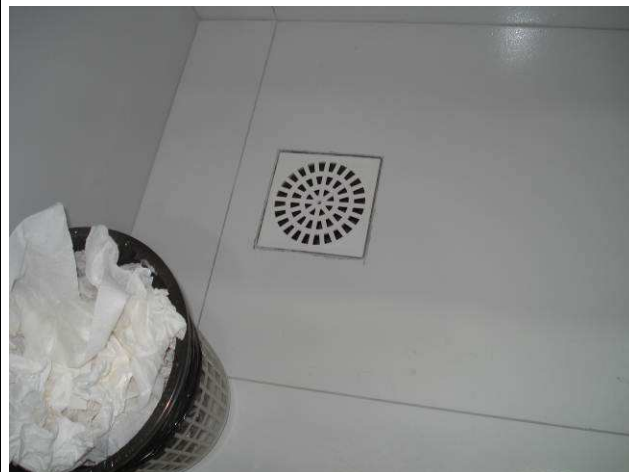
Figura 37C: Executados acabamentos e instalada grelha das caixas sifonadas (banheiro masculino).
