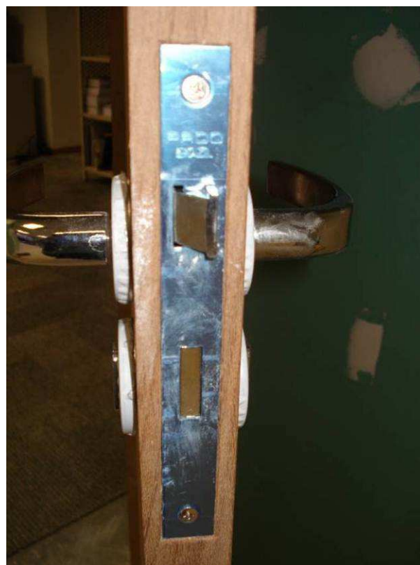
Figura 79C: Instaladas fechadura 40 mm, ZM COPA, marca Pado e maçaneta tipo alavanca.
