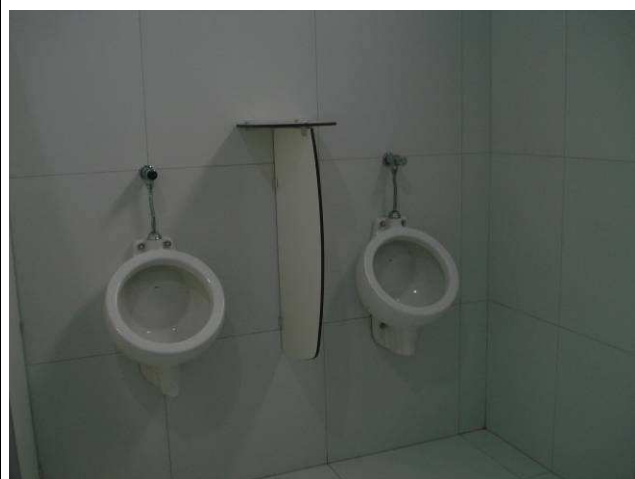
Figura 45C: Mictórios reinstalados no banheiro masculino.
