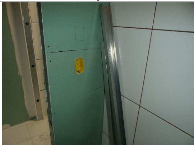
Figura 03E: infraestrutura de caixas 2X4" e eletrodutos corrugados - vestiários.
