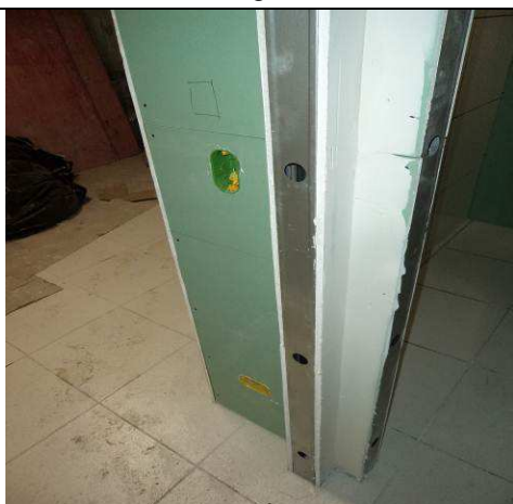
Figura 05E: infraestrutura de caixas 2X4" e eletrodutos corrugados - vestiários.
