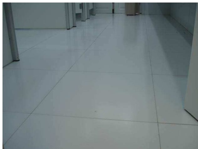
Figura 23C: Piso em porcelanato Incepa assentado no banheiro feminino.
