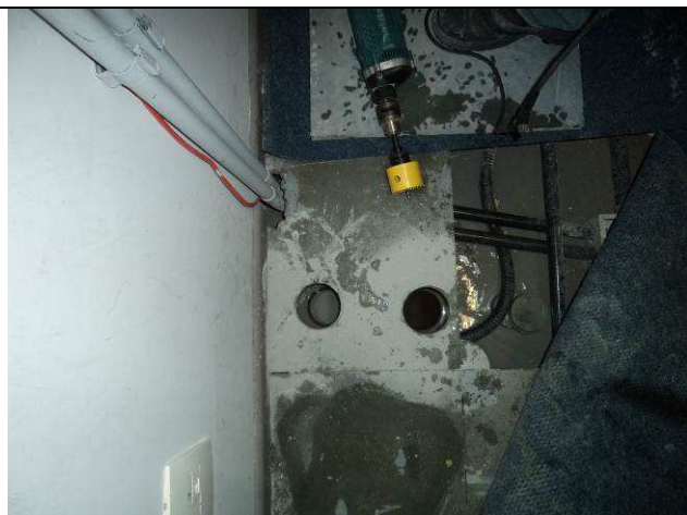
Figura 12E: infraestrutura - entrada de telecomunicações bancos.
