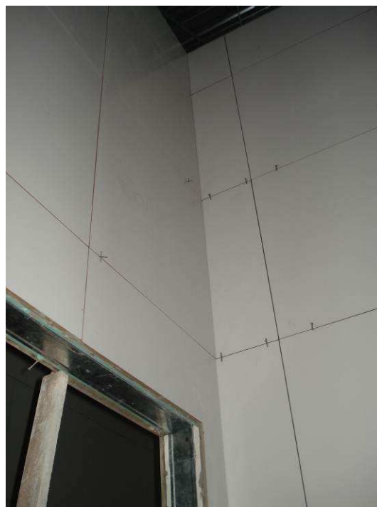
Figura 49C: Hall entre cozinha e apoio com assentamento assentado.
