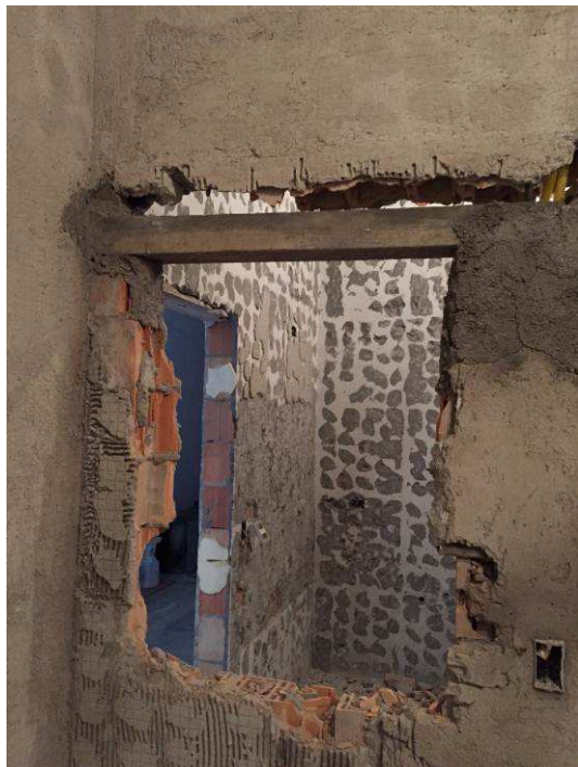
Figura 25C: Demolição de alvenaria para abertura de vão de porta (acesso cozinha).
