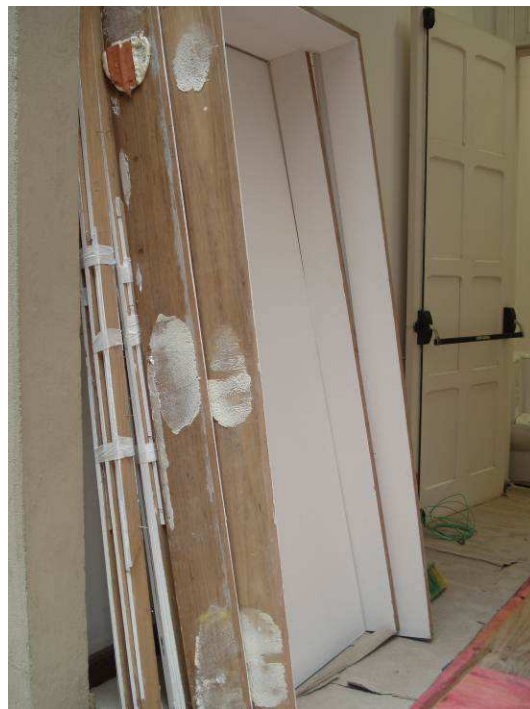
Figura 18C: Portas a serem reinstaladas.
