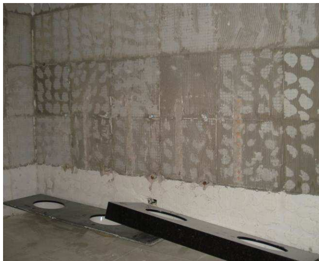
Figura 21C: Remoção do tampo em granito do banheiro masculino.
