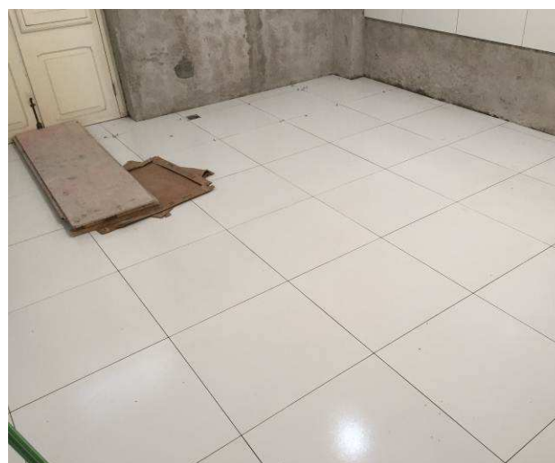
Figura 53C: Piso assentado na cozinha. Utilizados espaçadores de 1,5mm de espessura.
