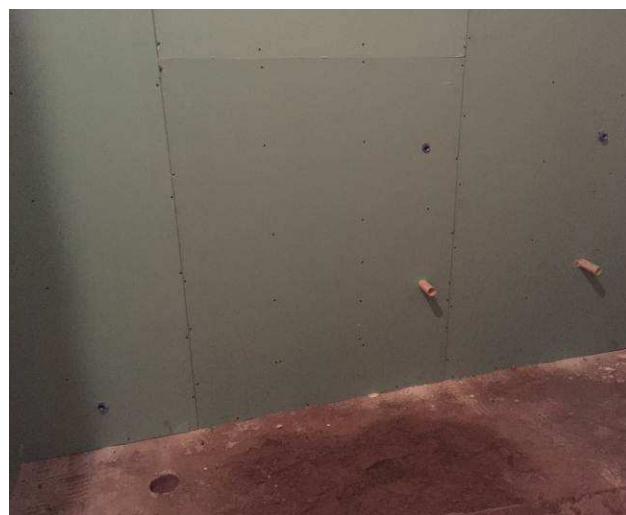
Figura 60C: Executados pontos de água fria com Ø 25 mm na e respectivos esgotos secundários (mictórios), no banheiro masculino. À esquerda ponto de água fria e esgoto primário para vaso sanitário.
