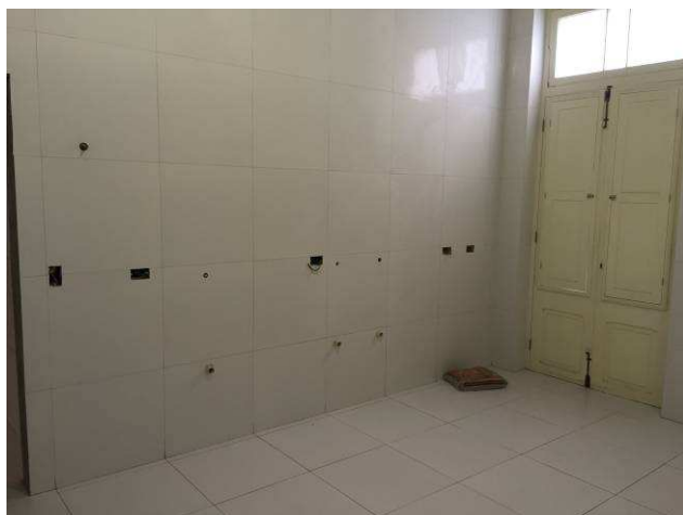
Figura 48C: Apoio com assentamento das paredes concluídas.
