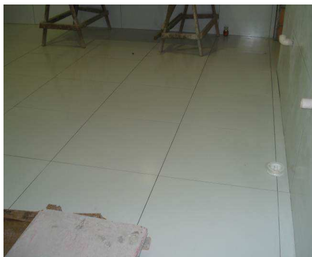
Figura 54C: Piso assentado na cozinha.
