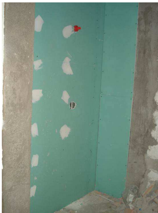
Figura 64C: Registro gaveta 1.1/2" (Docol) instalado no banheiro PNE. Pendente instalação do acabamento cromado.
