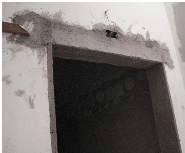
Figura 50C: Executado requadro de vãos das portas.
