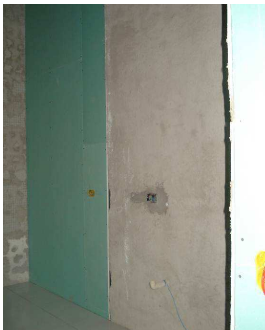
Figura 36C: Parede em gesso acartonado verde executada no corredor.
