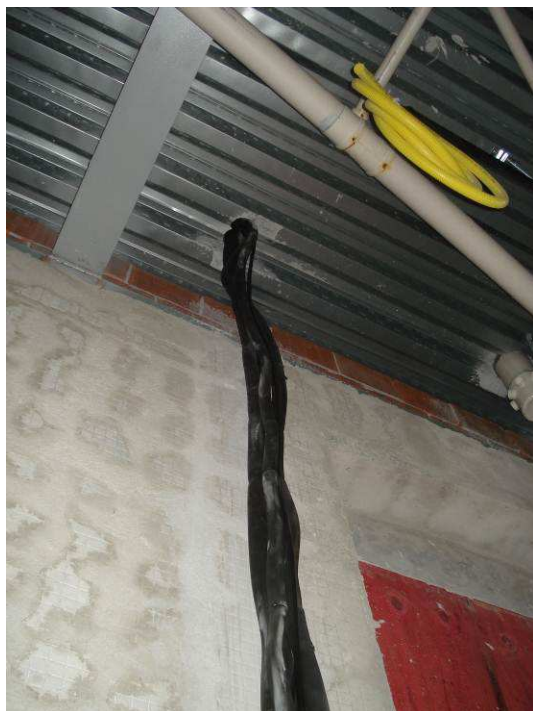
Figura 76C: Executada rede frigorígena, de ar condicionado tipo Split, em trecho a ser embutido em parede do pavimento térreo.
