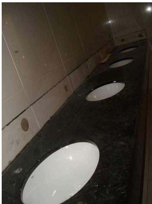
Figura 23C: Espelho removido no banheiro feminino.
