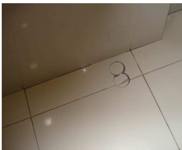
Figura 72C: Executados furos na laje da sobreloja, com \varnothing 1/4", possibilitando execução de tubulação de esgoto secundário.
