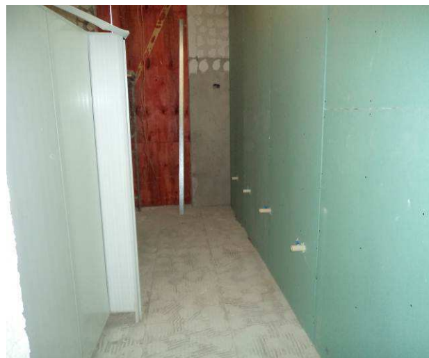
Figura 37C: Parede em gesso acartonado verde executada no banheiro feminino.
