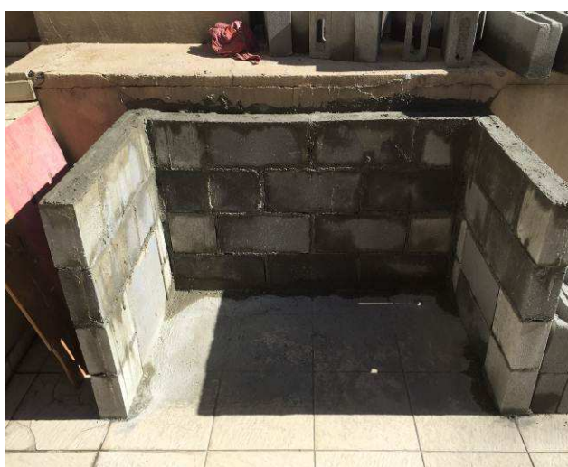
Figura 81C: Paredes do abrigo da central GLP parcialmente executadas.
