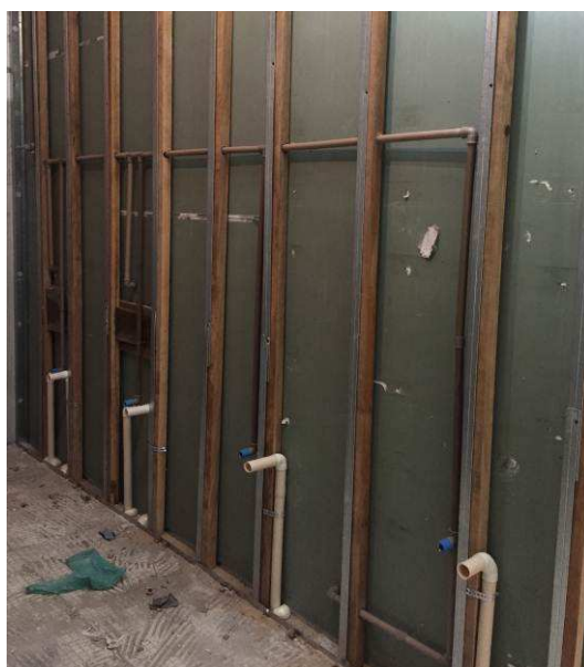
Figura 39C: Instalados montantes em madeira, para reforço da parede do banheiro feminino, onde será instalado tampo em granito.
