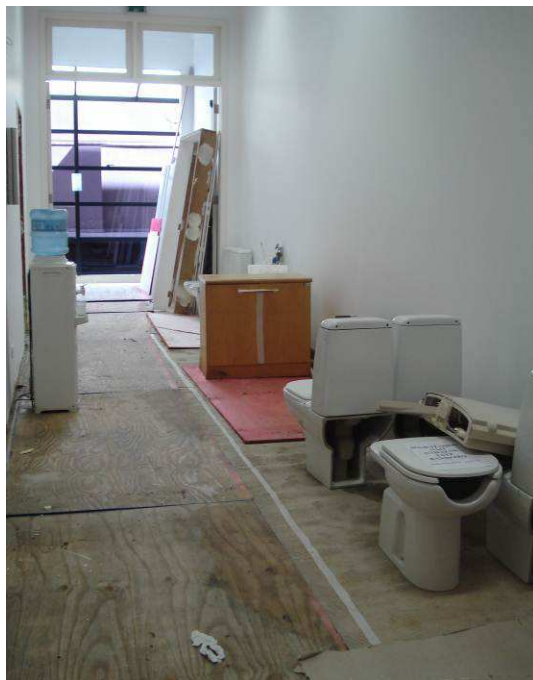
Figura 04C: Proteção do piso com utilização de madeirite e papel ondulado.
