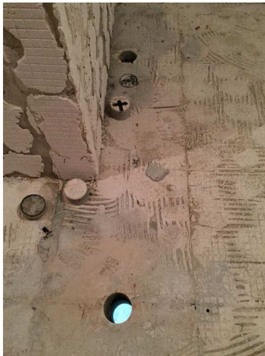
Figura 30C: Furos na laje, executados para instalação de ponto de esgoto secundário de pia e caixa de gordura, ambos da sala de apoio.
