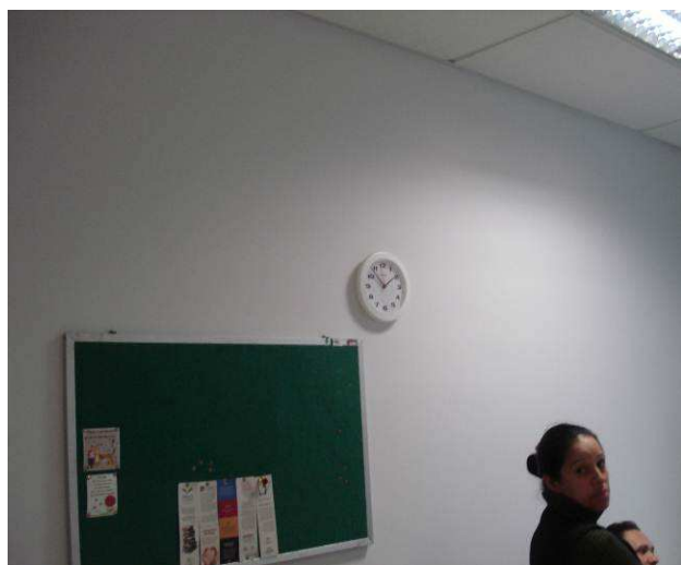
Figura 88C: Executada pintura em 3 demãos de tinta látex acrílica, marca Luz & Cor, na cor branco gelo, na copa do 2º pavimento.
