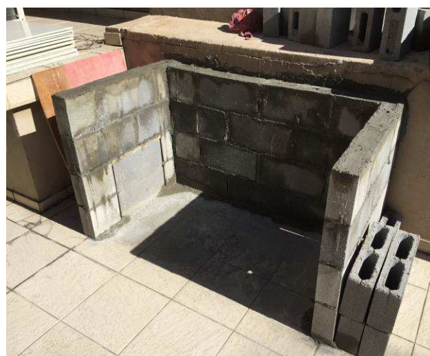
Figura 82C: Paredes do abrigo da central GLP parcialmente executadas.
