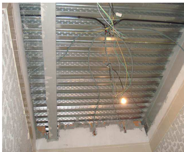
Figura 11C: Forro removido em banheiro.
