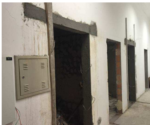
Figura 32C: Vergas executadas nos vãos das portas dos banheiros feminino e masculino.
