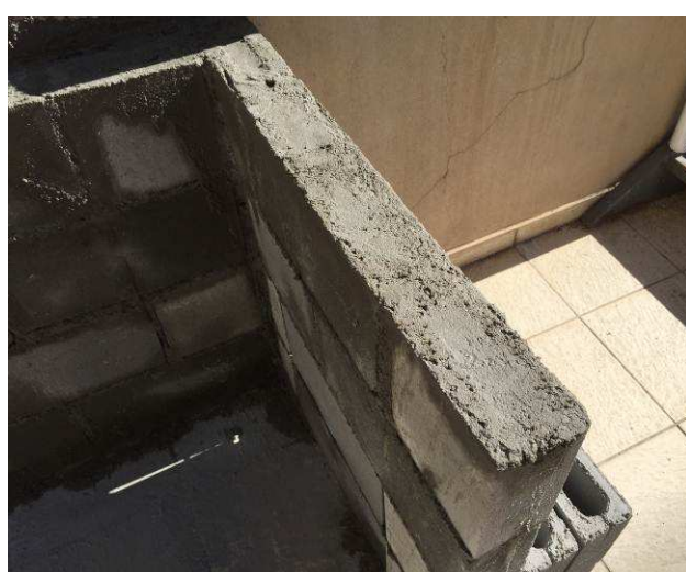
Figura 80C: Detalhe do preenchimento dos blocos de concreto.
