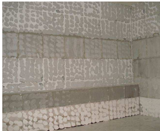
Figura 14C: Revestimento cerâmico removido em parede de banheiro.
