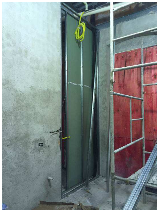
Figura 35C: Parede em gesso acartonado verde com perfis metálicos, executada na cozinha.
