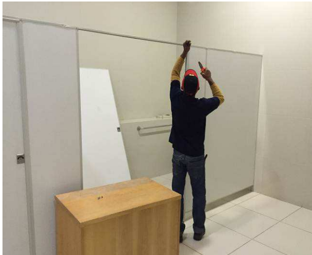
Figura 09C: Remoção de divisórias navais em banheiro
