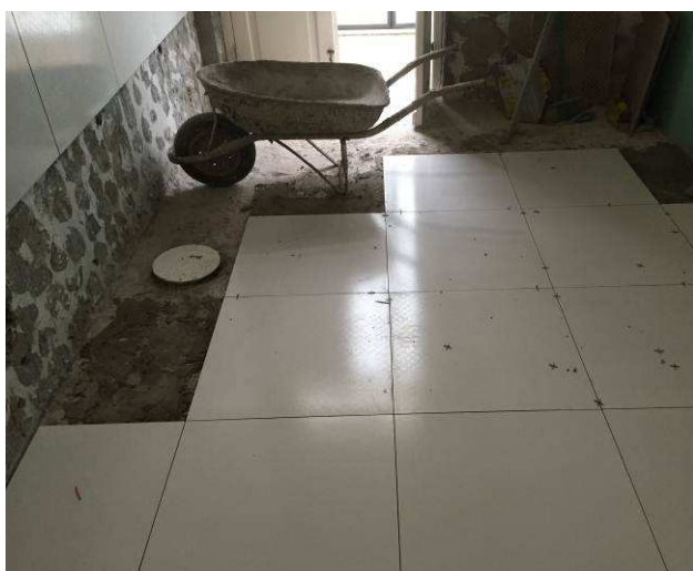
Figura 52C: Execução de regularização e assentamento de porcelanato em piso da sala de apoio.
