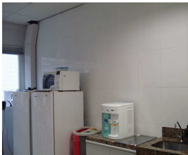
Figura 83C: Foram assentados os azulejos, marca Eliane, 33x45cm, linha Forma, cor branca, nas paredes úmidas das copas. Foto 2º andar.
