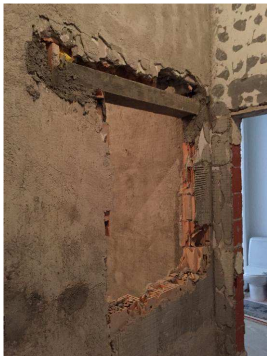
Figura 33C: Verga executada no vão da porta da cozinha.
