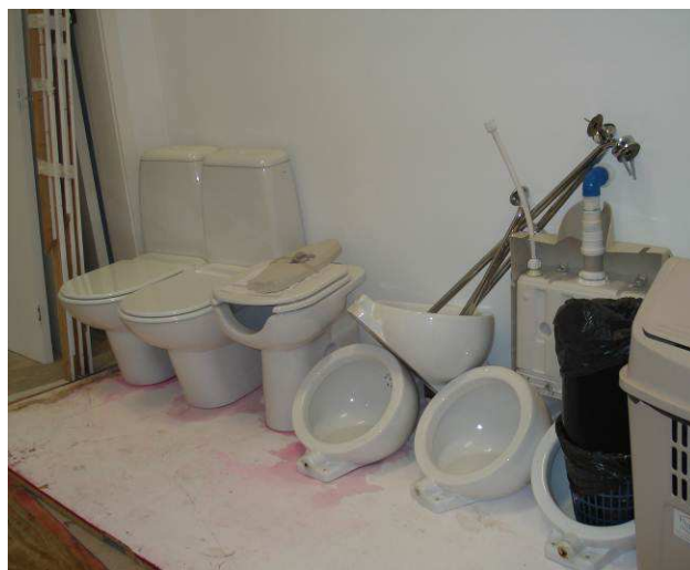
Figura 20C: Armazenamento de louças para posterior reinstalação.
