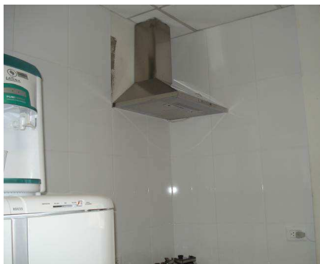
Figura 85C: Foram assentados os azulejos, marca Eliane, 33x45cm, linha Forma, cor branca, nas paredes úmidas das copas. Foto 12º andar.
