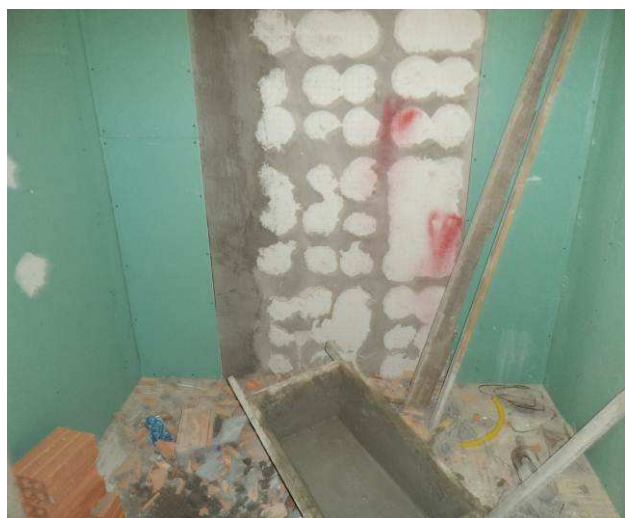
Figura 38C: Parede em gesso acartonado verde executada no banheiro PNE.
