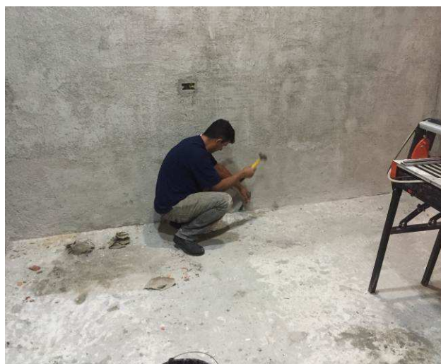
Figura 07C: Remoção de revestimento.
