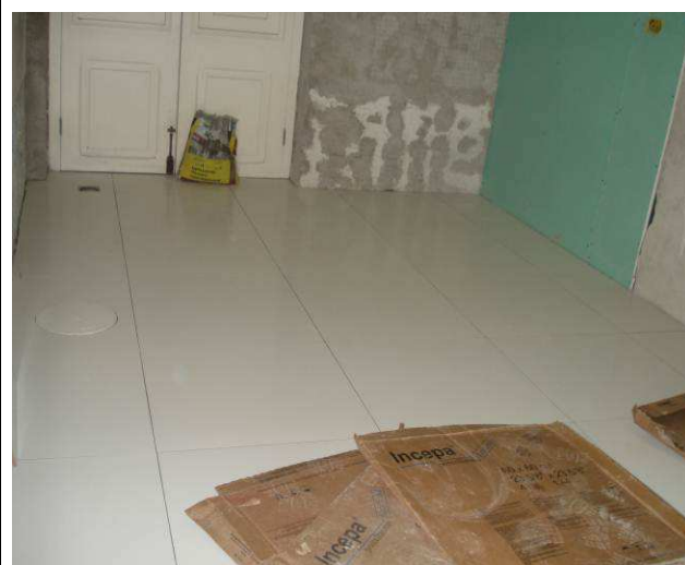
Figura 57C: Piso da sala de apoio assentado.
