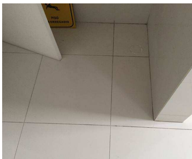
Figura 73C: Executados furos na laje da sobreloja, com \varnothing 1 1/2", possibilitando execução de tubulação de esgoto primário e de caixas sifonadas.
