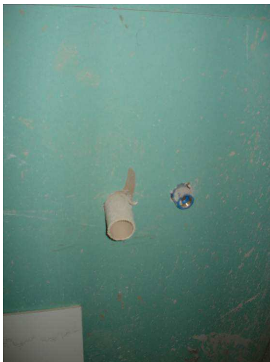
Figura 63C: Executado ponto de água fria com Ø 25 mm e respectivo esgotos secundário (lavatório), no banheiro PNE.
