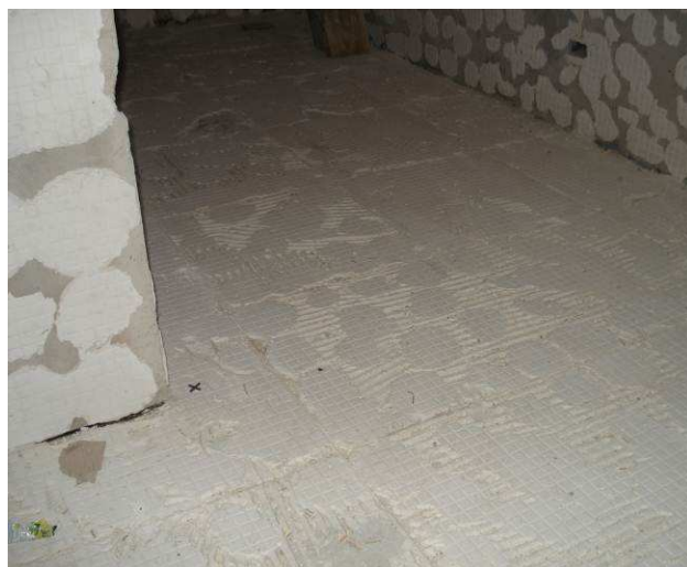
Figura 08C: Remoção de revestimento.
