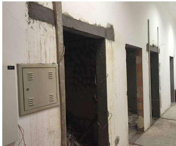
Figura 26C: Demolição de alvenaria para abertura das portas dos banheiros feminino e masculino.
