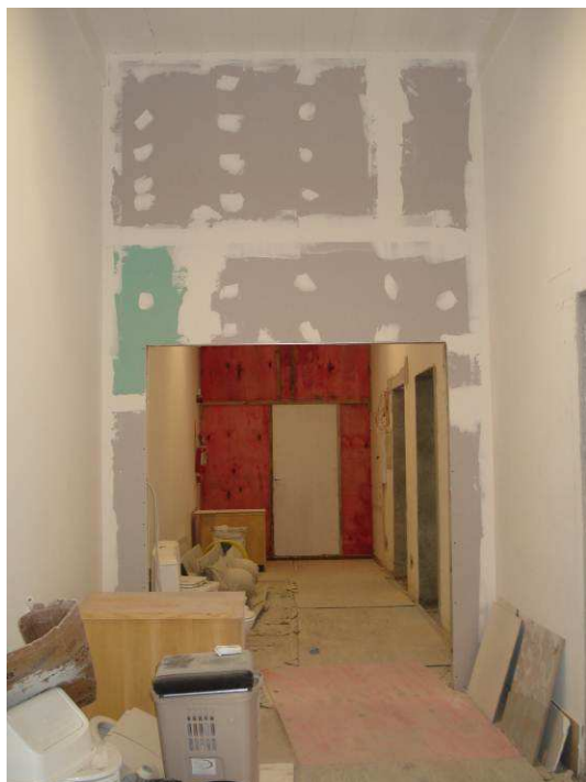
Figura 34C: Parede em gesso acartonado simples executada no corredor.
