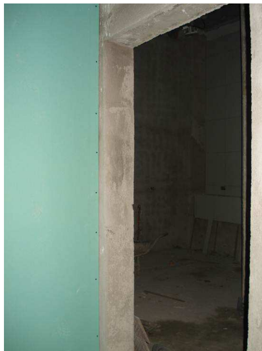
Figura 51C: Executado requadro de vãos das portas.
