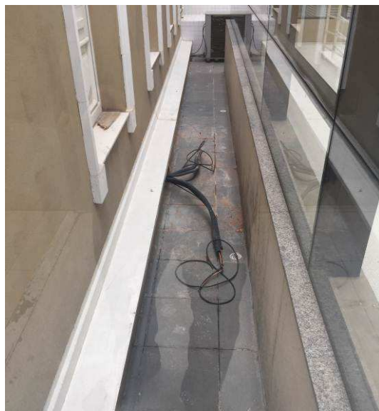
Figura 78C: Saída da rede frigorígena junto ao local onde será instalada a unidade condensadora.
