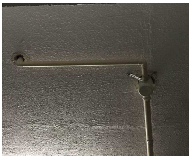
Figura 68C: Caixa sifonada PVC 100X100X50mm instalada no banheiro PNE.
