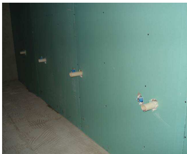
Figura 59C: Executados pontos de água fria com Ø 25 mm e respectivos esgotos secundários, no banheiro feminino.
