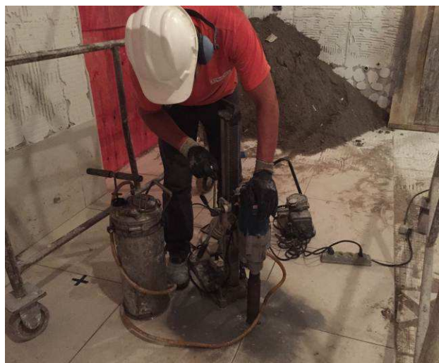
Figura 27C: Executados furos na laje, com utilização perfuratriz.
