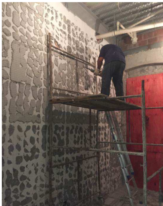
Figura 02C: Utilização de andaime metálico tipo fachadeiro.
