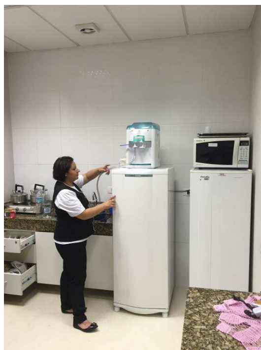
Figura 86C: Foram assentados os azulejos, marca Eliane, 33x45cm, linha Forma, cor branca, nas paredes úmidas das copas. Foto 4º andar.
