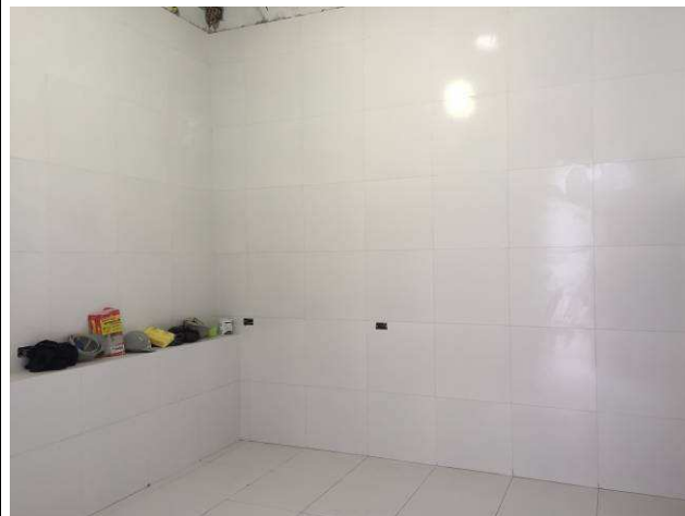
Figura 47C: Cozinha com assentamento das paredes concluídas.
