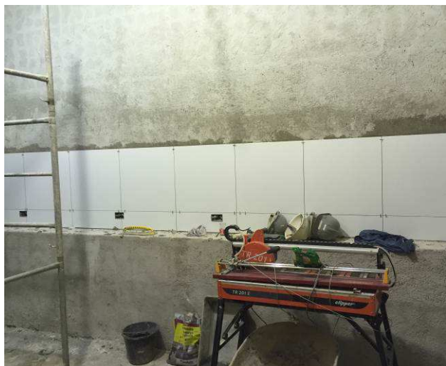
Figura 42C: Assentamento de porcelanato em parede da cozinha.
