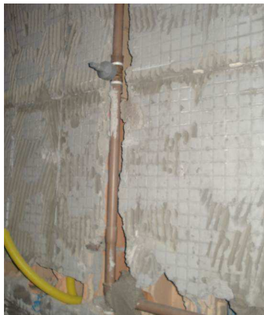
Figura 66C: Registro gaveta 3/4" (Deca) instalado no banheiro masculino. Pendente instalação do acabamento cromado.
