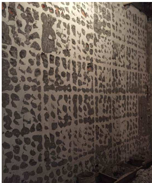
Figura 13C: Revestimento cerâmico removido em parede de banheiro.
