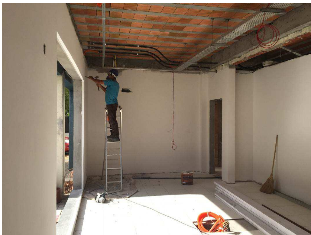
Figura 2 – Vista interna - área da ampliação.
