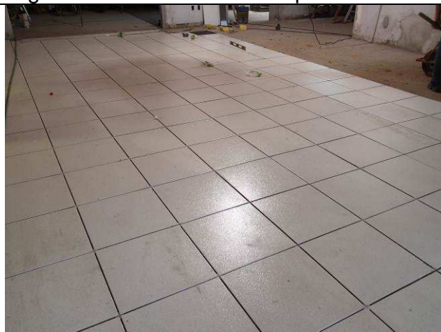
Figura 60C: Assentamento - piso cerâmico.
