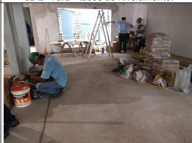
Figura 54C: Piso regularizado na área da 2ª Vara.
