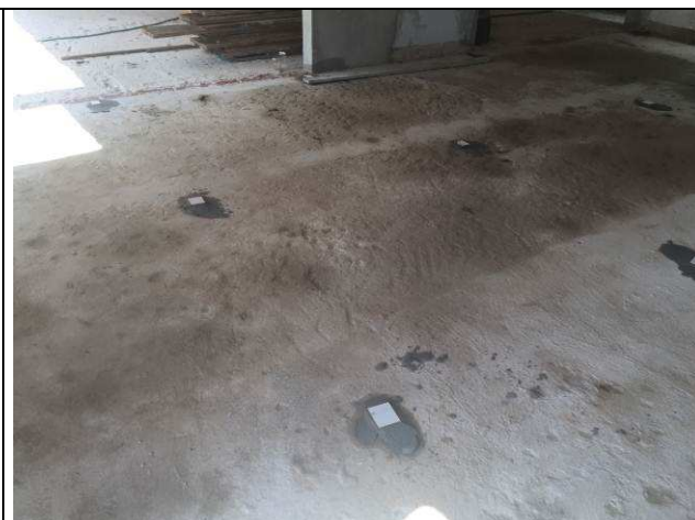
Figura 52C: Regularização de piso na área da 2ª Vara - tacos de nivelamento.
