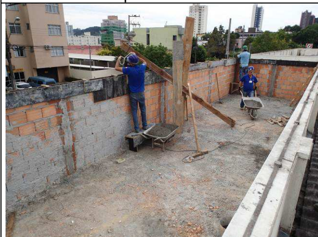
Figura 41C: Paredes de alvenaria da platibanda.
