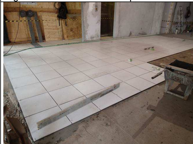
Figura 59C: Assentamento - piso cerâmico.
