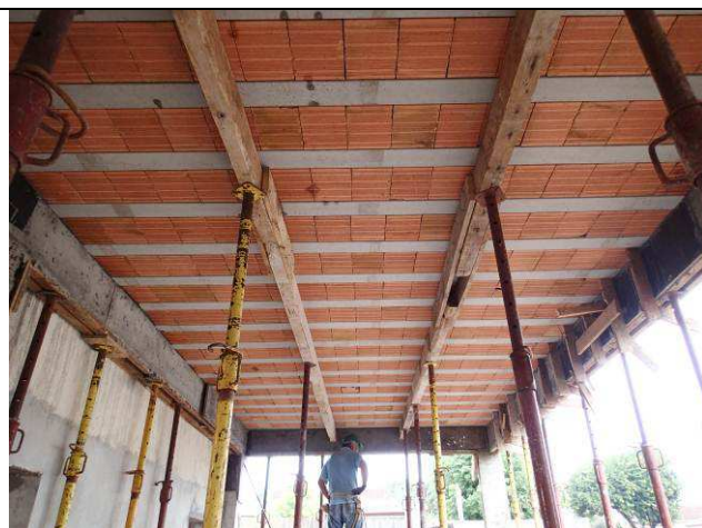
Figura 33C: Pilares, vigas e laje de cobertura.
