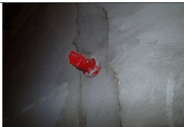
Figura 62C: Registro de gaveta - \phi 3/4\".
