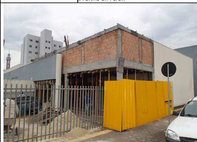
Figura 38C: Vista externa da estrutura de concreto armado.
