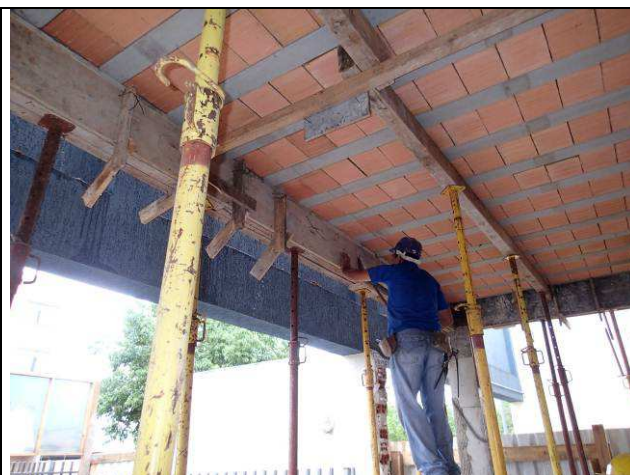
Figura 34C: Desforma das vigas de cobertura.
