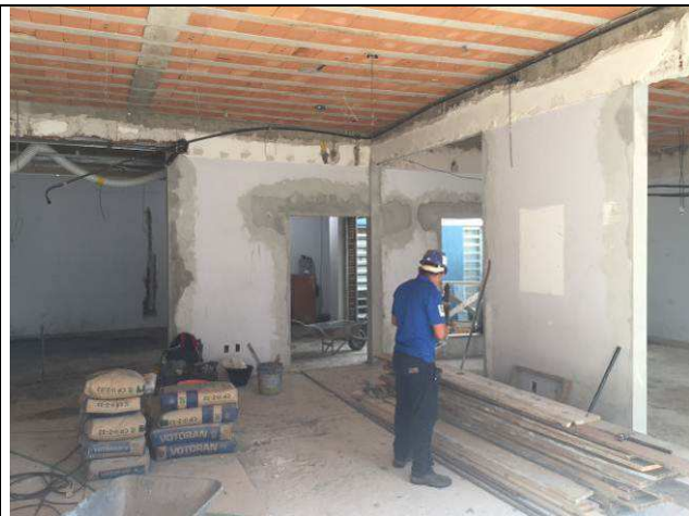
Figura 10C: Demolições internas.
