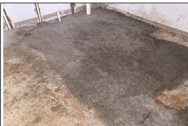
Figura 47C: Enchimento de rasgo em concreto para passagem de tubulações.
