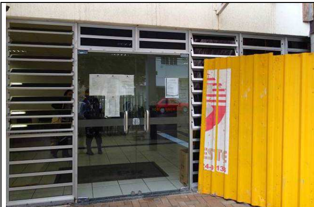
Figura 45C: Porta PV1E relocada - externa.
