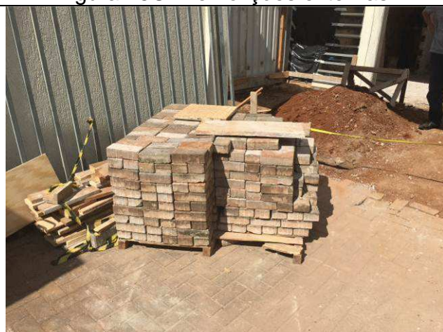
Figura 17C: Remoção de paver.
