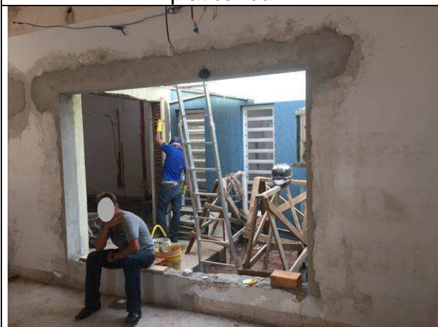
Figura 43C: Vergas de concreto armado.
