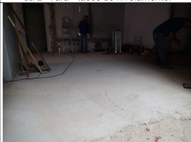
Figura 53C: Regularização de piso na área da 2ª Vara.
