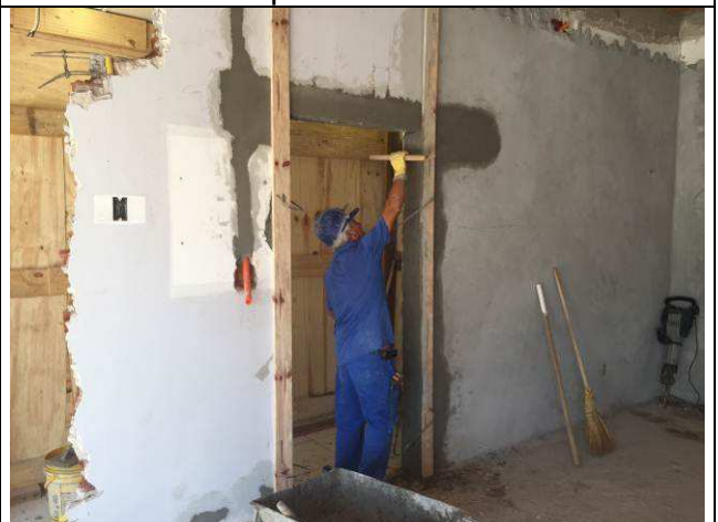
Figura 42C: Vergas de concreto armado.
