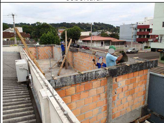
Figura 36C: Concretagem da cinta da platibanda.
