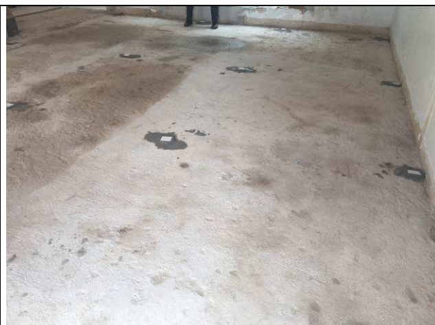
Figura 51C: Regularização de piso na área da 2ª Vara - tacos de nivelamento.
