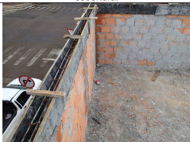
Figura 35C: Armação da cinta da platibanda.
