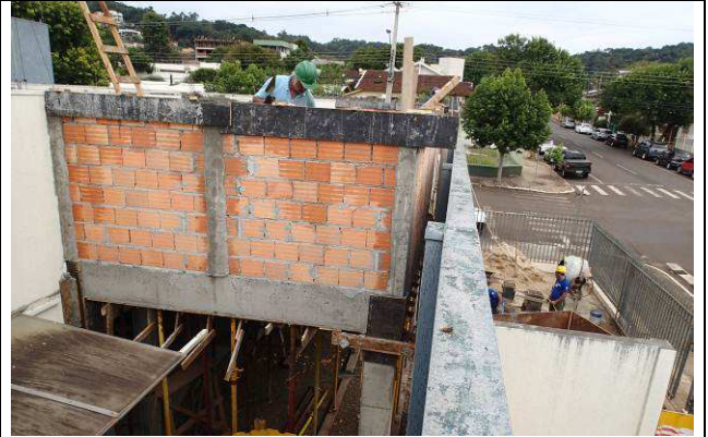
Figura 40C: Paredes de alvenaria da platibanda.
