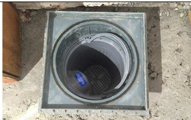
Figura 69C: Caixa de gordura com cesto.
