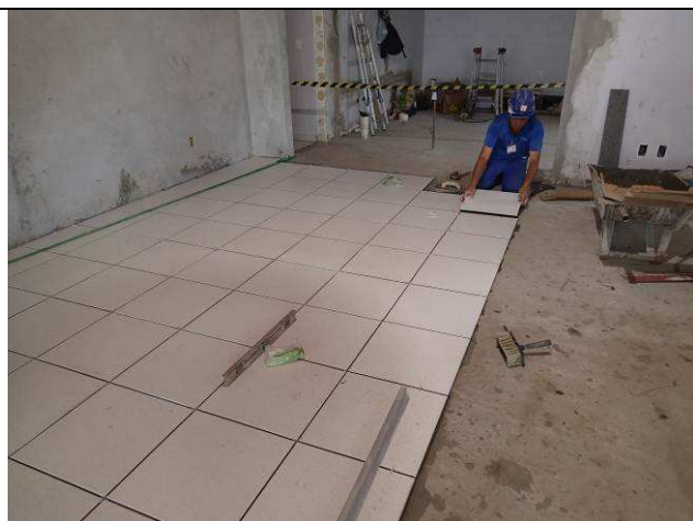
Figura 58C: Assentamento - piso cerâmico.
