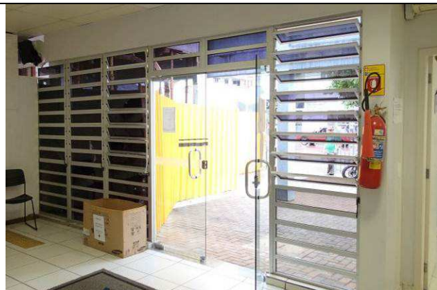
Figura 46C: Porta PV1E relocada - interna.
