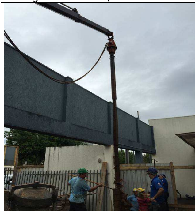
Figura 23C: Execução das brocas.
