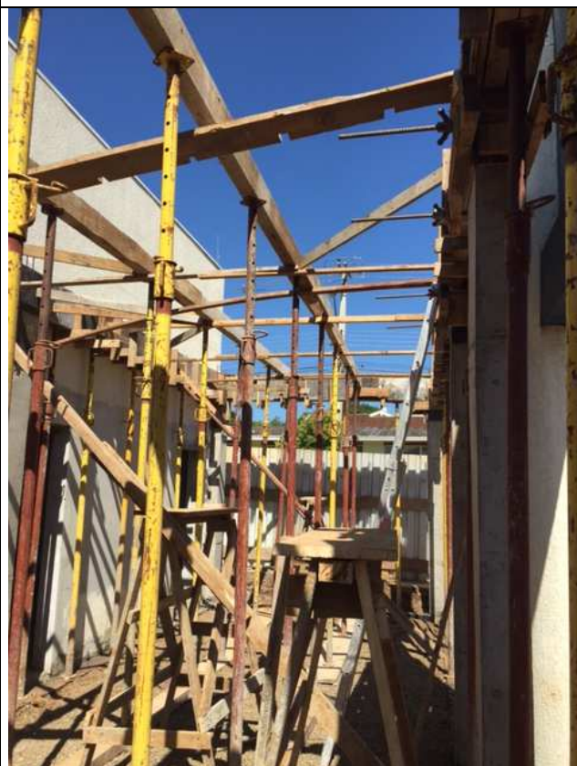
Figura 28C: Pilares e formas / escoramento das vigas e laje de cobertura.
