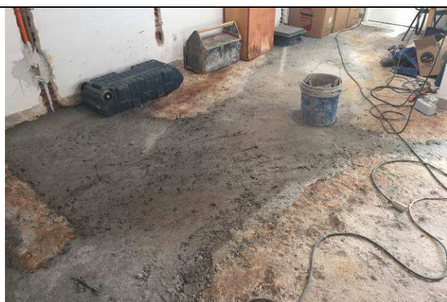
Figura 48C: Enchimento de rasgo em concreto para passagem de tubulações.
