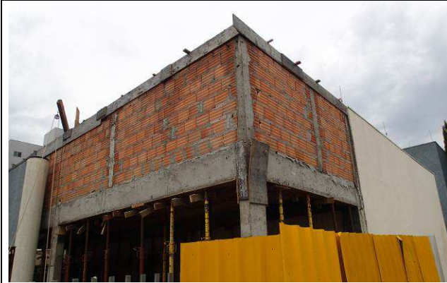
Figura 39C: Paredes de alvenaria da platibanda.
