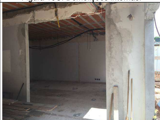
Figura 12C: Demolições internas.
