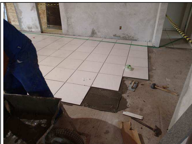
Figura 57C: Assentamento - piso cerâmico.
