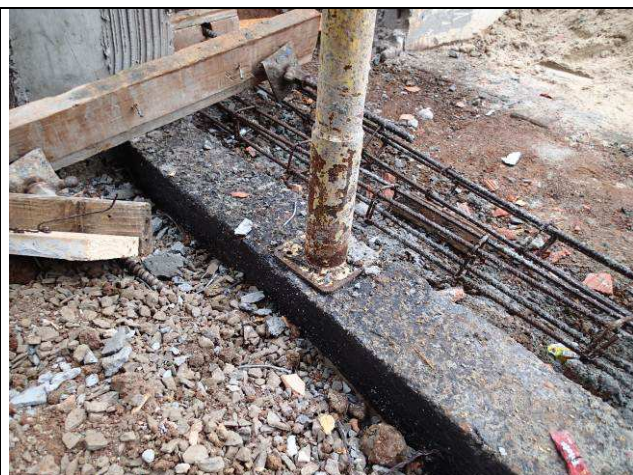
Figura 26C: Vigas baldrame impermeabilizadas.
