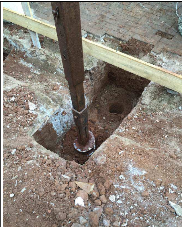
Figura 22C: Execução das brocas.
