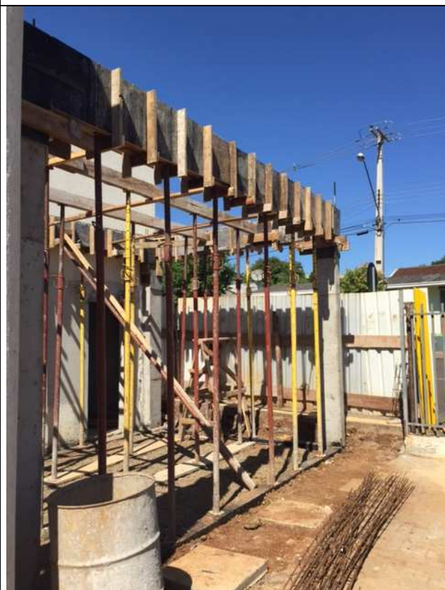
Figura 27C: Pilares e formas / escoramento das vigas e laje de cobertura.
