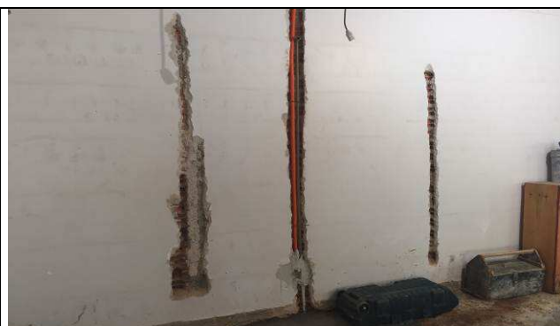
Figura 62C: Ponto de dreno.
