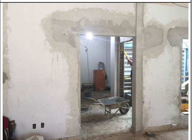
Figura 44C: Vergas de concreto armado.
