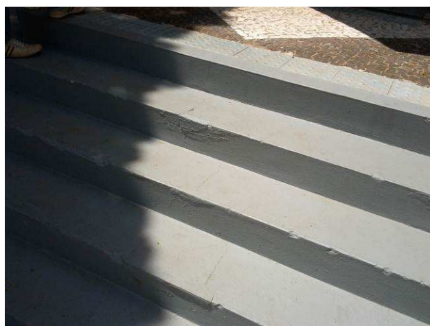
Figura 22C: Detalhe da pintura da escada frontal
