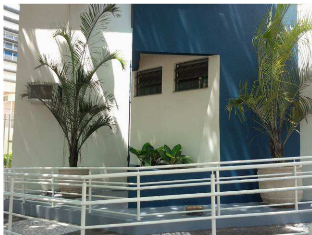
Figura 08C: Visão lateral - pintura do corrimão e guarda-corpo da rampa
