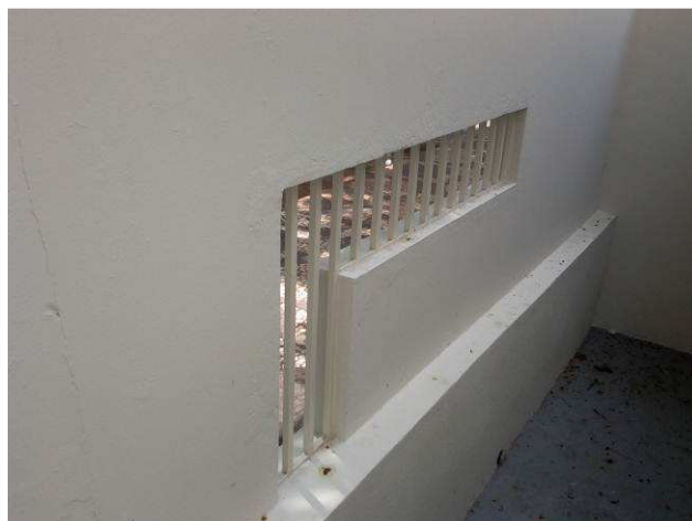
Figura 10C: Pintura do gradil de visão das entradas de energia
