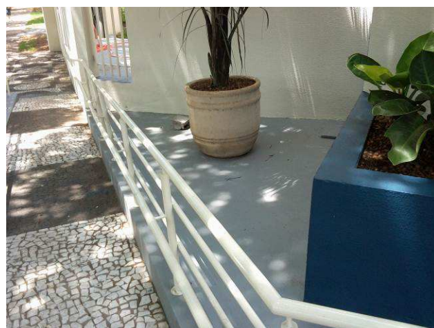
Figura 06C: Detalhe da pintura do corrimão e guarda-corpo da rampa
