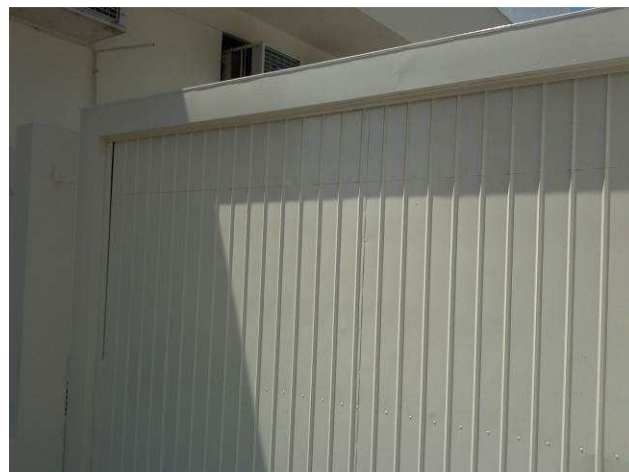
Figura 14C: Portão do estacionamento
