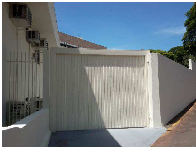
Figura 13C: Detalhe de gradil e portão do estacionamento.
