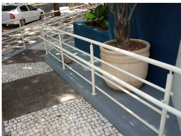
Figura 05C: Pintura do corrimão e guarda-corpo da rampa
