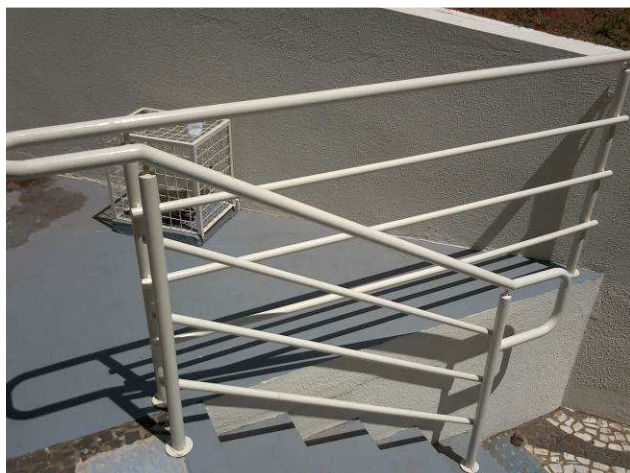
Figura 07C: Pintura do corrimão e guarda-corpo da escada frontal
