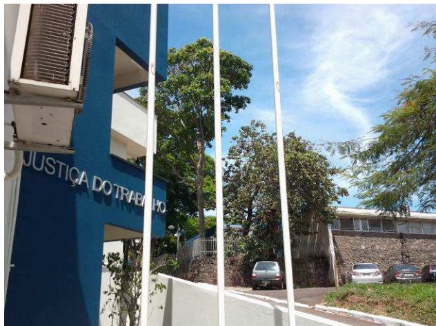
Figura 15C: Pintura dos mastros das bandeiras
