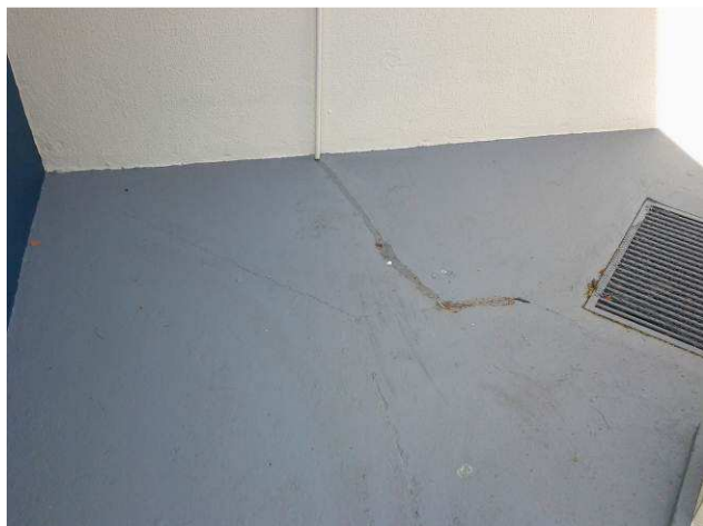
Figura 17C: Piso pintado, nos fundos da distribuição
