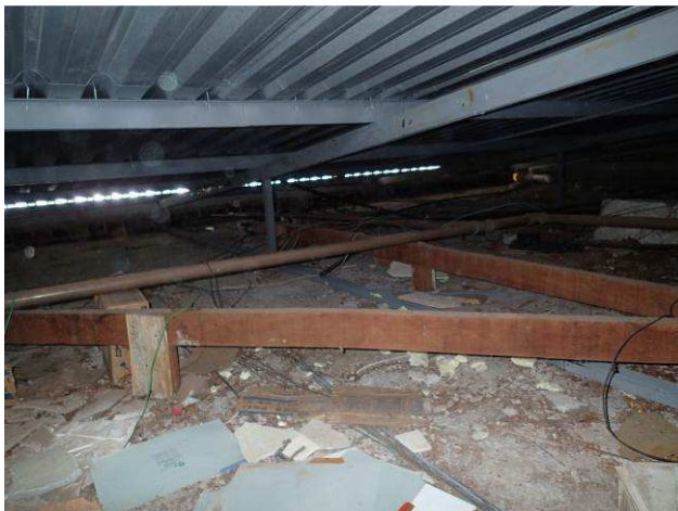
Figura 01C: Estrutura metálica de cobertura
