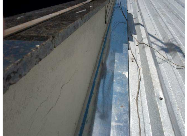
Figura 14C: Contrarrufo instalado
