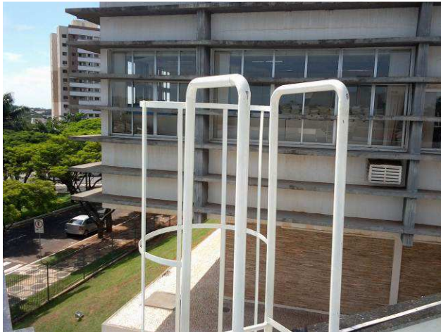
Figura 17C: Escada marinheiro chegando na cobertura
