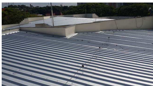
Figura 07E: Detalhe das cordoalhas
