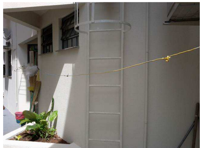
Figura 20C: Início da escada marinheiro
