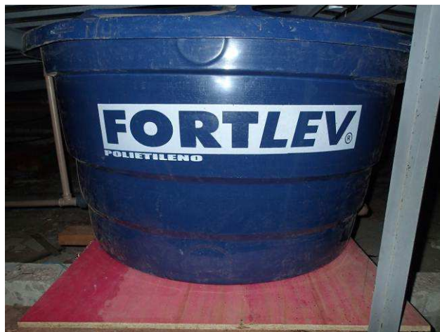
Figura 22C: Detalhe do reservatório
