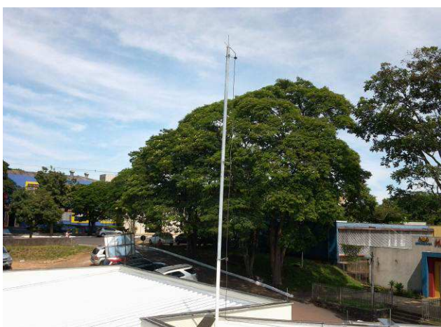
Figura 01E: Sistema Franklin reinstalado na fachada frontal
