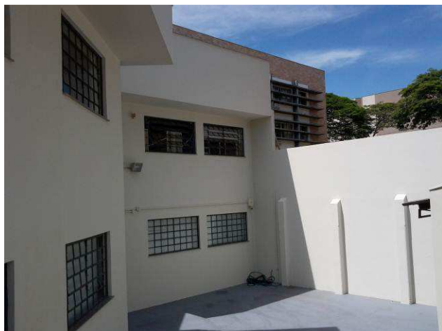
Figura 27C: Pintura de paredes externas
