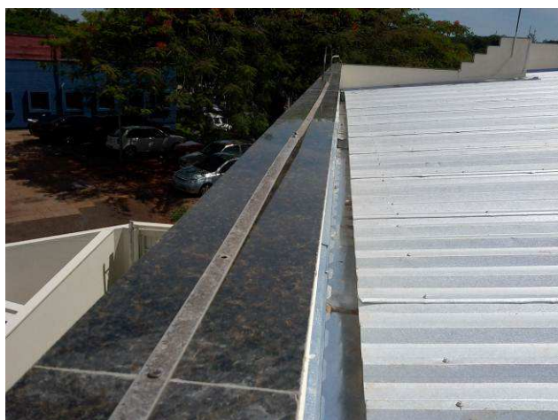
Figura 07C: Capeamento das platibandas
