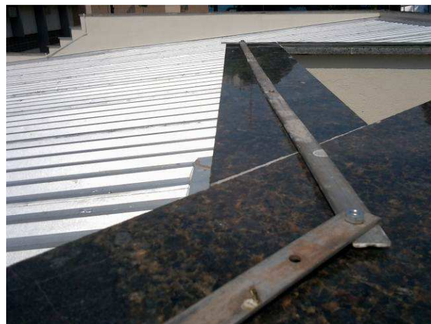
Figura 04E: Detalhe de barra chata reinstalada sobre a platibanda
