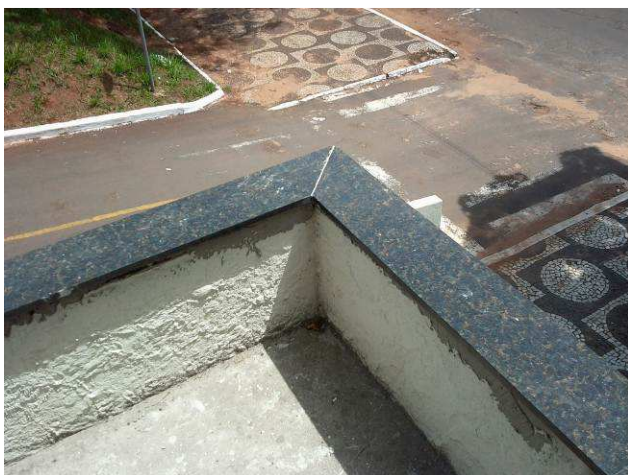
Figura 11C: Peitoril de uma das floreiras, em detalhe
