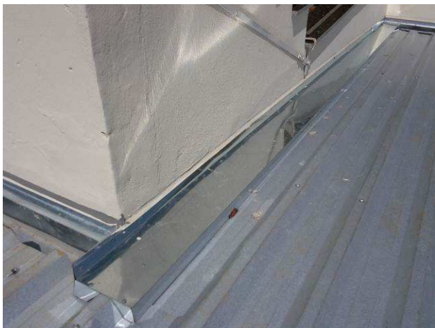
Figura 15C: Detalhe de contrarrufo
