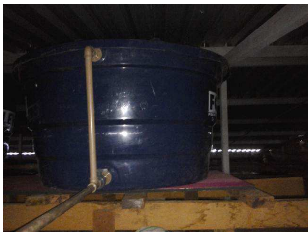
Figura 24C: Acoplamento da drenagem de limpeza e extravasor
