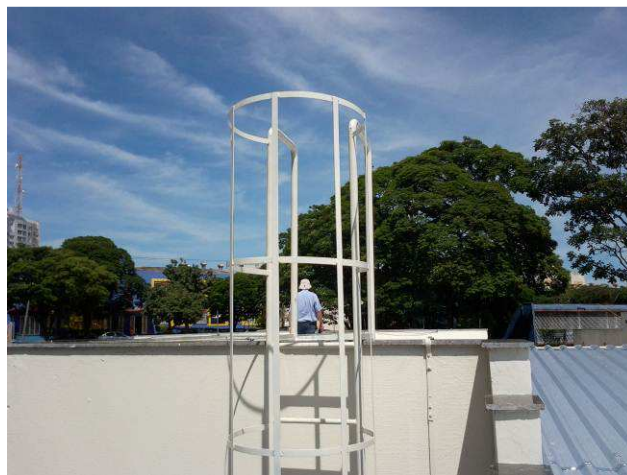
Figura 32C: Pintura da escada marinho
