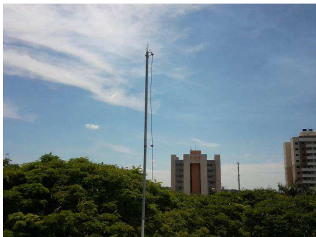
Figura 03E: Sistema Franklin reinstalado na fachada posterior
