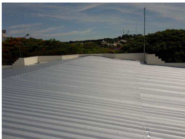
Figura 05C: Cobertura em telha sanduíche
