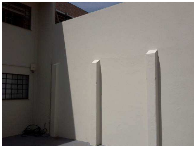
Figura 26C: Pintura do muro de arrimo
