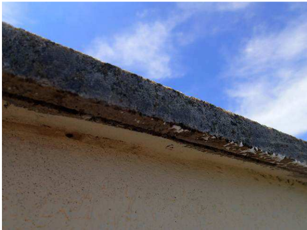
Figura 09C: Detalhe das pingadeiras nas pedras de capeamento das platibandas
