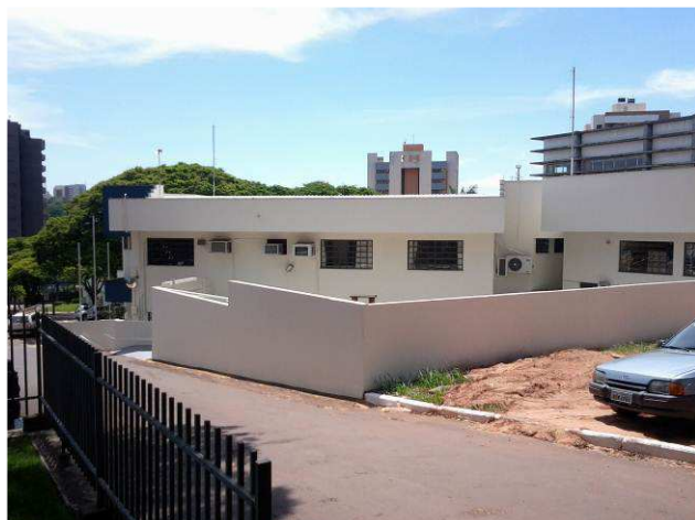
Figura 29C: Muros externos e paredes
