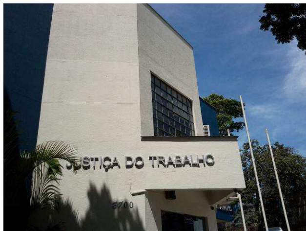
Figura 28C: Pintura de paredes externas
