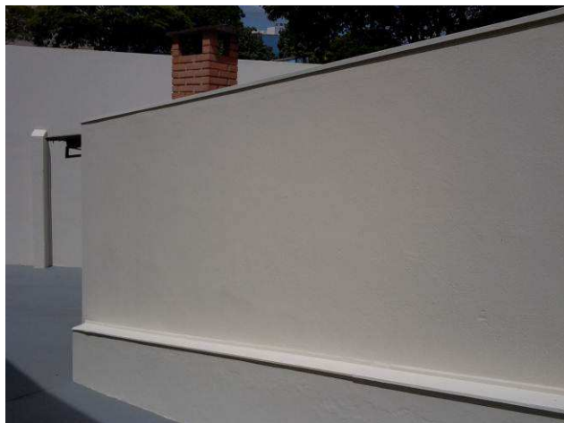
Figura 25C: Pintura de muros internos
