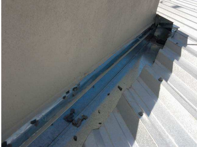
Figura 13C: Calha instalada junto à fachada frontal
