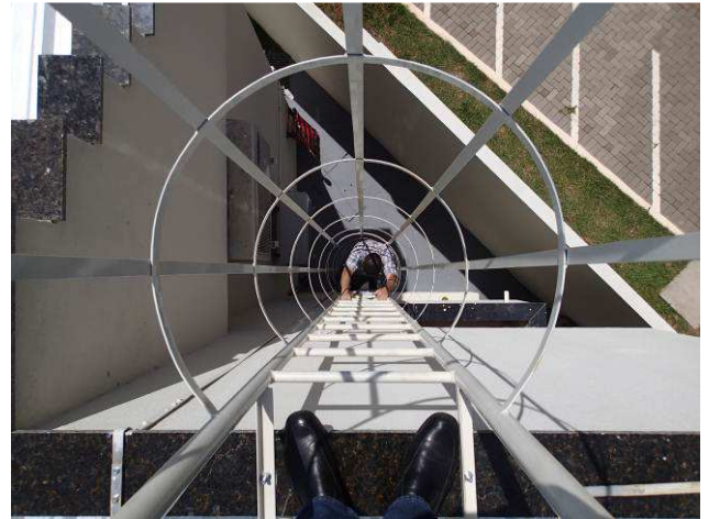
Figura 18C: Escada vista por dentro
