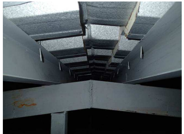
Figura 02C: Detalhe da fixação das telhas nas terças
