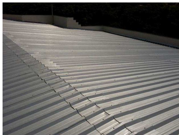
Figura 06C: Detalhe da fixação das goivas
