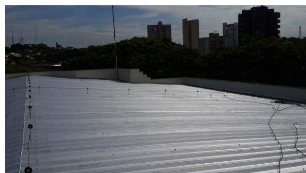
Figura 08E: Cordoalhas instaladas sobre a cobertura
