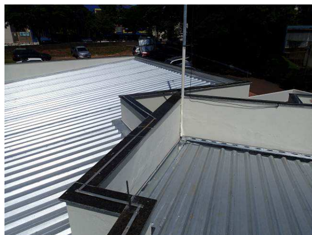
Figura 08C: Capeamento das platibandas
