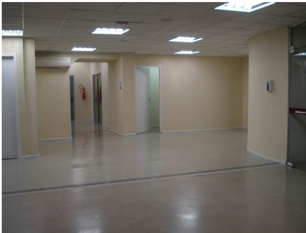
Figura 01 - Hall de espera entre 5ª Vara do Trabalho.
