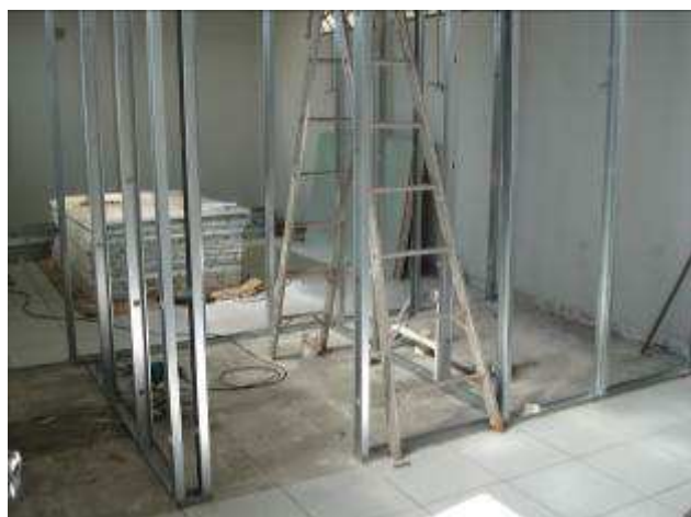
Figura 35C: estrutura metálica da parede de gesso acartonado dos banheiros privativos.
