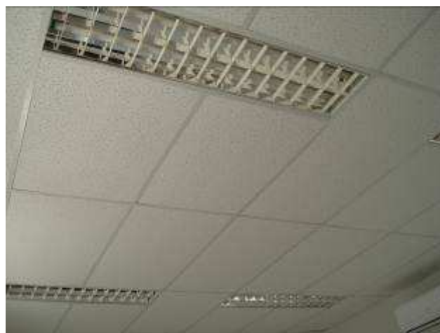
Figura 52C: substituição do forro nos locais afetados pela obra.
