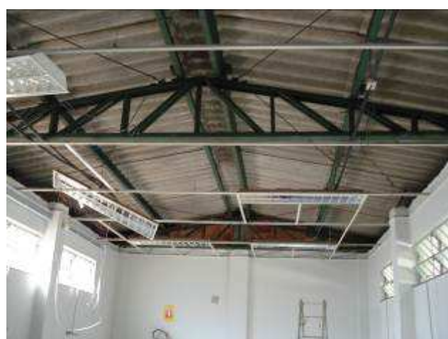
Figura 51C: substituição do forro nos locais afetados pela obra.
