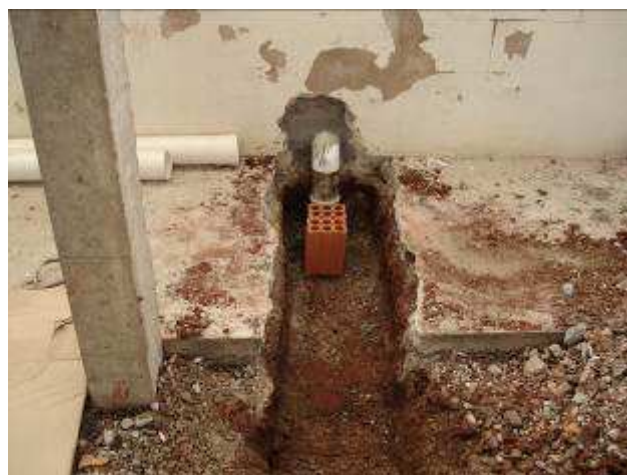
Figura 30C: valeta para interligação dos pontos de esgoto à fossa/sumidouro.
