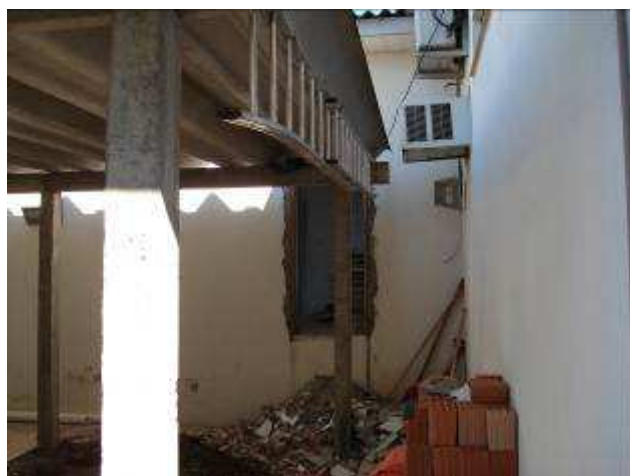
Figura 17C: instalação da porta de acesso através do estacionamento – Gabinete 01 e Assistência.
