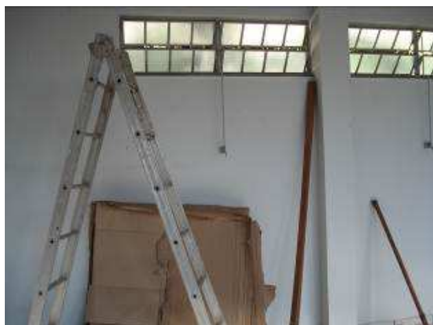
Figura 19C: remoção das janelas existentes e instalação de janelas novas – Gabinete 01.
