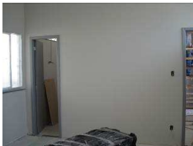
Figura 56C: pintura paredes internas – parede do Gabinete 01 pintada.
