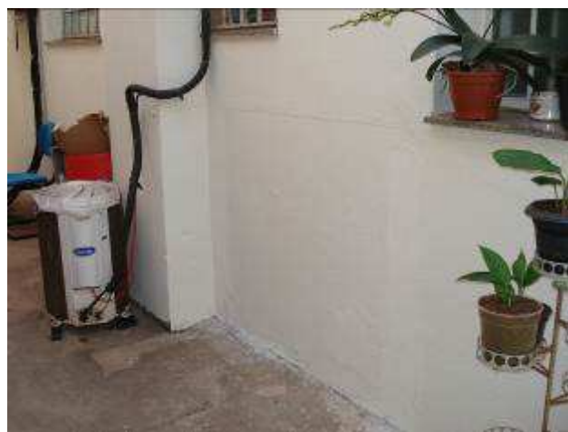
Figura 04C: após a demolição do abrigo do botijão de gás – pintura e acabamento.
