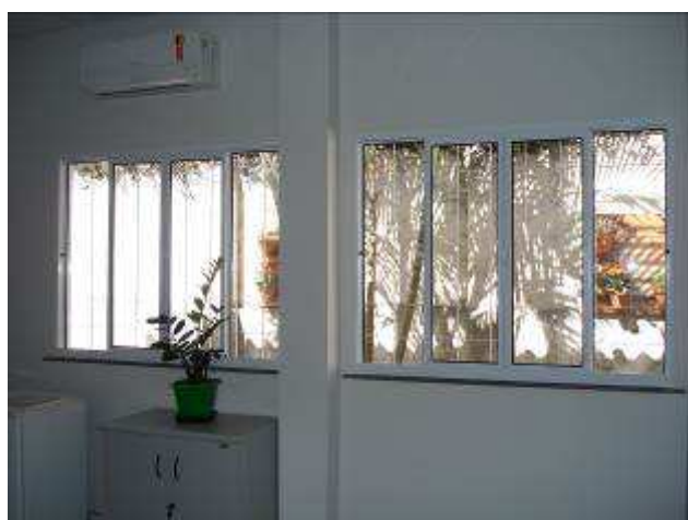
Figura 23C: remoção das janelas existentes e instalação de janelas novas – Gabinete 01.
