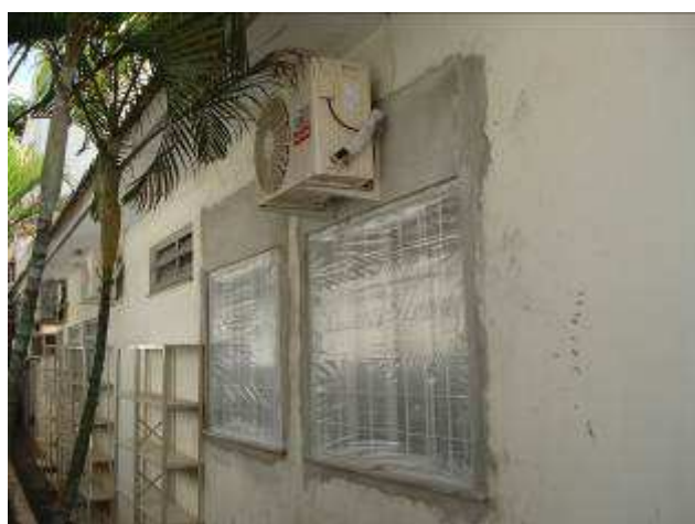
Figura 63C: instalação de ar condicionado – Gabinete 01.
