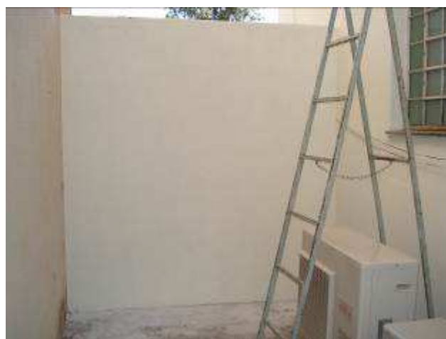
Figura 54C: pintura paredes externas – muro fundos da edificação pintado.
