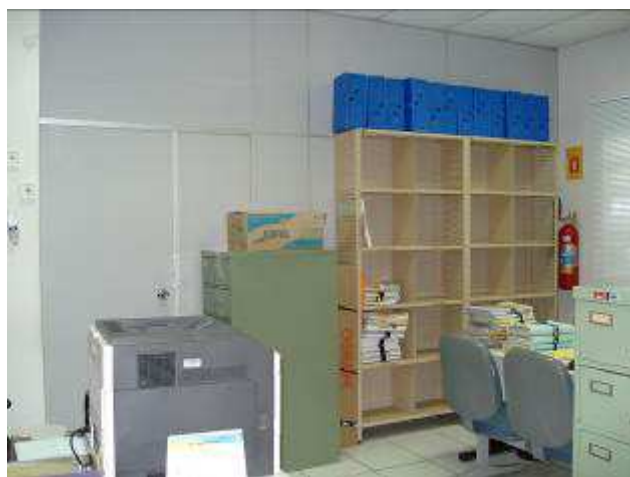
Figura 13C: substituição de parede de divisória naval – Gabinete 01 e Assistência.
