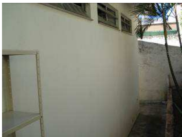
Figura 21C: remoção das janelas existentes e instalação de janelas novas – Gabinete 01.
