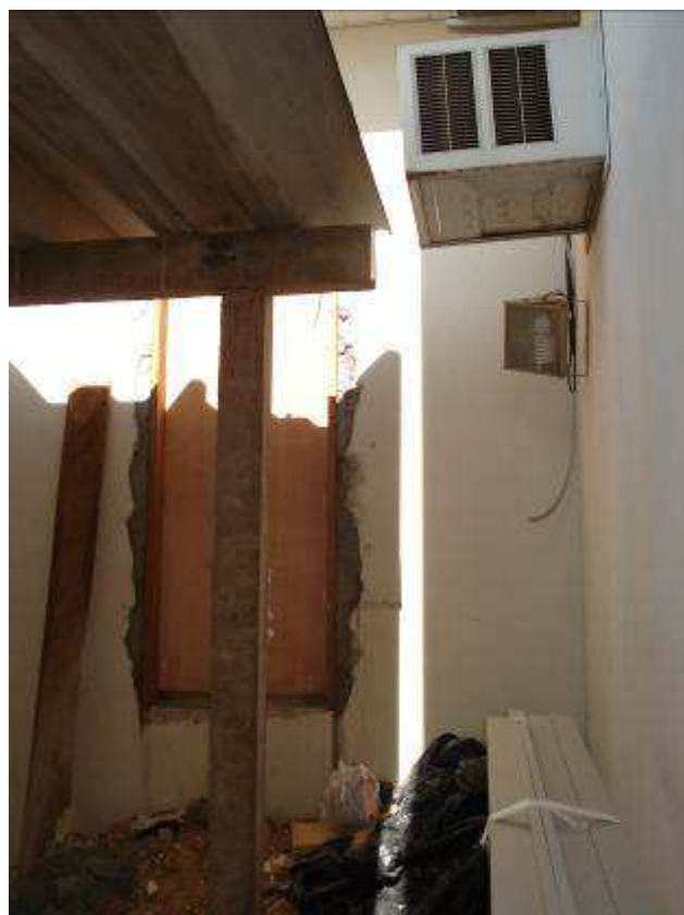
Figura 16C: instalação da porta de acesso através do estacionamento – Gabinete 01 e Assistência.
