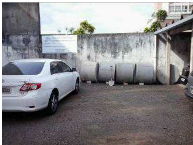
Figura 31C: anéis de concreto para instalação do sumidouro.
