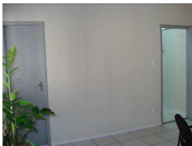
Figura 26C: construção de parede em gesso acartonado e instalação de portas – Gabinete 01.
