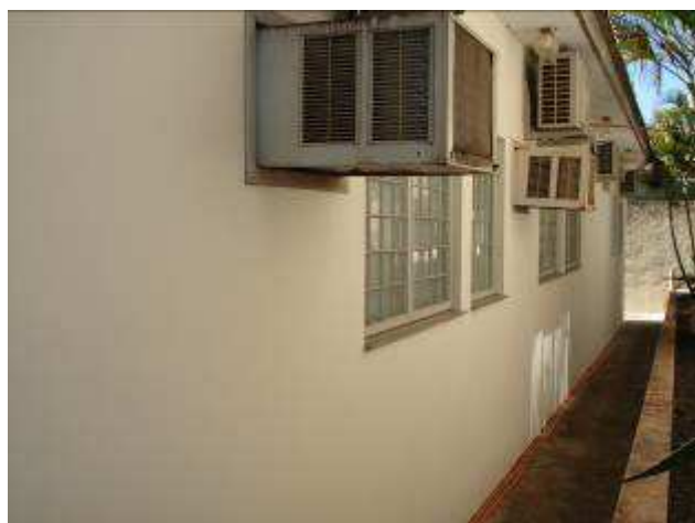
Figura 55C: pintura paredes externas – parede dos fundos da edificação pintada.
