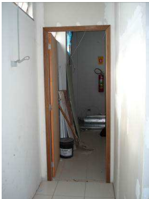
Figura 59C: antes da pintura - paredes internas e esquadrias
