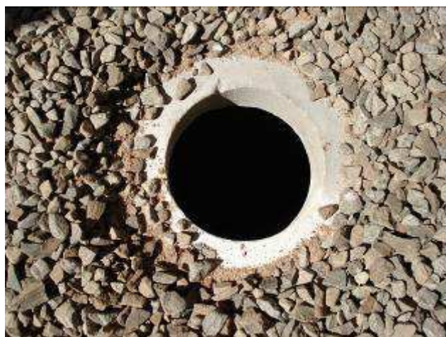
Figura 33C: fossa / sumidouro instalado.
