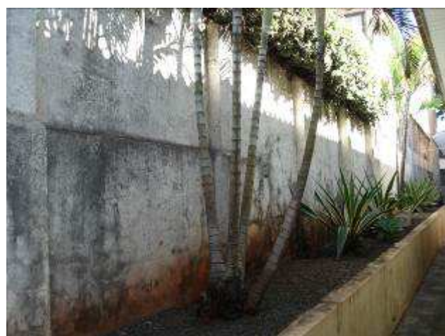
Figura 44C: corredor antes da instalação do jardim
