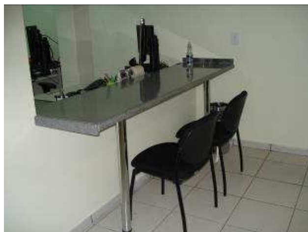
Figura 10C: instalação de balcão em granito – balcão 2ª VT.
