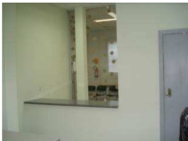
Figura 9C: instalação de balcão em granito – balcão 2ª VT.
