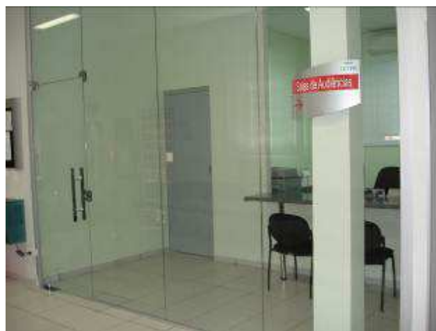
Figura 8C: parede demolida e painel de vidro temperado instalado – balcão 2ª VT.
