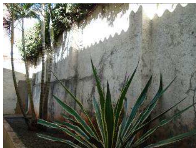
Figura 45C: corredor antes da instalação do jardim
