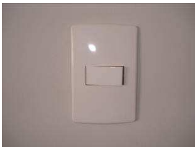
Figura 75E: instalação de interruptores.
