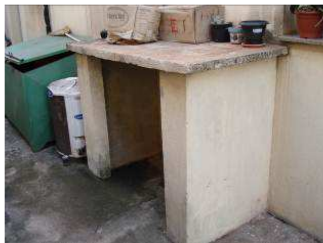
Figura 03C: abrigo do botijão de gás – antes da demolição
