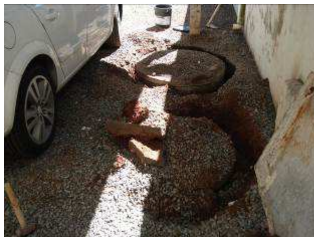
Figura 32C: instalação da fossa / sumidouro
