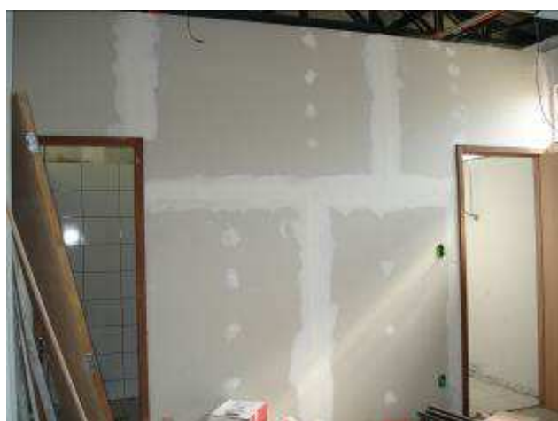
Figura 25C: construção de parede em gesso acartonado e instalação de portas – Gabinete 01.
