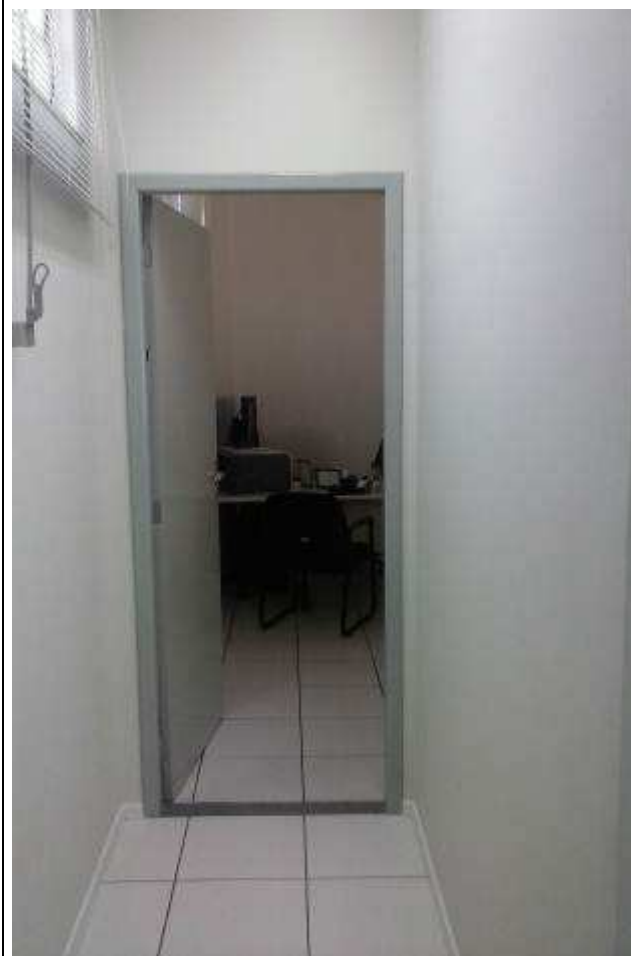
Figura 60C: pintura das paredes internas e das esquadrias.
