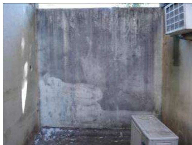
Figura 53C: pintura paredes externas – muro fundos da edificação antes da pintura.
