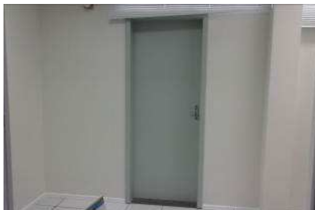
Figura 58C: pintura das paredes internas e das esquadrias.
