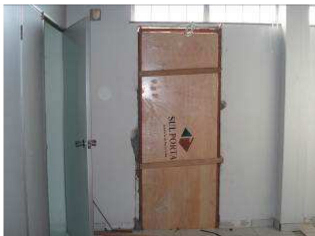
Figura 57C: antes da pintura - paredes internas e esquadrias.
