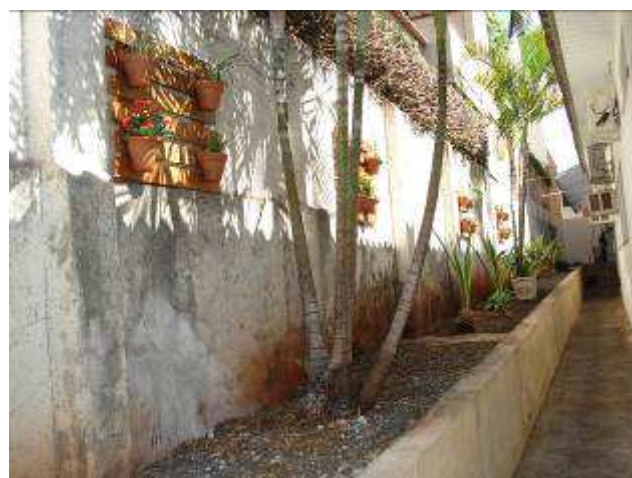
Figura 46C: instalado jardim vertical no corredor dos fundos.
