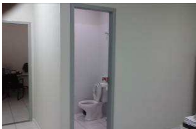
Figura 37C: parede acabada dos banheiros privativos.
