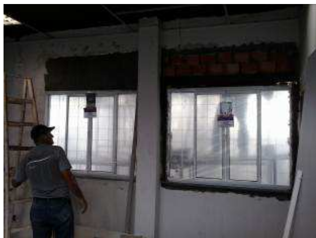
Figura 20C: remoção das janelas existentes e instalação de janelas novas – Gabinete 01.
