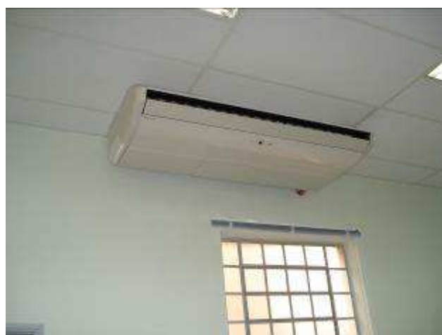
Figura 62C: instalação de ar condicionado – Sala de Audiências 02.
