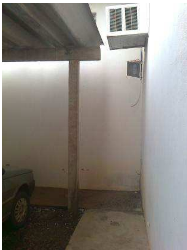
Figura 15C: parede p/ abertura de vão da porta de acesso através do estacionamento – Gabinete 01 e Assistência.
