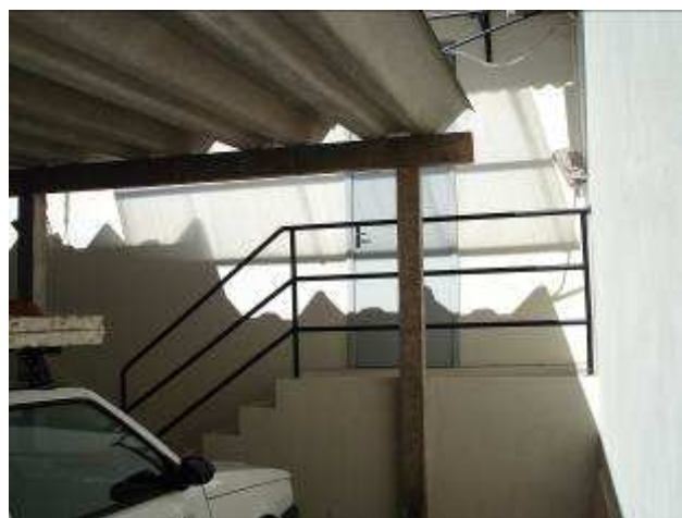
Figura 18C: instalação da porta de acesso através do estacionamento – Gabinete 01 e Assistência.
