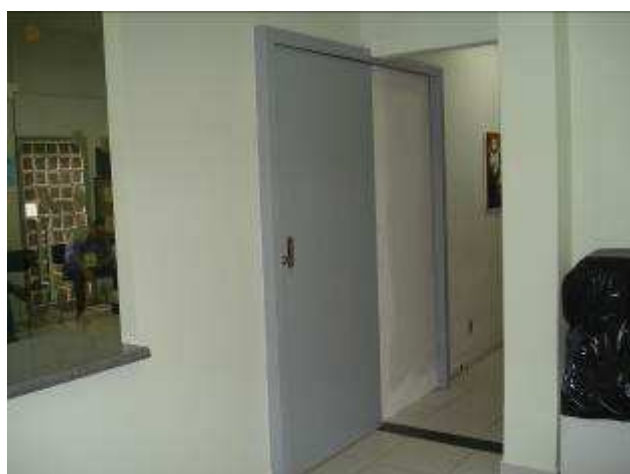
Figura 11C: instalação de porta de correr – balcão 2ª VT.
