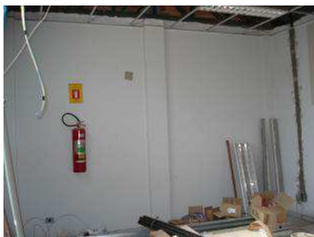
Figura 27C: pintura interna – Gabinete 01.
