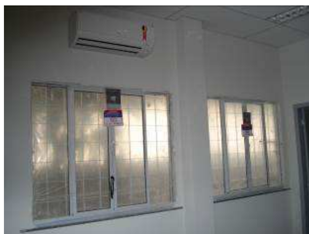
Figura 64C: instalação de ar condicionado – Gabinete 01.
