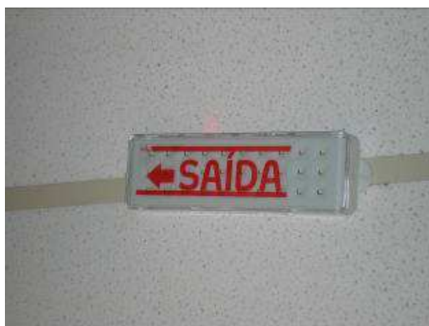
Figura 76E: instalação de luminárias de emergência.
