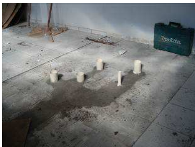
Figura 29C: pontos de esgoto para construção dos banheiros privativos.
