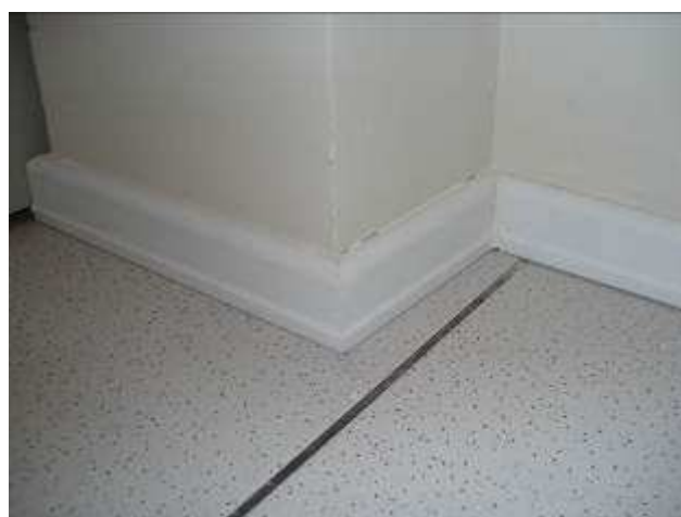
Figura 24C: instalação de rodapé – Gabinete 01.
