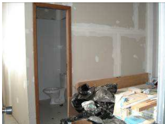
Figura 36C: montagem da parede de gesso acartonado dos banheiros privativos.
