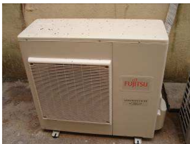
Figura 61C: instalação de ar condicionado – Sala de Audiências 02.
