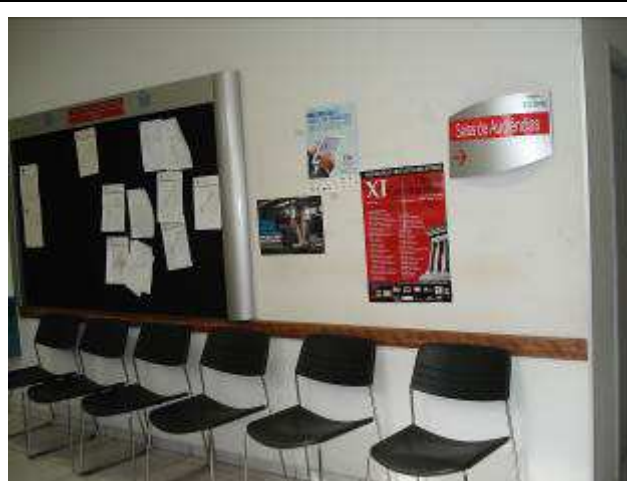
Figura 06C: antes da demolição da parede – balcão 2ª VT.
