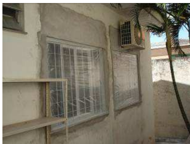
Figura 22C: remoção das janelas existentes e instalação de janelas novas – Gabinete 01.
