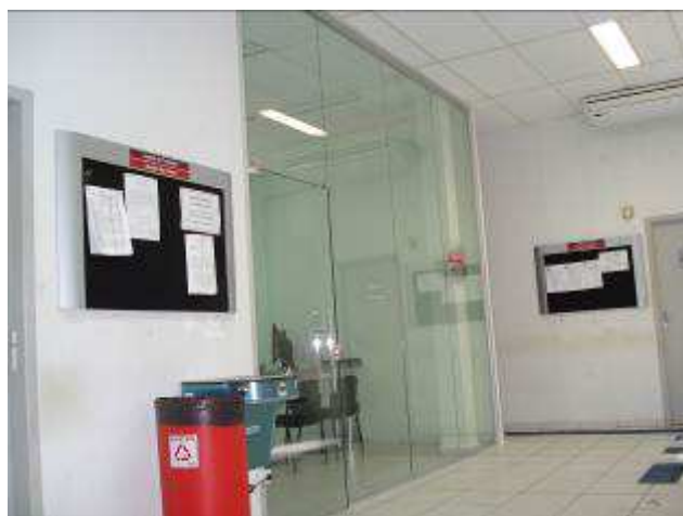
Figura 7C: parede demolida e painel de vidro temperado instalado – balcão 2ª VT.
