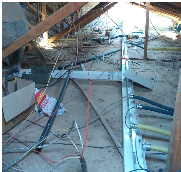
Figura 06E: Retirada de instalação existente
