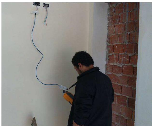
Figura 29E: Certificação de pontos lógicos
