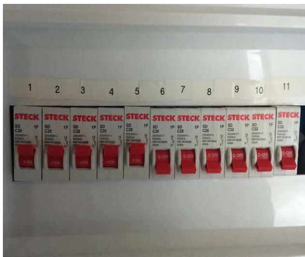
Figura 15E: Disjuntores monopolares
