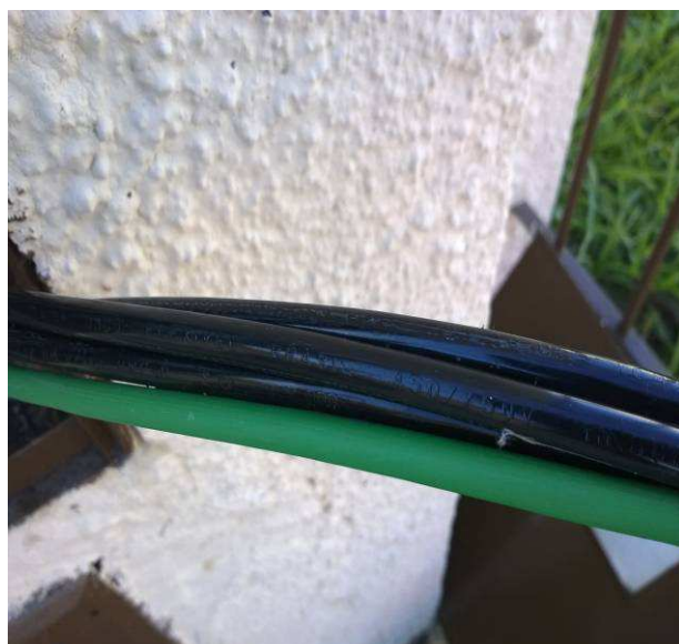
Figura 10E: Cabos flexíveis 16,0 mm 2
