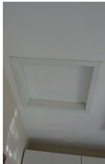
Figura 02: Demolição para abertura de alçapão da 1ª Vara.
