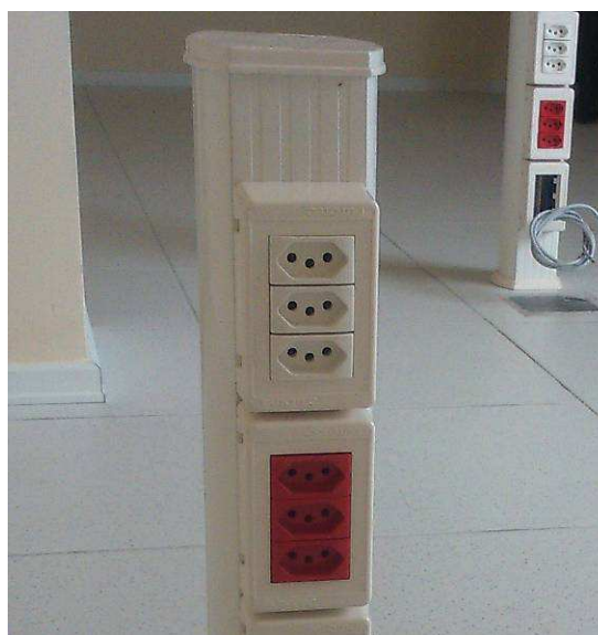
Figura 08E: Tomadas em totem Dutotec
