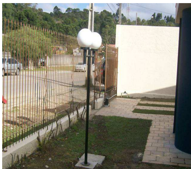
Figura 20E: Poste com duas luminárias de jardim
