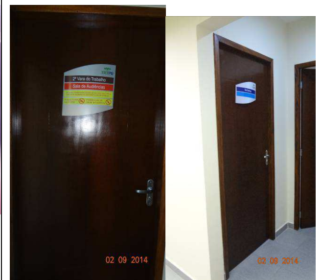
Figura 21: Fixação de placas de comunicação visual.
