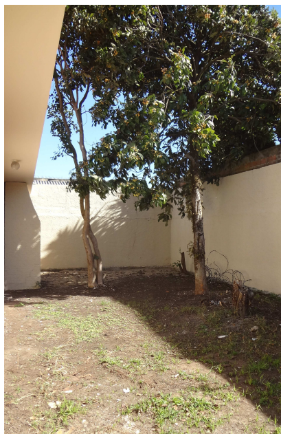
Figura 15: Limpeza com remoção de cobertura vegetal.
