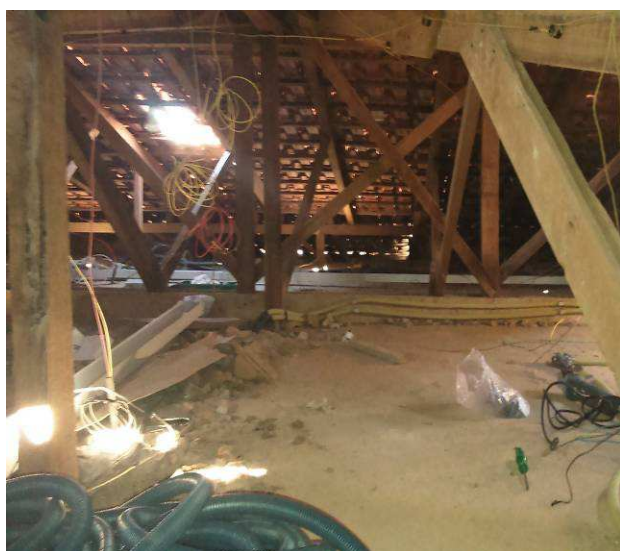
Figura 31E: Retirada de instalação elétrica existente.
