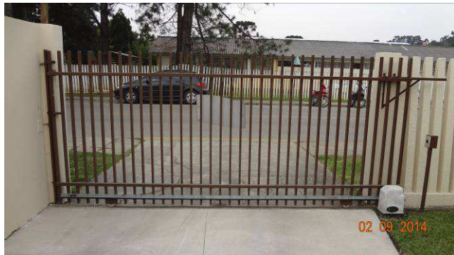
Figura 18: Pintura dos gradis da 1º Vara.
