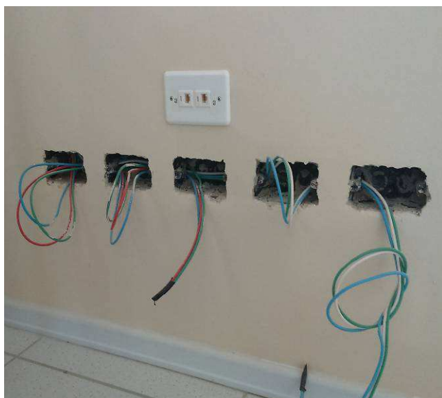
Figura 09E: Cabos instalados em caixas 4x2"
