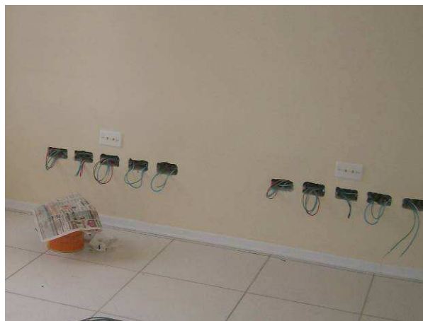
Figura 02E: Caixas de PVC – drywall/alvenaria
