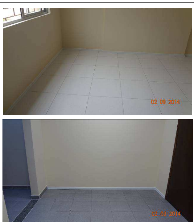
Figura 9: Rodapés na Sala de Audiência, circulação e Site.
