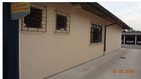
Figura 17: Pintura das fachadas da 1ª Vara.
