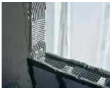
Ligação da Estrutura com a Alvenaria
