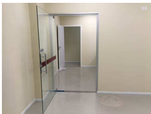
Figura 11C: Porta de vidro no acesso ao balcão de atendimento.
