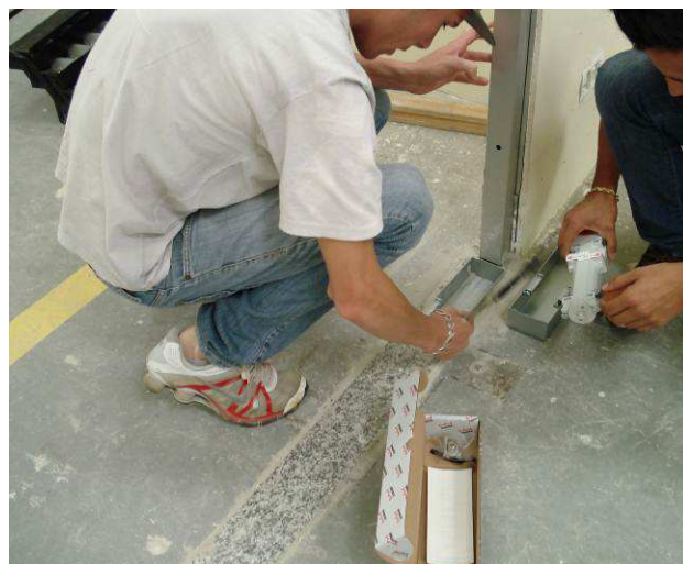
Figura 18C: Instalação da mola de piso.
