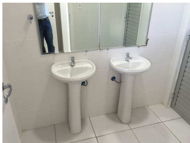
Figura 93C: Lavatórios com coluna, gancho toalheiro e espelhos nos banheiros dos terceirizados.
