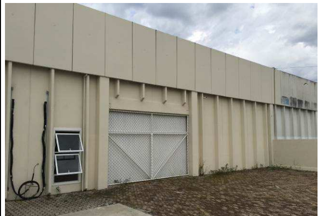
Figura 133C: Pintura na fachada dos fundos.
