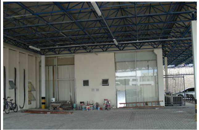
Figura 131C: Pintura na fachada frontal e pilares.
