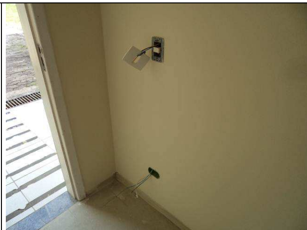
Figura 08E: caixas 2x4 área corredor de emergência.
