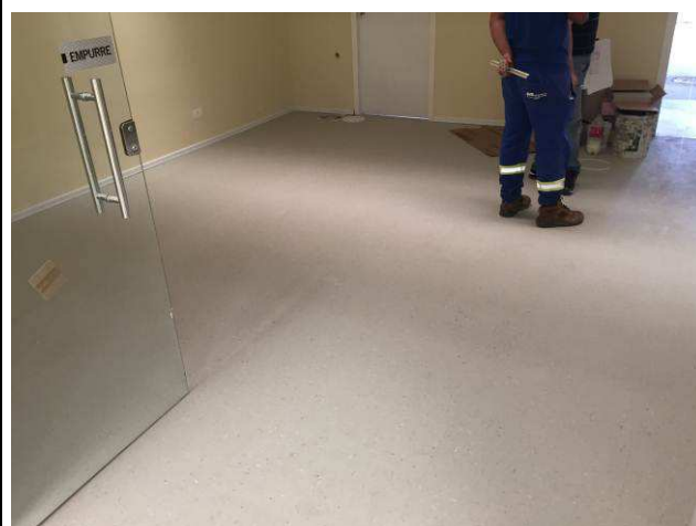
Figura 68C: Piso vinílico instalado na 5ª Vara.
