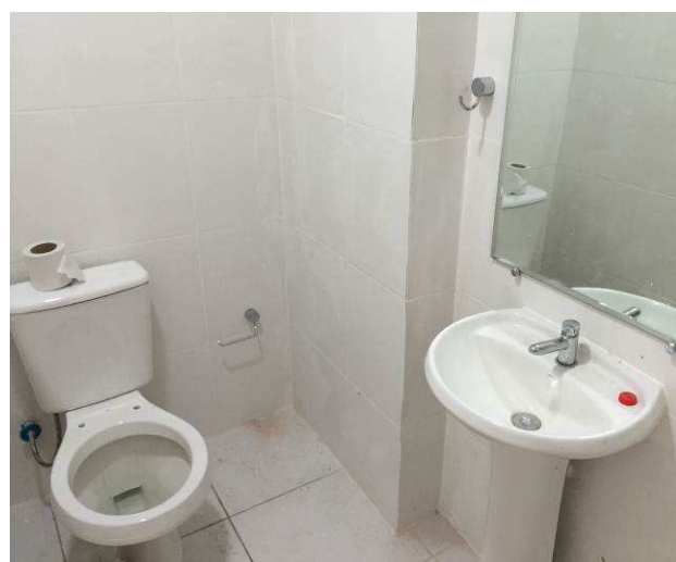
Figura 46C: Rejuntamento de azulejo de banheiro da 5ª Vara concluído.
