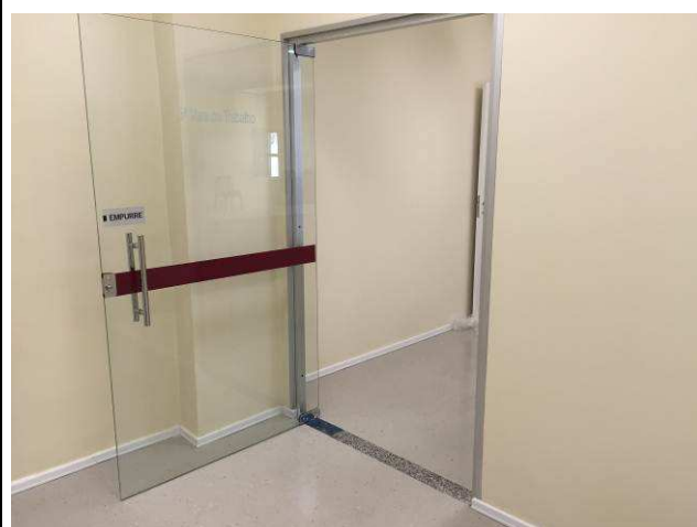
Figura 12C: Porta de vidro no acesso ao balcão de atendimento.
