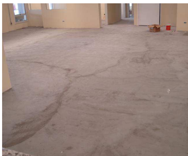
Figura 53C: Regularização do contrapiso para instalação do piso vinílico.
