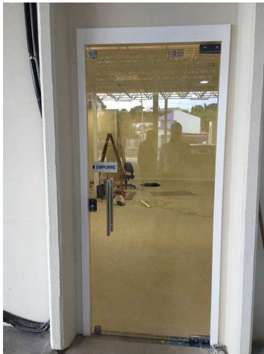
Figura 14C: Porta de vidro no acesso à Secretaria da 5ª Vara.
