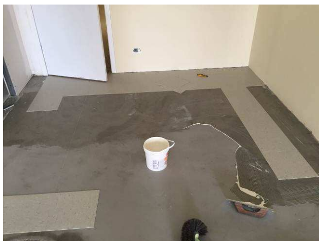
Figura 59C: Instalação do piso vinílico.
