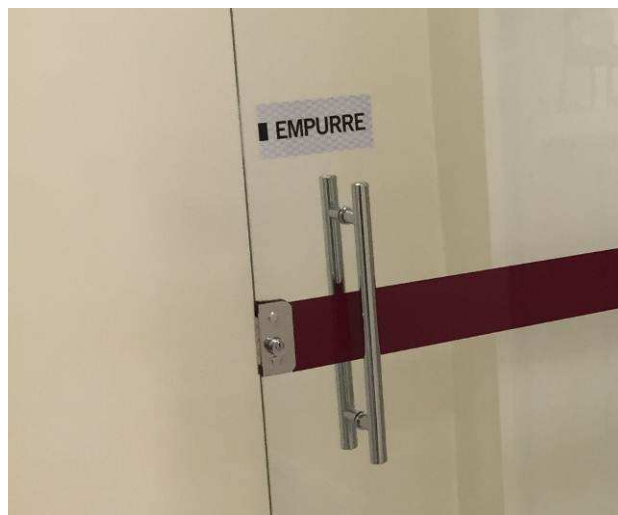
Figura 20C: Detalhe dos puxadores das portas de vidro.
