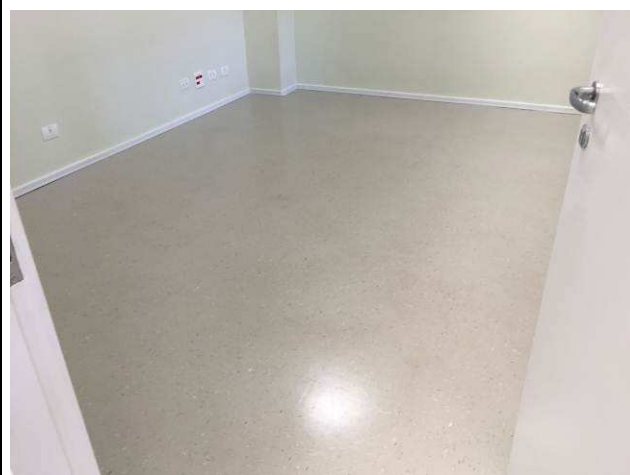
Figura 66C: Piso vinílico instalado na 5ª Vara.
