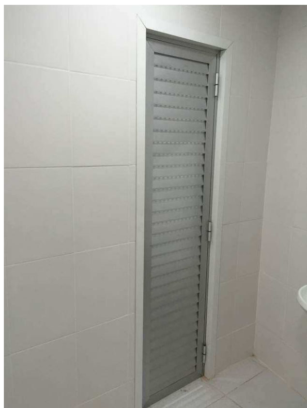
Figura 33C: Porta em veneziana de alumínio natural nos sanitários e chuveiros dos banheiros da área de terceirizados.
