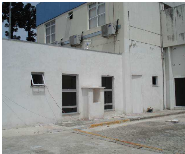
Figura 38C: Ao centro, janelas J04 instaladas na copa da área de terceirizados.
