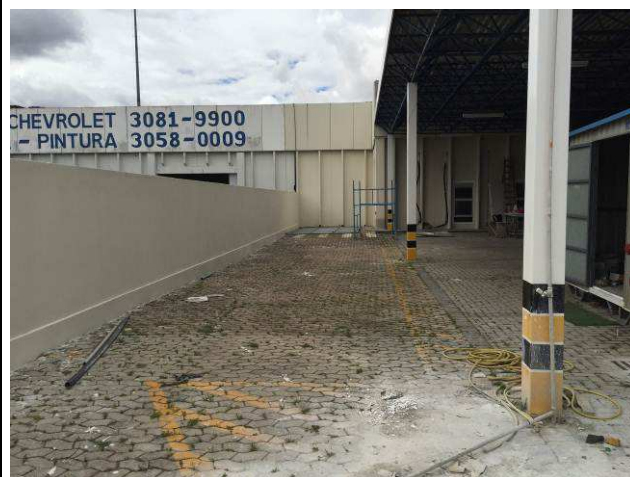
Figura 137C: Pintura no muro lateral frontal.
