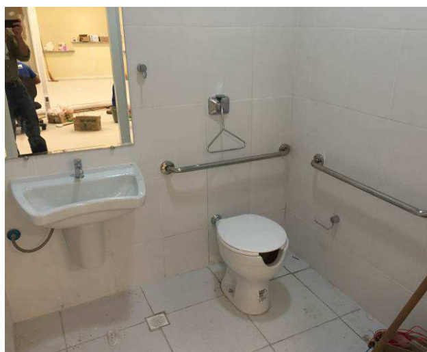
Figura 47C: Rejuntamento de azulejo de banheiro PNE concluído.
