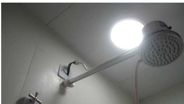
Figura 43C: Forro removível instalado nos vestiários e banheiros dos terceirizados.
