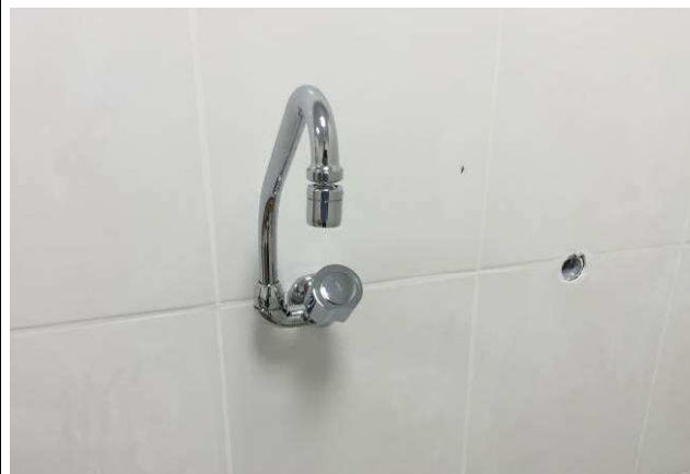
Figura 88C: Torneira instalada na copa da 5ª Vara.
