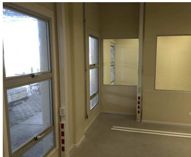
Figura 22C: Esquadrias de alumínio e painéis de vidro fixo na Secretaria da 5ª Vara.
