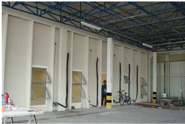
Figura 130C: Pintura na fachada frontal.
