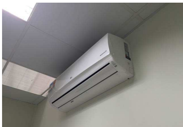
Figura 107C: Evaporadora LG 18.000 – gabinete de juiz I.
