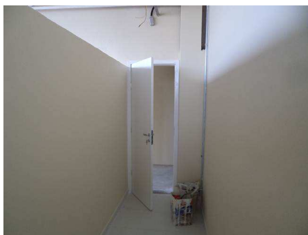
Figura 129C: Pintura do corredor de acesso aos vestiários dos terceirizados.
