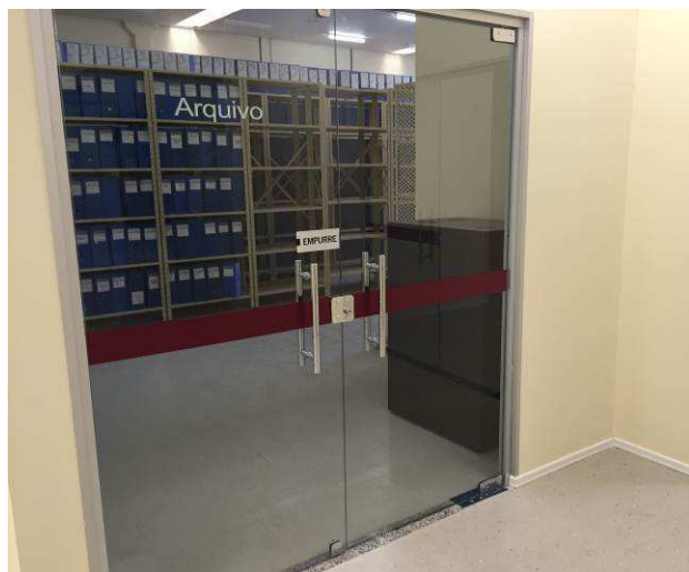
Figura 15C: Porta de vidro no acesso ao Arquivo.
