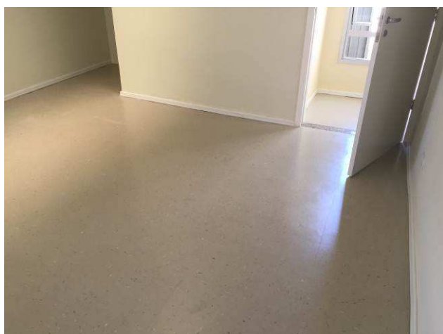
Figura 65C: Piso vinílico instalado na 5ª Vara.
