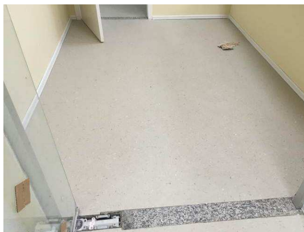
Figura 63C: Piso vinílico instalado na 5ª Vara.
