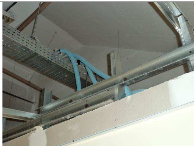
Figura 07E: eletrodutos para caixas 2x4 área corredor de emergência.
