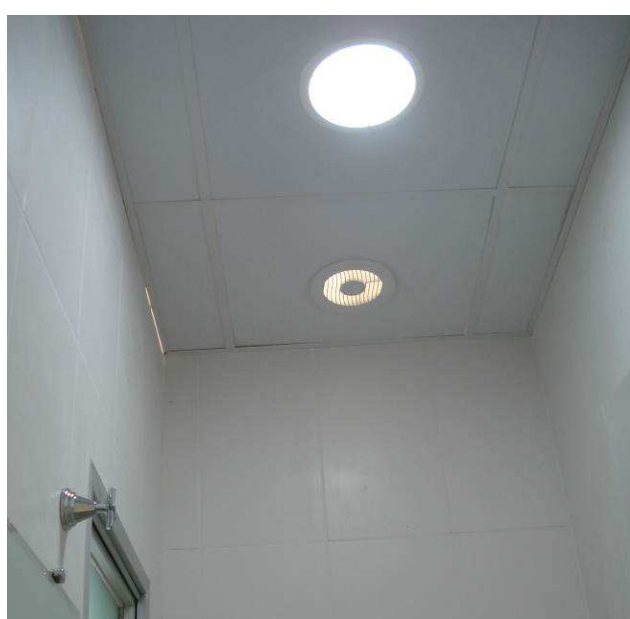
Figura 39C: Forro instalado em banheiro de gabinete do juiz da 5ª Vara.
