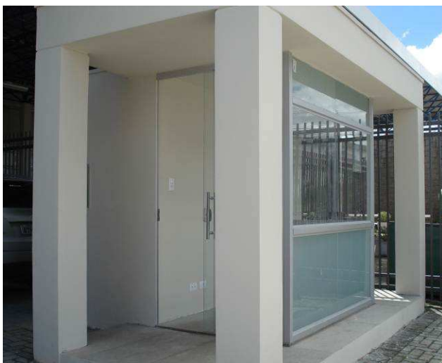
Figura 27C: Painéis de vidro fixo e móvel (janelas máximo ar) aplicados na guarita.
