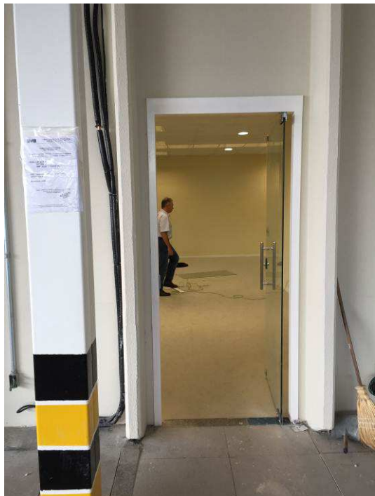
Figura 13C: Porta de vidro no acesso à Secretaria da 5ª Vara.
