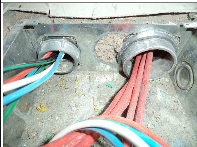
Figura 04E: infraestrutura sob o piso – sala de audiências.
