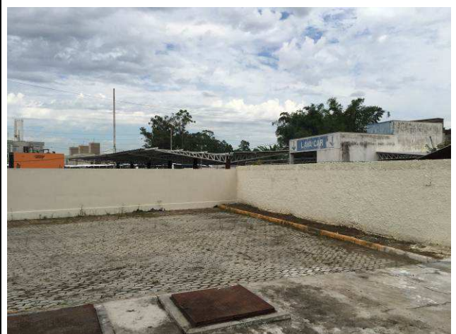
Figura 135C: Pintura nos muros dos fundos.
