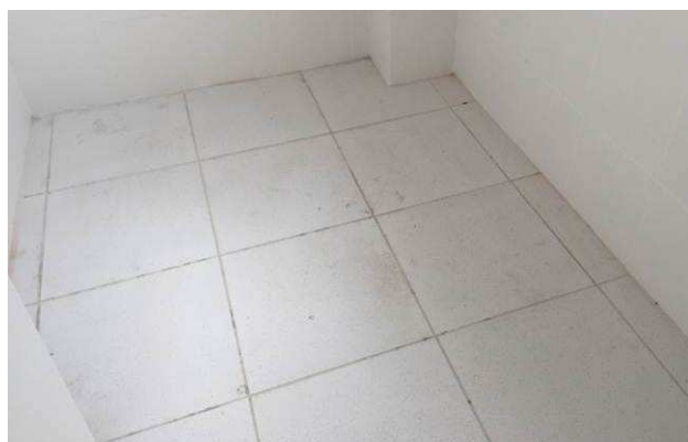
Figura 69C: Piso cerâmico área de serviço.
