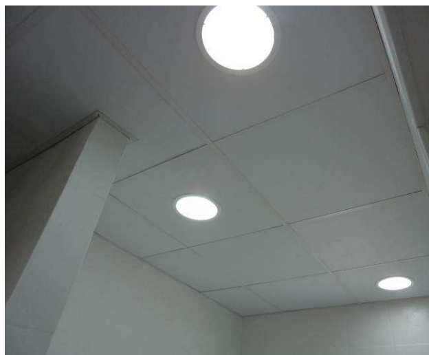
Figura 41C: Forro removível instalado na copa dos terceirizados.
