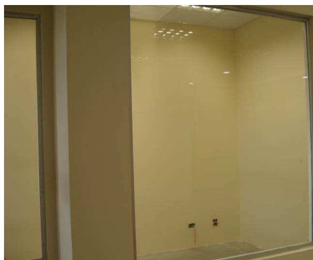
Figura 24C: Painéis de vidro fixo – visores da sala de assistentes.
