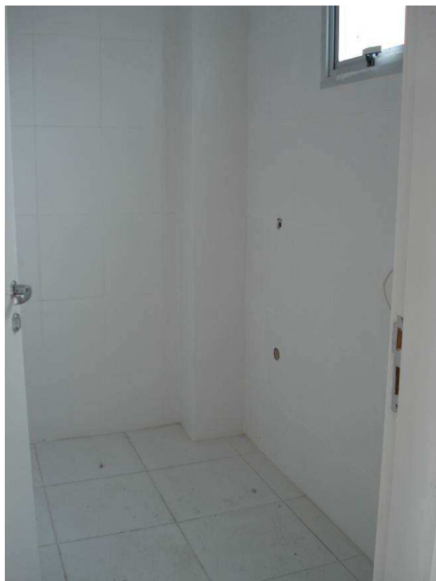
Figura 51C: Azulejos assentados e rejuntados na área de serviços.
