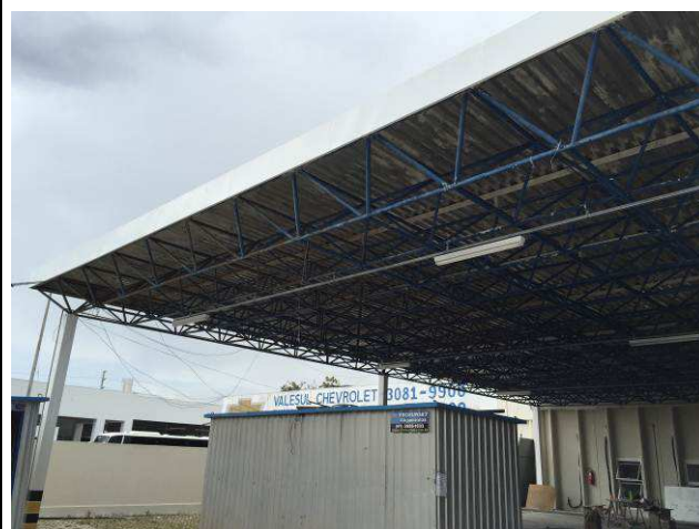
Figura 139C: Pintura da testeira.
