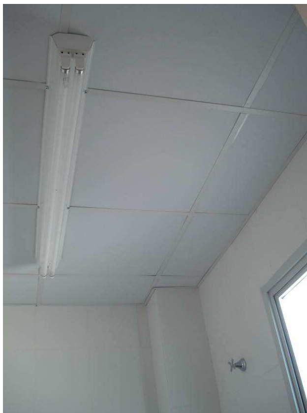
Figura 44C: Forro removível instalado na área de serviços.
