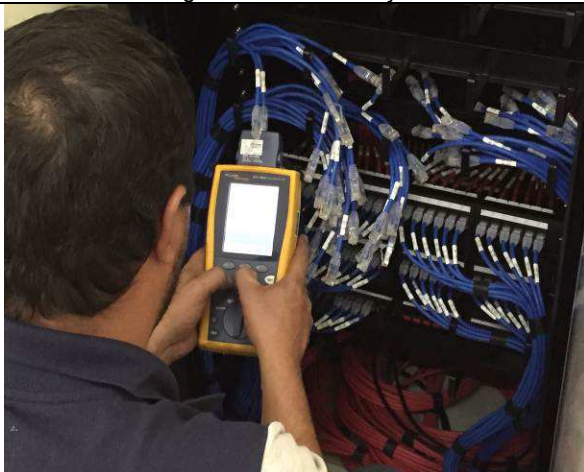
Figura 51E: certificação dos pontos lógicos.
