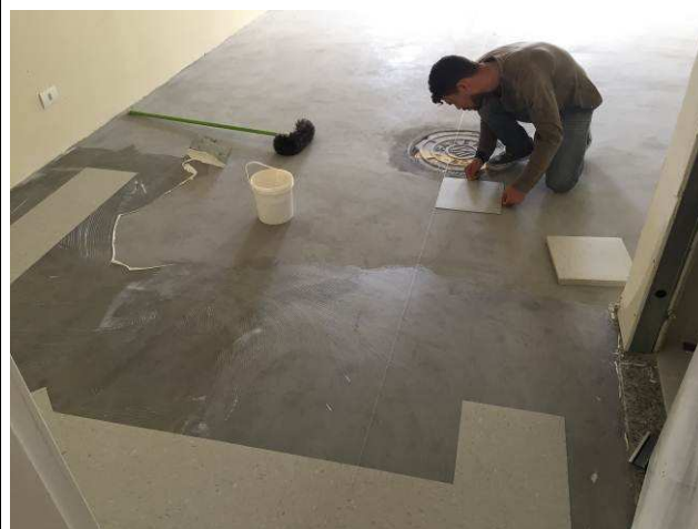
Figura 60C: Instalação do piso vinílico.
