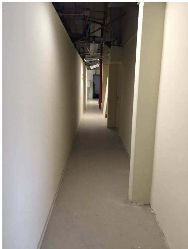
Figura 126C: Pintura do corredor lateral da 3ª Vara.
