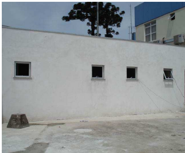
Figura 37C: Janelas J03 instaladas nos banheiros e vestiários da área de terceirizados.
