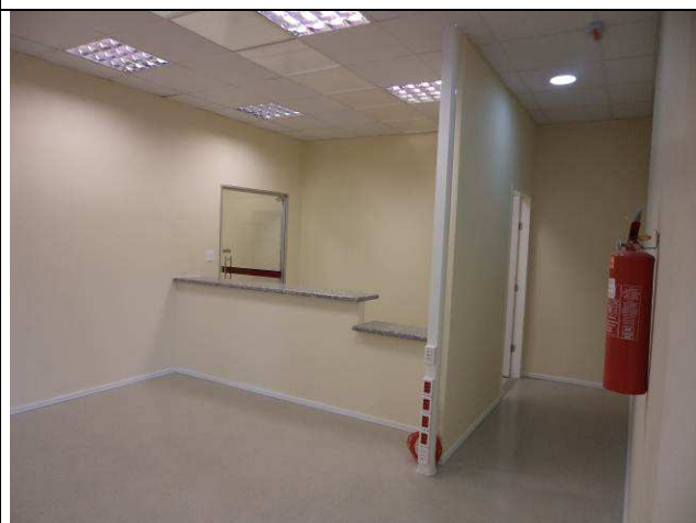
Figura 23E: Colunas técnicas e totens Dutotec.
