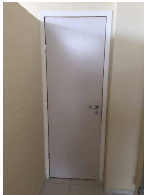
Figura 32C: porta com largura de 70 cm, na circulação de acesso aos vestiários.
