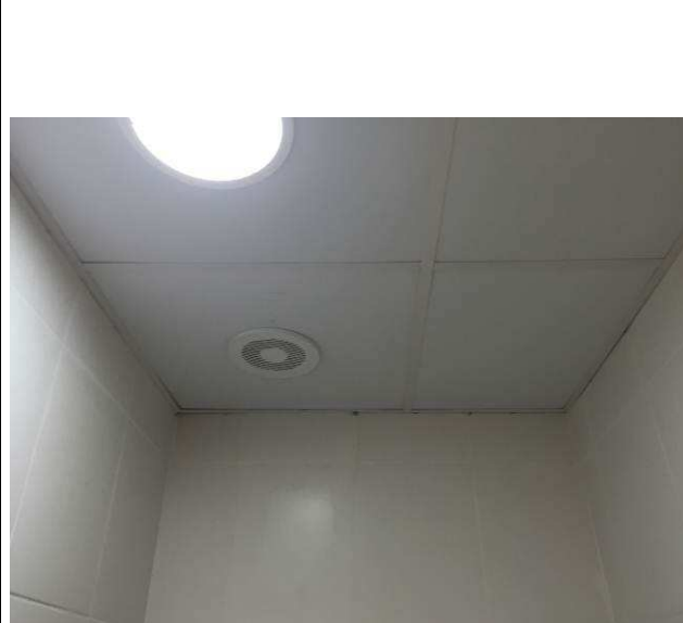
Figura 40C: Forro instalado em banheiro da sala de estar dos oficiais / Direção.
