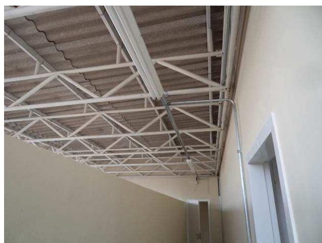
Figura 128C: Pintura do corredor de acesso aos vestiários dos terceirizados.
