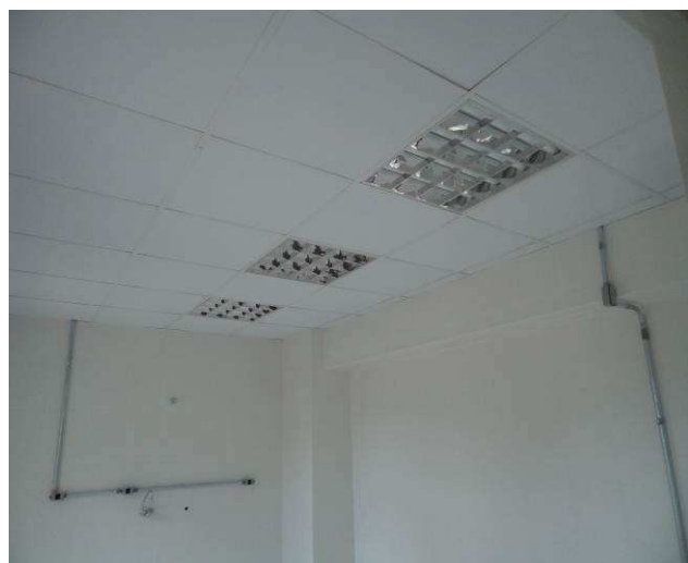
Figura 41C: Forro removível instalado na copa dos terceirizados.
