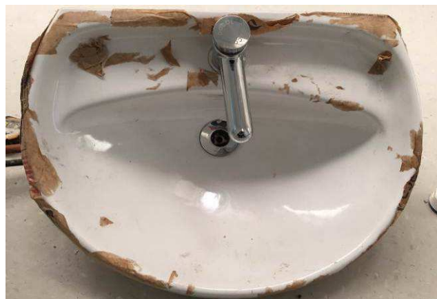
Figura 87C: Lavatório com torneira de fechamento automático e válvula cromada.
