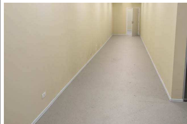
Figura 62C: Piso vinílico instalado na 5ª Vara.
