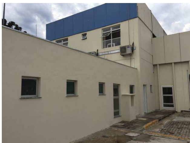
Figura 134C: Pintura na fachada terceirizados.
