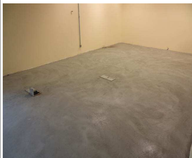
Figura 54C: Regularização do contrapiso para instalação do piso vinílico.
