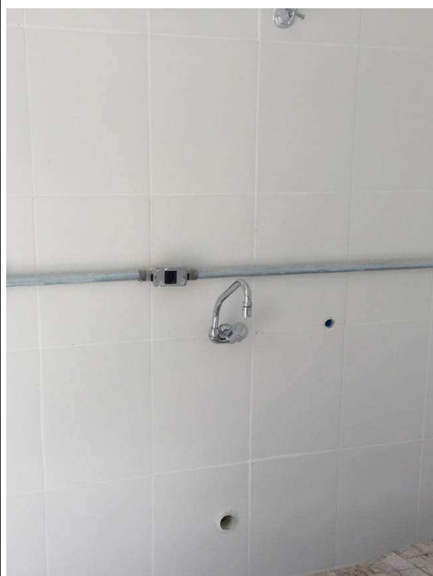
Figura 78C: Ponto de bebedouro ao lado da torneira na copa dos terceirizados.
