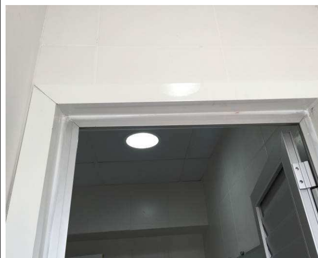
Figura 36C: Cantoneiras de alumínio para acabamento entre as portas e as paredes de gesso acartonado.
