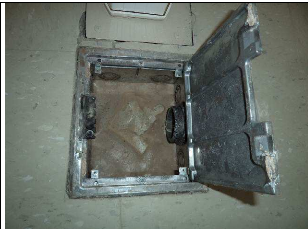
Figura 02E: infraestrutura sob o piso – sala de audiências.
