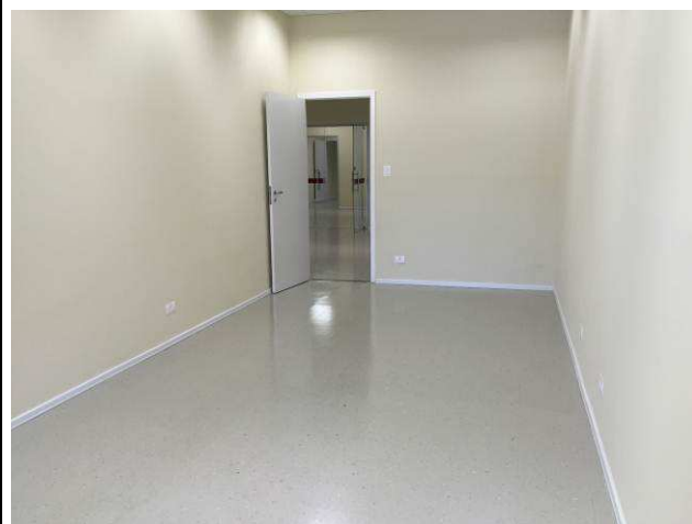
Figura 64C: Piso vinílico instalado na 5ª Vara.
