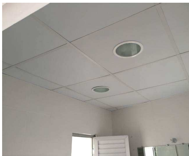
Figura 42C: Forro removível instalado nos vestiários e banheiros dos terceirizados.
