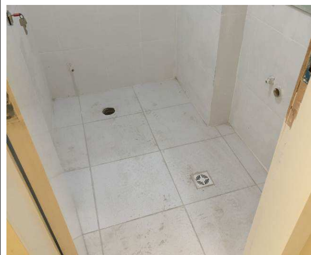
Figura 56C: Piso cerâmico em banheiro da secretaria da 5ª Vara.
