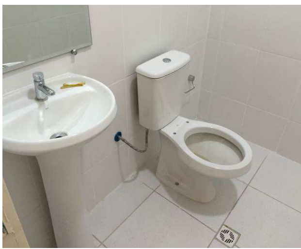
Figura 48C: Rejuntamento de azulejo de banheiro da 5ª Vara concluído
