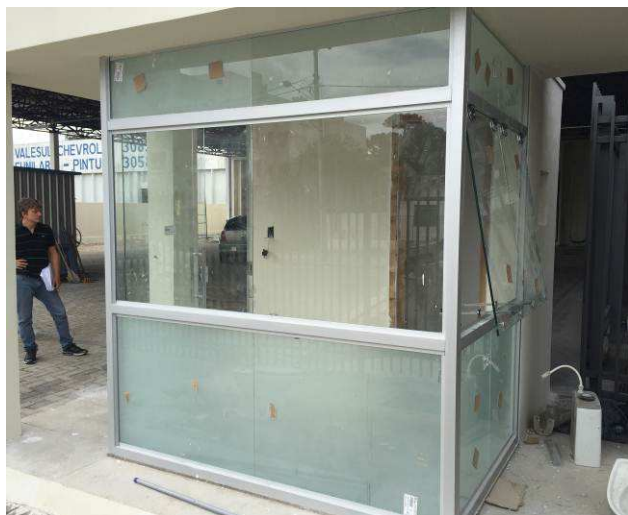
Figura 25C: Painéis de vidro fixo e móvel (janelas máximo ar) aplicados na guarita.
