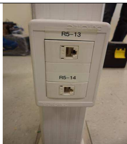
Figura 46E: conectores RJ45 cat6.
