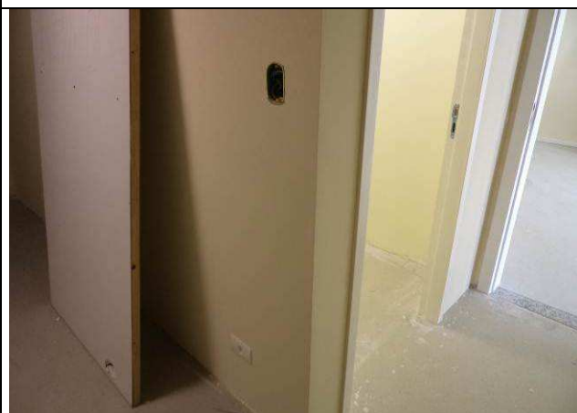
Figura 06E: caixas 2x4 área corredor de emergência.
