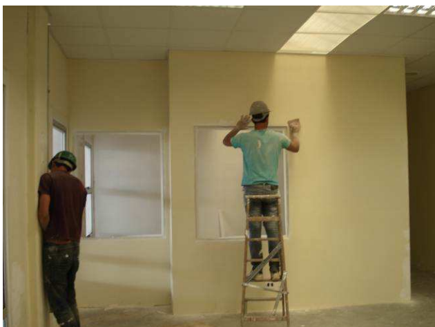
Figura 118C: Lixamento de paredes internas.
