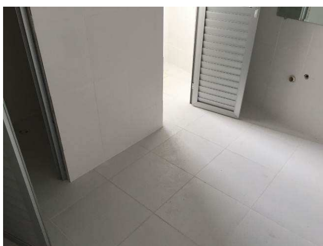
Figura 73C: Piso cerâmico área de serviço.
