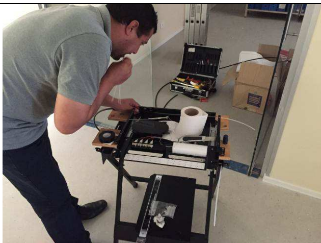
Figura 48E: fusão fibra óptica.
