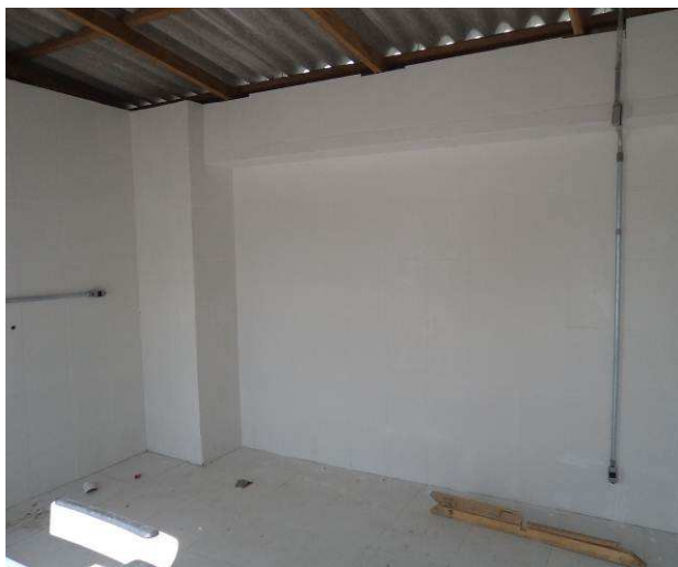
Figura 49C: Rejuntamento de azulejo na copa da área de terceirizados.
