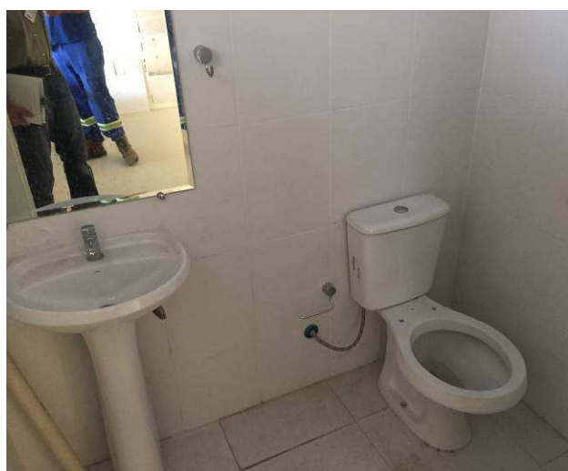
Figura 45C: Rejuntamento de azulejo de banheiro do gabinete de juiz I concluído.
