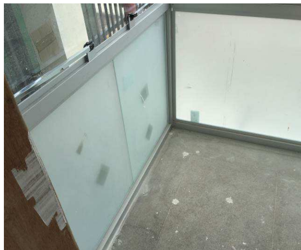
Figura 26C: Películas jateadas aplicada na porção inferior dos painéis de vidro.
