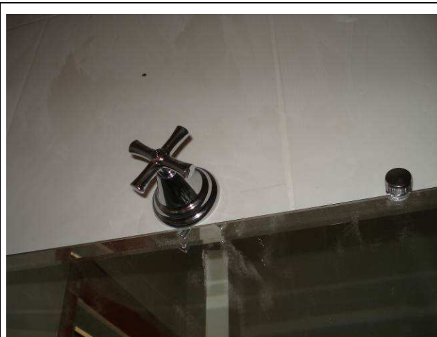
Figura 76C: Acabamentos dos registros de gaveta.
