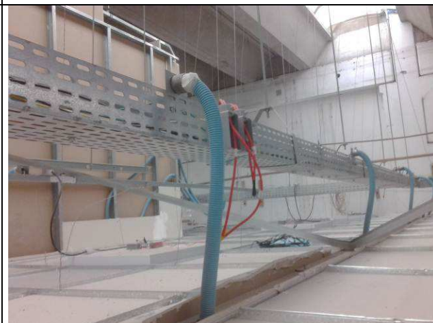
Figura 10E: pontos lógicos em condutes para uso nos postes Dutotec.
