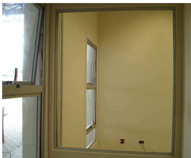
Figura 23C: Painéis de vidro fixo – visores da sala de assistentes.
