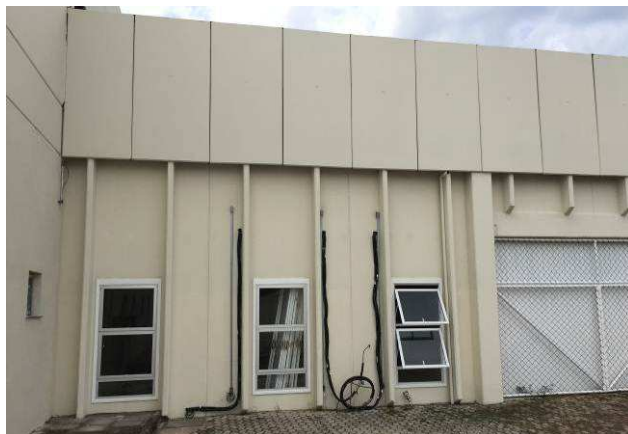
Figura 132C: Pintura na fachada dos fundos.
