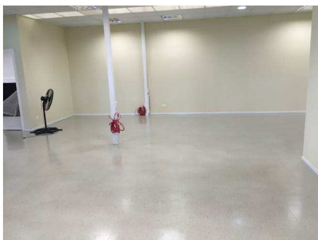
Figura 67C: Piso vinílico instalado na 5ª Vara.
