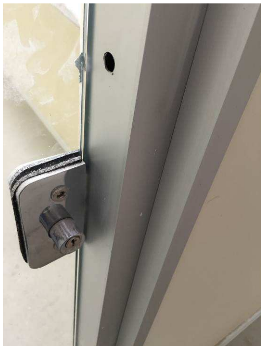
Figura 17C: Detalhe das fechaduras das portas de vidro.
