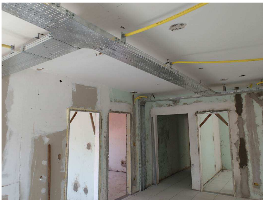
Figura 3 – Vista interna – pavimento superior.
