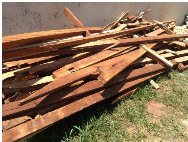
Figura 04C: Madeiramento removido da cobertura principal
