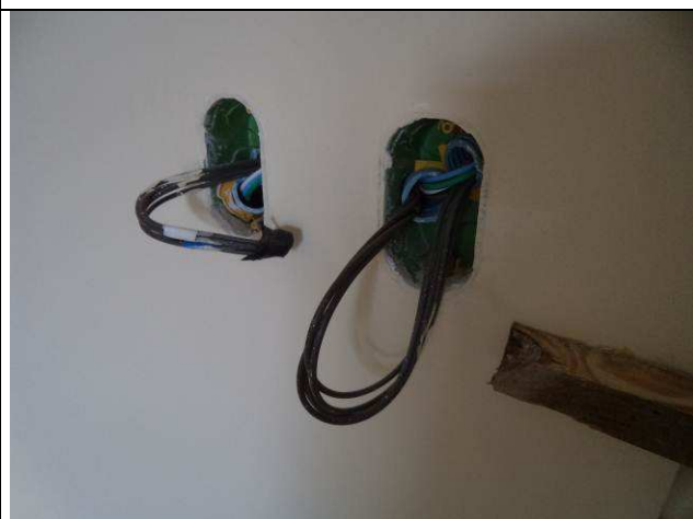
Figura 22E: Cabeamento elétrico – padrão de cores iluminação.
