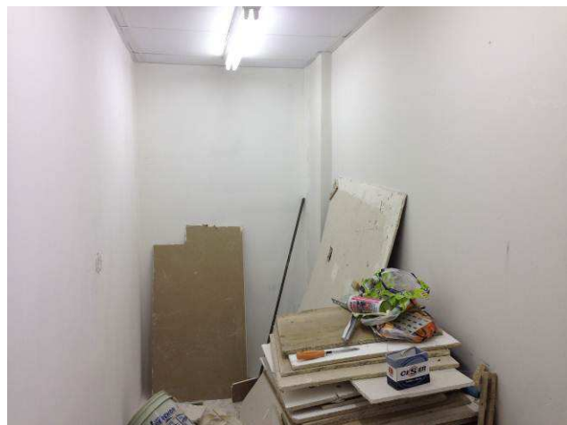
Figura 161C: Emassamento e lixamento de parede em gesso acartonado da sala SG.
