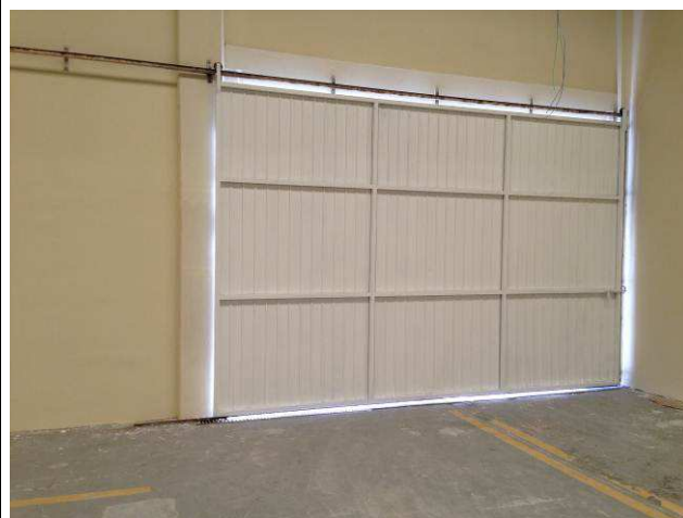
Figura 160C: Pintura com tinta esmalte acetinada – lado interno – portão do Arquivo.
