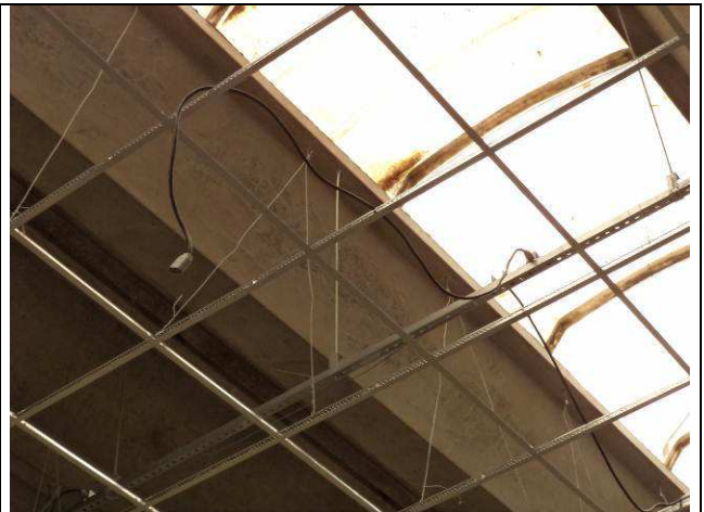
Figura 42E: Iluminação – derivadores laterais, cabos PP, plugues conexão.
