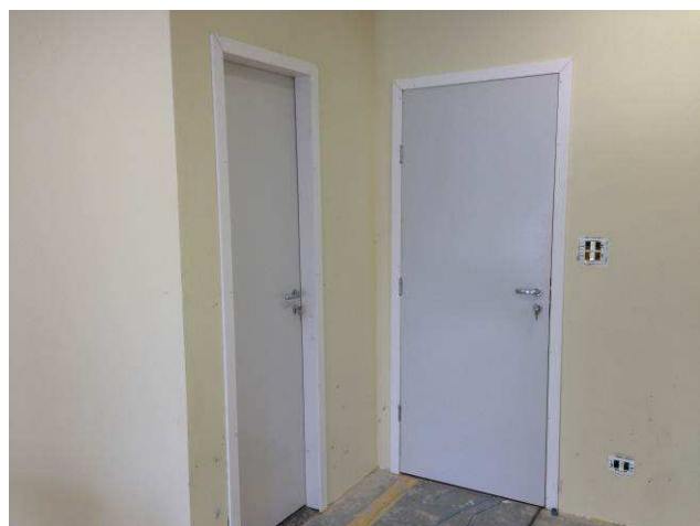
Figura 31C: Portas de madeira instaladas.
