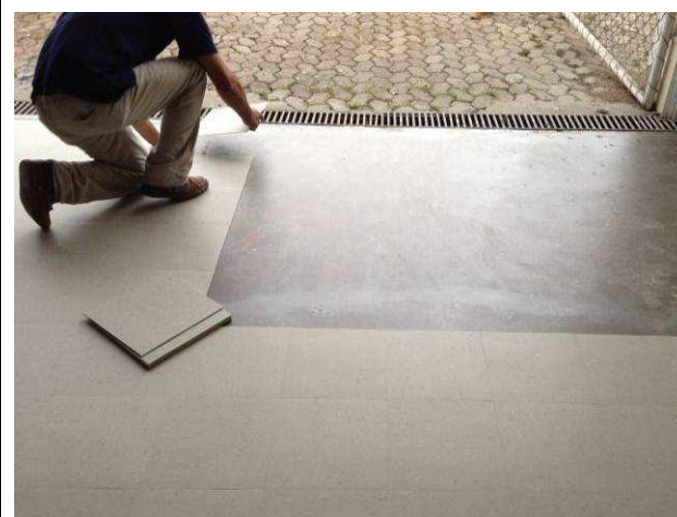
Figura 106C: Detalhe da instalação do piso vinílico.
