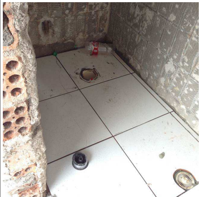
Figura 94C: Figura 38C: Piso cerâmico assentado no BWC da guarita.
