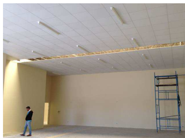
Figura 58C: Forro de gesso acartonado instalado no arquivo.
