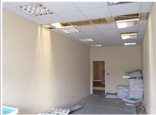
Figura 154C: Pintura com tinta látex acrílica, cor palha – Direção do Fórum.
