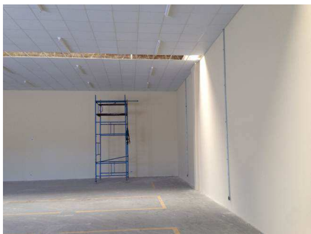
Figura 157C: Pintura com tinta látex acrílica, cor palha – Arquivo.
