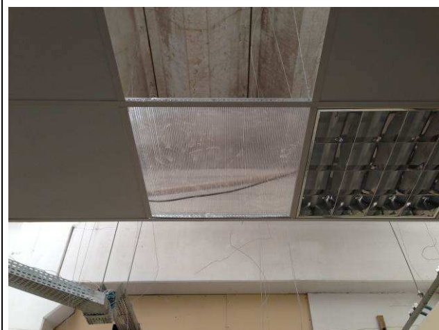
Figura 70C: Forro instalado na sala SG.
