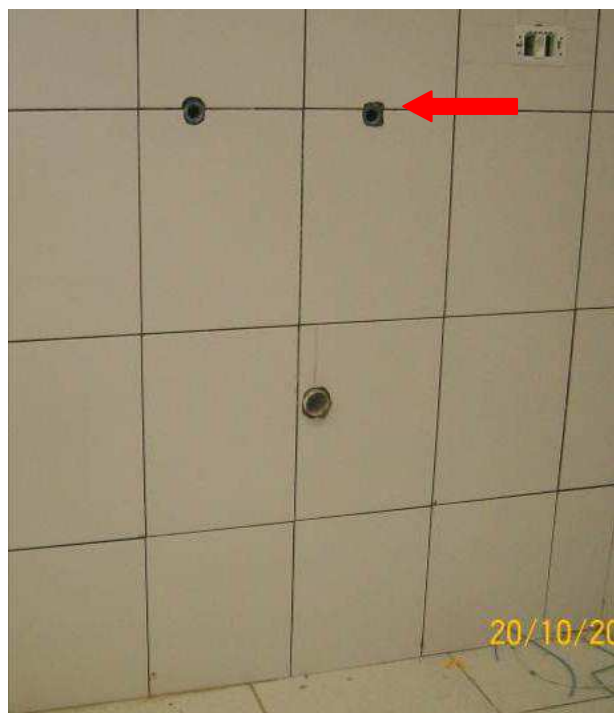
Figura 129C: Ponto de água fria para bebedouro 5ª Vara.
