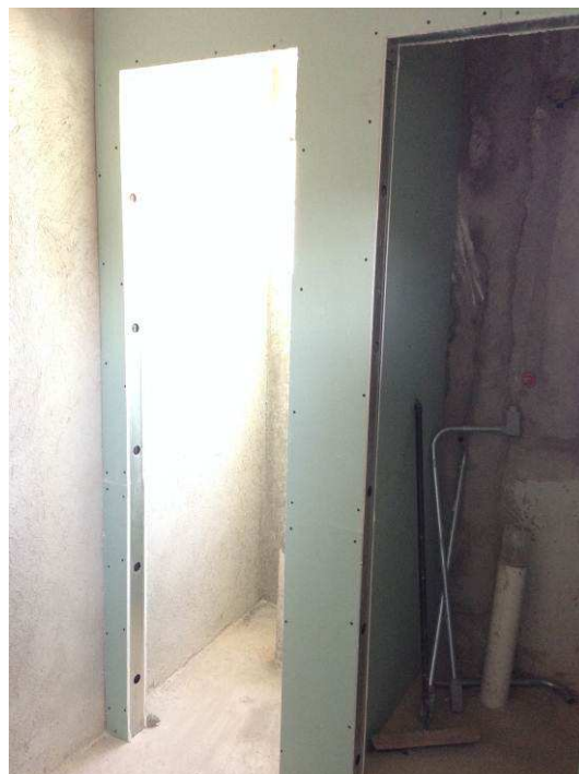
Figura 10C: Parede de gesso acartonado RU-verde em banheiro da área de terceirizados.
