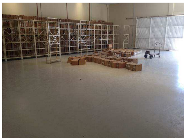
Figura 107C: Piso vinílico instalado no arquivo.
