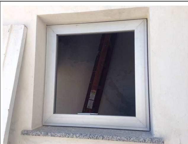
Figura 51C: Janelas J03 – área de terceirizados.
