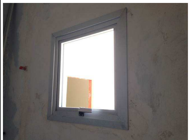
Figura 50C: Janelas J03 – área de terceirizados.
