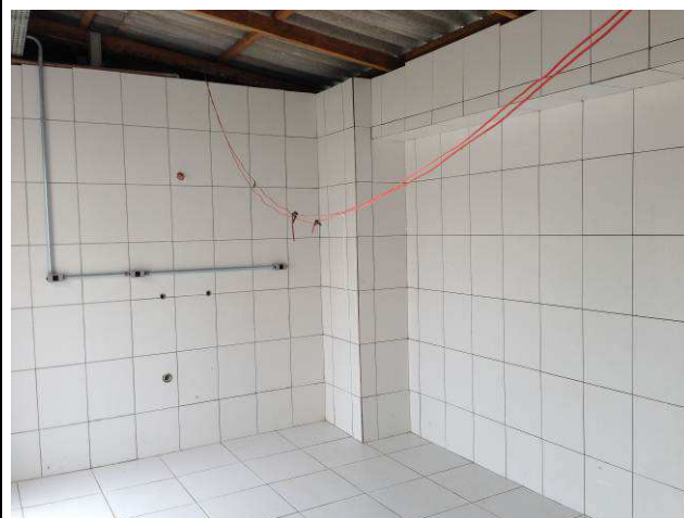
Figura 86C: Azulejos assentados na copa da área de terceirizados.
