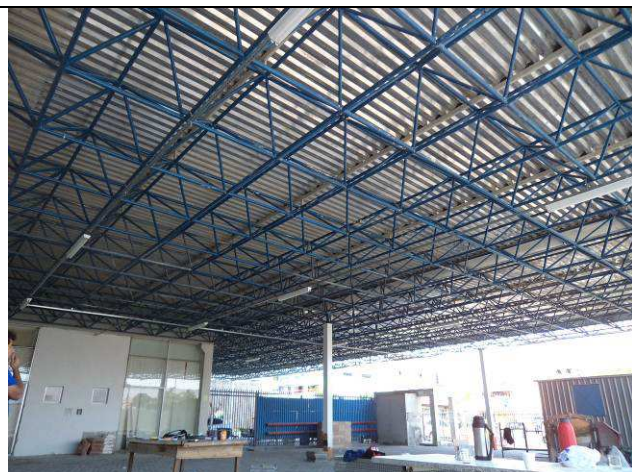
Figura 49E: iluminação – luminárias 2x32W estacionamento e hall.
