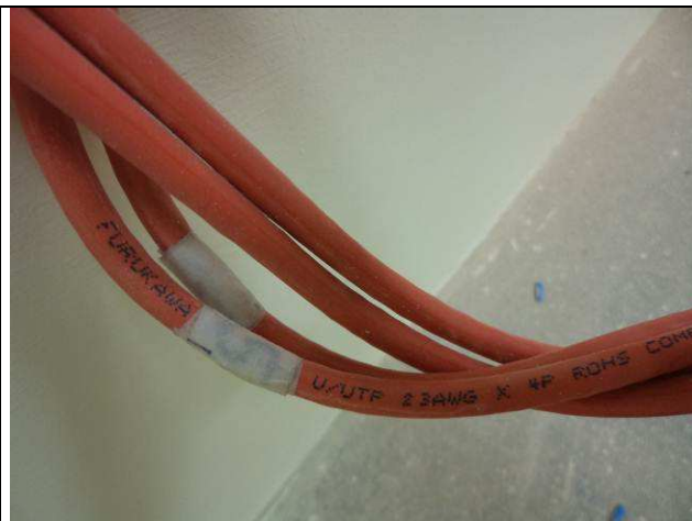
Figura 82E: cabearamento lógico UTP cat 6 Furukawa.
