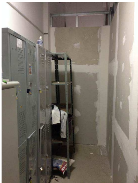
Figura 13C: Montagem de paredes de gesso acartonado ST- simples da Sala de Segurança.
