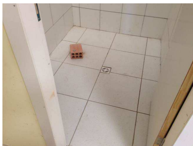
Figura 101C: Piso cerâmico assentado no BWC 2 da sala de estar da Direção do Fórum.
