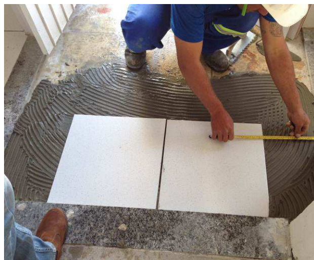
Figura 110C: Detalhe do assentamento do piso cerâmico.
