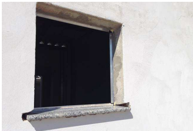
Figura 47C: Contramarco instalado em janela J03 – banheiros e vestiários da área de terceirizados.
