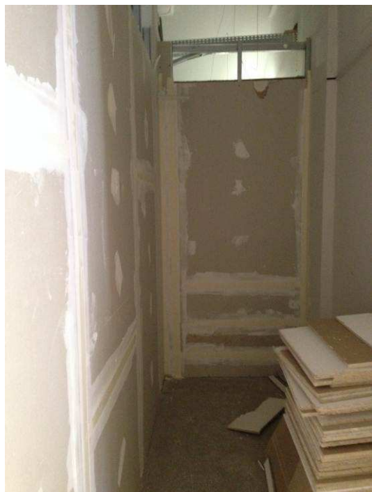
Figura 15C: Montagem de paredes de gesso acartonado ST- simples do depósito SG.
