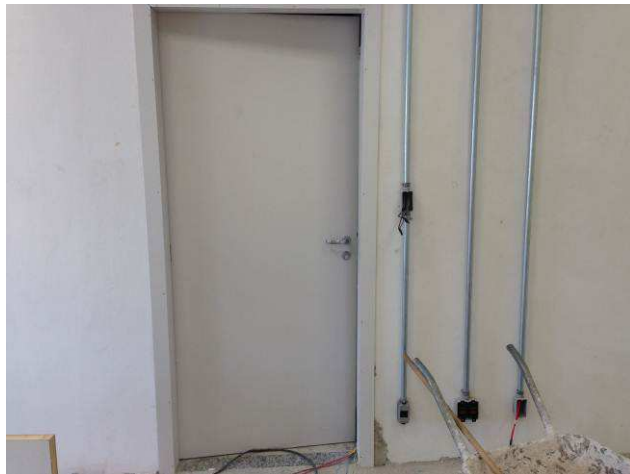
Figura 45C: Portas de madeira instaladas.
