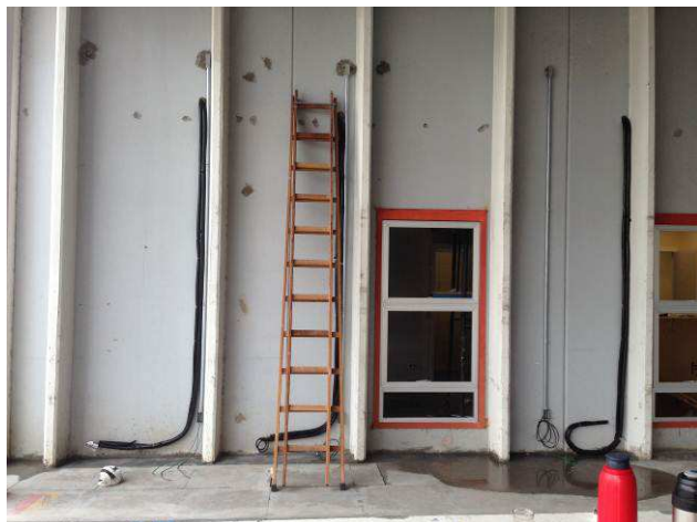
Figura 139C: Instalação da rede frigorígena – sala de audiências, gabinete de juiz e sala de assistentes da 5ª Vara.
