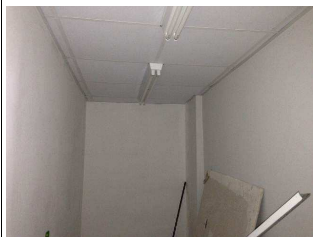
Figura 72C: Forro instalado na sala SG.
