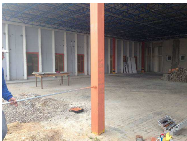
Figura 163C: Aplicação de fundo zarcão nos pilares metálicos do estacionamento.
