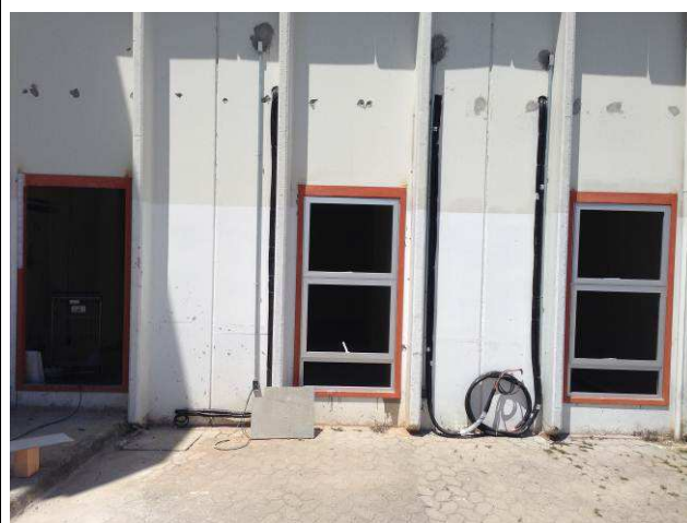
Figura 42C: Janelas J02 – salas dos oficiais e da Direção do Fórum.
