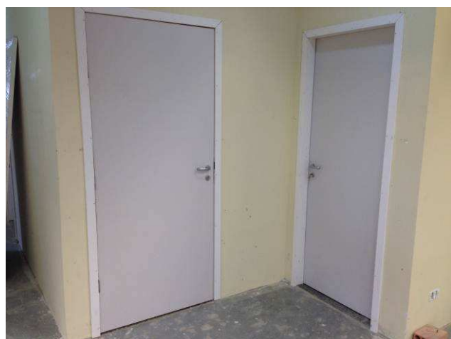
Figura 27C: Portas de madeira instaladas.
