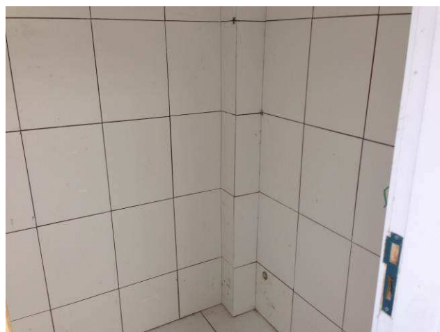
Figura 85C: Azulejos assentados no BWC da sala dos Oficiais de Justiça.
