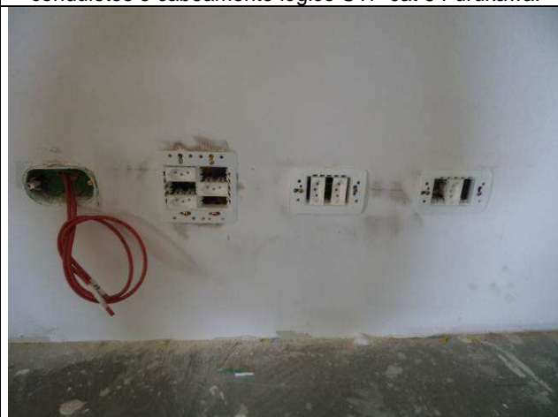
Figura 78E: Infra-estrutura lógica – caixas 2x4", 4x4" e condutes e cabeamento lógico UTP cat 6 Furukawa.
