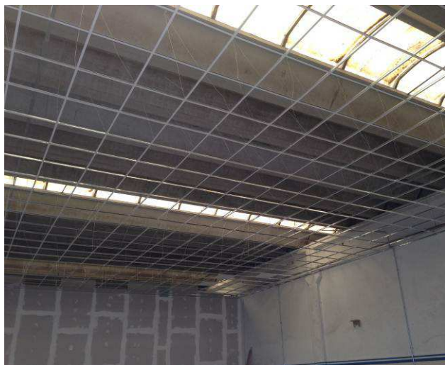
Figura 55C: Montagem dos perfis metálicos em área de arquivo.
