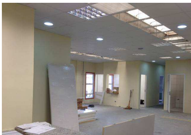
Figura 60C: Forro instalado em área da 5ª Vara.
