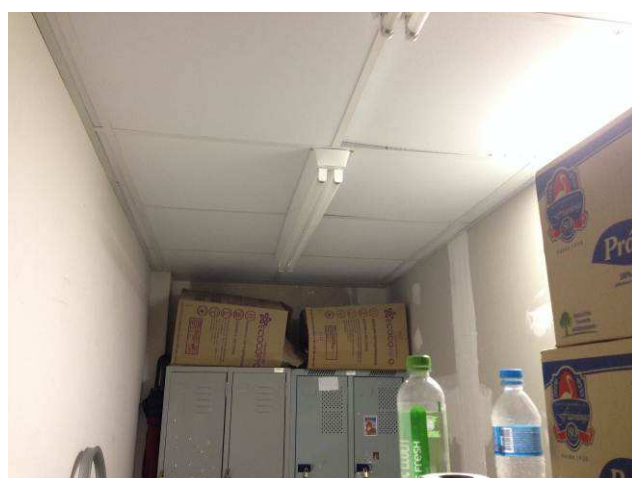
Figura 71C: Forro instalado na sala de segurança.
