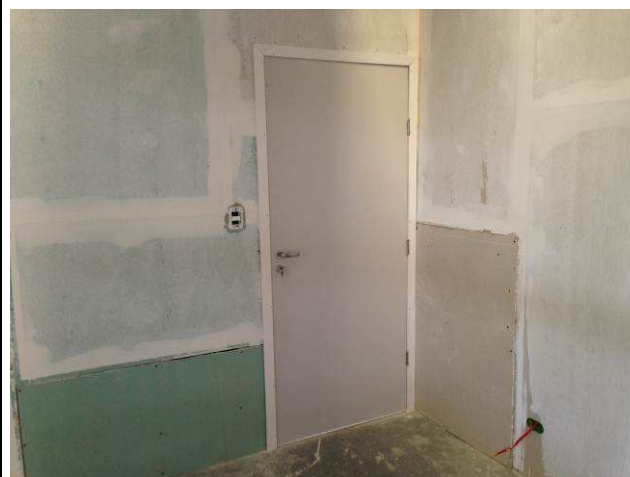
Figura 32C: Portas de madeira instaladas.
