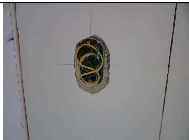
Figura 18E: Infraestrutura elétrica – caixas 2x4, 4x4 e condutores.
