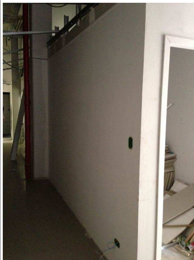
Figura 162C: Emassamento e lixamento de parede em gesso acartonado da sala SG.
