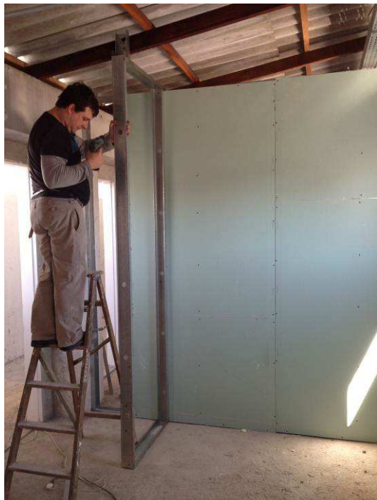
Figura 07C: Montagem de estrutura de parede de gesso acartonado RU-verde em vestiário da área de terceirizados.
