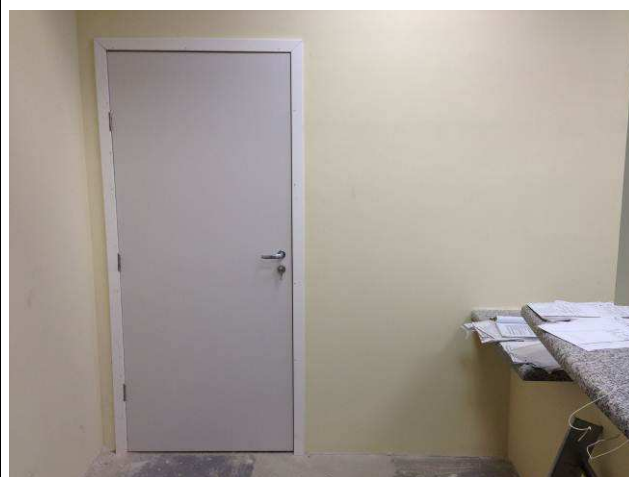
Figura 28C: Portas de madeira instaladas.
