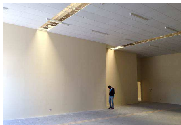
Figura 156C: Pintura com tinta látex acrílica, cor palha – Arquivo.
