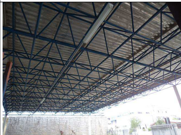
Figura 50E: iluminação – luminárias 2x32W estacionamento e hall.
