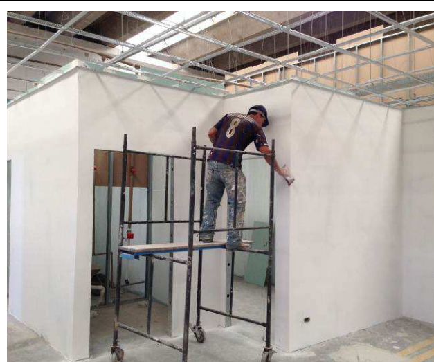
Figura 145C: Emassamento de paredes em gesso acartonado, com massa corrida PVA, utilizando-se desempenadeira de aço.
