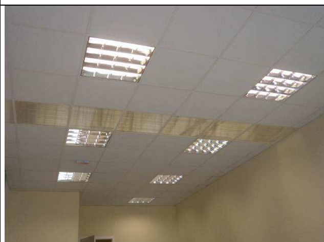
Figura 56E: iluminação – luminárias 4x16W com aletas.
