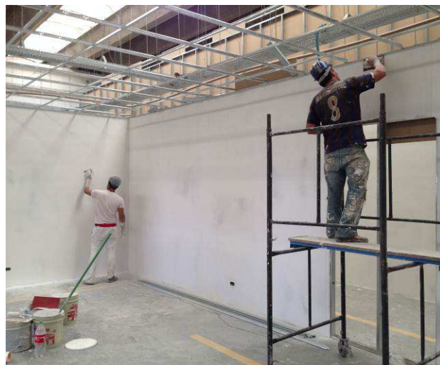
Figura 04C: Andaime para emassamento de parede em gesso acartonado.
