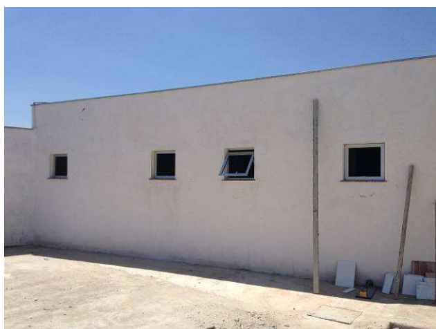
Figura 49C: Janelas J03 – área de terceirizados.
