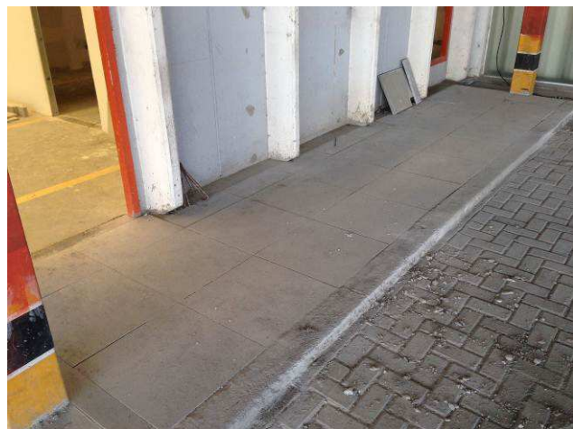
Figura 117C: Calçada concluída com assentamento da pedra basalto no trecho restante.
