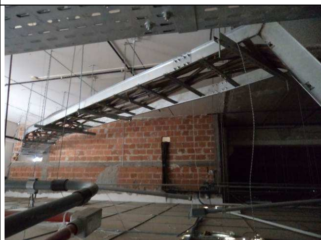
Figura 68E: Quadro QDG/ quadro barramento – novo leito para ramal de entrada de energia.
