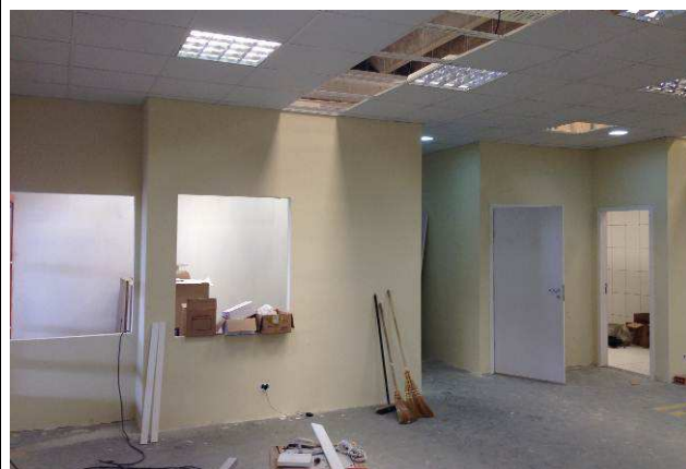
Figura 150C: Pintura com tinta látex acrílica, cor palha, da marca Alessi – Secretaria da 5ª Vara.
