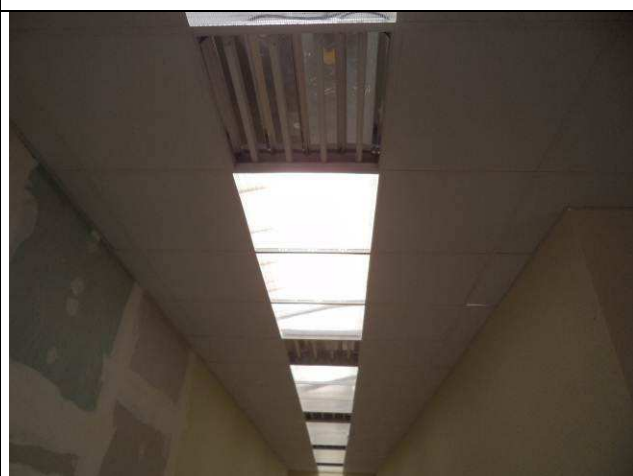
Figura 57E: iluminação – luminárias 4x16W sem aletas.
