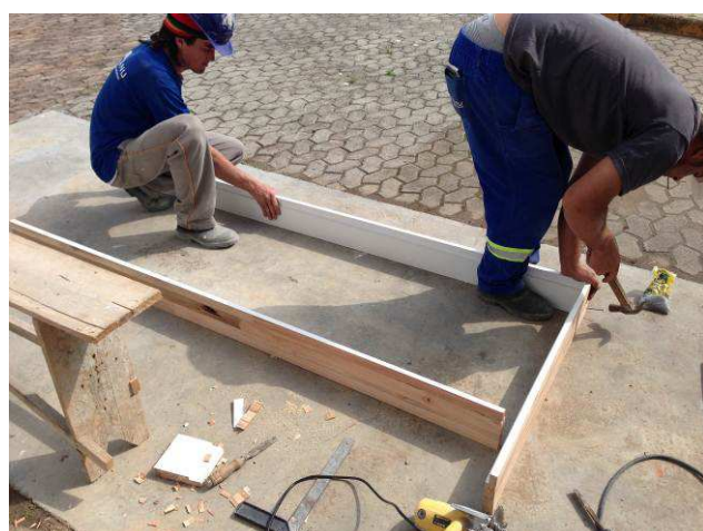
Figura 17C: Montagem dos caixilhos das portas de madeira.
