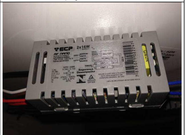
Figura 46E: iluminação - reatores.
