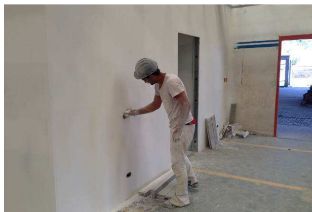
Figura 149C: Lixamento da massa corrida aplicada.
