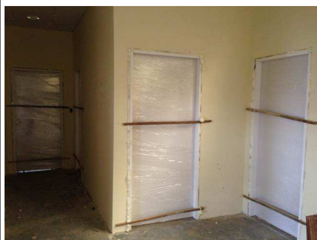
Figura 18C: Montagem dos caixilhos das portas de madeira.
