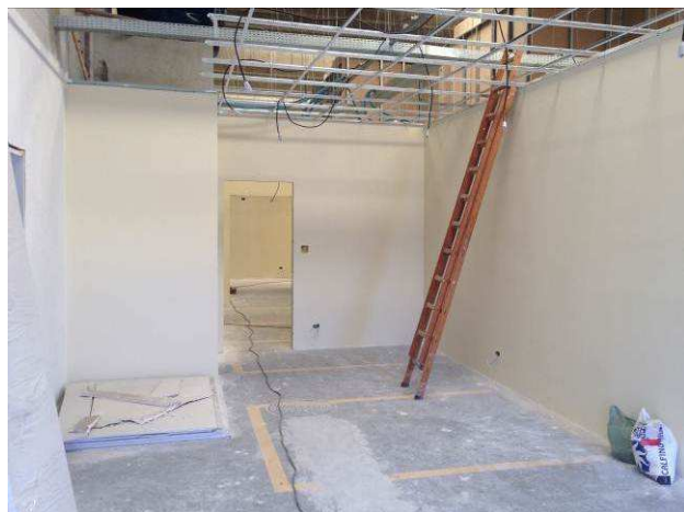
Figura 153C: Pintura com tinta látex acrílica, cor palha – Sala dos Oficiais.
