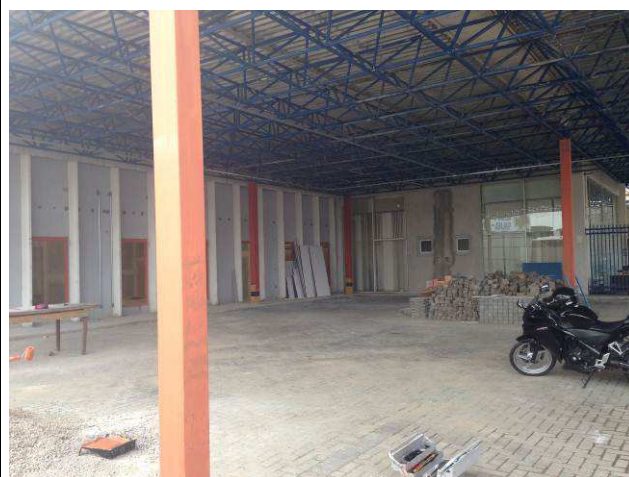
Figura 164C: Aplicação de fundo zarcão nos pilares metálicos do estacionamento.
