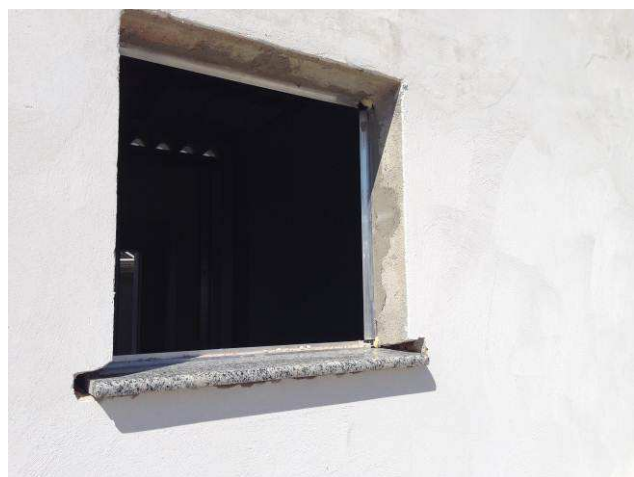
Figura 121C: Peitoril instalado em janela J03 dos vestiários da área de terceirizados.
