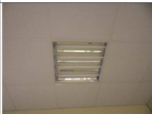
Figura 58E: iluminação – luminárias 4x16W sem aletas.
