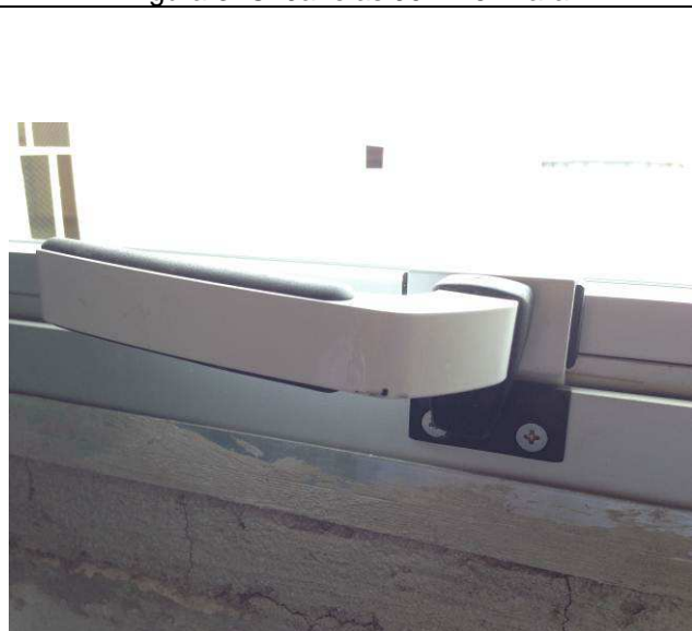
Figura 39C: Janelas J02 – trinco de abertura.
