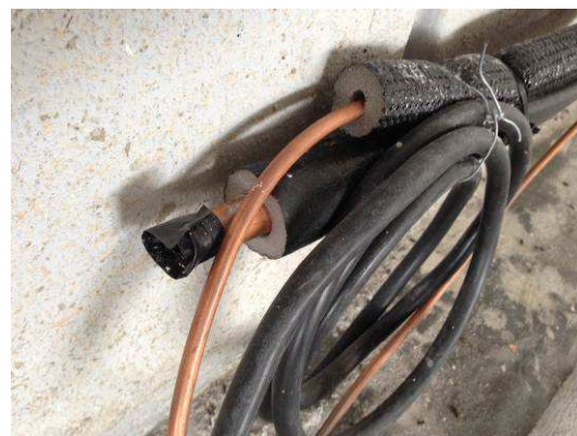
Figura 138: Instalação da rede frigorígena – tubulações de cobre e isolamento.
