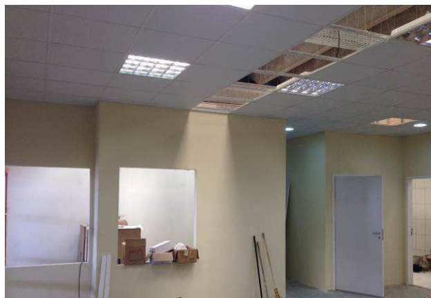
Figura 61C: Forro instalado em área da 5ª Vara.
