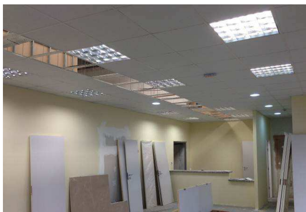
Figura 59C: Forro instalado em área da 5ª Vara.
