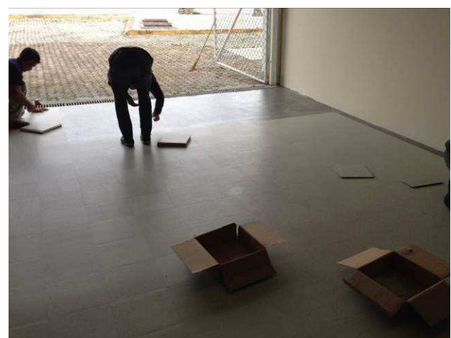
Figura 105C: Instalação do piso vinílico especificado na figura anterior.
