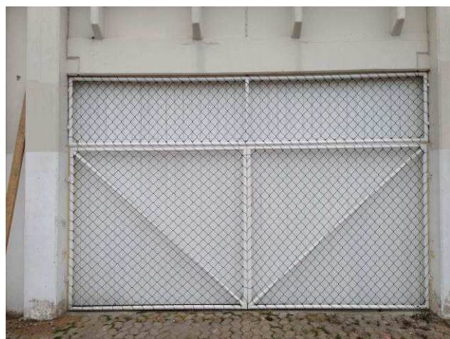
Figura 159C: Pintura com tinta esmalte acetinada – lado externo – portão do Arquivo.
