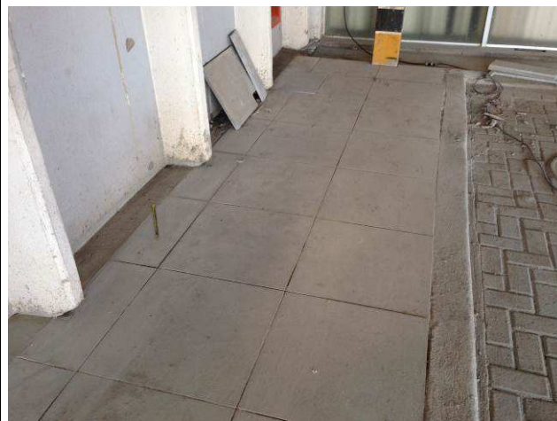
Figura 118C: Calçada concluída com assentamento da pedra basalto no trecho restante.
