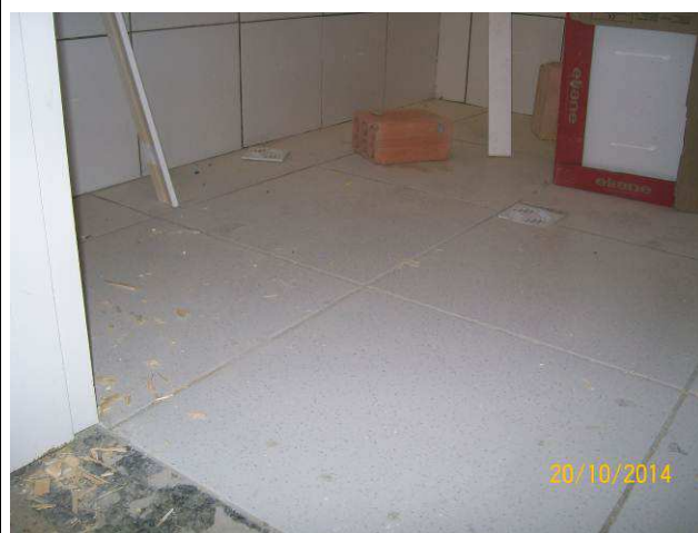
Figura 102C: Piso cerâmico assentado no BWC 2 da sala de estar da Direção do Fórum.
