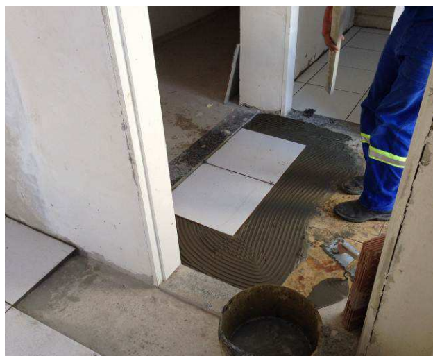
Figura 109C: Assentamento de piso cerâmico na circulação entre a copa e área de serviço.
