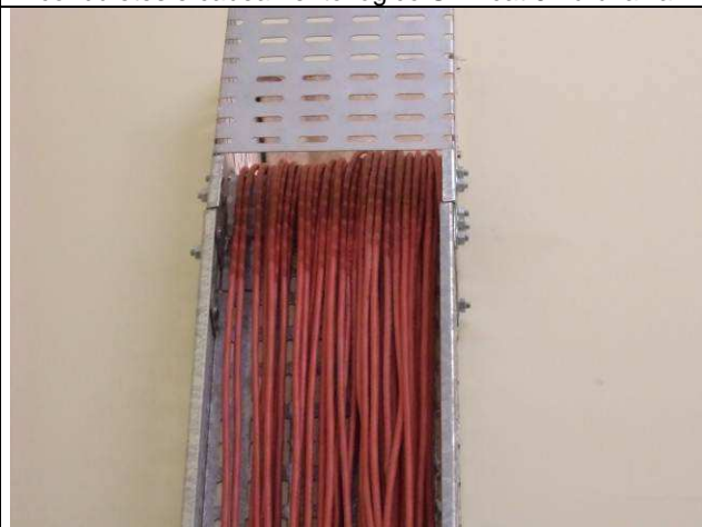
Figura 80E: cabeamento lógico UTP cat 6 Furukawa.
