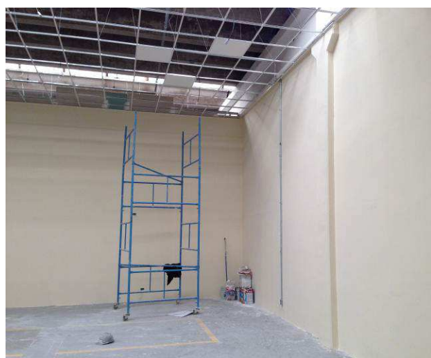
Figura 02C: Andaime para montagem de estrutura de forro modular.
