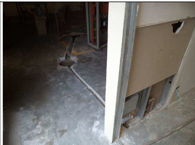
Figura 01E: Infraestrutura elétrica – corte em piso e demolição para passagem de eletrodutos sob o piso – sala de audiências.
