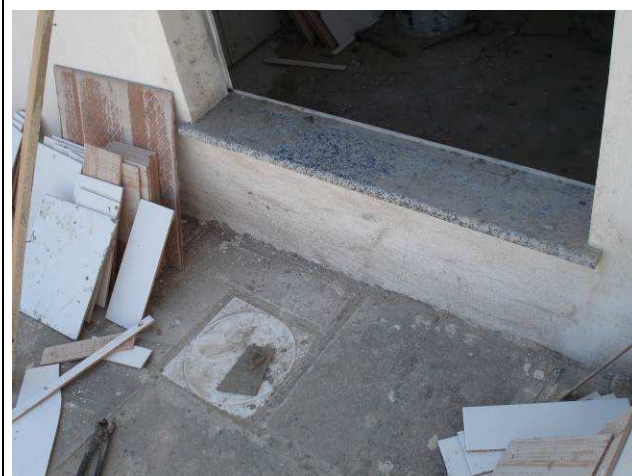
Figura 124C: Detalhe do peitoril (com pingadeira) instalado em janela J04.
