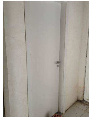
Figura 46C: Portas de madeira instaladas.
