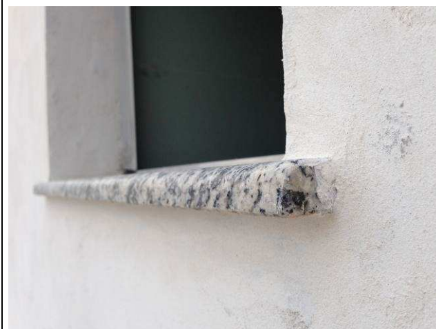
Figura 122C: Detalhe do peitoril (com pingadeira) instalado em janela J03.
