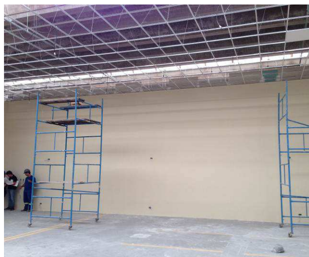
Figura 54C: Continuação da montagem dos perfis metálicos na área de arquivo.
