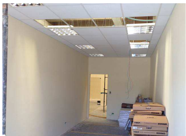
Figura 57C: Forro de gesso acartonado instalado na sala da Direção do Fórum.
