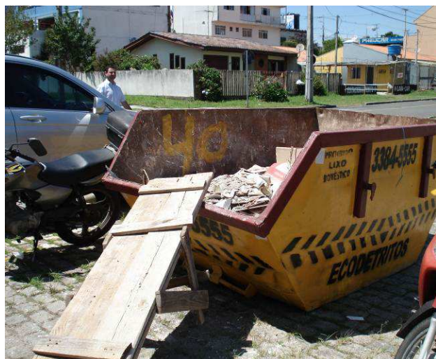
Figura 05C: Caçamba para coleta de entulhos.
