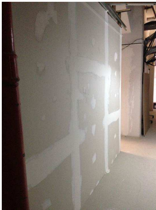
Figura 16C: Montagem de paredes de gesso acartonado ST- simples do depósito SG.
