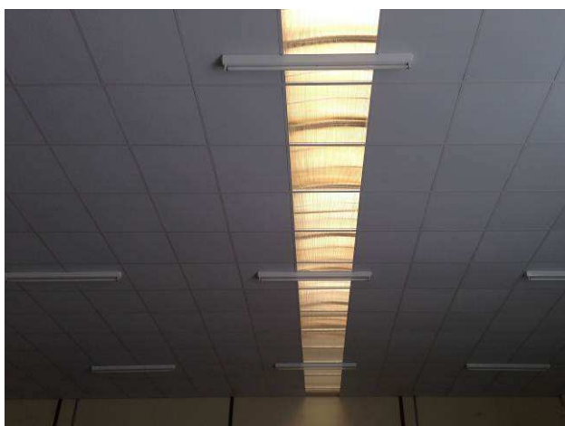
Figura 66C: Detalhe do forro em policarbonato alveolar.
