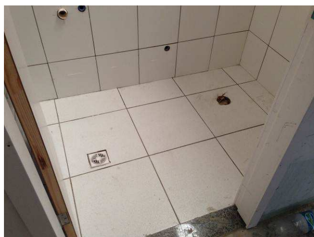
Figura 95C: Piso cerâmico assentado no BWC juiz da 5ª Vara.
