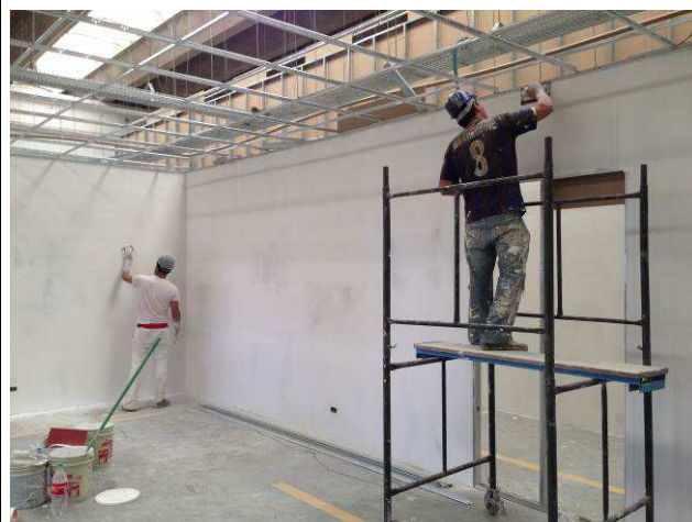
Figura 148C: Emassamento e lixamento de parede em gesso acartonado da 5ª Vara.
