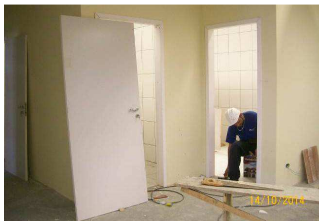
Figura 23C: Fechaduras instaladas – marca Papaiz.
