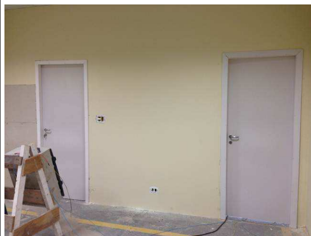
Figura 30C: Portas de madeira instaladas.
