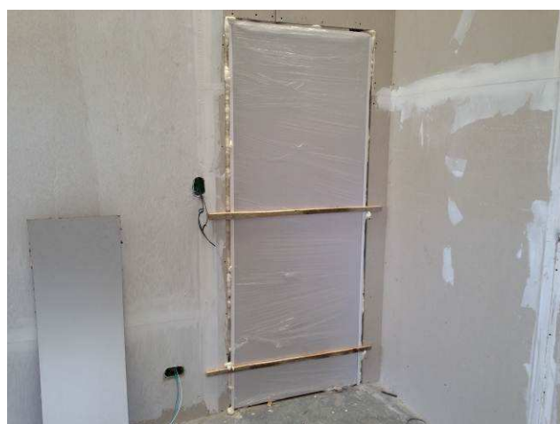
Figura 19C: Montagem dos caixilhos das portas de madeira.
