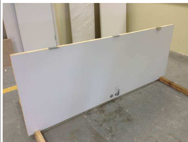
Figura 22C: Montagem das fechaduras e dobradiças.
