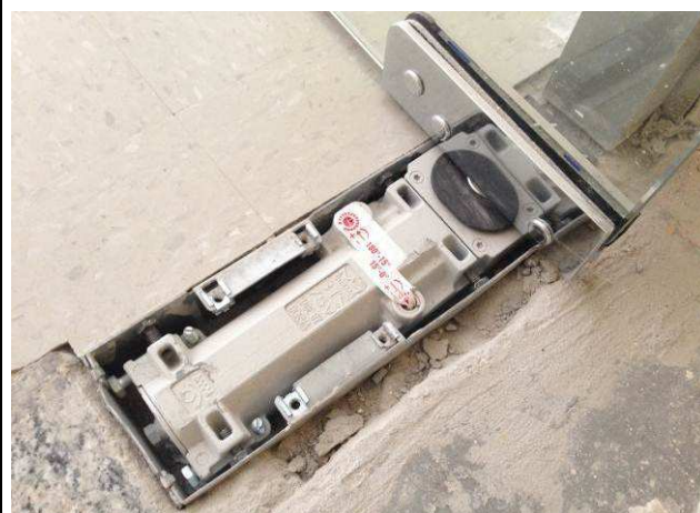
Figura 34C: Porta de vidro – mola de piso Dorma.
