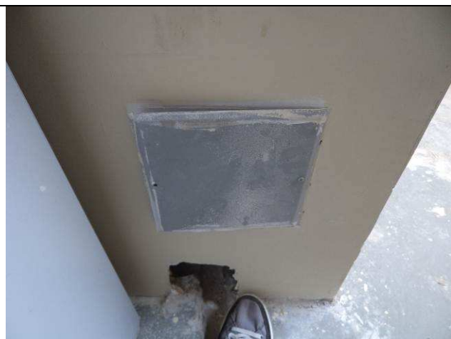
Figura 75E: Infra-estrutura lógica – caixa passagem sala audiências.
