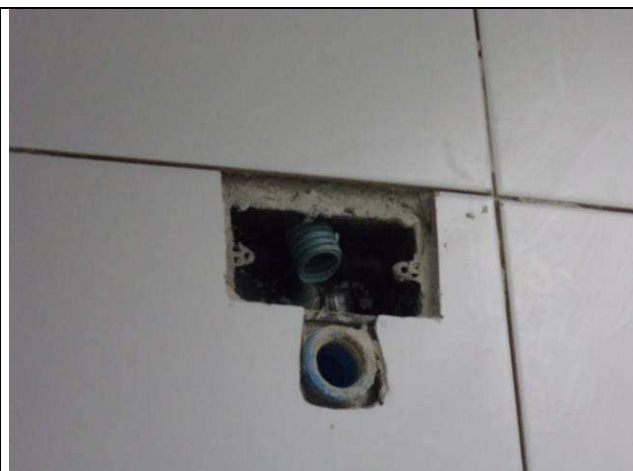
Figura 17E: Infraestrutura elétrica – caixas 2x4, 4x4 e condutores.
