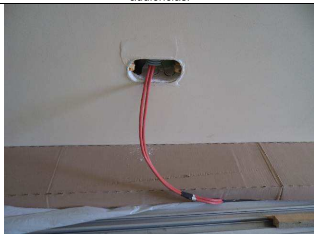
Figura 77E: Infra-estrutura lógica – caixas 2x4", 4x4" e condutes e cabeamento lógico UTP cat 6 Furukawa.
