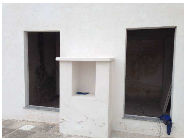
Figura 123C: Peitoris instalados em janelas J04 da copa da área de terceirizados.
