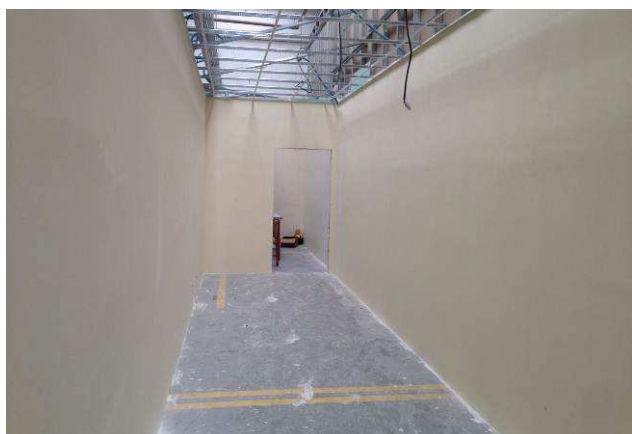
Figura 155C: Pintura com tinta látex acrílica, cor palha – Circulação.
