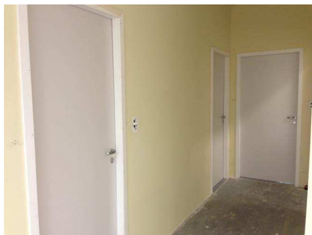
Figura 29C: Portas de madeira instaladas.
