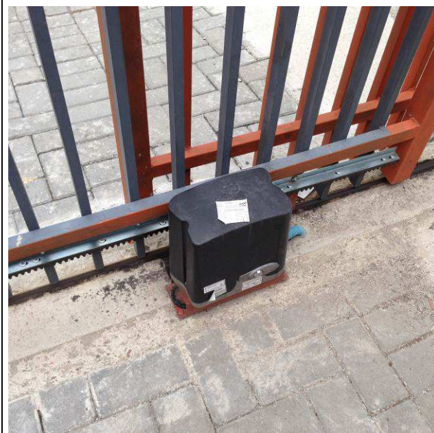
Figura 144: Detalhe do motor – marca PPA.
