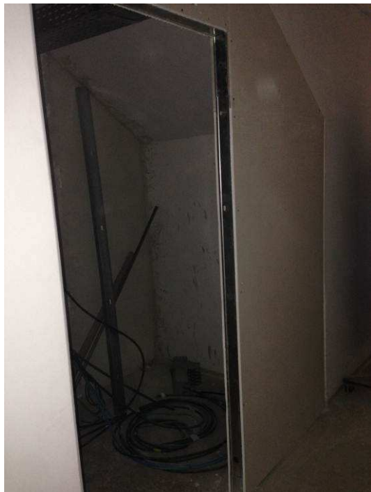
Figura 11C: Montagem de paredes de gesso acartonado ST- simples da Sala Técnica.
