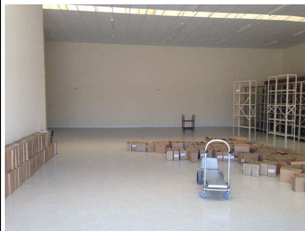
Figura 108C: Piso vinílico instalado
