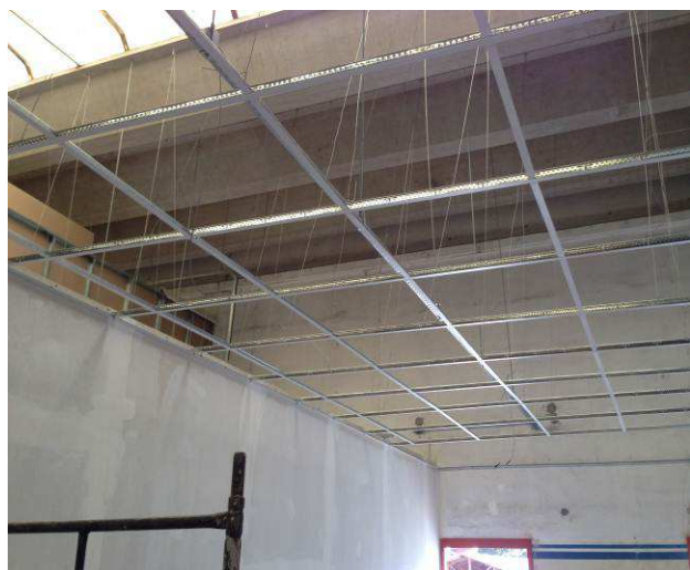
Figura 53C: Montagem dos perfis metálicos na sala de Oficiais de Justiça.
