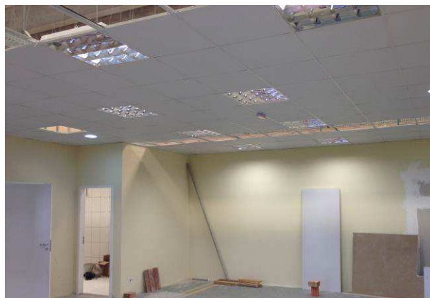
Figura 62C: Forro instalado em área da 5ª Vara.
