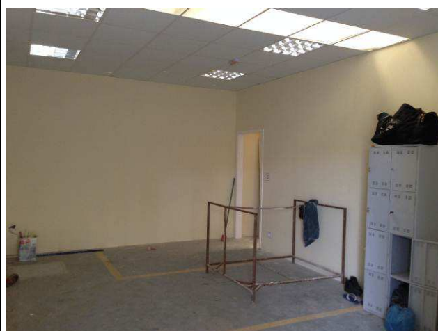
Figura 152C: Pintura com tinta látex acrílica, cor palha – Sala de Audiências.
