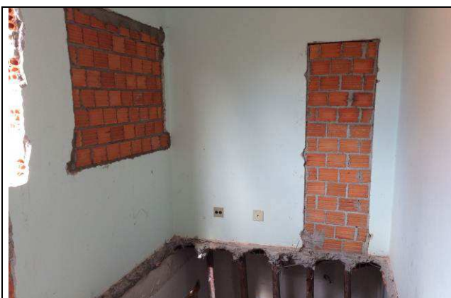
Figura 59C: Paredes de alvenaria – fechamento dos vãos.
