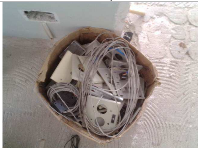
Figura 07E: Retirada das instalações de telefonia existentes – pavimento térreo.
