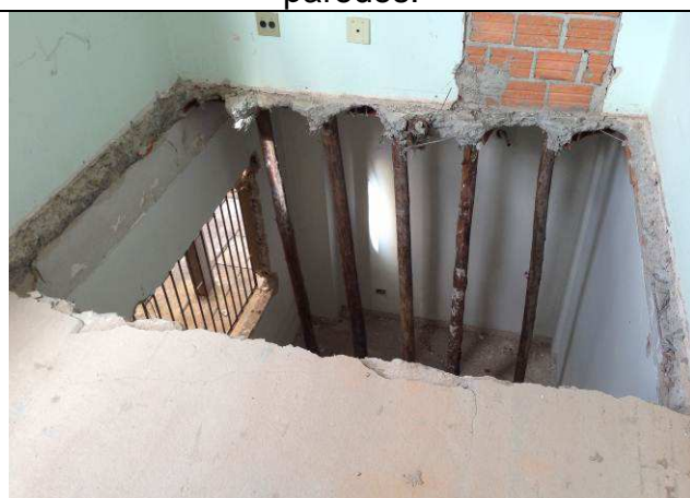
Figura 17C: Demolição de laje de concreto – abertura da escada metálica.
