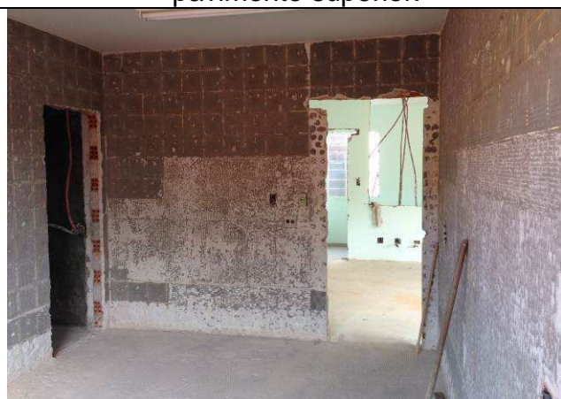
Figura 23C: Demolição de piso cerâmico – sala de audiências pavimento superior.
