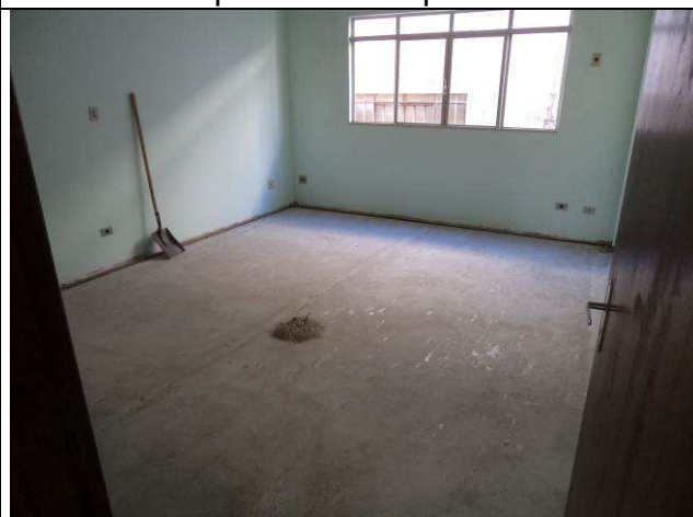
Figura 22C: Demolição de piso de madeira e rodapés – pavimento superior.
