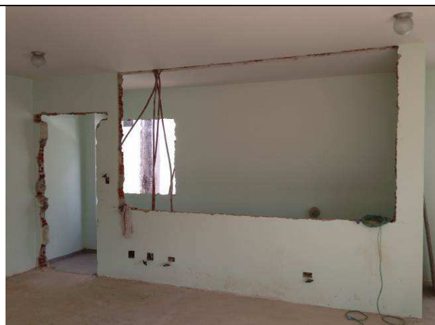
Figura 13C: Demolição de alvenaria – paredes.
