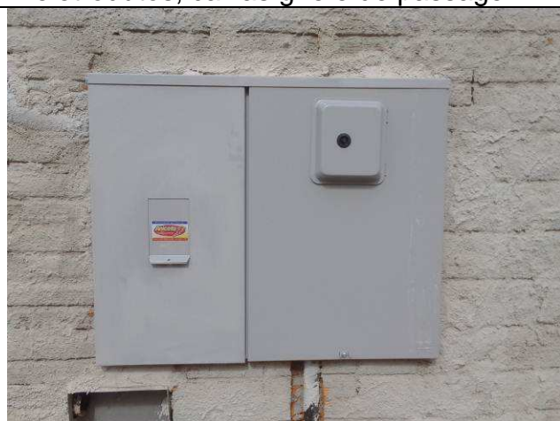
Figura 11E: Nova entrada de energia e telecomunicações – mureta, eletrodutos, caixas gne e de passagem.
