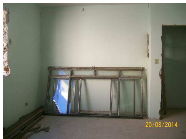
Figura 47C: Remoção de esquadrias metálicas – pavimento superior.
