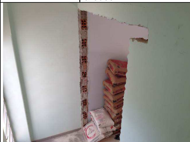
Figura 16C: Demolição de alvenaria – paredes.
