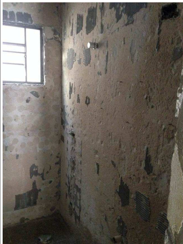
Figura 38C: Remoção de azulejo – banheiro pavimento inferior.
