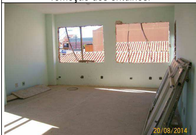
Figura 05C: Demolição de alvenaria – abertura de vãos de janelas.
