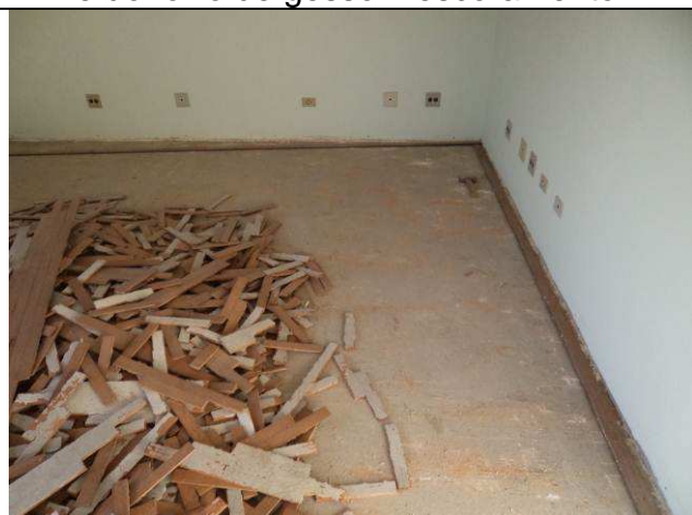
Figura 21C: Demolição de piso de madeira – pavimento superior.
