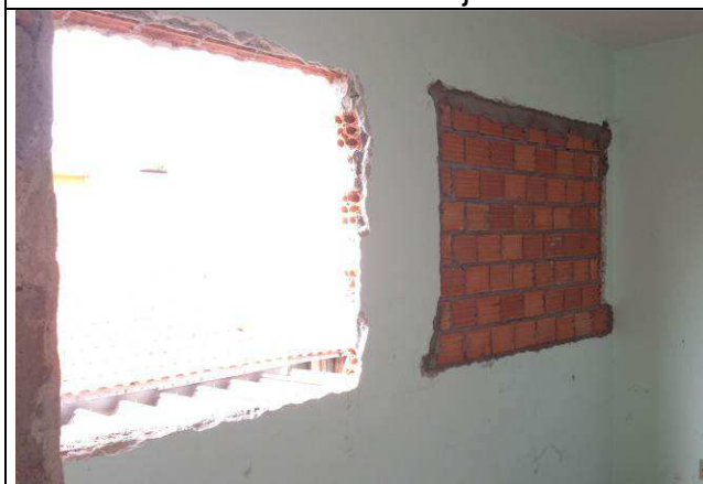
Figura 07C: Demolição de alvenaria – abertura de vãos de janelas.
