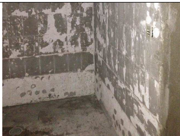
Figura 25C: Demolição de piso cerâmico – banheiro pavimento superior.
