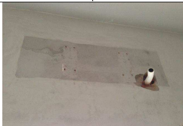
Figura 57C: Remoção de aparelhos de ar condicionado.
