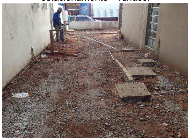
Figura 54C: Remoção do piso do estacionamento – lateral direita.
