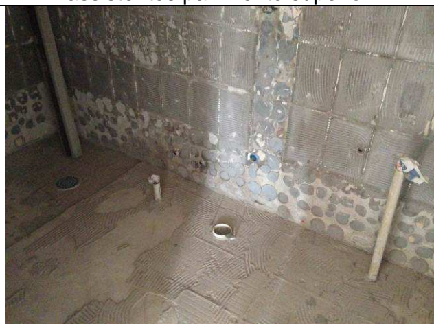
Figura 41C: Remoção de louças – banheiro pavimento superior.
