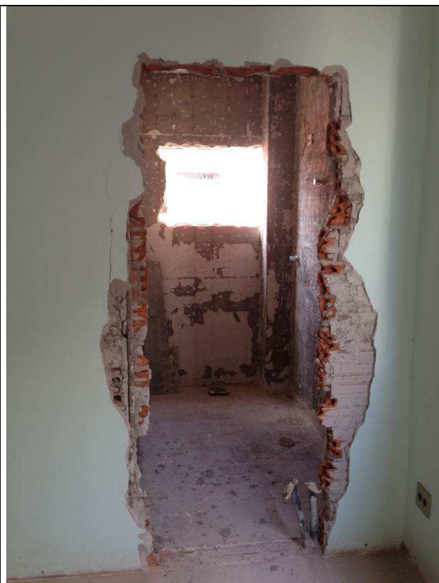
Figura 10C: Demolição de alvenaria – abertura de vãos de portas.
