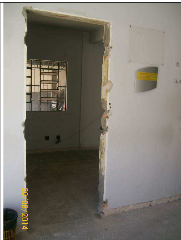
Figura 46C: Remoção de esquadrias de madeira – pavimento inferior.
