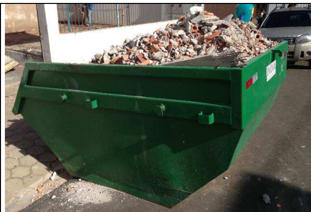
Figura 04C: Caçamba utilizada para remoção dos entulhos.
