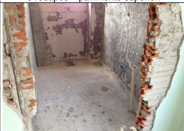
Figura 24C: Demolição de piso cerâmico – banheiro pavimento superior.
