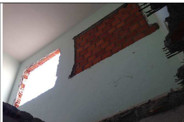
Figura 60C: Paredes de alvenaria – fechamento dos vãos.
