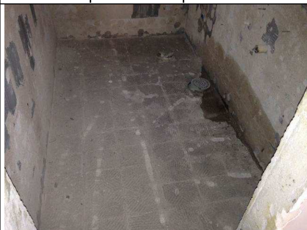
Figura 42C: Remoção de louças – banheiro pavimento inferior.
