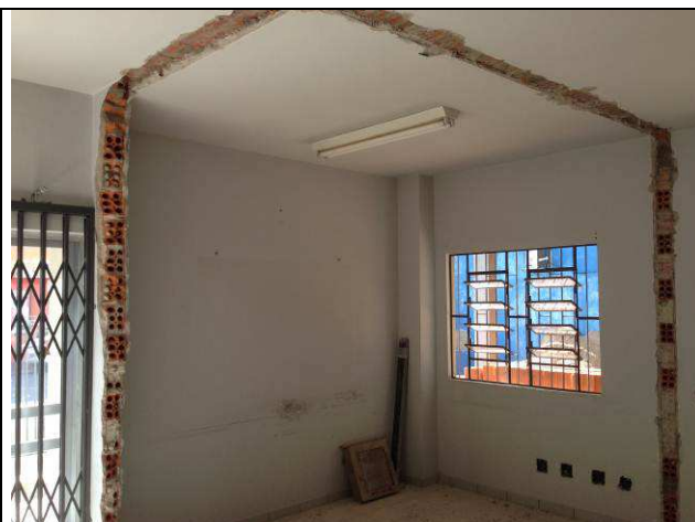
Figura 14C: Demolição de alvenaria – paredes.
