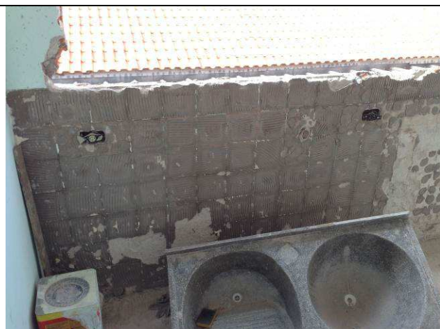
Figura 39C: Remoção de azulejo – sala de assistentes pavimento superior.
