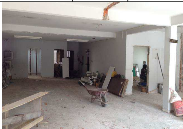
Figura 27C: Demolição de piso cerâmico – secretaria pavimento inferior.
