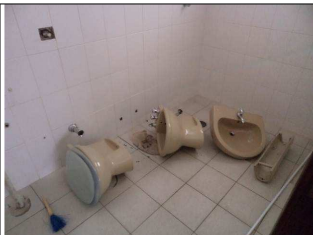
Figura 40C: Remoção de louças – banheiro pavimento superior.
