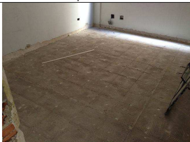
Figura 30C: Demolição de piso cerâmico – secretaria pavimento inferior.
