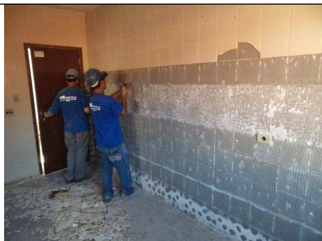
Figura 35C: Remoção de azulejo – sala de audiências pavimento superior.
