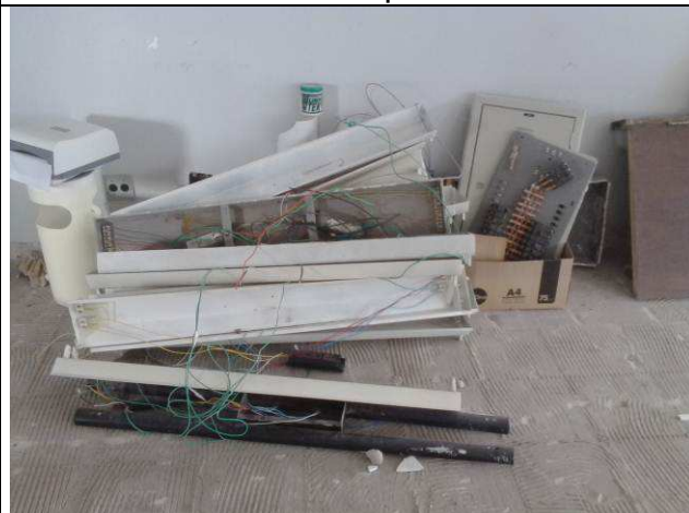
Figura 06E: Retirada das instalações elétricas existentes – pavimento térreo.
