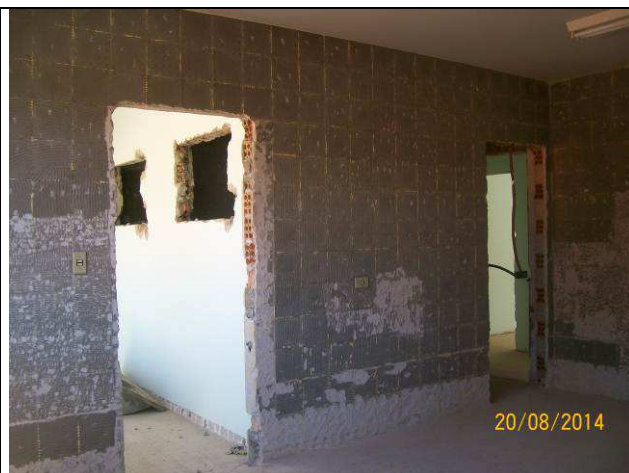
Figura 36C: Remoção de azulejo – sala de audiências pavimento superior.
