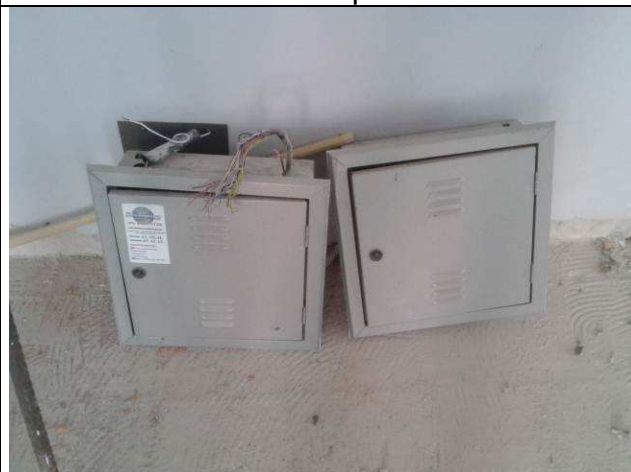
Figura 08E: Retirada das instalações de telefonia existentes – pavimento térreo.
