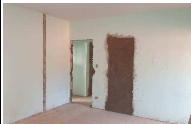
Figura 61C: Revestimentos internos – chapisco/emboço dos vãos fechados.
