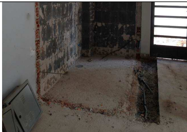
Figura 28C: Demolição de piso cerâmico – banheiro pavimento inferior.
