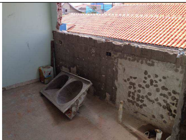
Figura 26C: Demolição de piso cerâmico – sala de assistentes pavimento superior.
