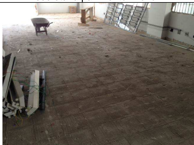
Figura 29C: Demolição de piso cerâmico – secretaria pavimento inferior.
