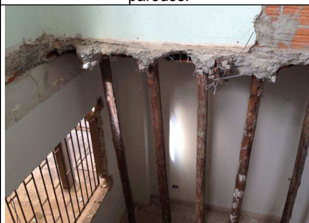
Figura 18C: Demolição de laje de concreto – abertura da escada metálica.
