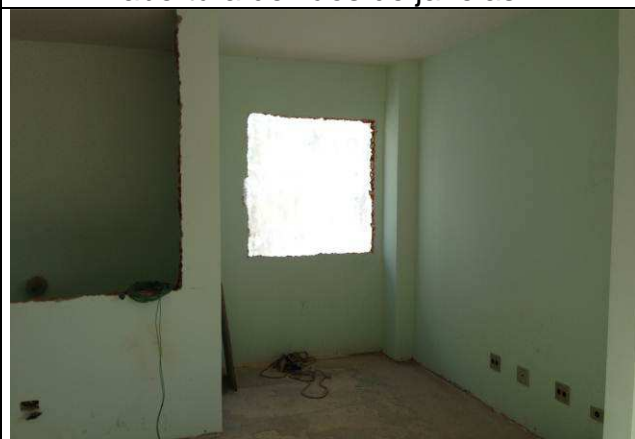
Figura 08C: Demolição de alvenaria – abertura de vãos de janelas.
