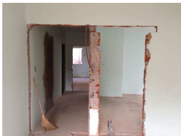
Figura 11C: Demolição de alvenaria – abertura de vãos de portas.
