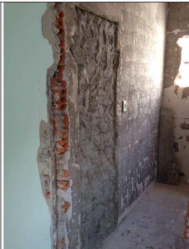
Figura 62C: Revestimentos internos – chapisco/emboço dos vãos fechados.
