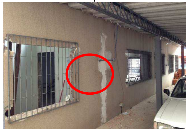
Figura 58C: Remoção de aparelhos de ar condicionado – secretaria (externa).
