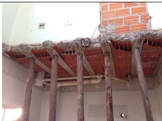
Figura 19C: Demolição de laje de concreto e do forro de gesso – escoramento.
