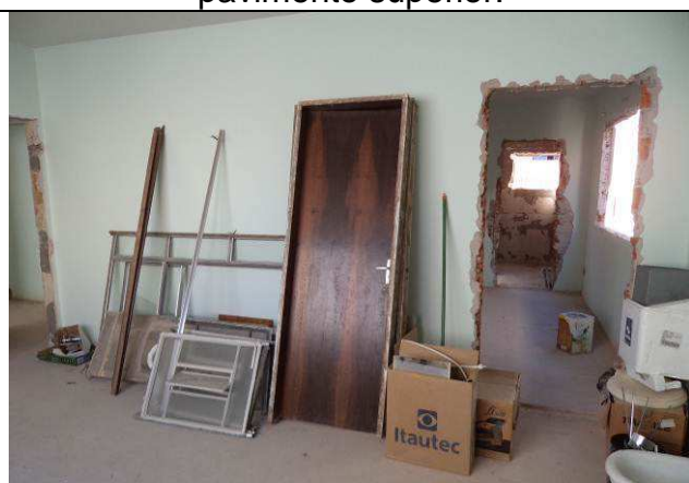
Figura 43C: Remoção de esquadrias de madeira – pavimento superior.
