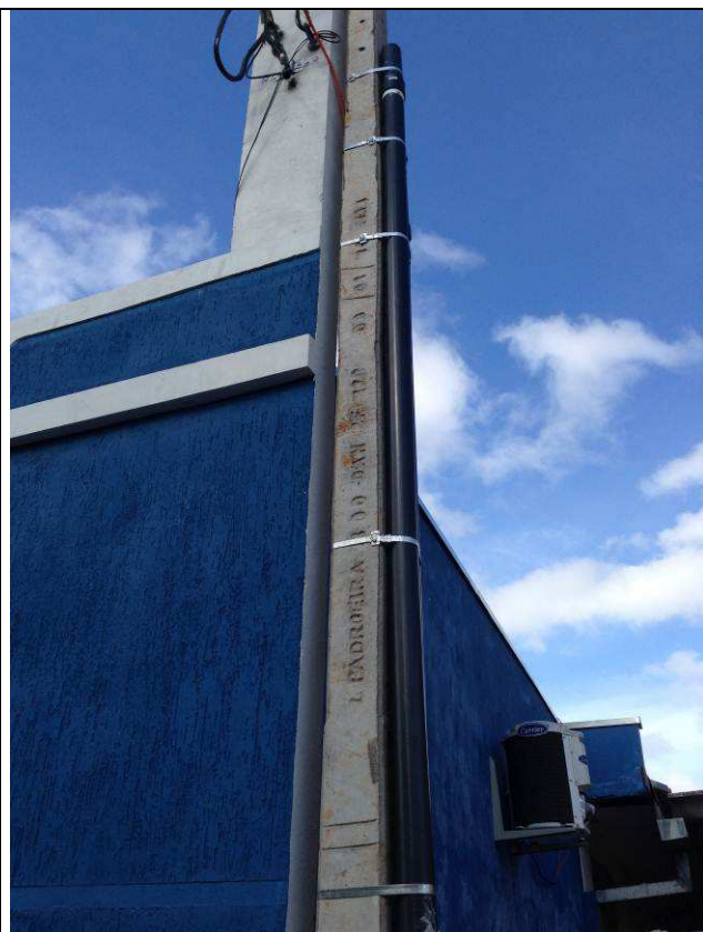
Figura 10E: Nova entrada de energia e telecomunicações – poste, eletrodutos.
