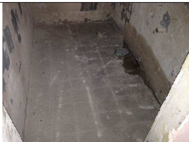
Figura 31C: Demolição de piso cerâmico – banheiro pavimento inferior.
