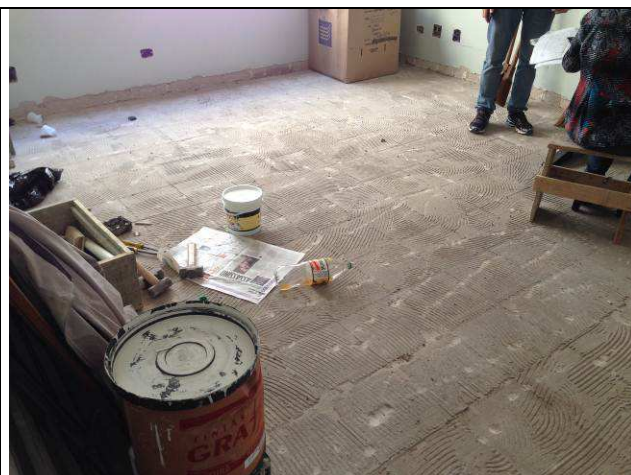
Figura 32C: Demolição de piso cerâmico – secretaria pavimento inferior.
