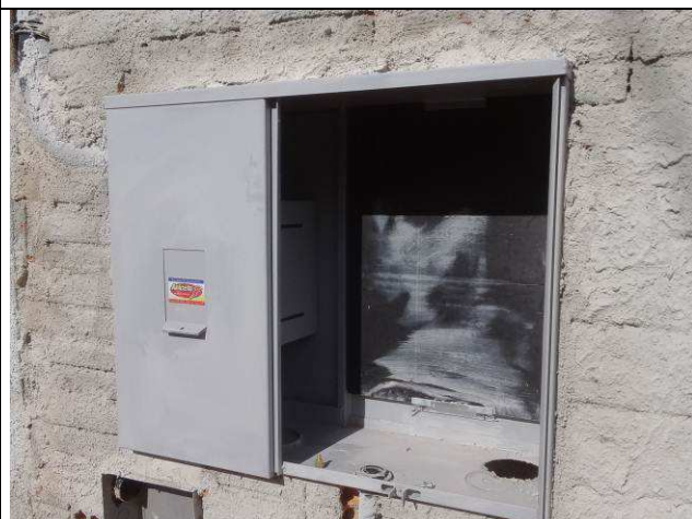
Figura 12E: Nova entrada de energia e telecomunicações – mureta, eletrodutos, caixas gne e de passagem.
