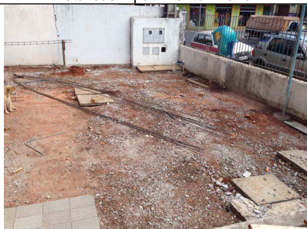
Figura 51C: Remoção do piso do estacionamento – frente.
