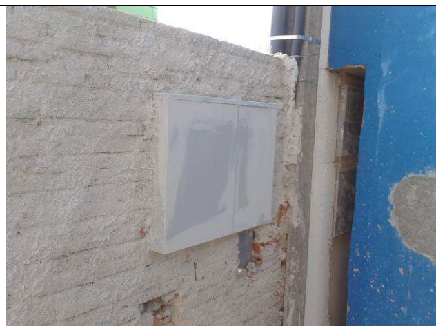
Figura 13E: Nova entrada de energia e telecomunicações – mureta, eletrodutos, caixas gne e de passagem.
