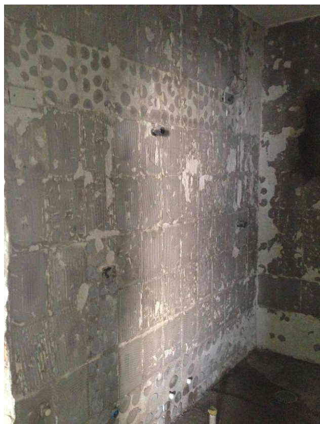
Figura 33C: Remoção de azulejo – banheiro pavimento superior.
