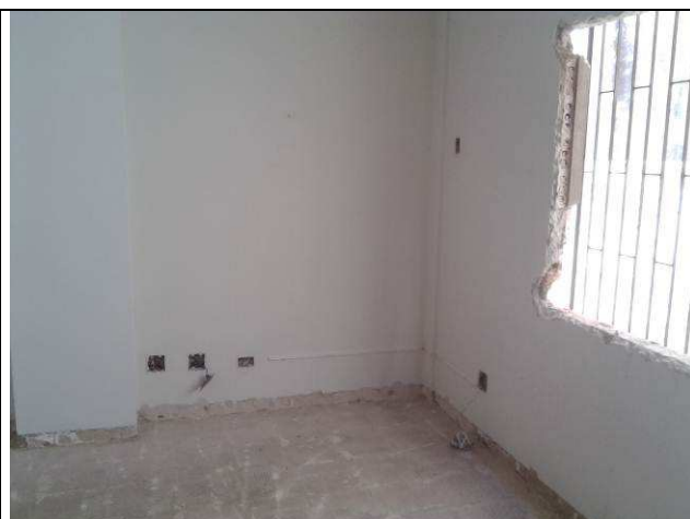
Figura 02E: Retirada das instalações elétricas existentes – pavimento térreo.
