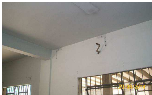
Figura 55C: Remoção de aparelhos de ar condicionado – evaporadora secretaria.
