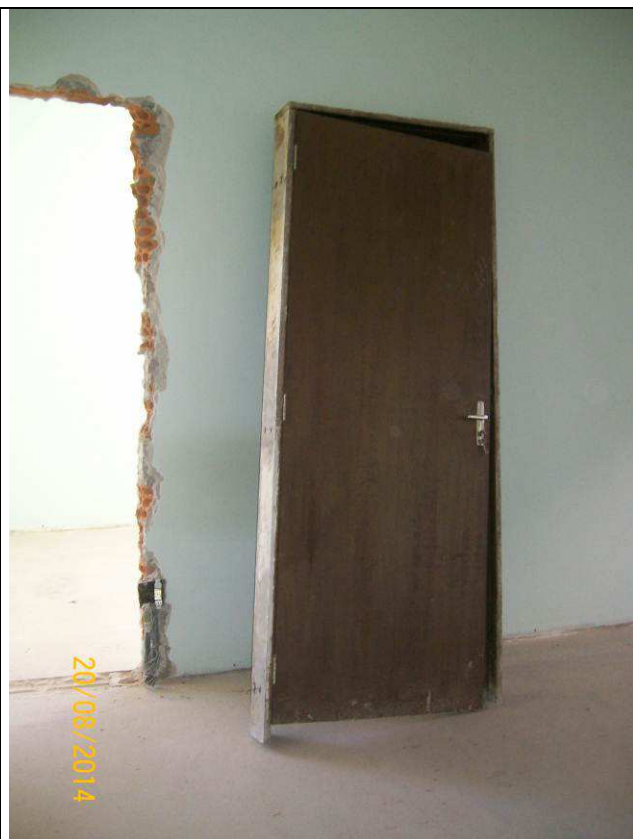
Figura 45C: Remoção de esquadrias de madeira – pavimento superior.
