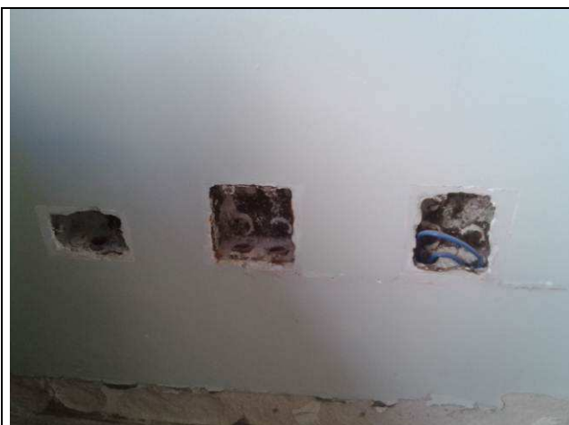
Figura 01E: Retirada das instalações elétricas existentes – pavimento térreo.
