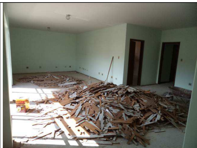
Figura 20C: Demolição de piso de madeira – pavimento superior.
