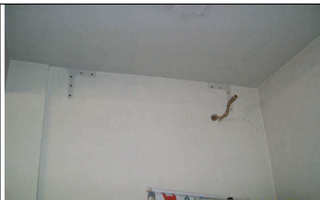
Figura 56C: Remoção de aparelhos de ar condicionado – evaporadora secretaria.
