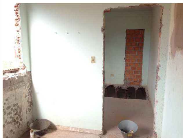
Figura 12C: Demolição de alvenaria – abertura de vãos de portas.
