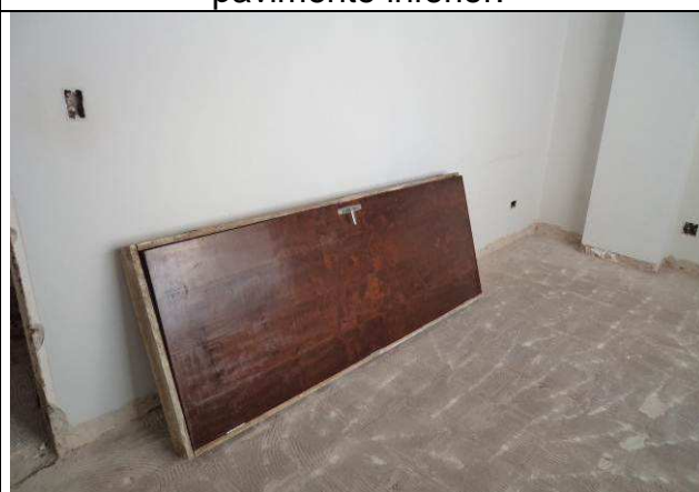
Figura 44C: Remoção de esquadrias de madeira – pavimento inferior.
