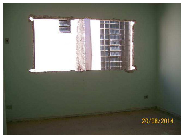
Figura 48C: Remoção de esquadrias metálicas – pavimento superior.
