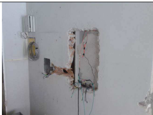
Figura 03E: Retirada das instalações elétricas existentes – pavimento térreo.
