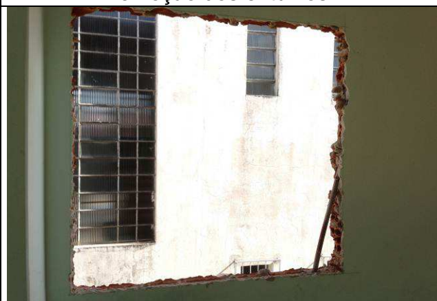
Figura 06C: Demolição de alvenaria – abertura de vãos de janelas.
