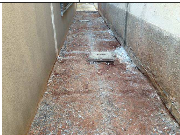
Figura 52C: Remoção do piso do estacionamento – fundos.
