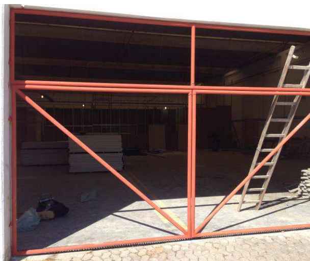
Figura 28C: Montagem da estrutura do portão em tubos de aço galvanizado, com dimensões 4,6 x3,0m, nos fundos do arquivo.
