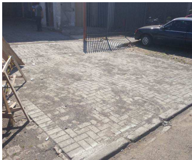
Figura 44C: Pavimentação com blocos de concreto em área externa de acesso de veículos.
