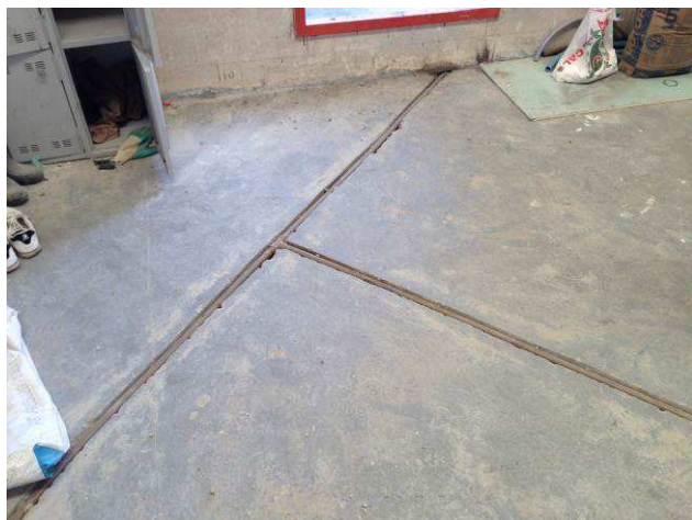
Figura 63C: Execução de drenos em tubos de PVC soldável (25mm), para evaporadoras da 5ª Vara.
