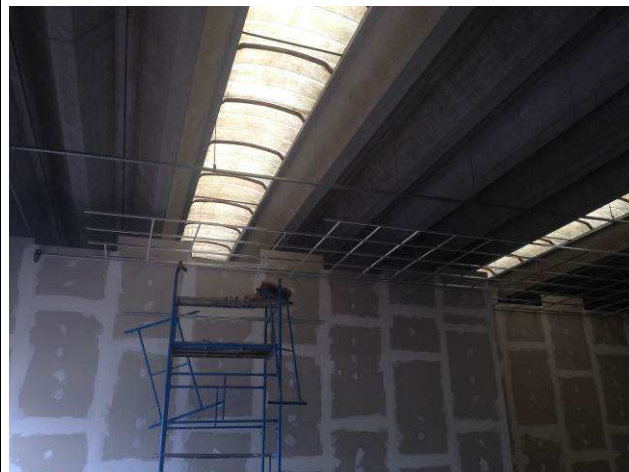
Figura 04C: Andaime para montagem de forros modulares.
