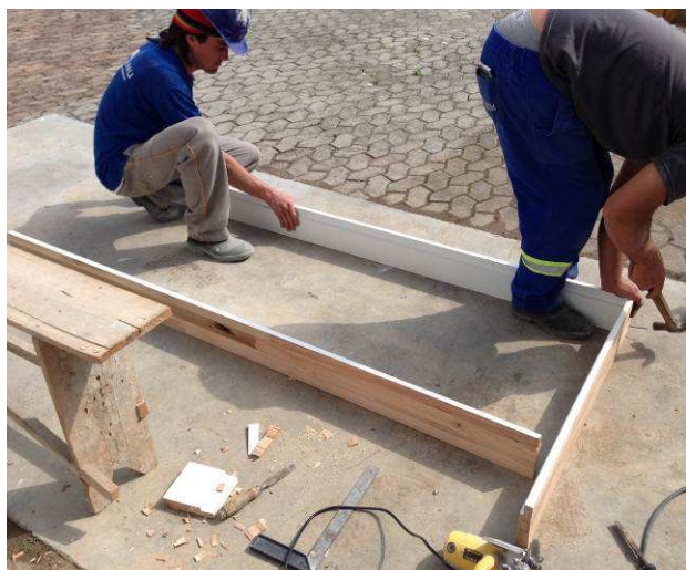
Figura 30C: Montagem de batentes de porta de madeira.
