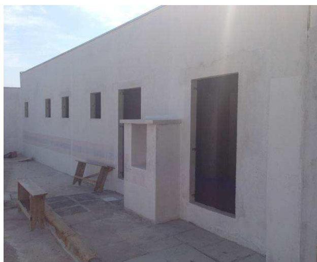
Figura 74C: 1ª demão de fundo (selador) acrílico na cor branca, em área de terceirizados.
