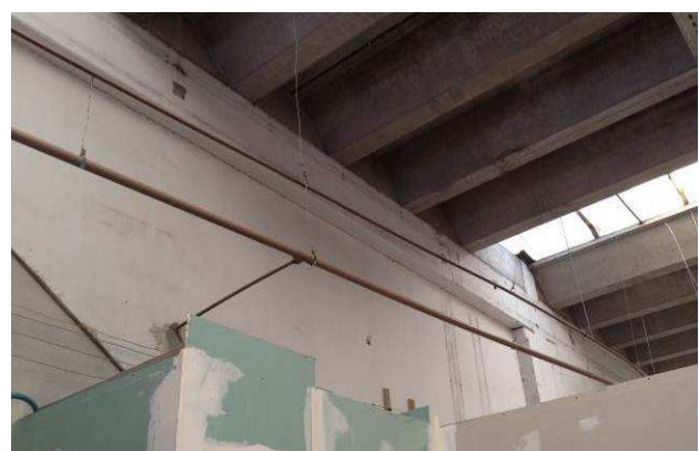
Figura 61C: Finalização de execução da rede de água fria (32mm).
