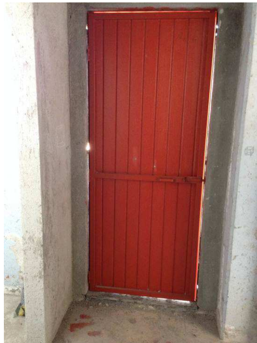
Figura 35C: Face interna da porta metálica na entrada da área de terceirizados.
