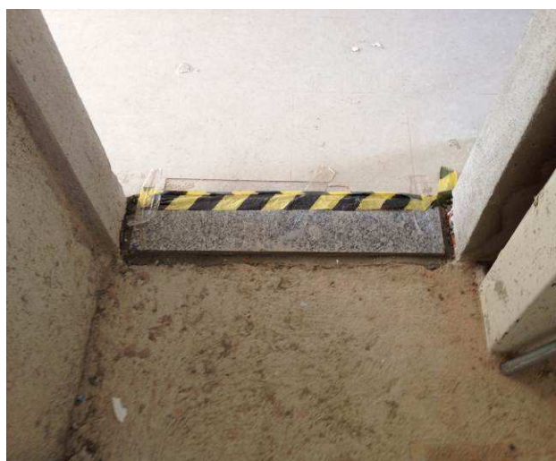
Figura 51C: Soleira em granito polido cinza andorinha instalada no acesso ao corredor de circulação da área de terceirizados.
