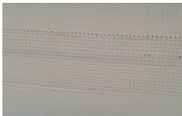
Figura 15C: Fita telada utilizada nas juntas das paredes em gesso acartonado RU e ST-duplo.
