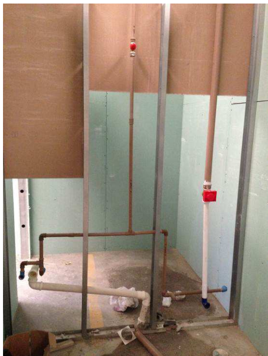
Figura 55C: À direita, execução de ponto de água fria (32mm) para bacia sanitária do banheiro PNE da secretaria da 5 Vara.
