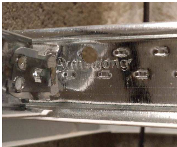
Figura 43C: Detalhe de perfil metálico tipo "T" da marca Armstrong.
