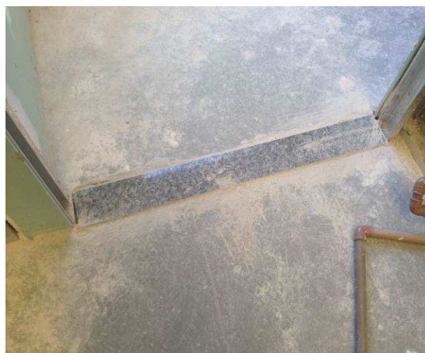
Figura 48C: Soleira em granito polido cinza andorinha instalada em vão sob porta da 5ª Vara do Trabalho.
