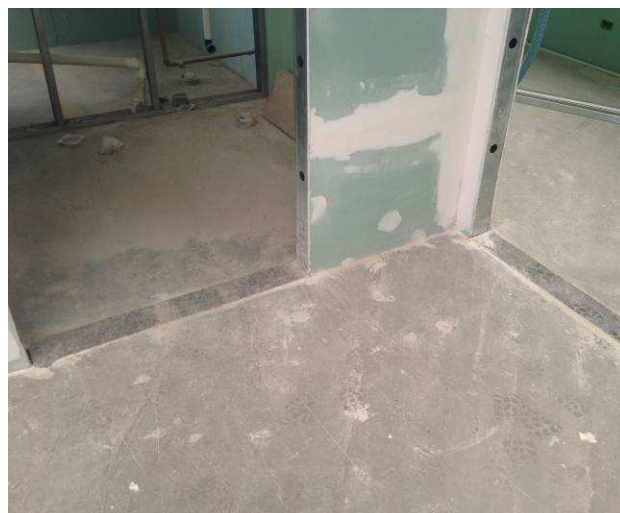
Figura 46C: Soleiras em granito polido cinza andorinha instaladas em vãos sob portas da 5ª Vara do Trabalho.
