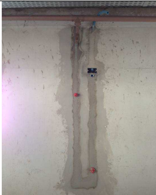
Figura 69C: Instalação de registros de gaveta e de pressão para chuveiro em banheiro da área de terceirizados. Ambos da marca Docol.
