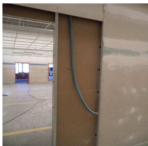
Figura 14E: eletrodutos corrugados – área barracão.
