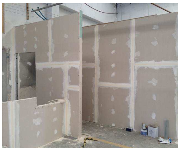
Figura 13C: Parede em gesso acartonado ST-simples com juntas fitadas e emassadas.
