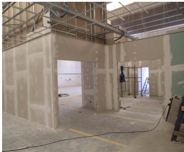
Figura 23C: Vista das áreas de arquivo e Direção do Fórum, com respectivas paredes executadas.
