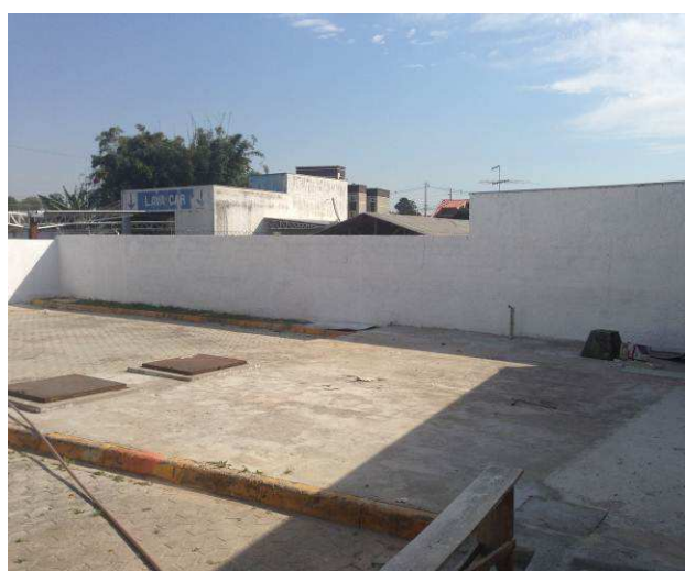
Figura 72C: 1ª demão de fundo (selador) acrílico na cor branca, em área nos fundos do terreno.
