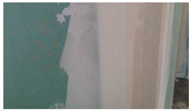
Figura 19C: Detalhe do acabamento do cantos das paredes, utilizando-se da fita ao lado.
