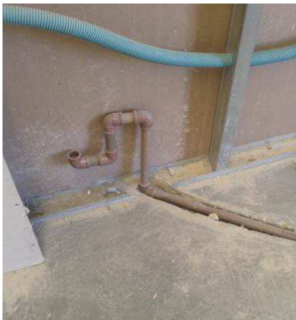
Figura 65C: Execução de sifão para evitar o retorno de mal cheiro.
