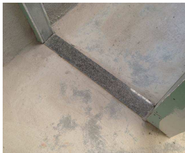
Figura 47C: Soleira em granito polido cinza andorinha instalada em vão sob porta da 5ª Vara do Trabalho.
