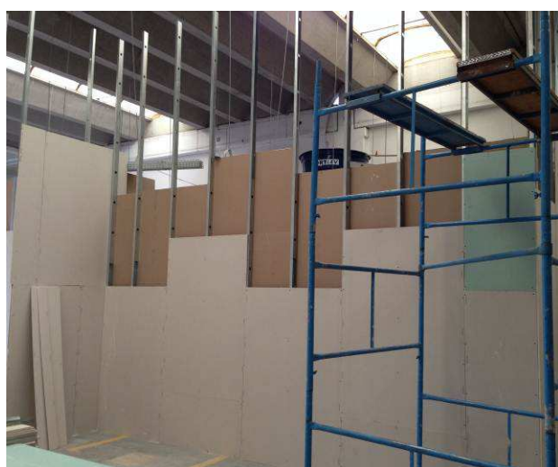
Figura 01C: Andaime para montagem de paredes em gesso acartonado.
