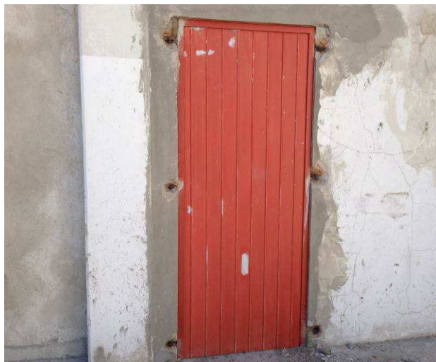
Figura 34C: Face externa da porta metálica na entrada da área de terceirizados.
