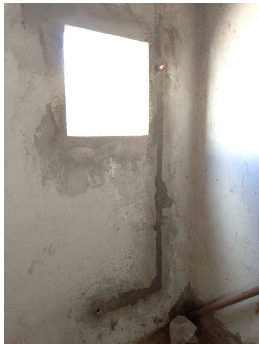
Figura 68C: Finalização de pontos de água fria (25mm) em banheiro da área de terceirizados.
