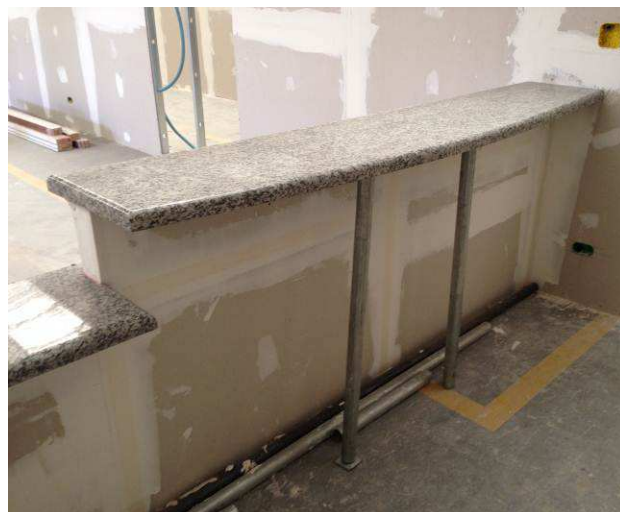
Figura 27C: Balcão mostrado ao lado, com tampo em granito cinza andorinha e acabamento meio boleado nas bordas. Tubos cromados serão instalados em outra etapa.
