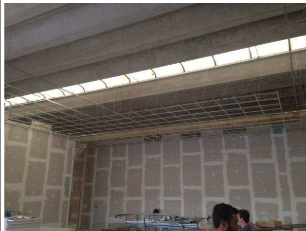
Figura 39C: Montagem dos perfis metálicos em área da 5ª Vara do Trabalho - arquivo.
