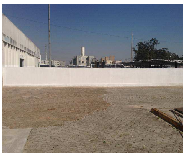
Figura 73C: 1ª demão de fundo (selador) acrílico na cor branca, em área nos fundos do terreno.
