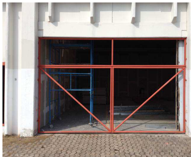
Figura 29C: Montagem da estrutura do portão em tubos de aço galvanizado, com dimensões 4,6 x3,0m, nos fundos do arquivo.
