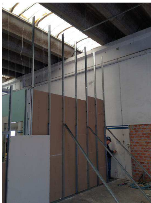
Figura 07C: À direita, detalhe da estrutura metálica descrita na figura ao lado.
