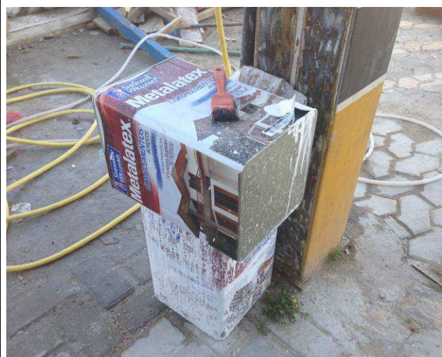
Figura 75C: Fundo (selador) acrílico, na cor branca, aplicado (Metalatex - Sherwin Williams).
