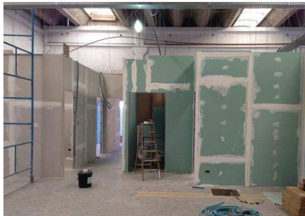
Figura 10C: Paredes de gesso acartonado ST-simples e RU-verde, em área da 5ª Vara.
