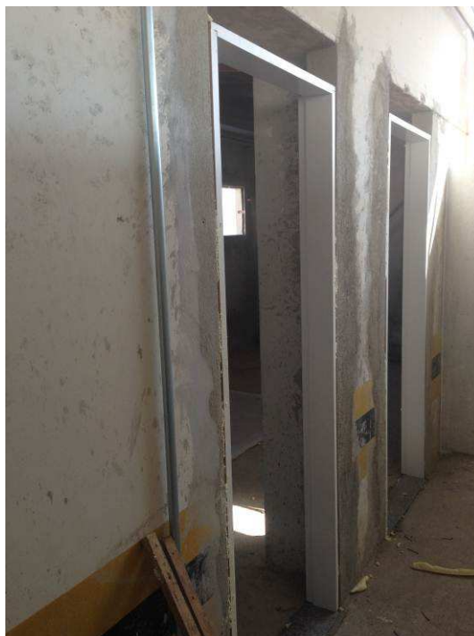
Figura 33C: Portas em madeira (PM80) com fundo primer branco, instaladas nos vestiários.
