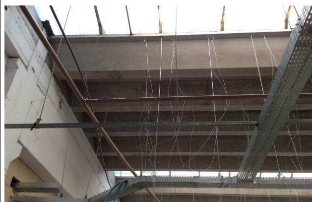
Figura 62C: Finalização de execução da rede de água fria (32mm).
