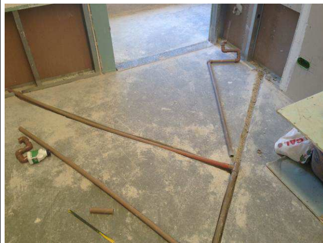
Figura 64C: Execução de drenos em tubos de PVC soldável (25mm), para evaporadoras da 5ª Vara.
