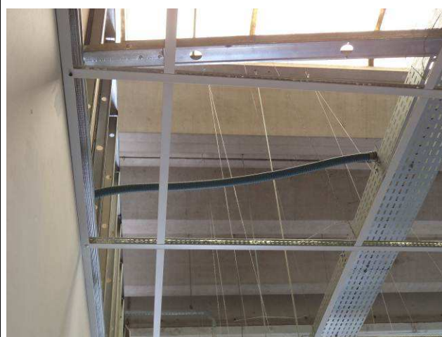
Figura 12E: eletrodutos corrugados – área barracão.
