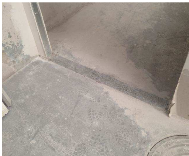
Figura 45C: Soleira em granito polido cinza andorinha instalada em vão sob porta da 5ª Vara do Trabalho.
