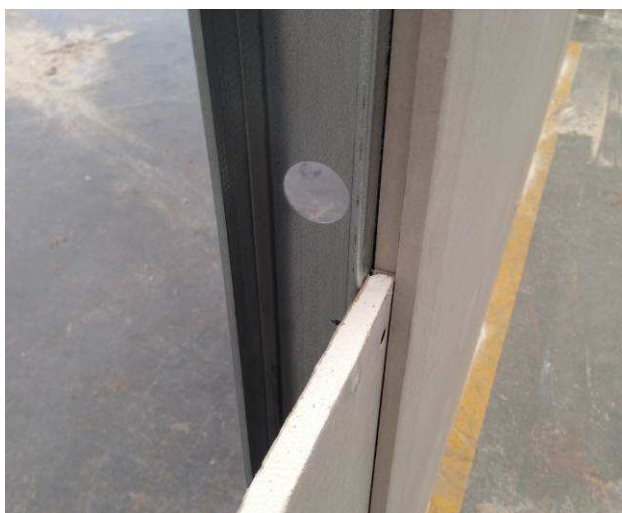
Figura 08C: Montagem de parede em gesso acartonado ST-duplo.
