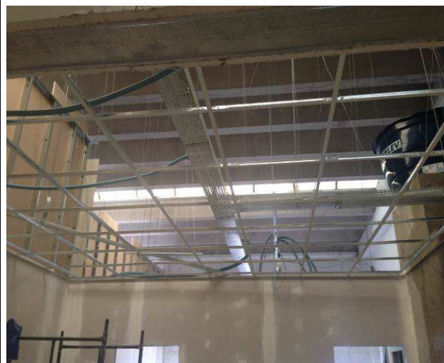
Figura 41C: Montagem dos perfis metálicos em área da 5ª Vara do Trabalho - estar da direção do Fórum e da sala dos oficiais.
