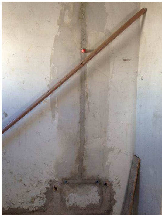
Figura 67C: Finalização de pontos de água fria (25mm) em banheiro da área de terceirizados.
