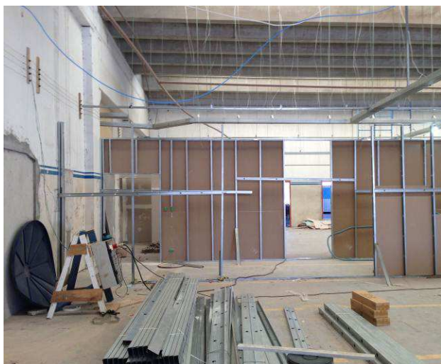
Figura 06C: Estruturas com perfis de aço zincado para montagem de paredes de gesso acartonado.
