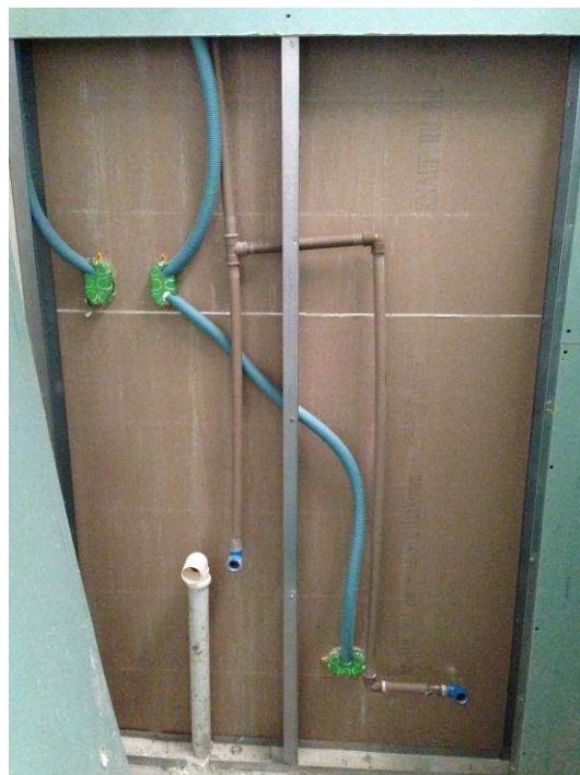
Figura 56C: Finalização de execução de pontos de esgoto secundário dos lavatórios e pias (50mm) do barracão novo – bwc juiz.
