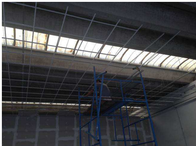
Figura 03C: Andaime para montagem de forros modulares.
