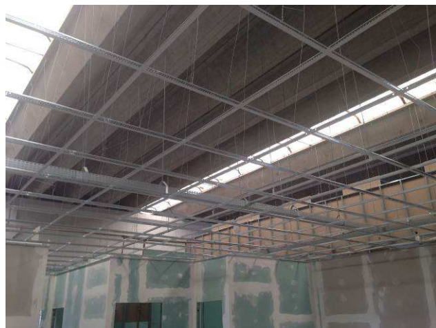
Figura 38C: Montagem dos perfis metálicos em área da 5ª Vara do Trabalho - secretaria.
