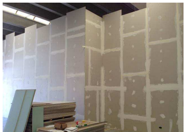
Figura 21C: Paredes em gesso acartonado ST simples em área do arquivo.
