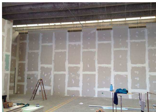
Figura 20C: Paredes em gesso acartonado ST simples em área do arquivo.
