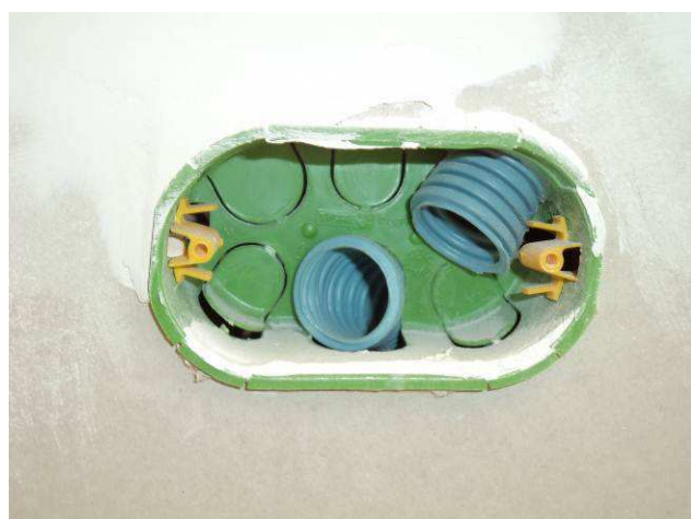
Figura 05E: caixas 2x4" e 4x4" específicas para drywall – área barracão.
