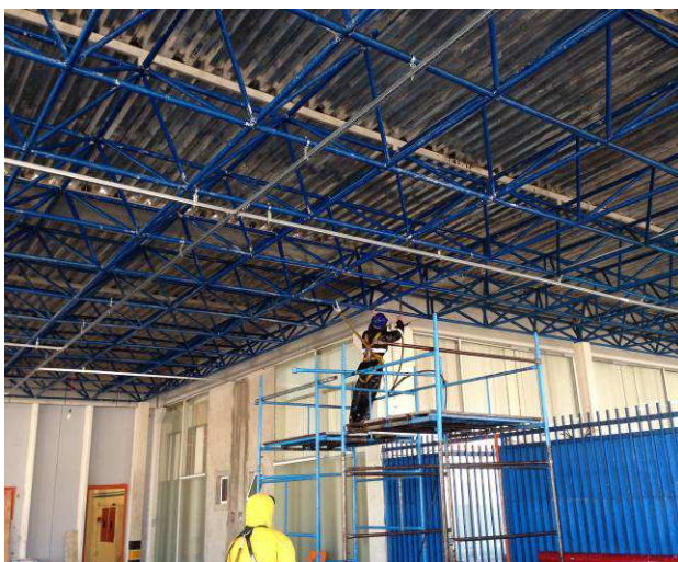
Figura 36C: Limpeza de estrutura metálica e face inferior de telhas com jato de alta pressão de água, em área de estacionamento coberto.
