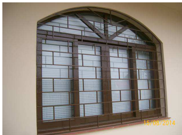
Figura 43: Pintura das esquadrias de madeira e gradis da 2º Vara.
