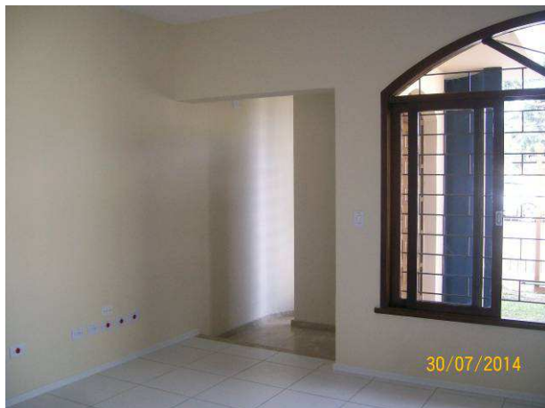
Figura 40: Pintura das paredes internas da 2º Vara.
