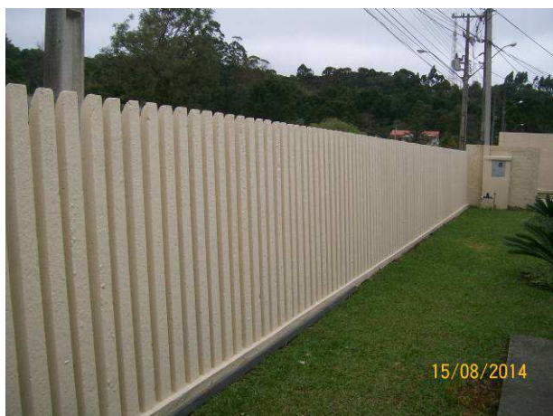
Figura 38: Pintura no muro palito da 1º Vara.
