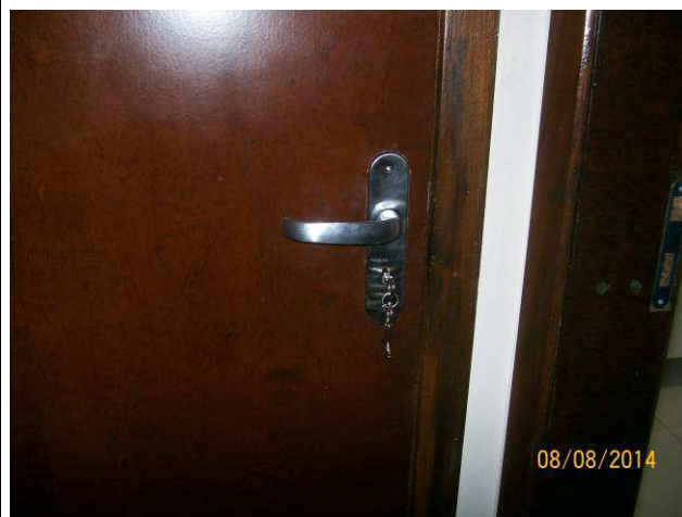
Figura 21: Fechaduras das portas da 2º Vara
