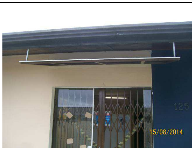
Figura 22: Cobertura de policarbonato para 1º Vara
