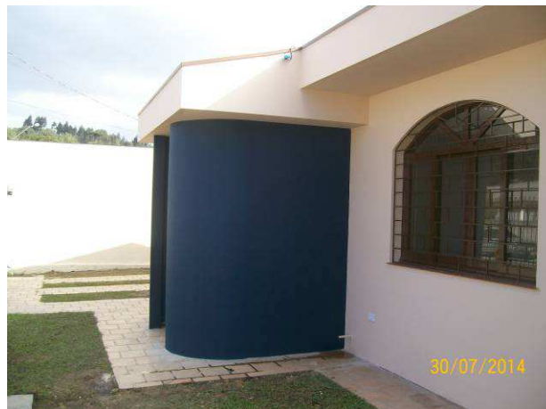
Figura 41: Pintura externa da 2º Vara.
