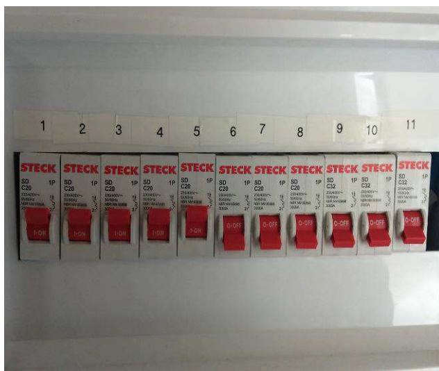
Figura 13E: Disjuntores monopulares
