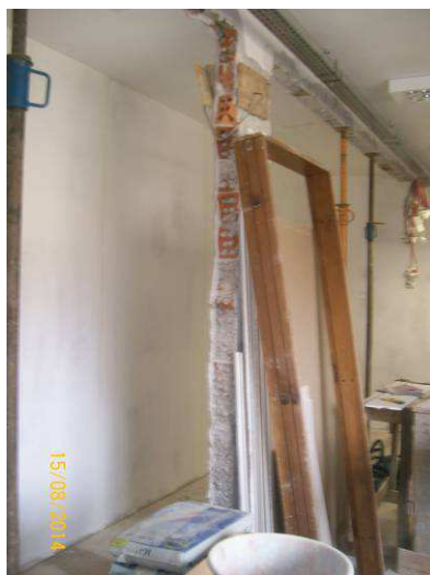
Figura 05: Demolição parede Sala de Audiência da 1º Vara.
