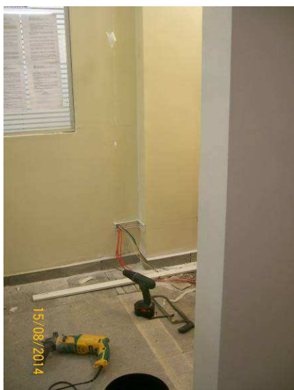
Figura 03: Demolição do balcão de atendimento da 1º Vara.
