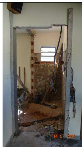
Figura 8: Remoção de cerâmica e azulejos (PNE) da 1ª Vara.
