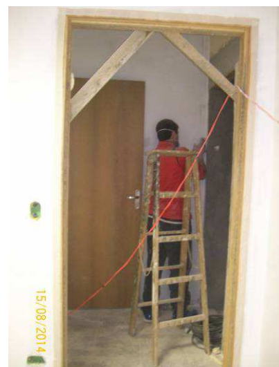
Figura 02: Demolição para abertura de portas da 1º Vara.
