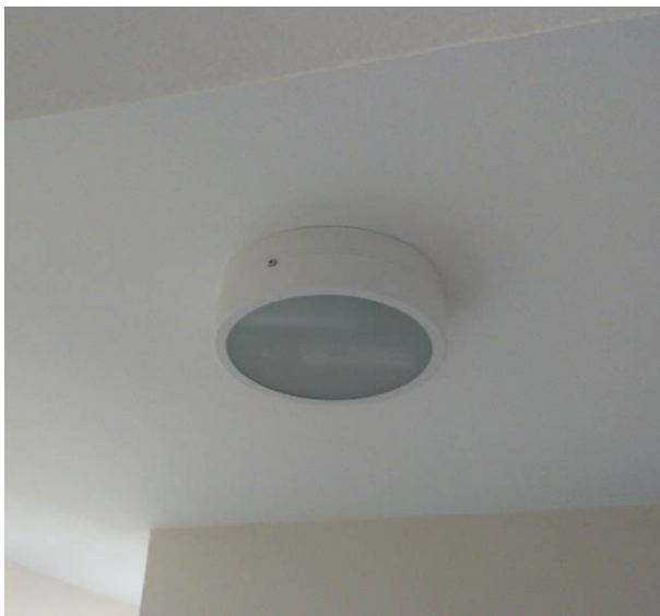
Figura 15E: Luminária de sobrepor redonda
