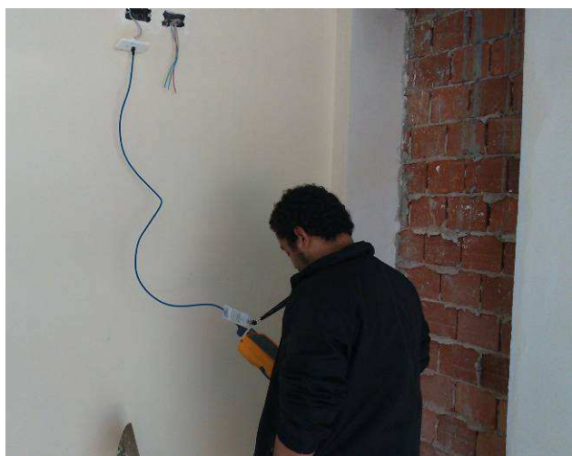
Figura 25E: Certificação de pontos lógicos
