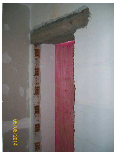
Figura 13: Verga nos vãos entre as casas
