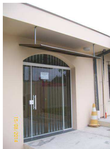
Figura 23: Cobertura de Policarbonato para 2º Vara
