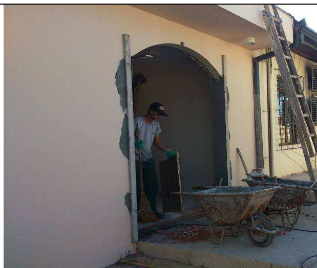
Figura 07: Demolição para abertura do vão da entrada da 2ª Vara
