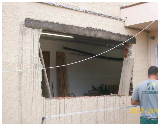
Figura 14: Verga na janela da Sala de Audiência da 2ª Vara.
