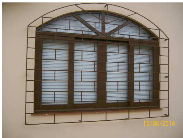
Figura 42: Pintura das esquadrias de madeira e gradis da 2º Vara.
