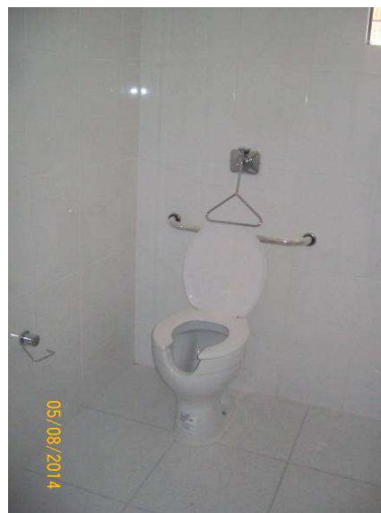
Figura 31: Vaso sanitário para PNE, barras de apoio cromadas, válvula de descarga tipo barra de acionamento e papeleira. Banheiro PNE 1ª Vara.
