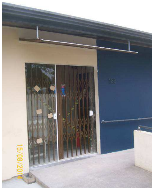
Figura 18: Porta de vidro temperado e porta pantográfica para a 1º Vara
