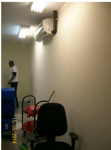
Figura 09: Parede de gesso acartonado duplo – Sala de Audiência/ Secretaria da 1ª Vara.
