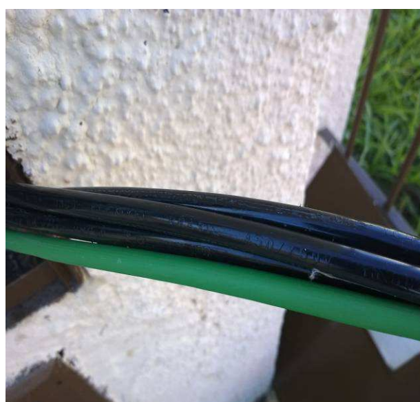
Figura 08E: Cabos flexíveis 16,0 mm 2
