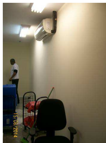
Figura 39: Pintura das paredes internas da 1º Vara.
