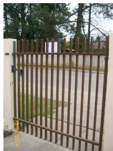
Figura 47: Pintura dos gradis da 1º Vara.
