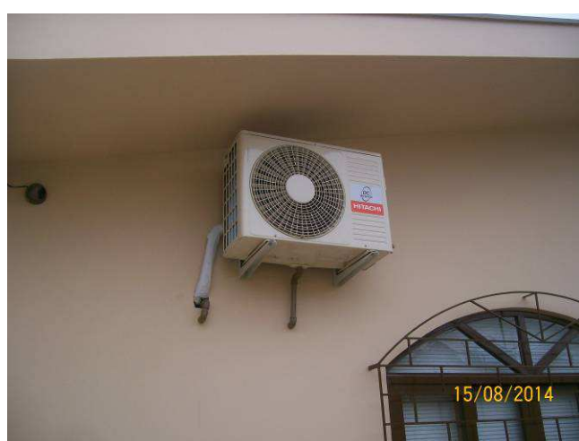
Figura 33: Instalação de aparelho externo de ar condicionado.
