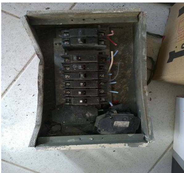
Figura 27E: Retirada de quadro elétrico existente.
