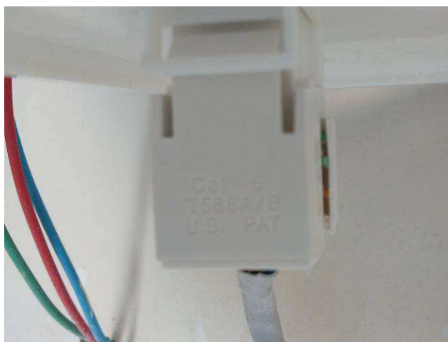
Figura 23E: Tomada keystone RJ 45
