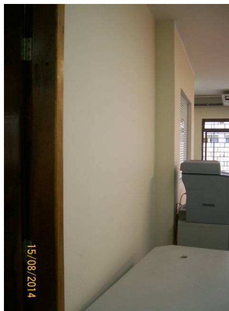
Figura 10: Parede gesso acartonado simples, na divisa da secretaria/ hall da 1ª Vara.
