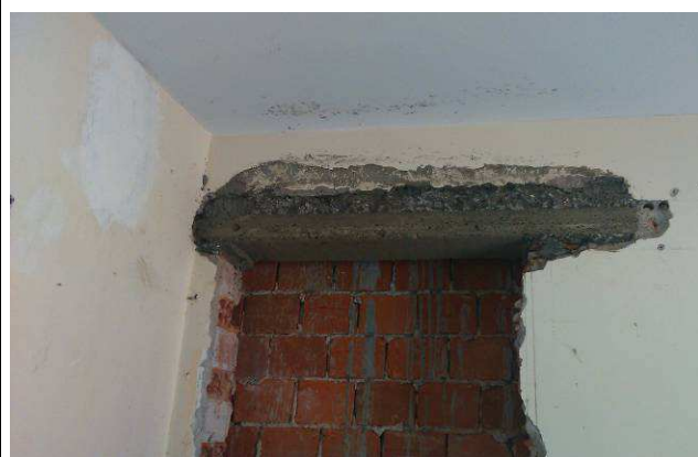
Figura 12: Verga nos vãos entre as casas.
