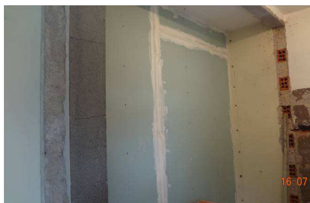
Figura 11: Parede em gesso acartonado verde banheiro PNE da 1ª Vara.
