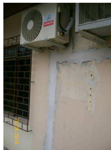
Figura 34: Instalação de aparelho externo do ar condicionado no site.
