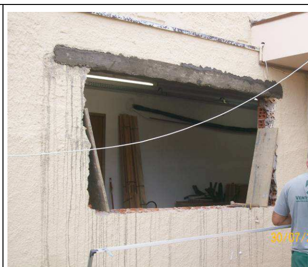
Figura 06: Demolição para abertura do vão da janela da 2º Vara.
