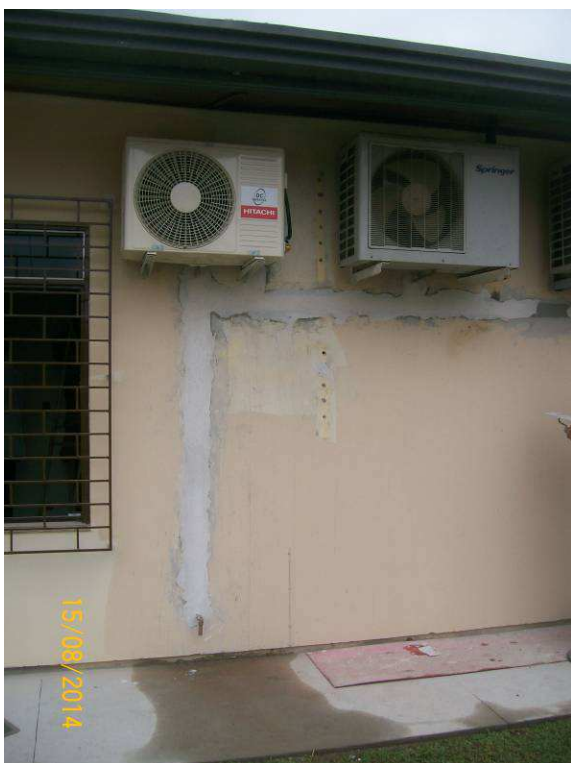
Figura 15: Embutir tubulação de ar condicionado na fachada frontal da 1º Vara.
