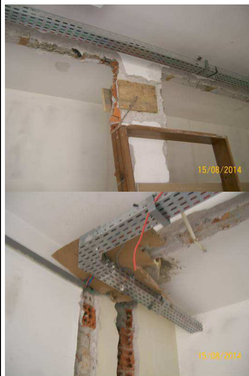
Figura 16: Colocação de graute no pilar e na viga Na 1º Vara.
