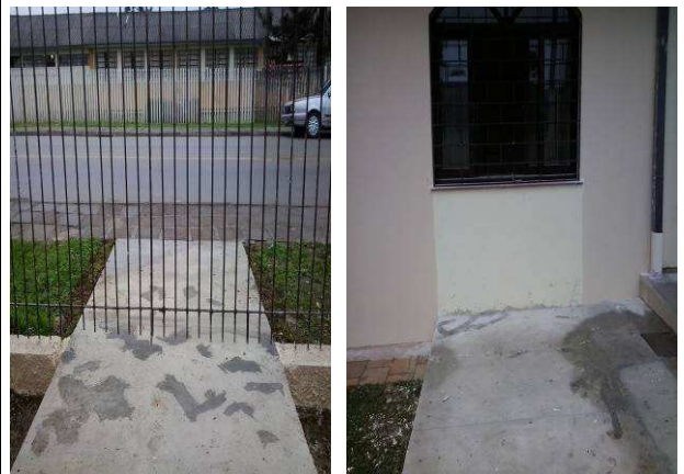
Figura 46: Rampa de acesso a 2ª VT
