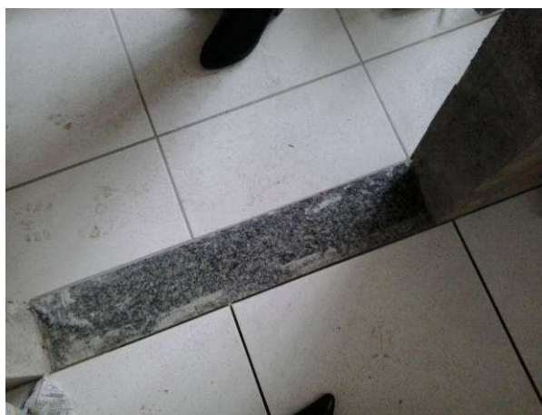
Figura 20: Instalação de soleira I.S servidores.
