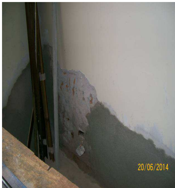
Figura 16: Execução de impermeabilização a 80 cm do piso.
