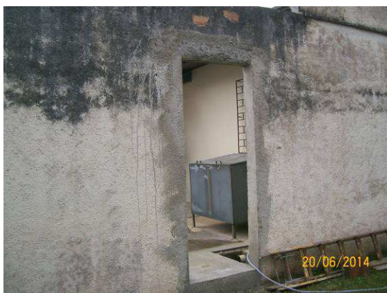
Figura 11: Verga na abertura de vão.
