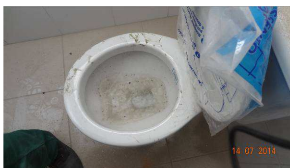
Figura 28: Água e esgoto testados. Vaso banheiro servidores
