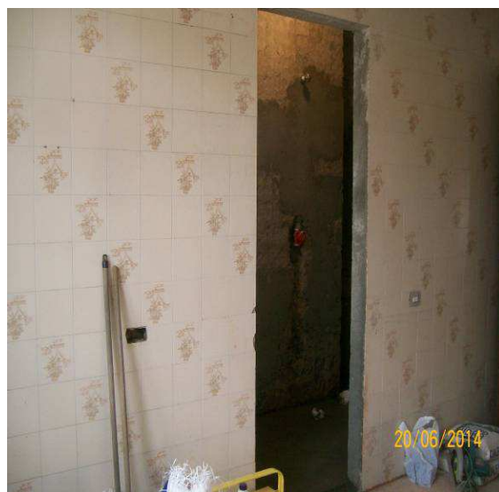
Figura 04: Abertura de vão para porta banheiro
