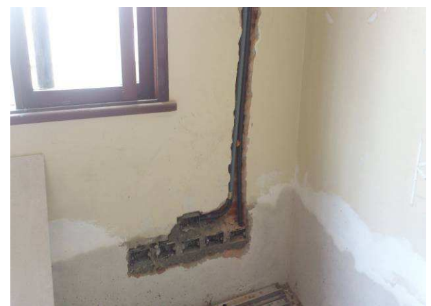
Figura 03E: Caixas de passagem/ligação em PVC
