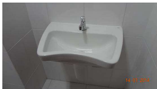
Figura 40: Lavatório com coluna suspensa para PNE, torneira de pressão e toalheiro tipo gancho.
