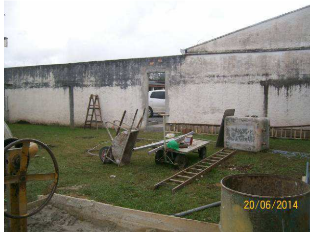
Figura 8: Remoção de brinquedos do quintal e abertura de vão para acesso entre as VTs.
