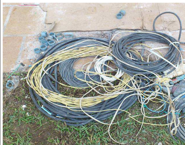
Figura 12E: Retirada de instalação existente
