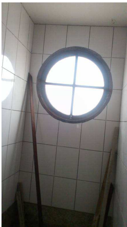
Figura 13: Execução de regularização de parede e colocação de azulejos. I.S gabinete
