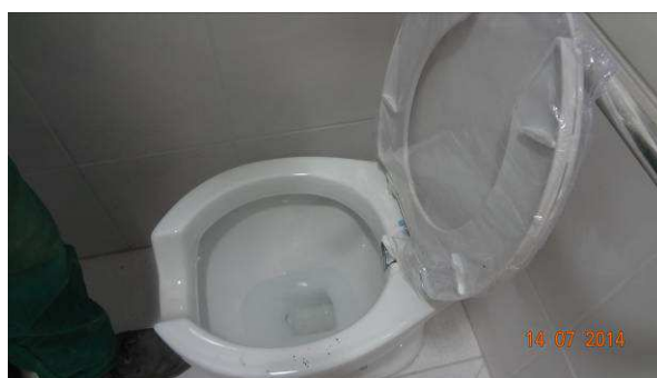
Figura 30: Água e esgoto testados. Vaso banheiro PNE.
