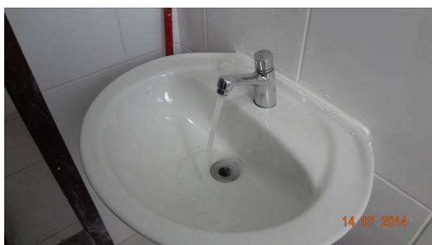
Figura 31: Água e esgoto testados. Lavatório banheiro gabinete.
