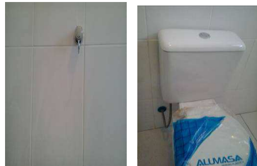
Figura 42: Toalheiro metálico, tipo gancho e vaso sanitário com caixa acoplada. Banheiro do gabinete
