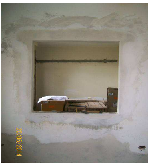
Figura 03: Demolição de vão para o balcão de atendimento
