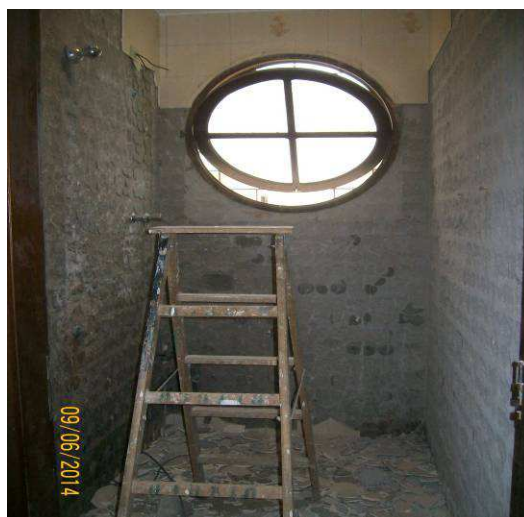
Figura 06: Remoção de revestimento de parede e piso cerâmico
