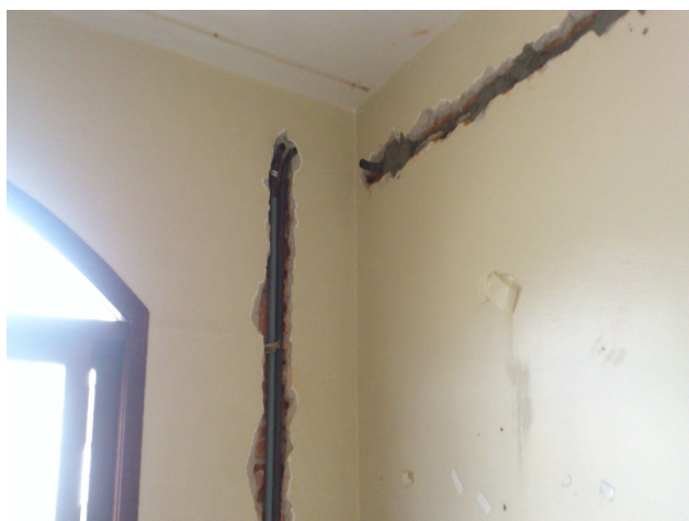
Figura 01E: Eletroduto de PVC flexível corrugado
