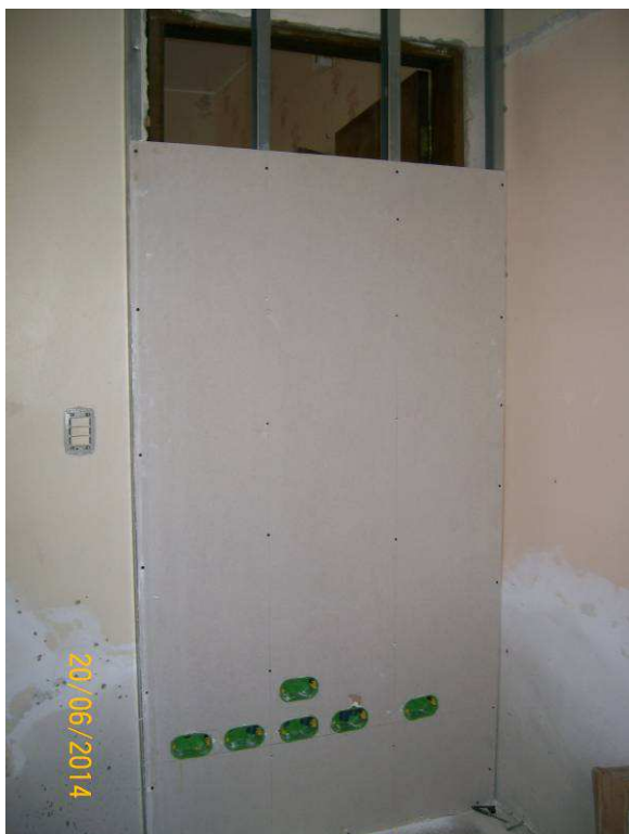
Figura 09: Fechamento de vão com gesso acartonado – porta cozinha
