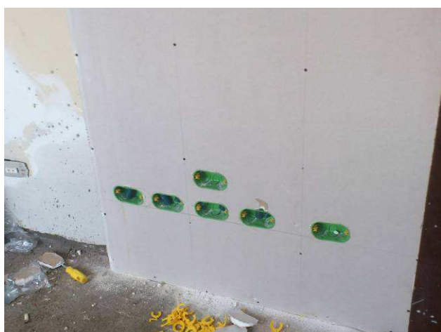
Figura 05E: Caixa de passagem para drywall
