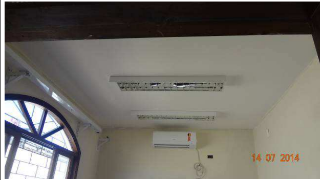
Figura 44: Instalação de aparelho de ar condicionado na sala 01.
