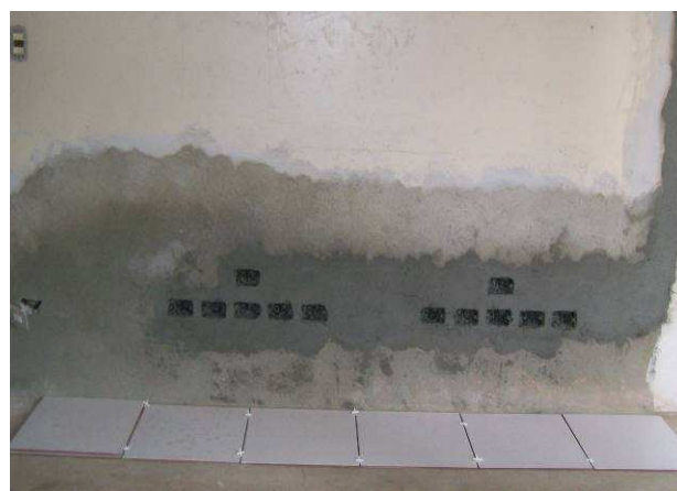
Figura 04E: Caixas de passagem/ligação em PVC
