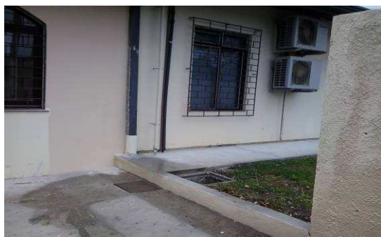
Figura 53: Relocação do hidrômetro e instalação de torneira. Foi embutido as tubulações de águas pluviais e execução de calçada.
