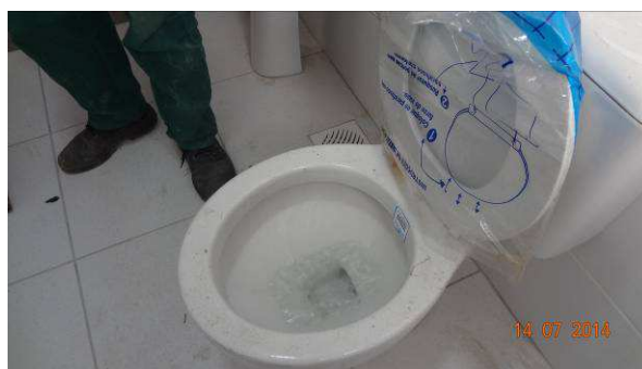
Figura 32: Água e esgoto testados. Vaso banheiro gabinete
