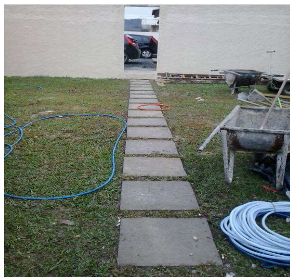
Figura 18: Instalação de blokret no acesso.
