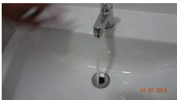
Figura 29: Água e esgoto testados. Lavatório banheiro PNE.
