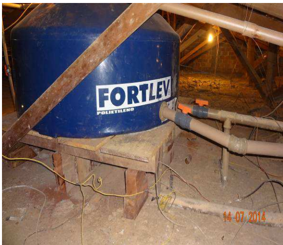
Figura 07: Substituição do reservatório
