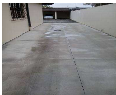
Figura 54: Execução de calçada, acesso estacionamento 1ª VT.
