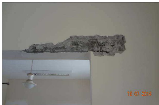
Figura 12: Verga na abertura de vão para balcão de atendimento.
