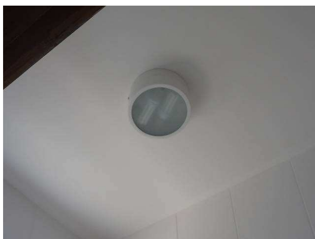
Figura 07E: Luminária de sobrepor redonda
