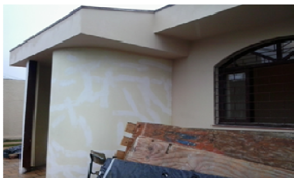
Figura 47: Emassamento frontal.
