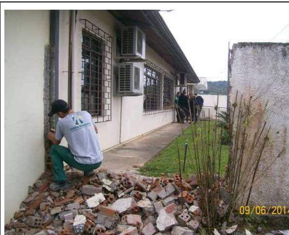
Figura 02: Demolição muro divisa
