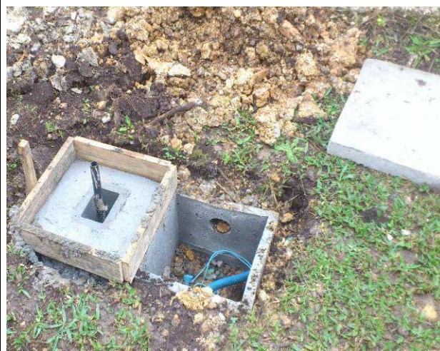
Figura 10E: Base do poste do jardim.
