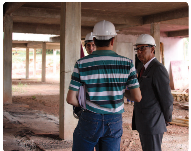
O engenheiro Kelvi Leandro da Silva detalha ao Presidente os próximos passos para a conclusão dos trabalhos
