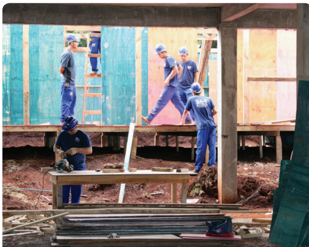
O novo fórum de Londrina envolve uma obra de 16 mil m 2 , sendo uma parte composta por reforma e outra por novas construções
