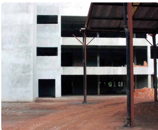
Na fase em que se encontra, o novo fórum de Londrina está recebendo infraestrutura de luz e água
