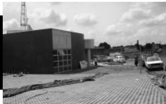
Obras na sede da Vara do Trabalho de Cambé
